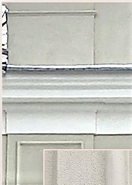
9,10,11. Detal – zbliżenie. Fragment gzymsu okapowego, boczna ściana ryzalitu wejścia z fragmentem portalu, zbliżenie odtworzonej dekoracji płyciny obwiedzonej wałkiem – faktura tynku.
