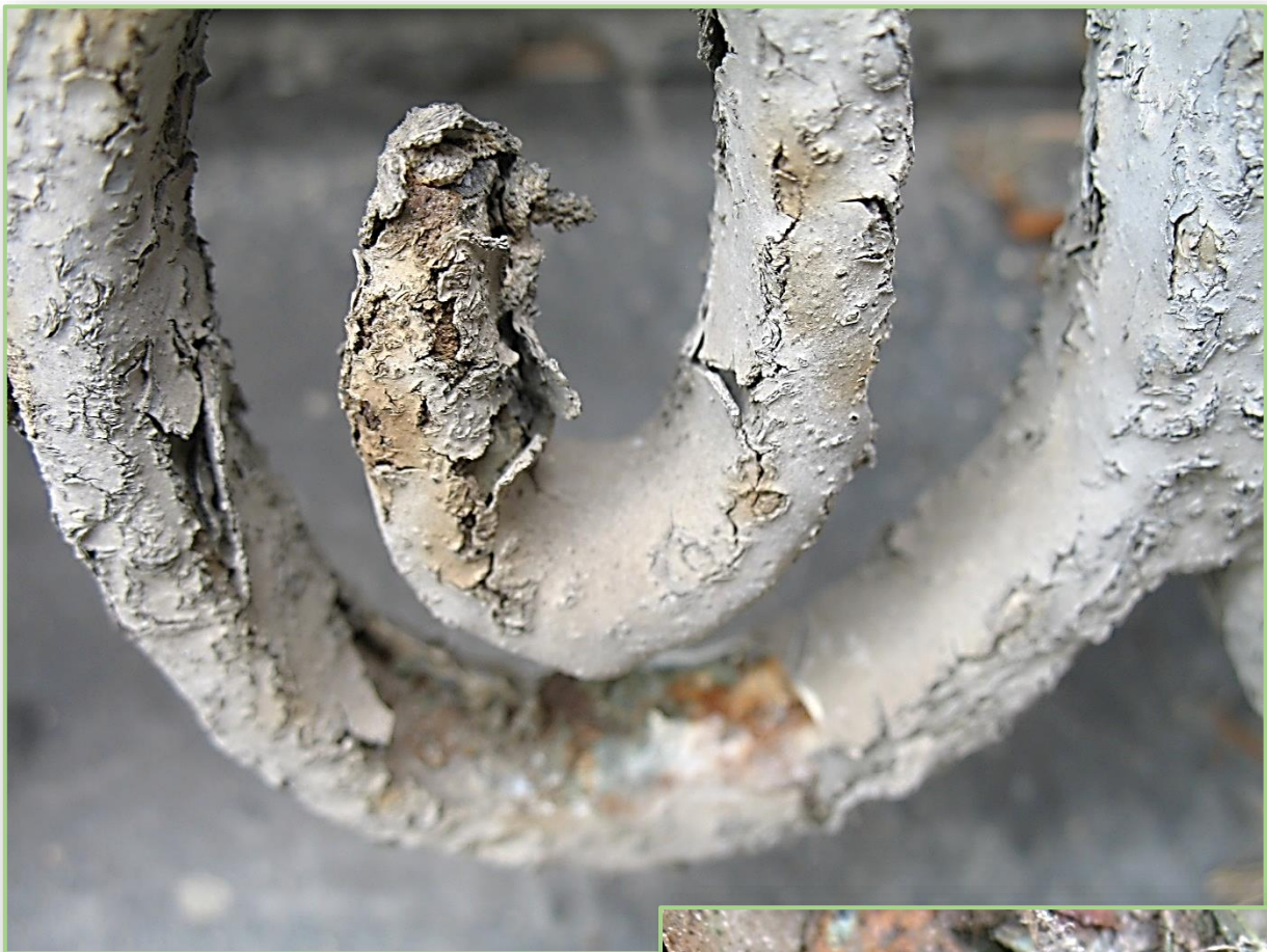
27, 28. Nowe okna sutereny oraz naprawa oryginalnych krat. Kolor metaloplastyki zbadano na etapie pisania Programu Prac Konserwatorskich.
