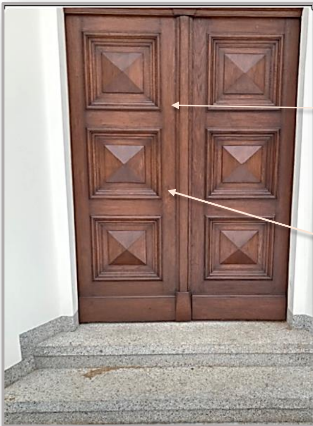
9,10,11,12. Oryginalne drzwi dębowe po renowacji, stopnie po rekonstrukcji (lastriko)
