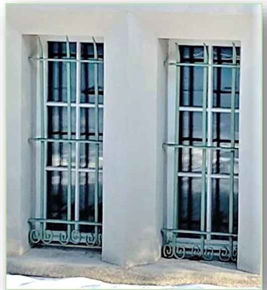
27, 28. Nowe okna sutereny oraz naprawa oryginalnych krat. Kolor metaloplastyki zbadano na etapie pisania Programu Prac Konserwatorskich.
