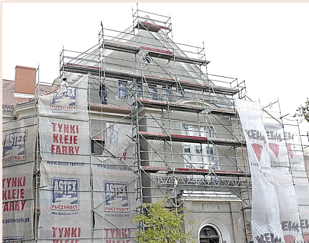
23. Renowacja tynków oraz dekoracji architektonicznej elewacji frontowej
