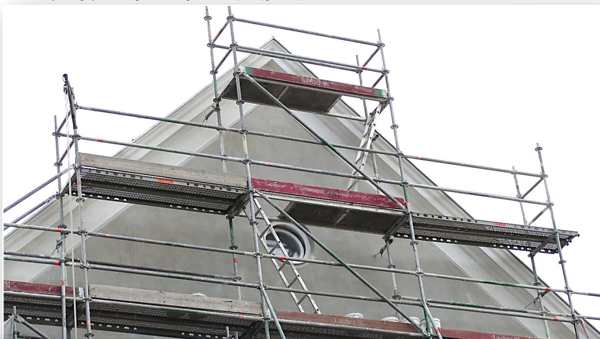
24. Zbliżenie szczytu i gzymsu naprawionego metodą „ciągnioną”
