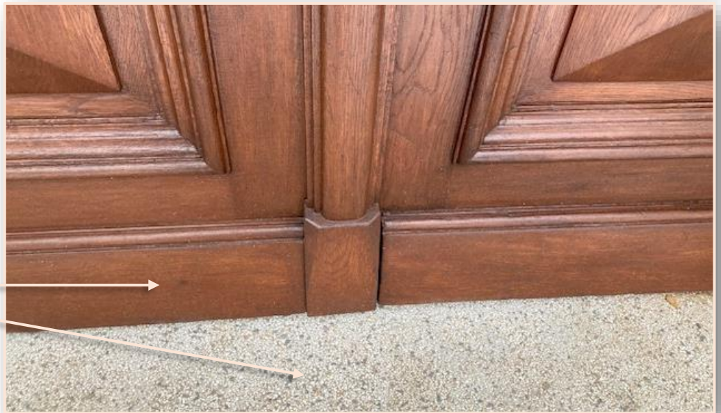
13. Zbliżenie listwy dolnej oraz nowego lastriko – imitacja oryginału
