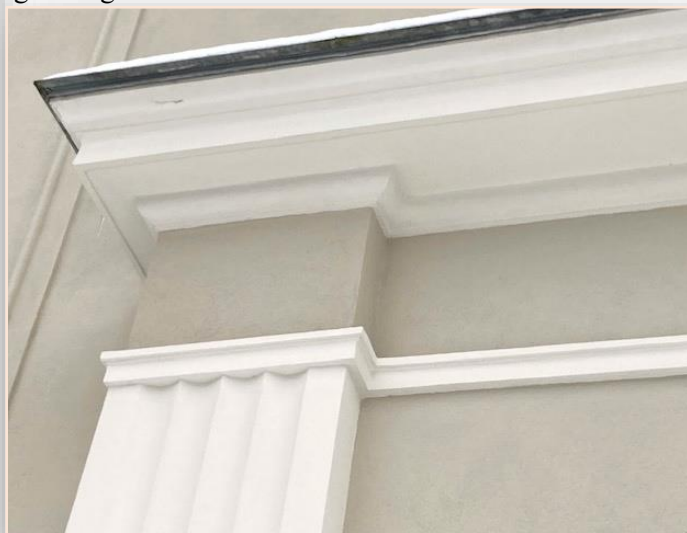
9,10,11. Detal – zbliżenie. Fragment gzymsu okapowego, boczna ściana ryzalitu wejścia z fragmentem portalu, zbliżenie odtworzonej dekoracji płyciny obwiedzonej wałkiem – faktura tynku.
