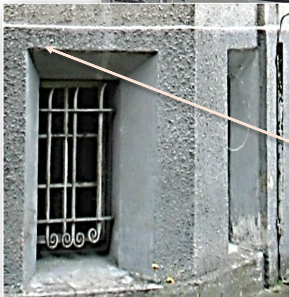
25,26. Naprawianie formy otworu okiennego w części cokołowej.
