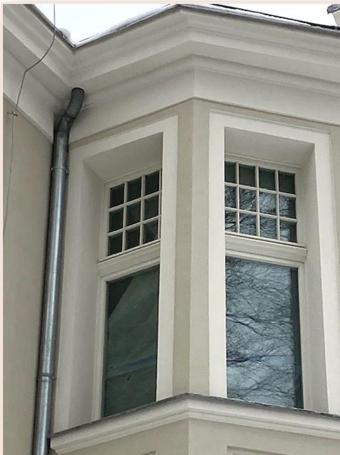
9,10,11. Detal – zbliżenie. Fragment gzymsu okapowego, boczna ściana ryzalitu wejścia z fragmentem portalu, zbliżenie odtworzonej dekoracji płyciny obwiedzonej wałkiem – faktura tynku.
