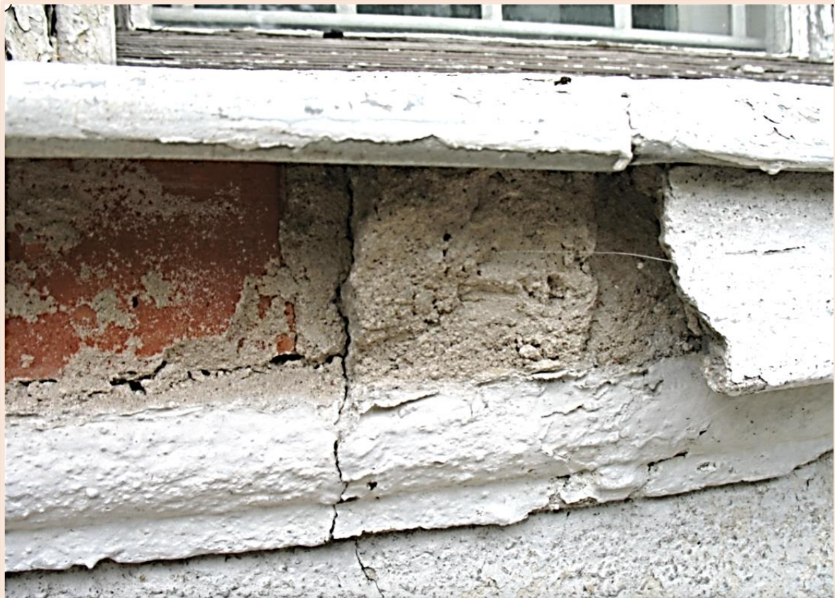
Widoczne zniszczenia nie tylko gzymsu, ale również pokrycia, które spadało na teren działki przy elewacjach
