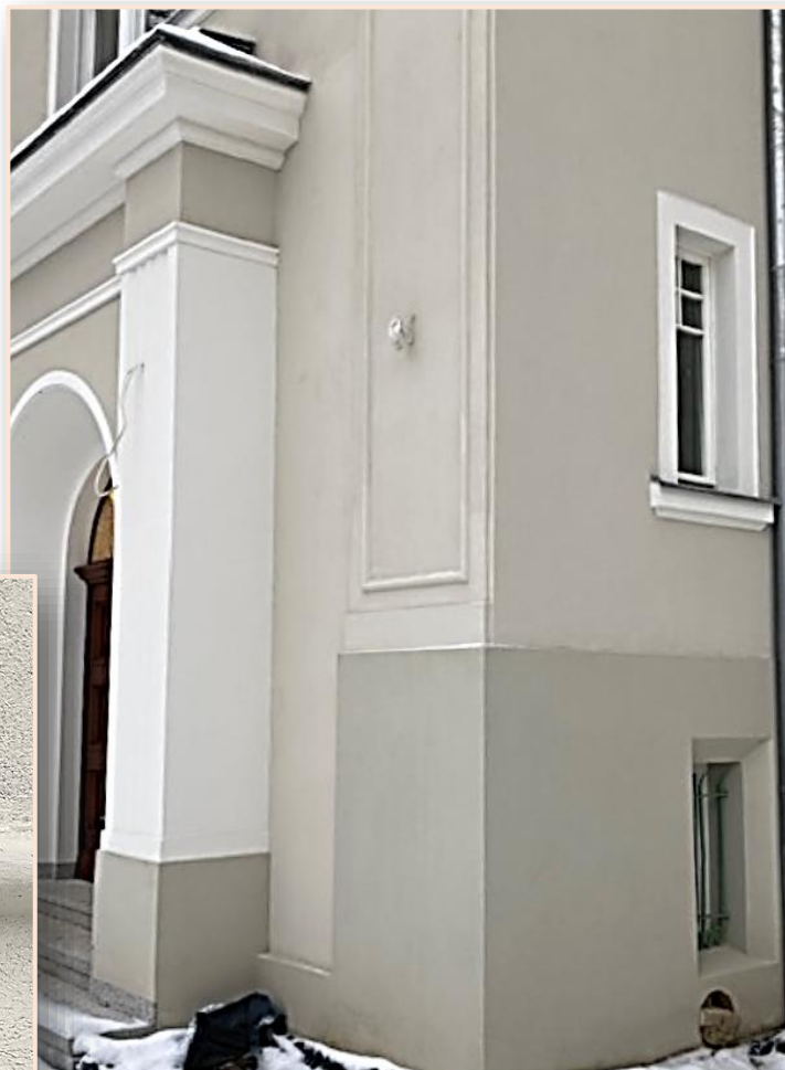
9,10,11. Detal – zbliżenie. Fragment gzymsu okapowego, boczna ściana ryzalitu wejścia z fragmentem portalu, zbliżenie odtworzonej dekoracji płyciny obwiedzonej wałkiem – faktura tynku.
