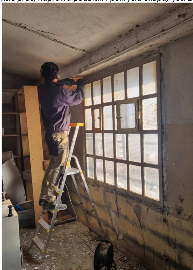
Fot. 20 Budynku dawnych garaży elektrowozów/magazyn (86B), fragment el. południowo-zachodnia, w trakcie prac, konserwacja okien, fot. 2023r.
