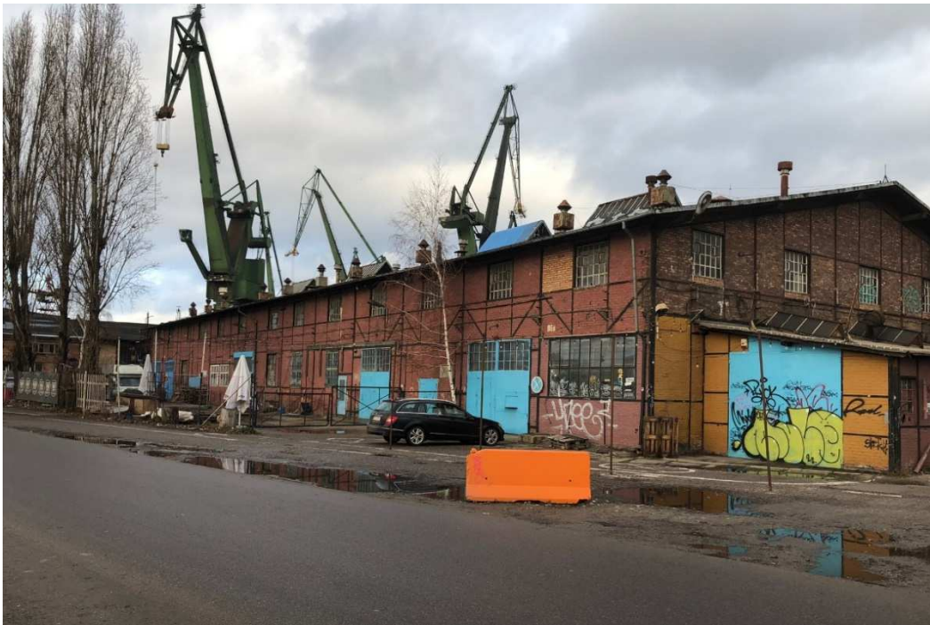
Fot. 30 Budynku dawnych garaży elektrowozów/magazyn (86B), el. południowo- zachodnia, stan przed pracami, fot. 2023r.
