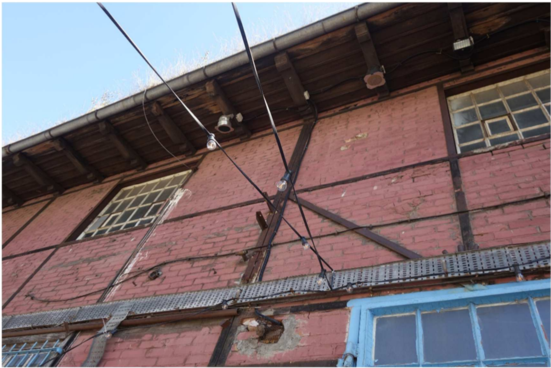
Fot. 36 Budynku dawnych garaży elektrowozów/magazyn (86B), el. południowo- zachodnia, stan przed pracami, widoczne różne instalacje, różowoczerwona farba na powierzchni i fragment podbitki fot. 2023r.
