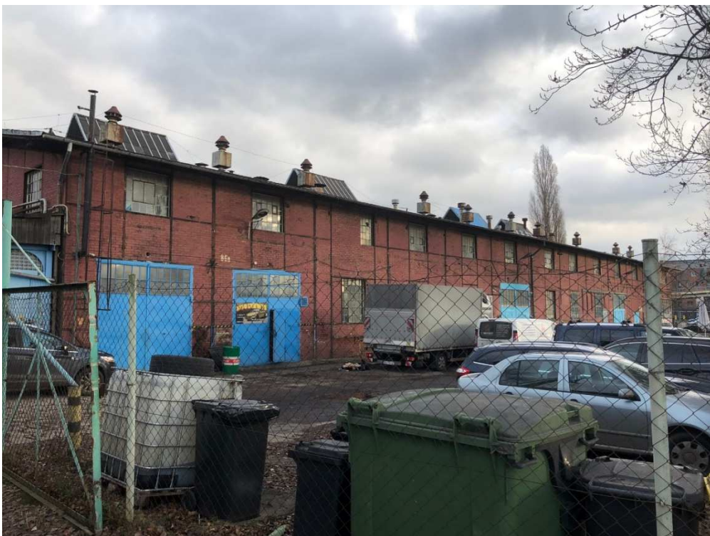
Fot. 22 Budynku dawnych garaży elektrowozów/magazyn (86B), el. południowo- zachodnia, stan przed pracami, fot. 2023r.
