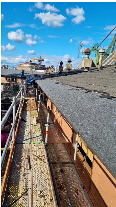
Fot. 19 Budynku dawnych garaży elektrowozów/magazyn (86B), fragment el. południowo-zachodnia, w trakcie prac, naprawa podbitki i pokrycia okapu, fot. 2023r.
