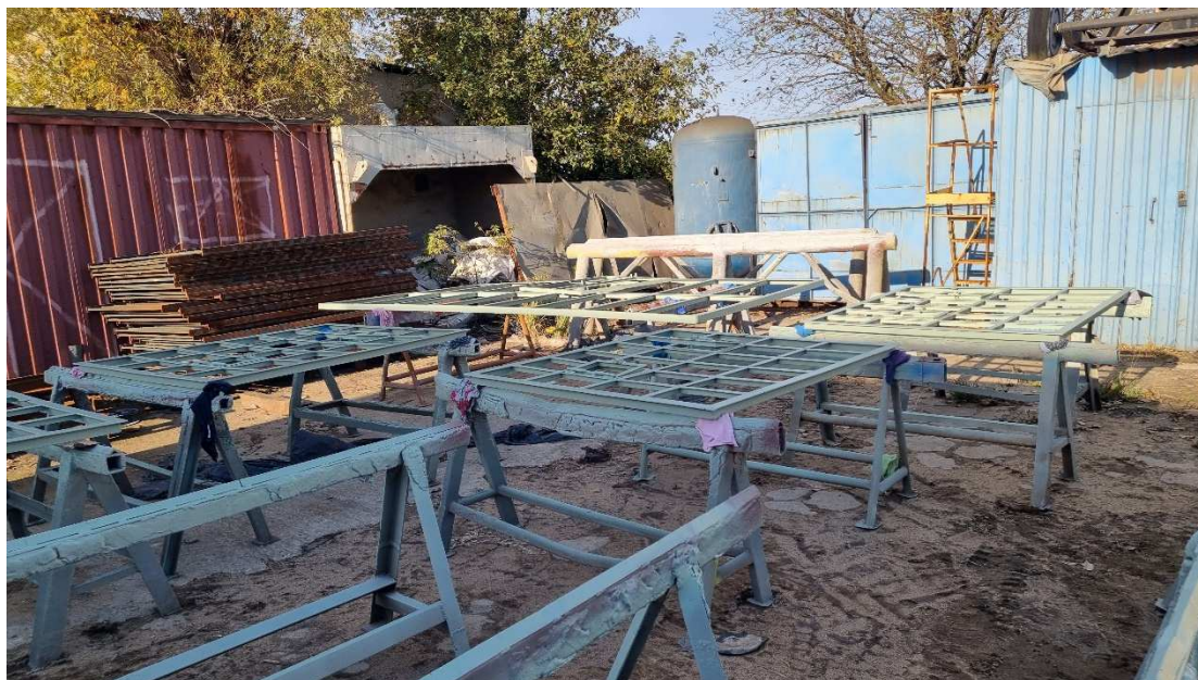
Fot. 21 Budynku dawnych garaży elektrowozów/magazyn (86B), fragment el. południowo-zachodnia, w trakcie prac, malowanie okien, fot. 2023r.
