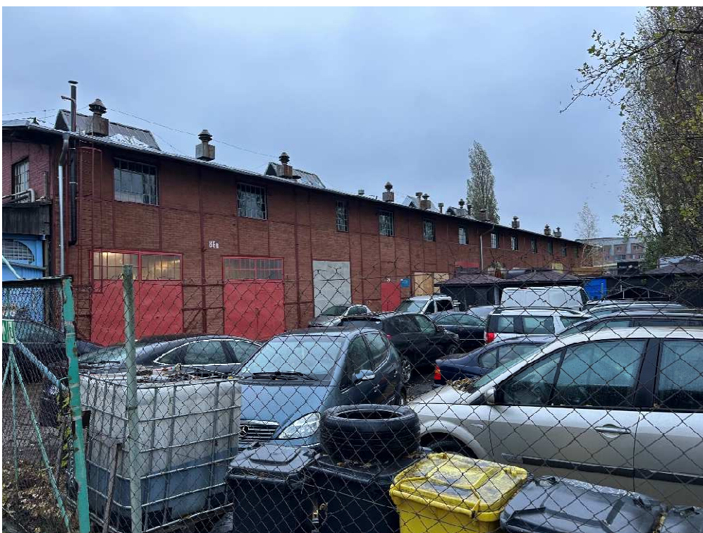
Fot. 23 Budynku dawnych garaży elektrowozów/magazyn (86B), el. południowo- zachodnia, stan po pracach, fot. 2023r.
