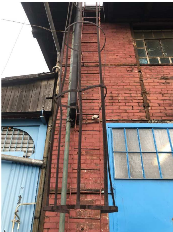
Fot. 40 Budynku dawnych garaży elektrowozów/magazyn (86B), fragment el. południowo-zachodnia, stan przed pracami, zniszczona drabinka, fot. 2023r.
