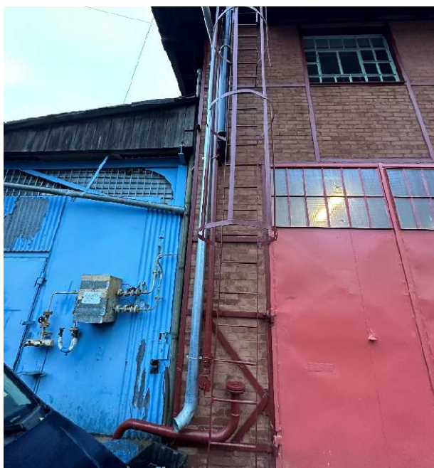
Fot. 41 Budynku dawnych garaży elektrowozów/magazyn (86B), fragment el. południowo-zachodnia, stan po pracach, fot. 2023r.
