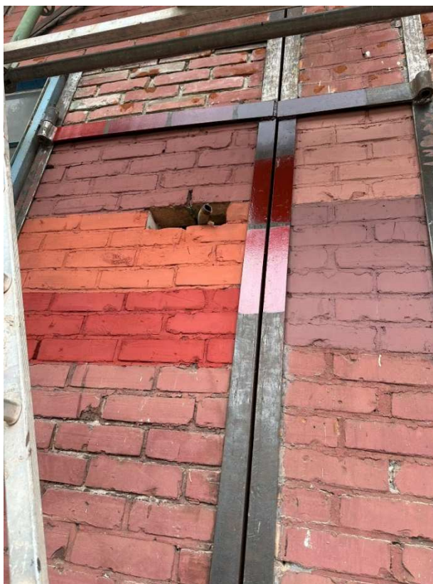
Fot. 15 Budynku dawnych garaży elektrowozów/magazyn (86B), fragment el. południowo-zachodnia, w trakcie prac, próby kolorystyczne, fot. 2023r.
