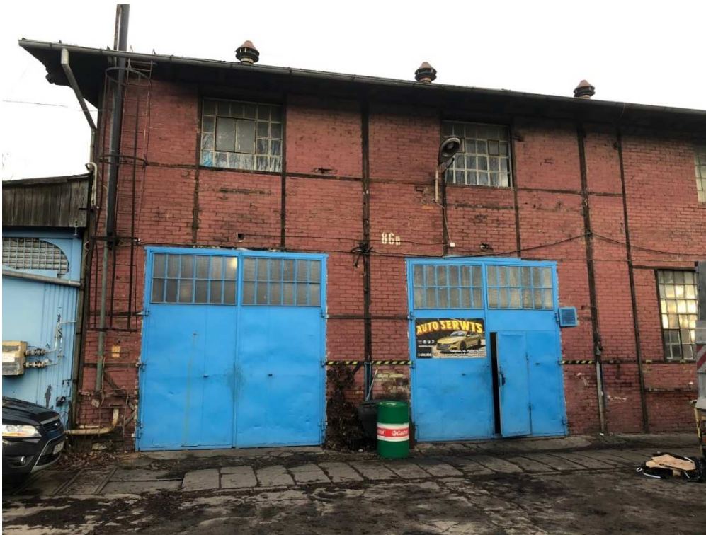
Fot. 24 Budynku dawnych garaży elektrowozów/magazyn (86B), fragment el. południowo-zachodnia, stan przed pracami, fot. 2023r.
