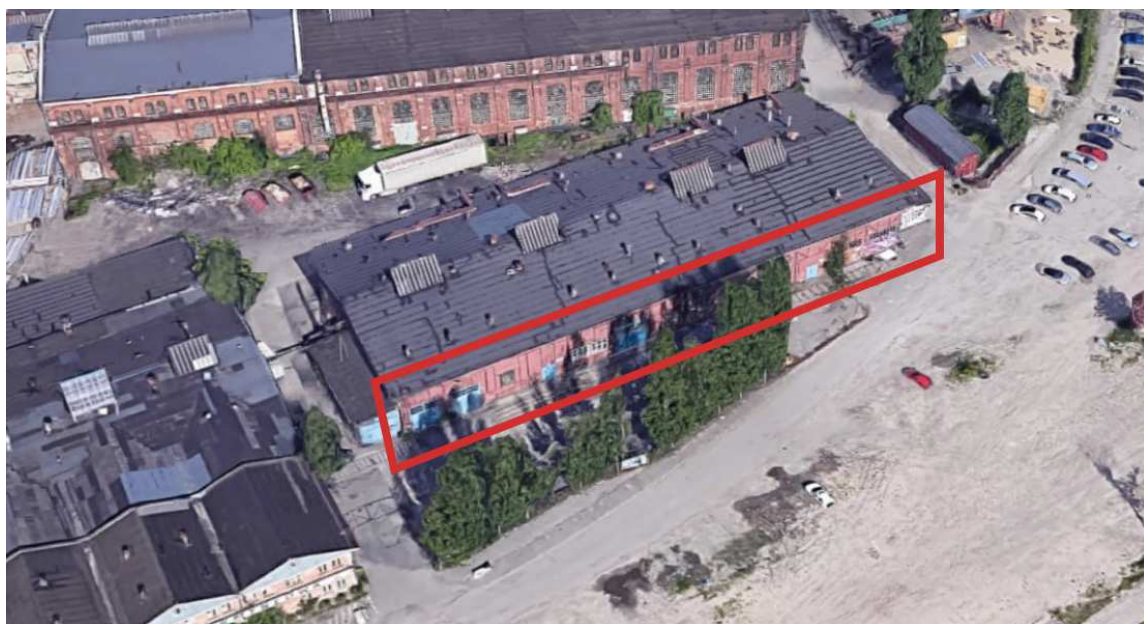
Fot. 2 Lokalizacja elewacji południowo-zachodniej budynku objętej remontem, oznaczona czerwoną ramką [źródło: https://www.google.com/maps ]
