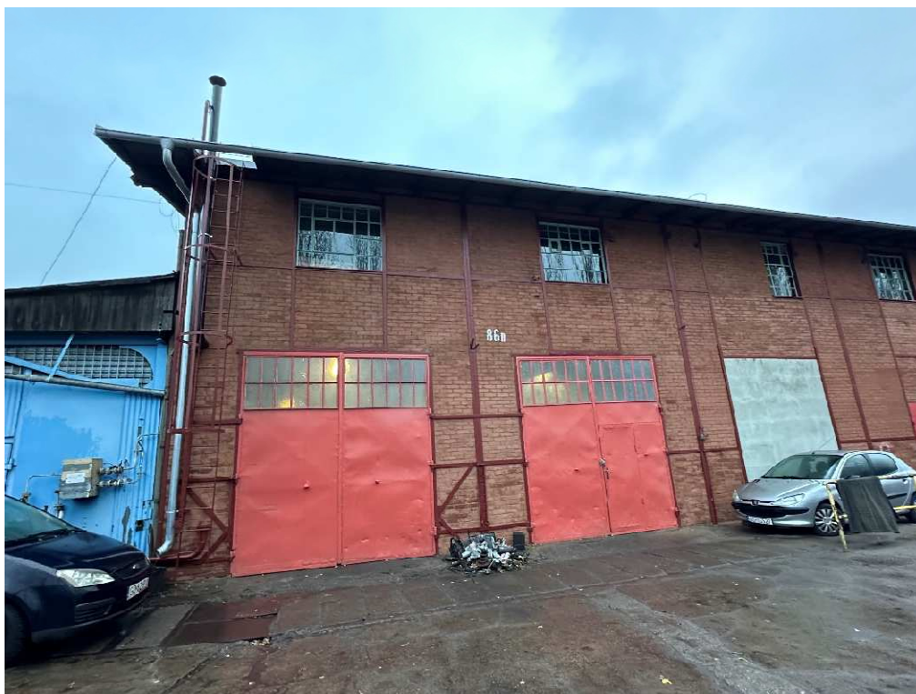
Fot. 25 Budynku dawnych garaży elektrowozów/magazyn (86B), fragment el. południowo-zachodnia, stan po pracach, fot. 2023r.
