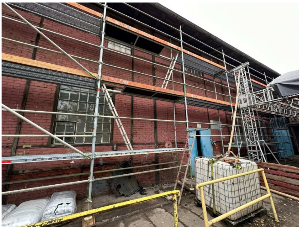
Fot. 11 Budynku dawnych garaży elektrowozów/magazyn (86B), fragment el. południowo-zachodnia, w trakcie prac, fot. 2023r.
