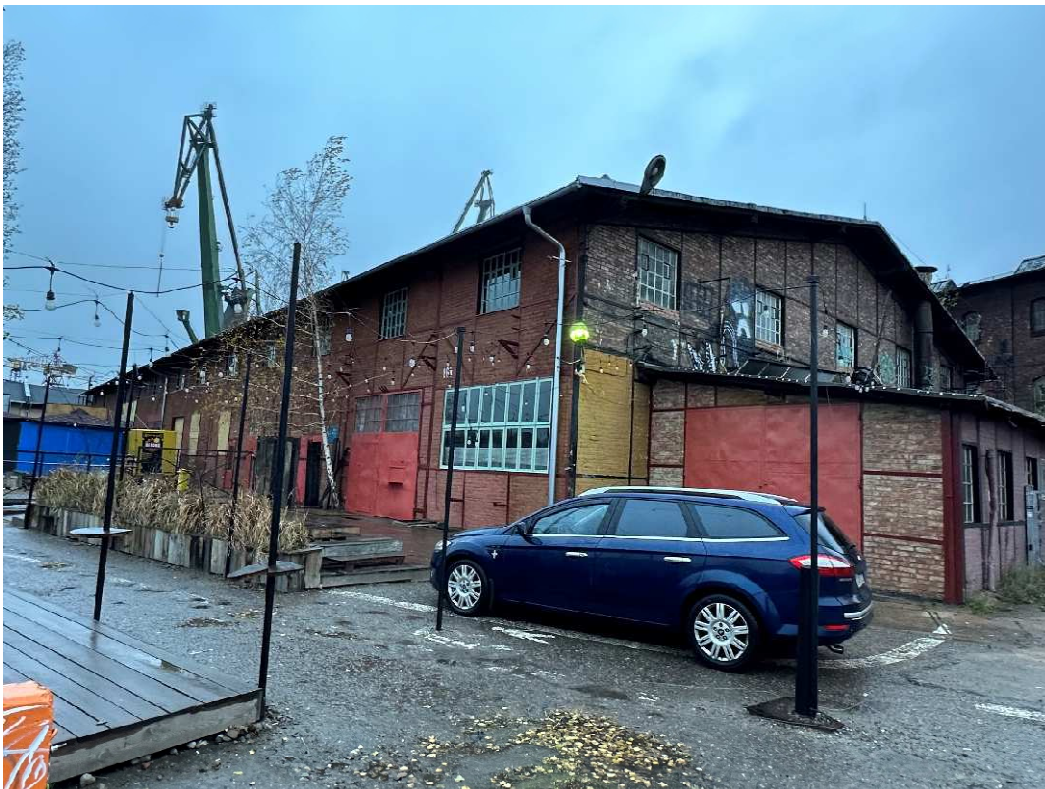
Fot. 31 Budynku dawnych garaży elektrowozów/magazyn (86B), el. południowo- zachodnia, stan po pracach, fot. 2023r.
