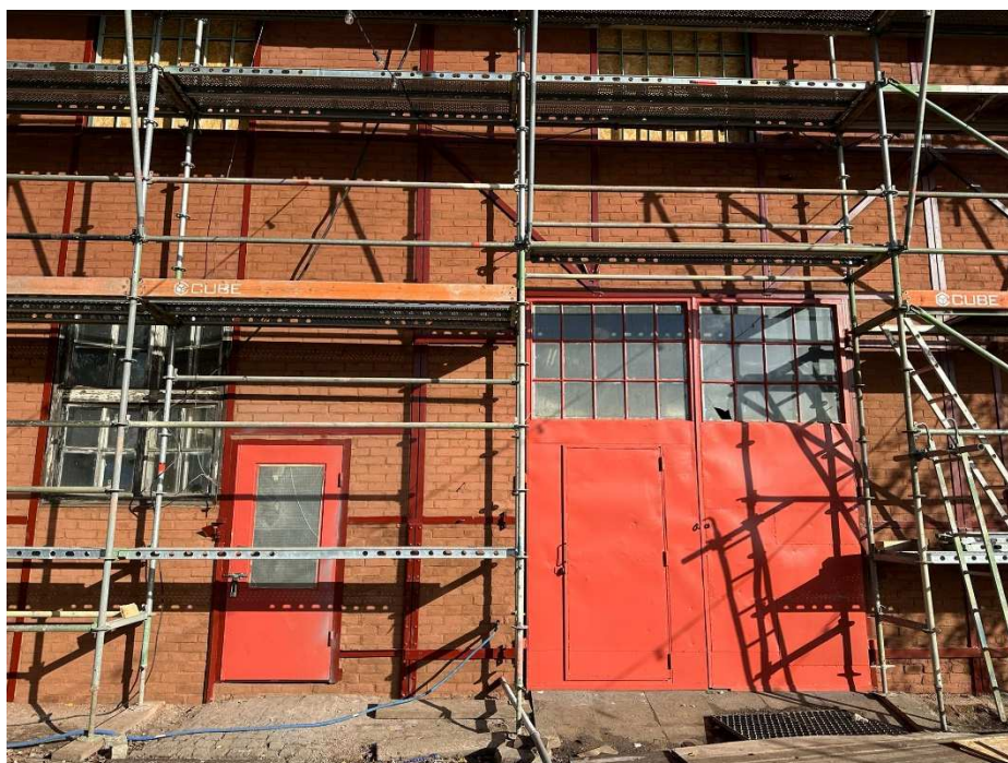
Fot. 18 Budynku dawnych garaży elektrowozów/magazyn (86B), fragment el. południowo-zachodnia, w trakcie prac, fot. 2023r.
