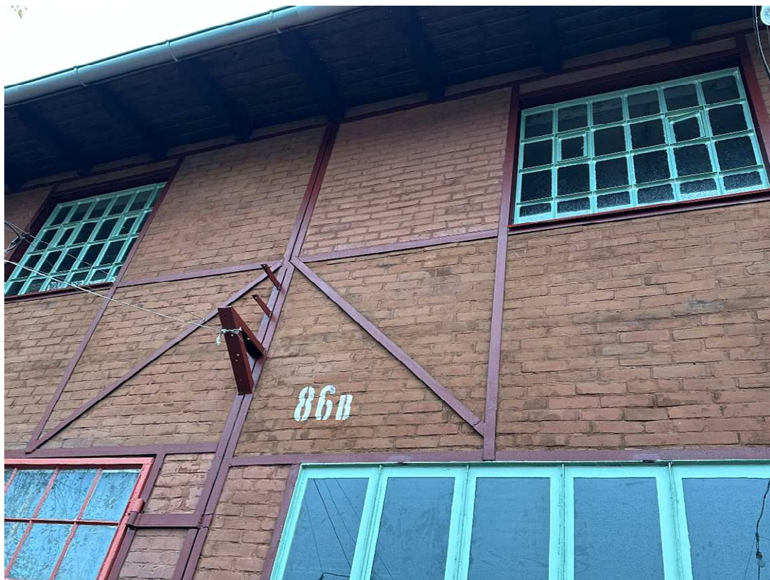
Fot. 37 Budynku dawnych garaży elektrowozów/magazyn (86B), fragment el. południowo- zachodnia, stan po pracach, fot. 2023r.
