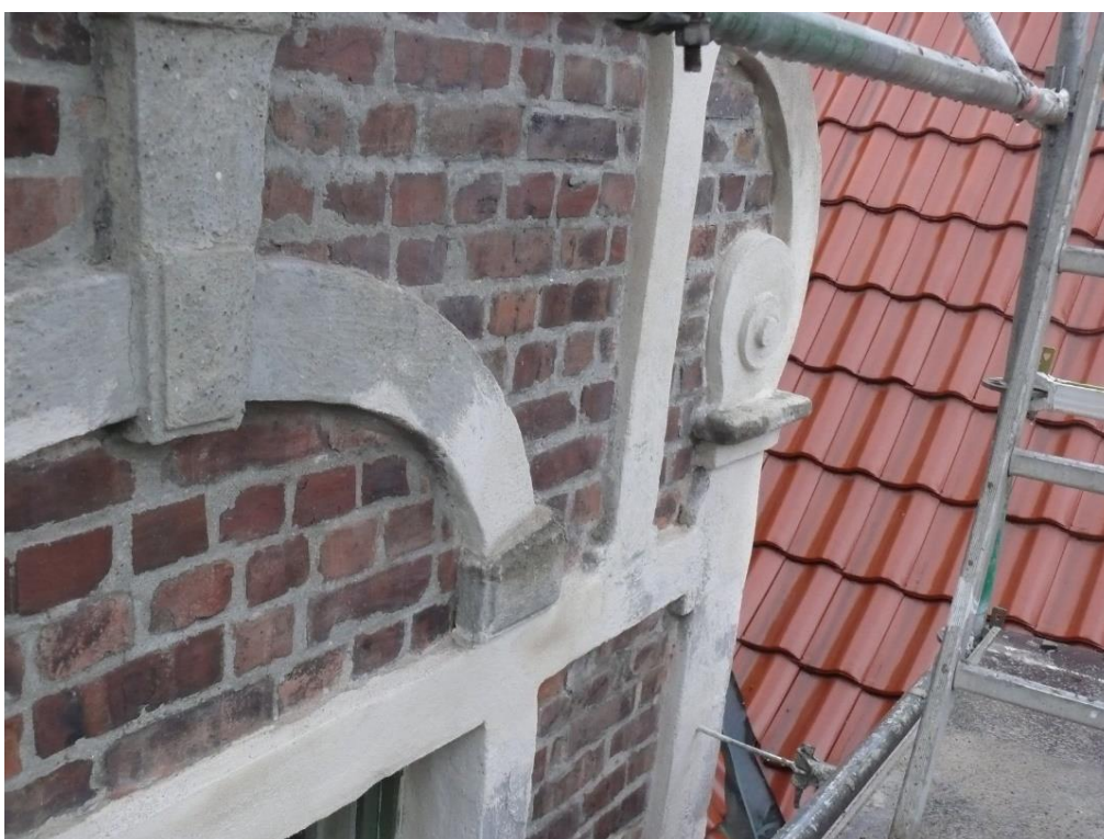
W pełni odtworzony detal z zaprawy tynkarskiej.
