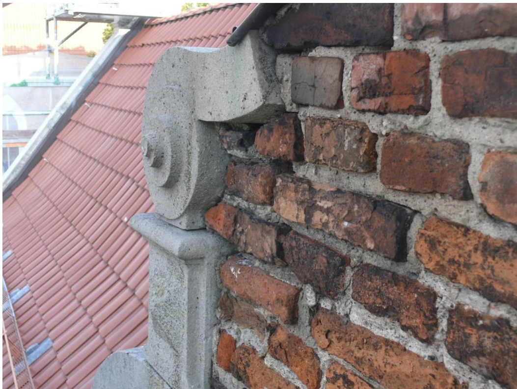
Detal architektoniczny z sztucznego kamienia- technika zbliżona do lastriko, pochodzący z roku 1934.
