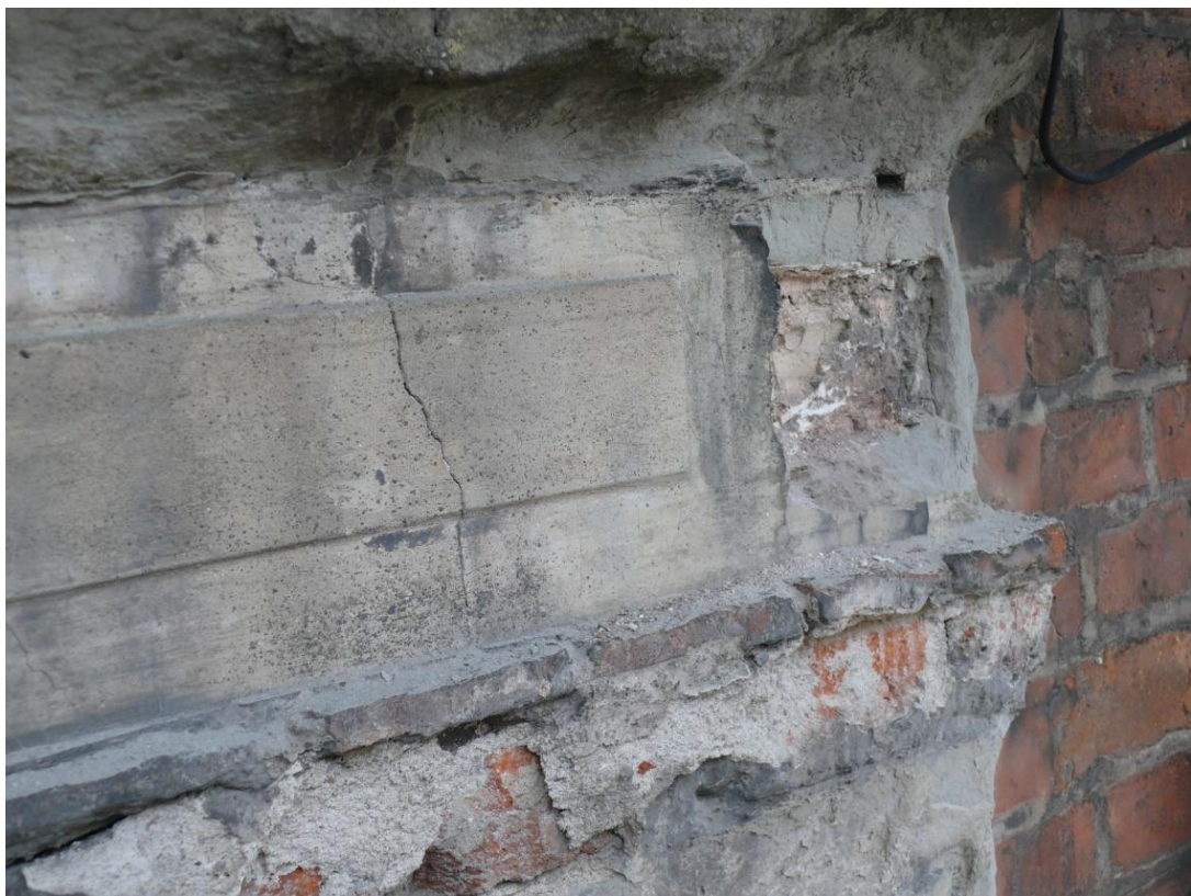
Widoczny brak dużego fragmentu architrawu oraz marmurowego prostokątnego kaboszonu.
