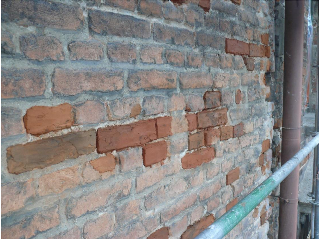
Wypełnienia ubytków zaprawą mineralną barwioną w masie.
