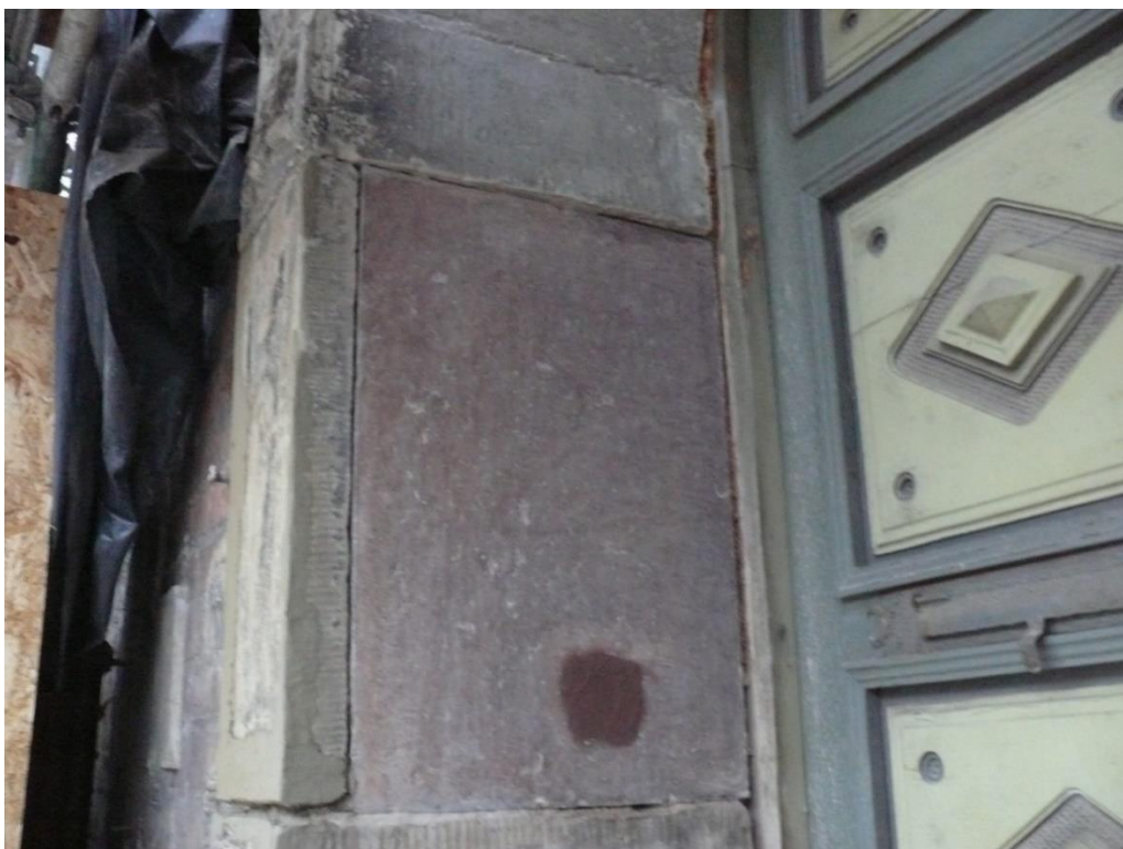
Wypełnienie ubytków w marmurze i piaskowcu. Powierzchnia marmuru po oczyszczeniu.
