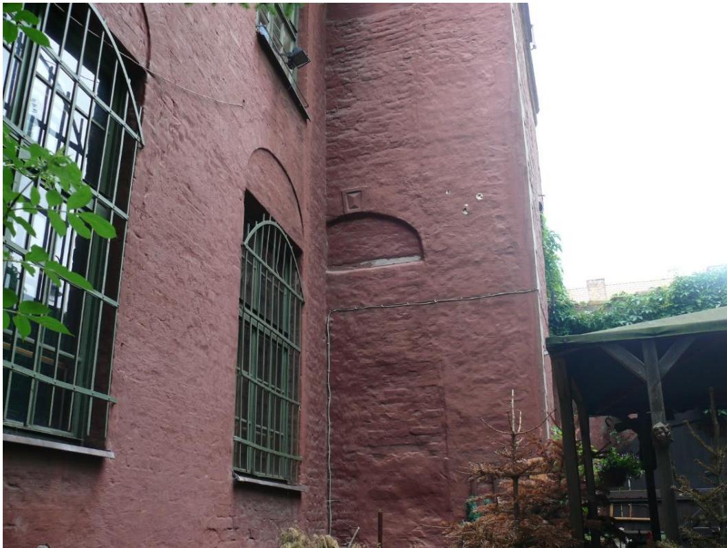
Ryzalit z prawej strony jest fragmentem budynku ustawionym kalenicowo do ulicy. Widoczny łuk był nad zamurowanym otworem okiennym.
