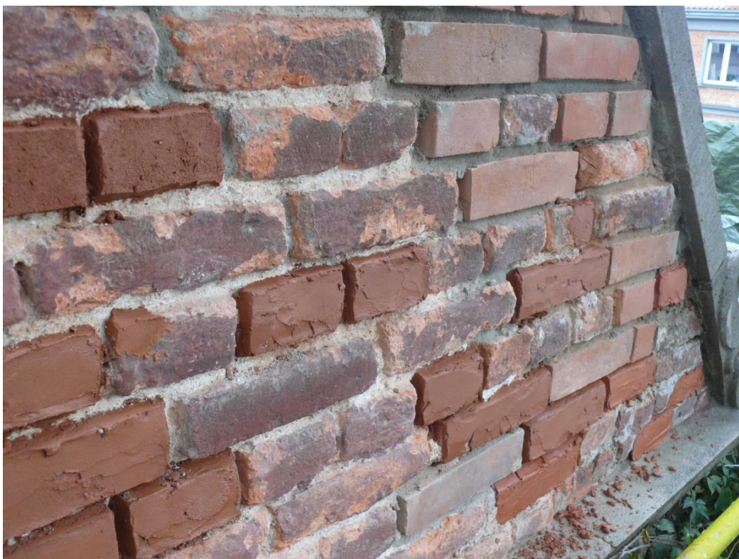
Przemurowania w miejscach głębokich ubytków oraz wypełnienie płytszych ubytków przy pomocy zaprawy mineralnej barwionej w masie.
