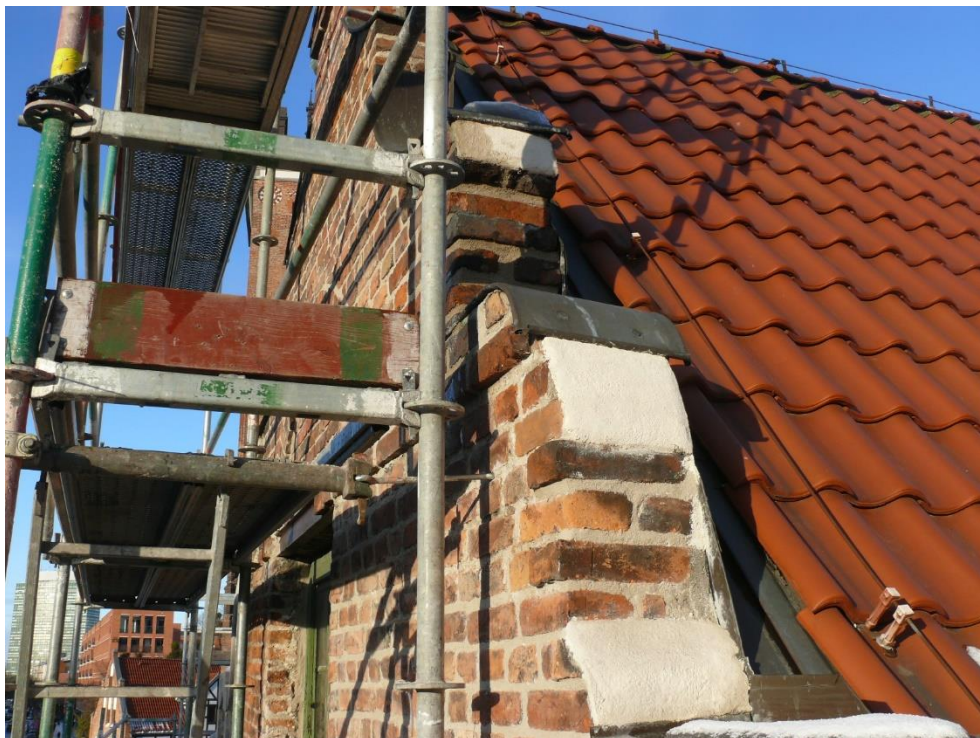
Spiływy na szczycie pokryte nową zaprawą tynkarską.
