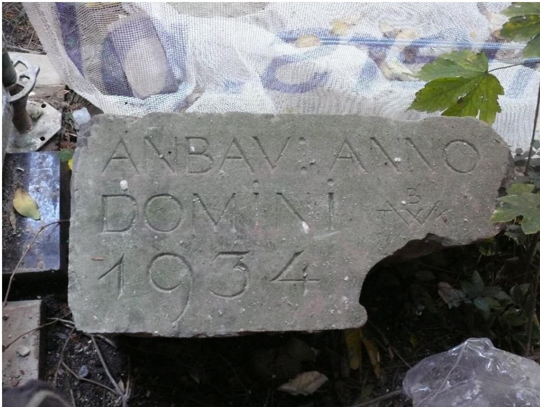
Tablica znajdująca się pod murem na dziedzińcu wykonana w technice zbliżonej do lastriko- identyczny materiał jak zachowany detal na szczytach.
