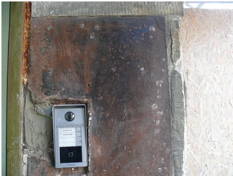
Wypełnienie głębokiego ubytku przy domofonie.
