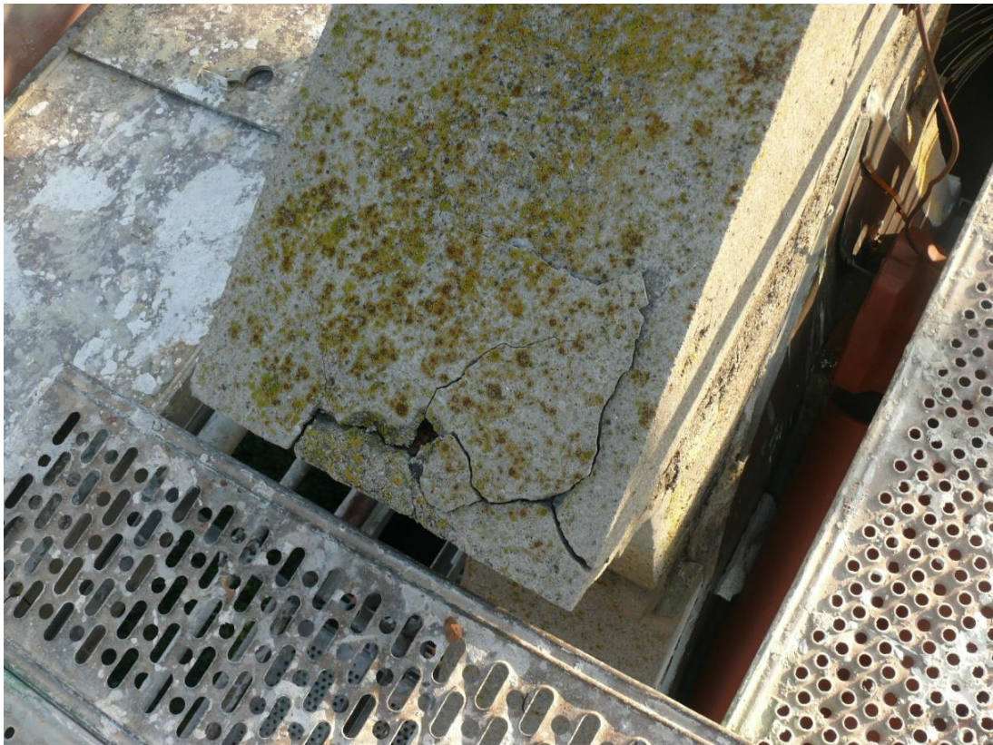
Uszkodzony fragment tympanonu z datą1647.
