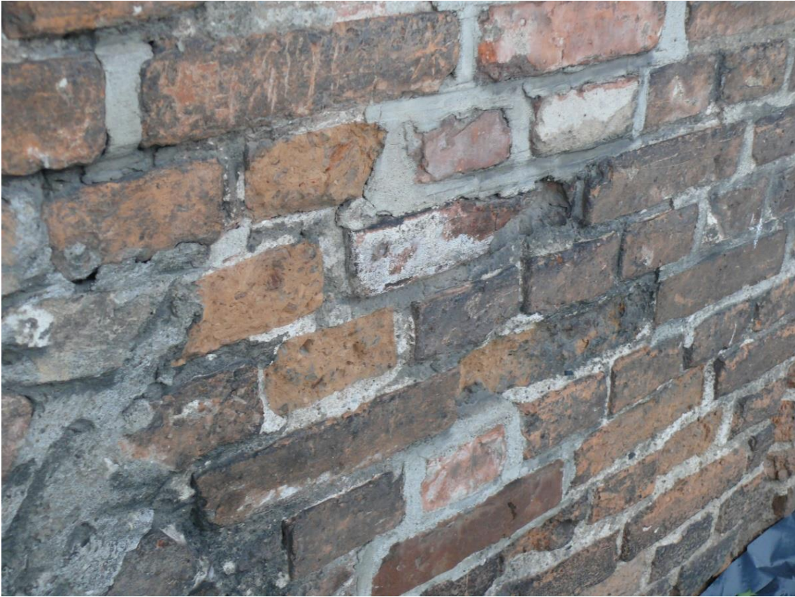
Fragment przyziemia- w przewadze cegły oryginalne, punktowo spoiny wypełniono zaprawą cementową.
