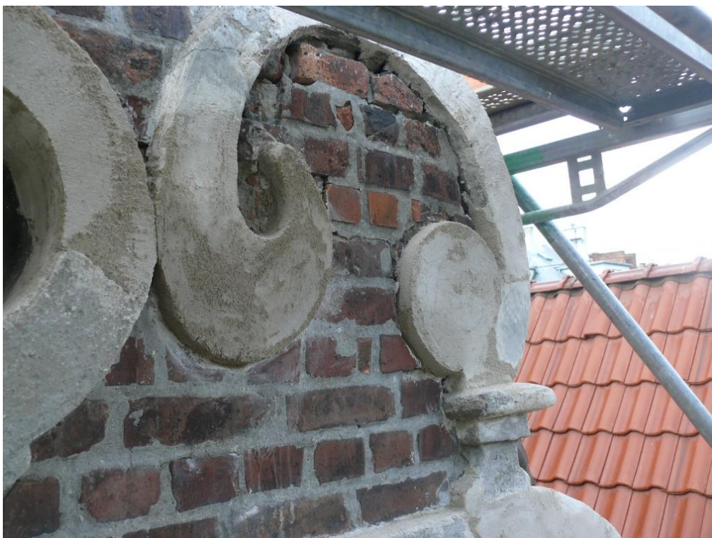
Warstwa podkładowa wykonana z zaprawy tynkarskiej.
