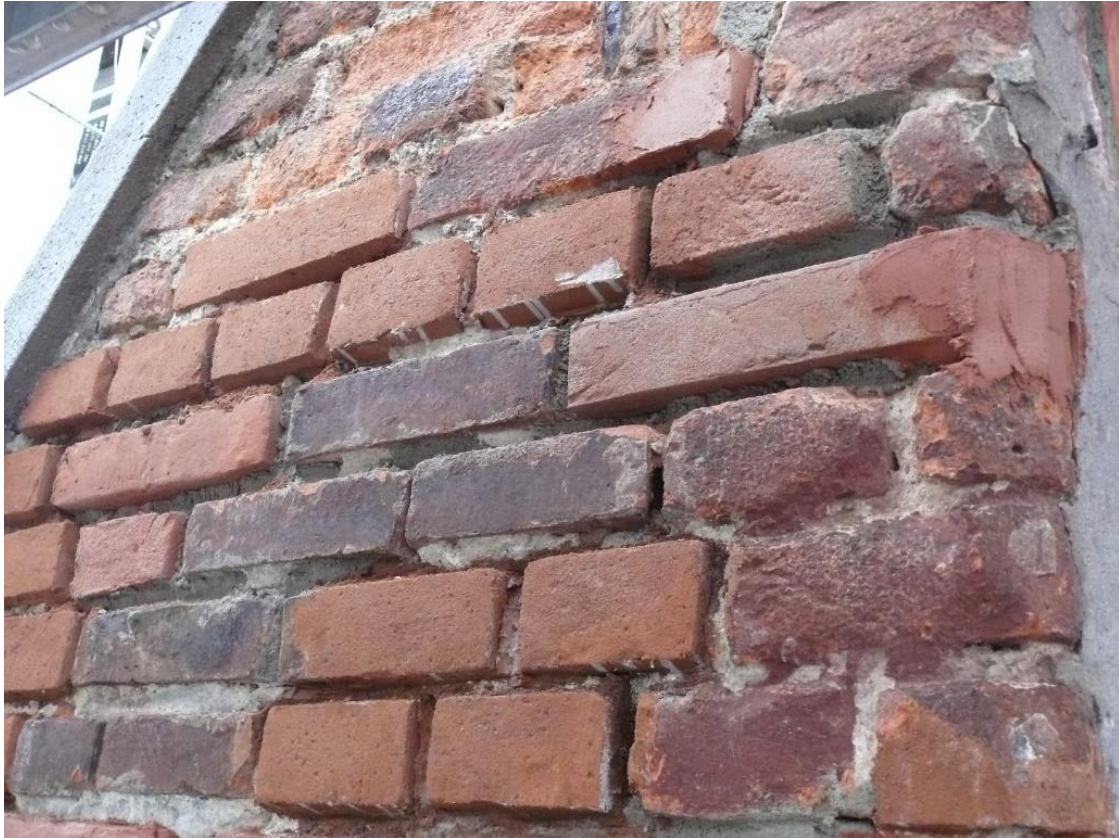
Fragment szczytu widoczne przemurowania z zachowaniem wstępu oryginalnego.
