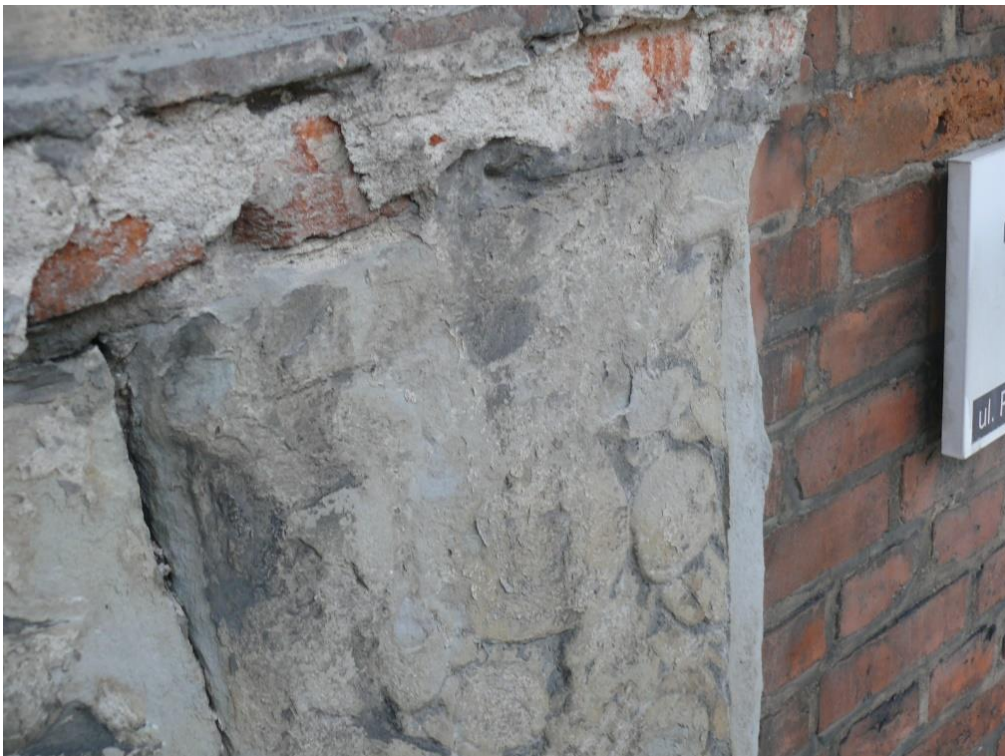
Architraw wykonany metodą ciągnięcia na miejscu był wyłożony na konstrukcji z dachówek.
