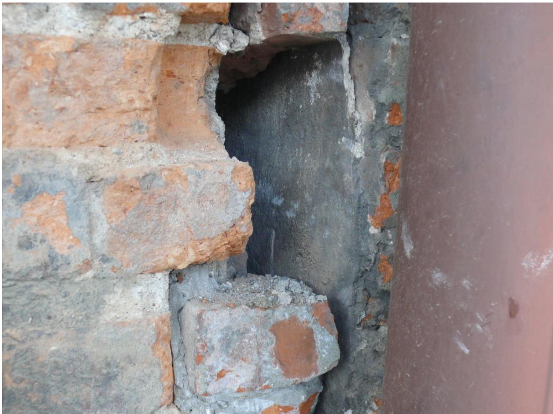
Rozwarstwienie w miejscu łączenia dwóch budynków po usunięciu zaprawy betonowej.
