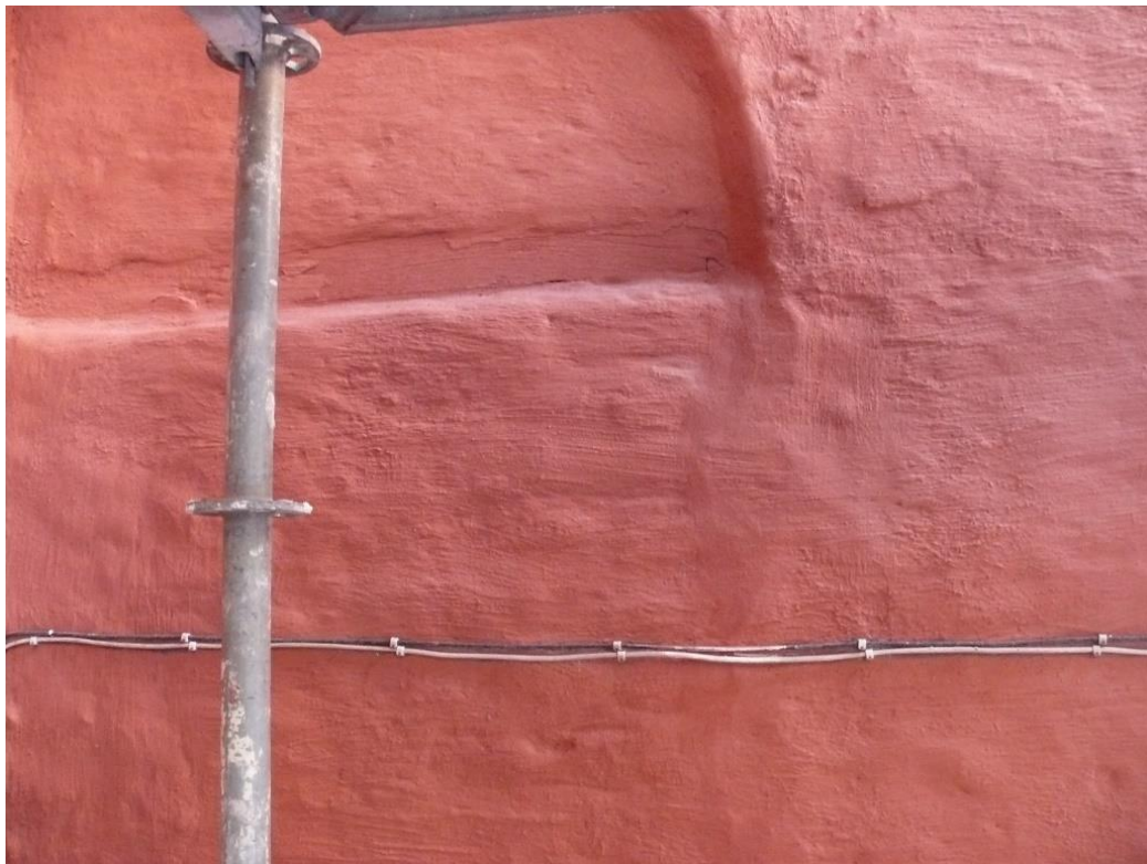
Boczna strona ryzalitu pomalowana farbą elewacyjną.
