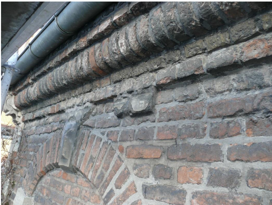
Gzyms z cegieł przyciętych w kształcie profilu- na nim początkowo była wyłożona zaprawa tynkarska.
