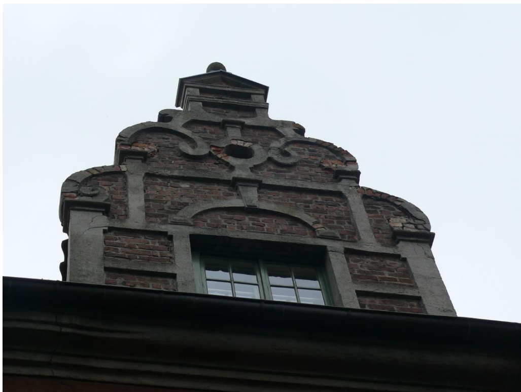
Detal architektoniczny zachowany w złym stanie.
