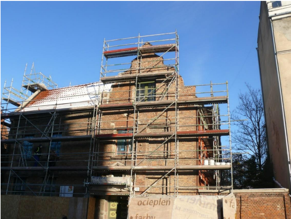
Widok ogólny elewacji frontowej przed demontażem rusztowań.
