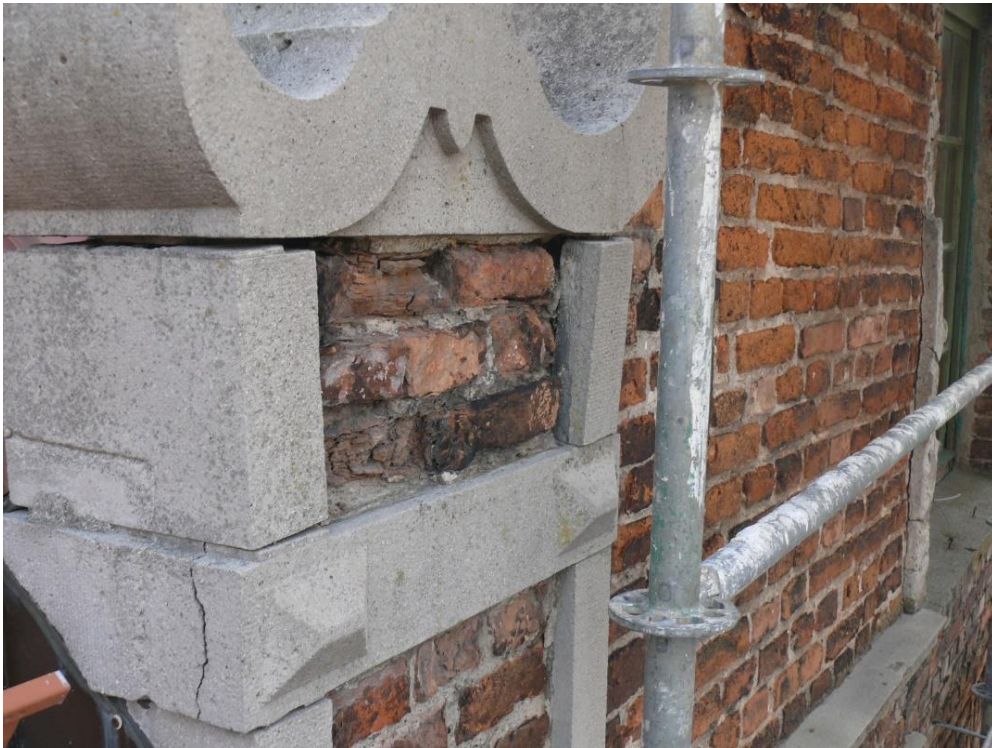
Odspojony fragment pionowego elementu.
