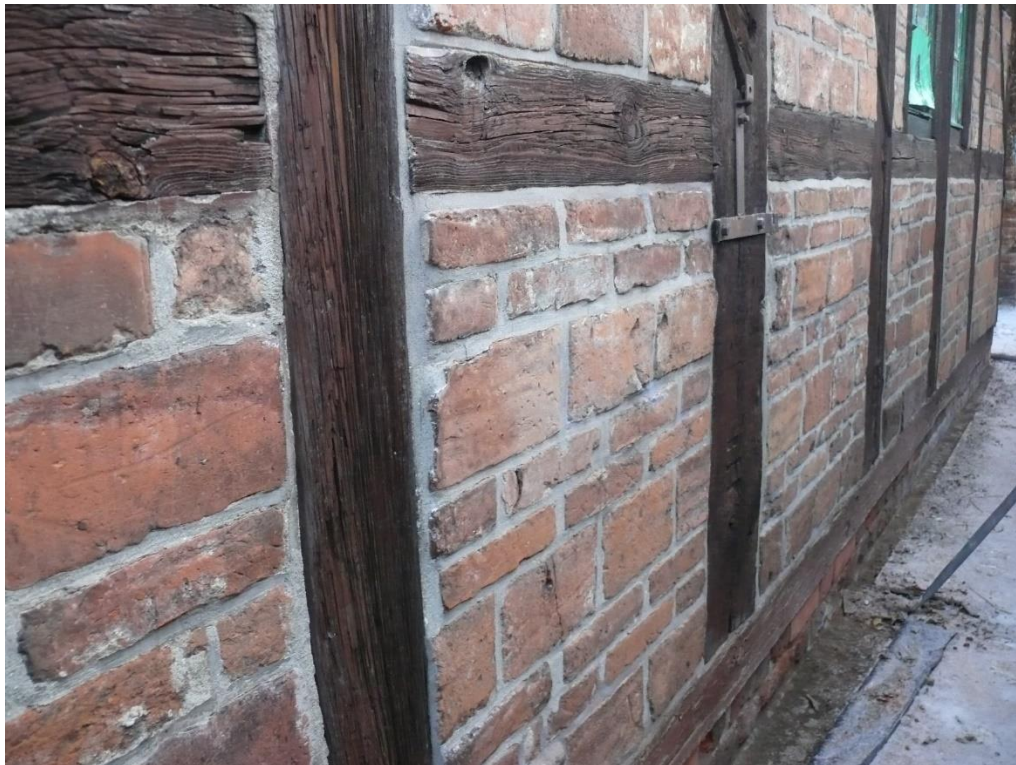
Wymieniono zaprawę w spoinach w miejscach pęknięć.
