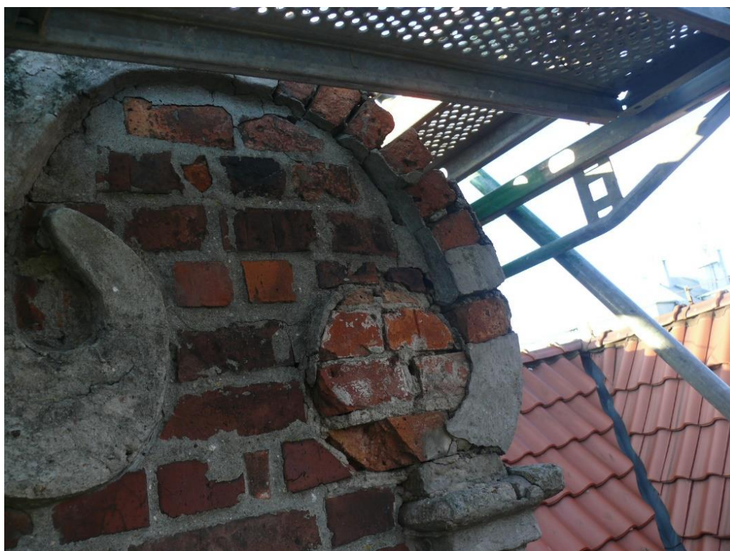
Dekoracja szczytu wykonana z zaprawy betonowej wykonana jest na konstrukcji ceglanej.
