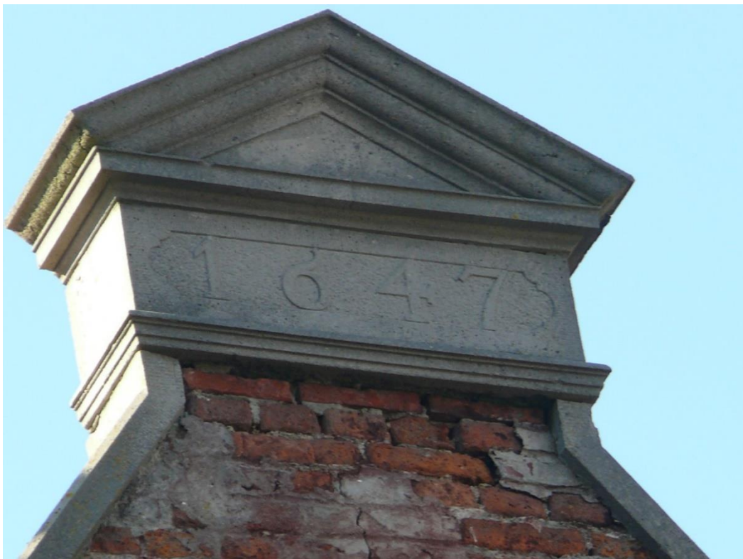
Tympanon z datą 1647 wykonany z zaprawy w technice zbliżonej do lastriko.
