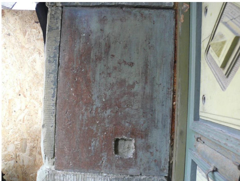
Prostokątny głęboki ubytek wypełniony zaprawą podkładową. Płyta marmurowa przed oczyszczeniem.
