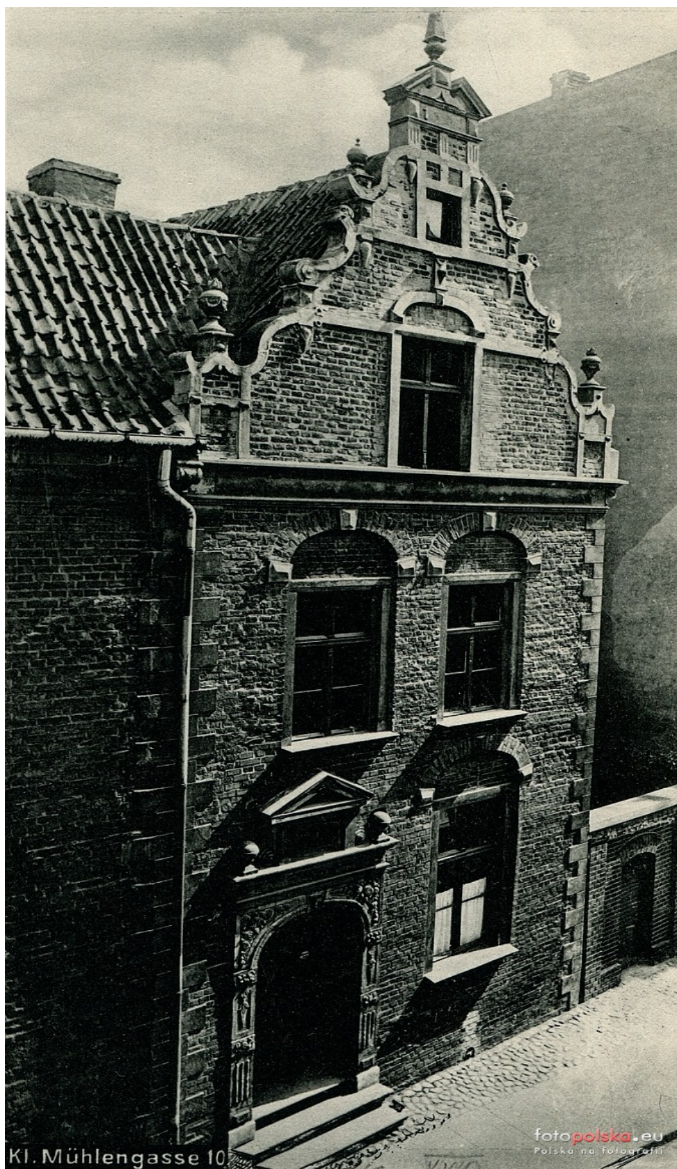
Elewacja budynku danej plebanii, stan z ok. 1905 (fot. Domena publiczna- fotopolska.eu)
