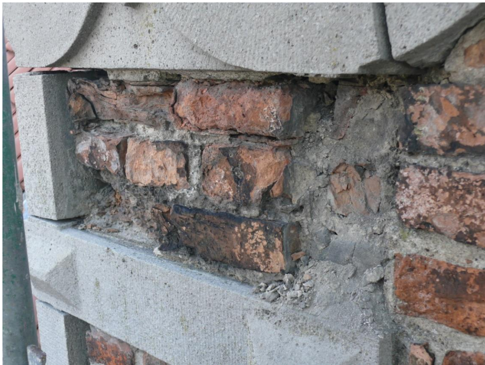
To samo miejsce po zdemontowaniu obluzowanego elementu.
