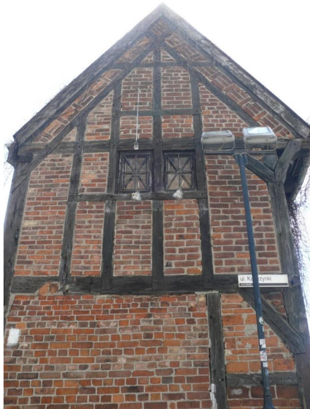
Widok ogólny od strony północnej.
