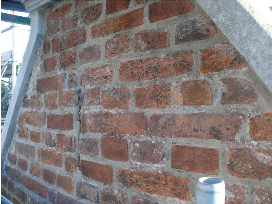
Górna partia szczytu, wypełnienia ubytków wykonane wyłącznie z zaprawy mineralnej barwionej w masie.
