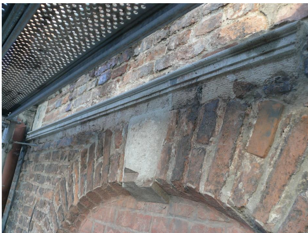
Zwornik z zaprawy został zabezpieczony opaskami z mineralnej zaprawy uelastycznionej.
