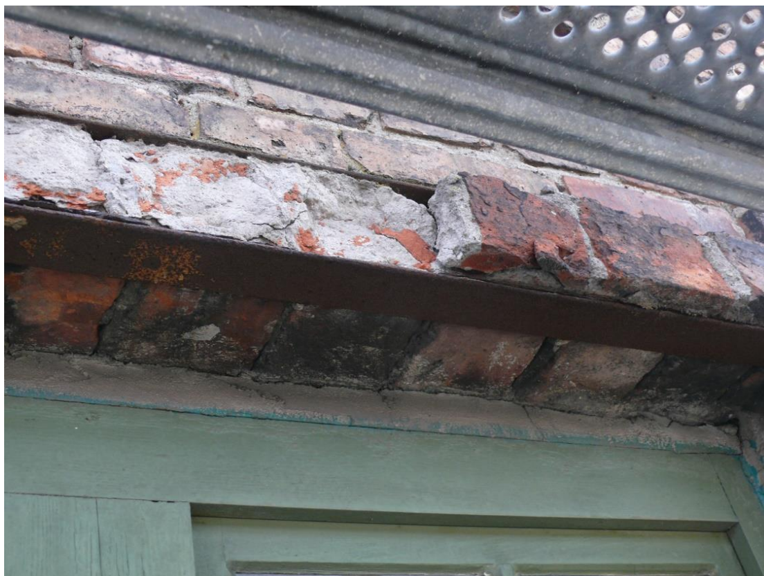
Nadproże okienne wykonane z dwuteownika- naprawa powojenna.
