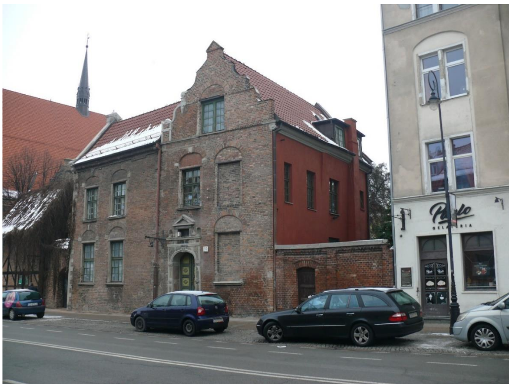
Widok ogólny od strony południowo- zachodniej.
