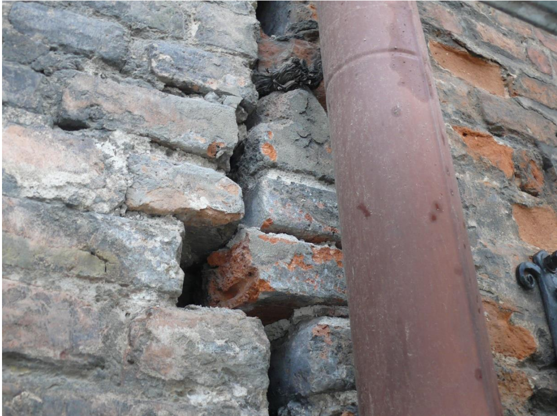
Rozwarstwienie w miejscu łączenia dwóch budynków po usunięciu zaprawy betonowej.
