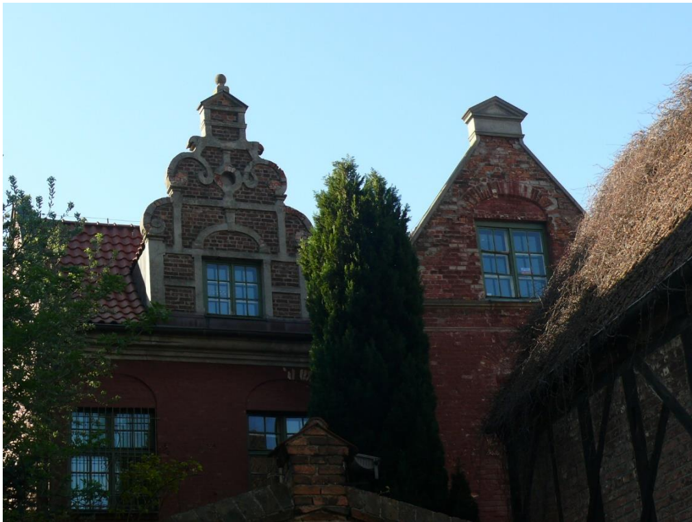
Szczyt po lewej stronie, detal architektoniczny wykonany z zaprawy.
