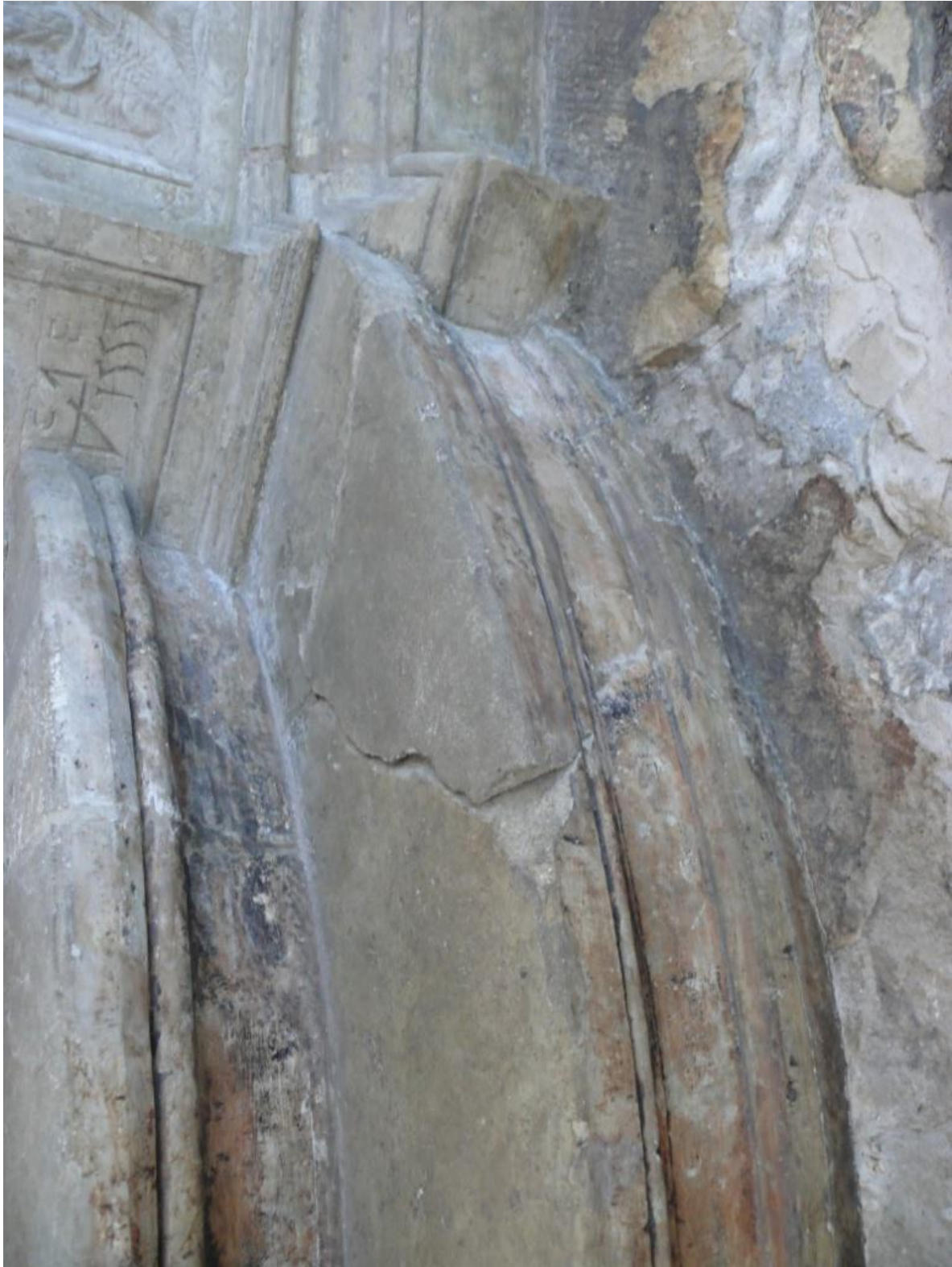
Odspojona zaprawa wypełniająca ubytek w dolnym stopniu.
