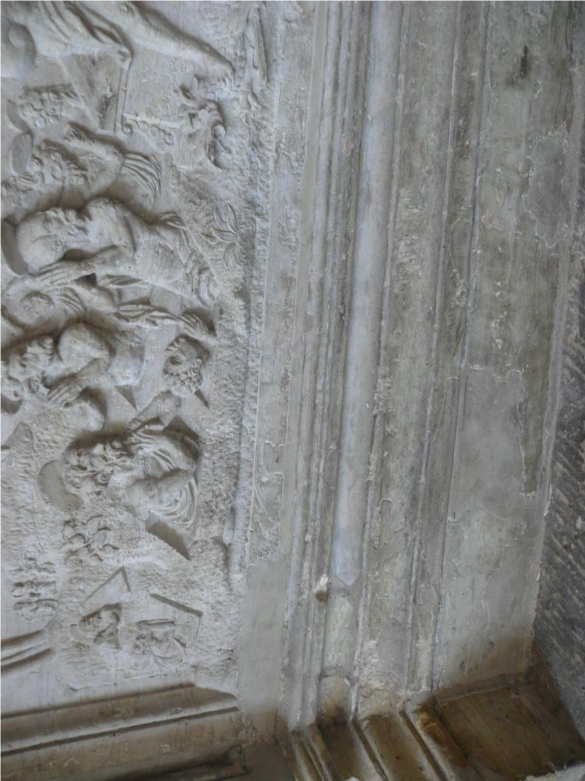
Fragment sceny Zmartwychwstania, na cokole widoczne przebarwienia i ubytki.
