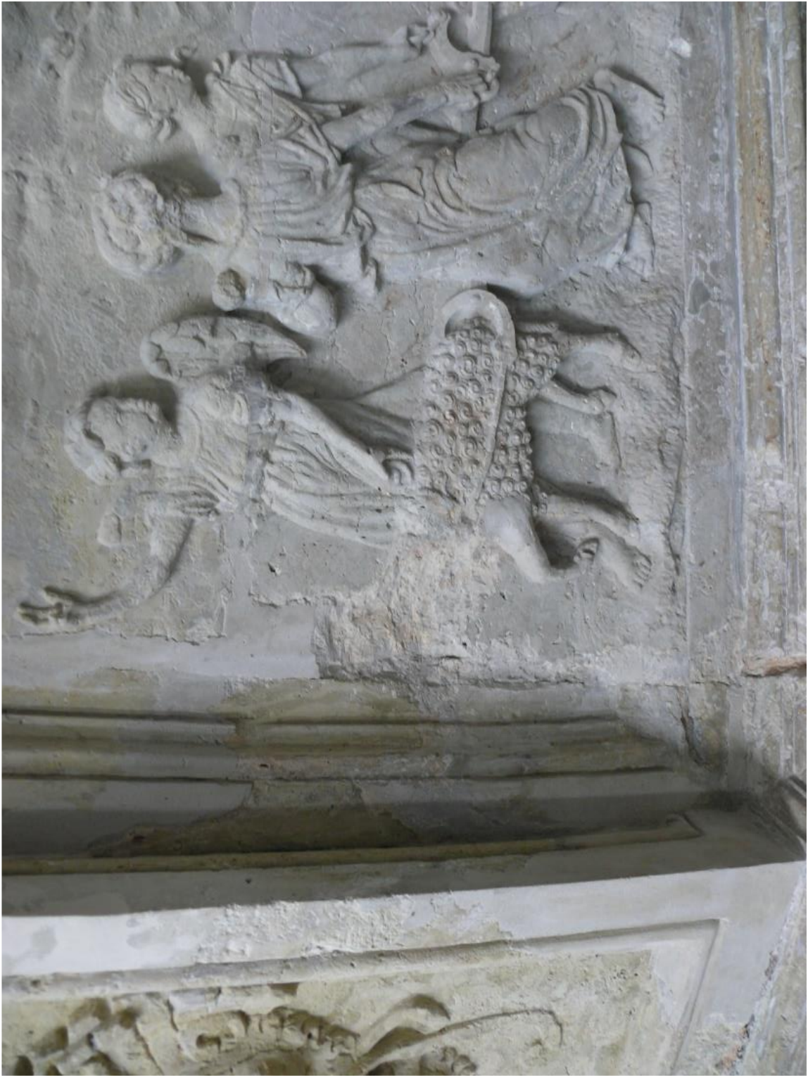
Płycina w trakcie usuwania odspojonej i przebarwionej zaprawy z ubytku.
