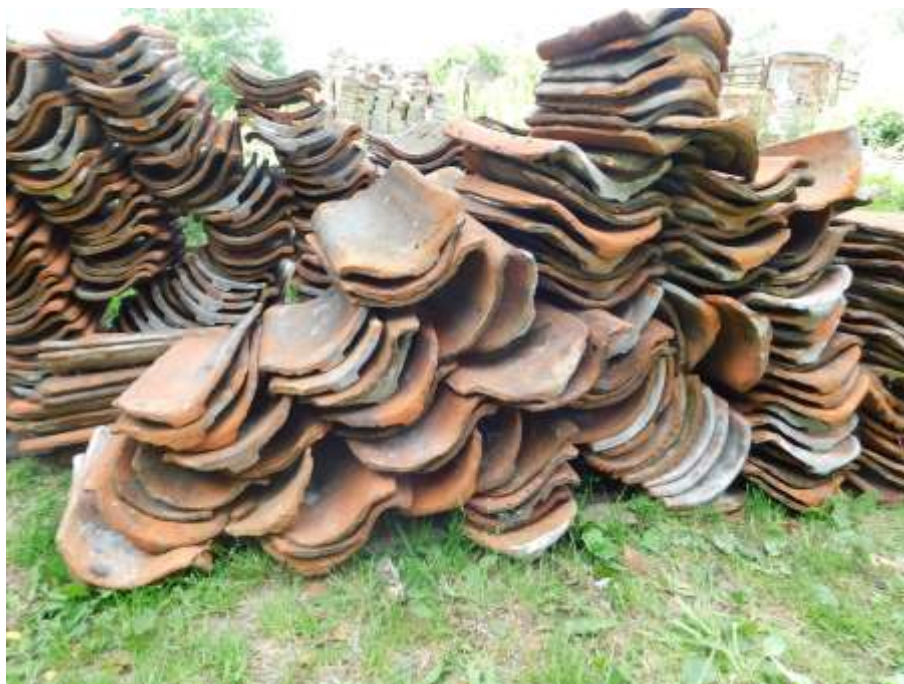
Fot . 12 Zdemontowane dachówki przed selekcją.
