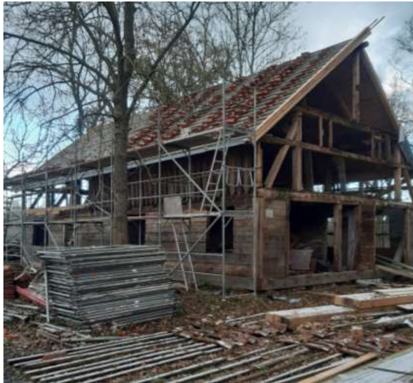
Fot. 23 Układanie dachówki na powierzchni dachu.
