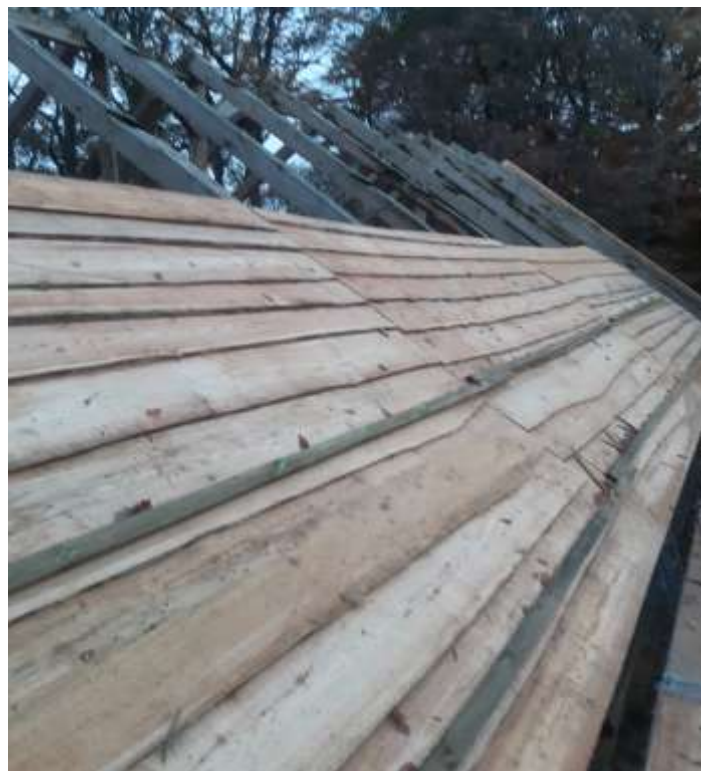
Fot. 19 Deskowanie dachu od strony zachodniej.
