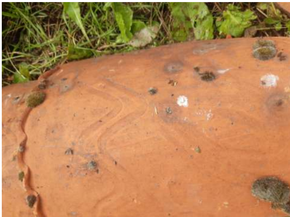
Fot. 15 Ręczne zdobienia powierzchni gąsiorów wraz z ręcznym zdobieniem krawędzi.
