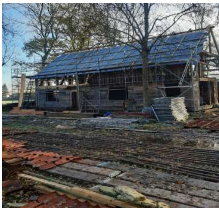
Fot. 20 Wykonane odeskowanie powierzchni zachodniej dachu wraz z membraną i kontr łątami
