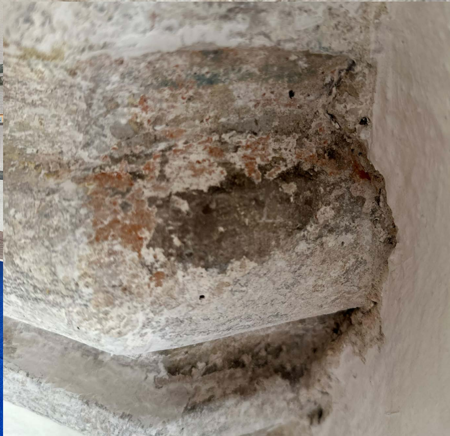
dolne profile wsporników były błękitne, środkowe ugrowy i czerwony a górny błękitny
