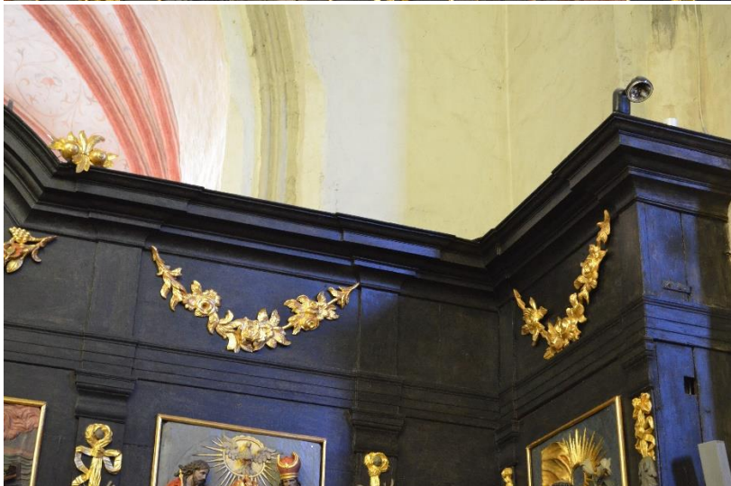
Elementy snycerskie , stan po wykonaniu prac
