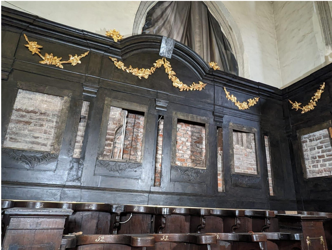
Girlandy po etapie restauracji i montażu na zaplewkach
