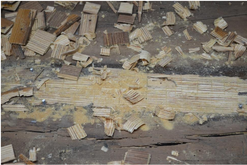
Odwrocie, w trakcie usuwania listew wzmacniających łączenia desek
