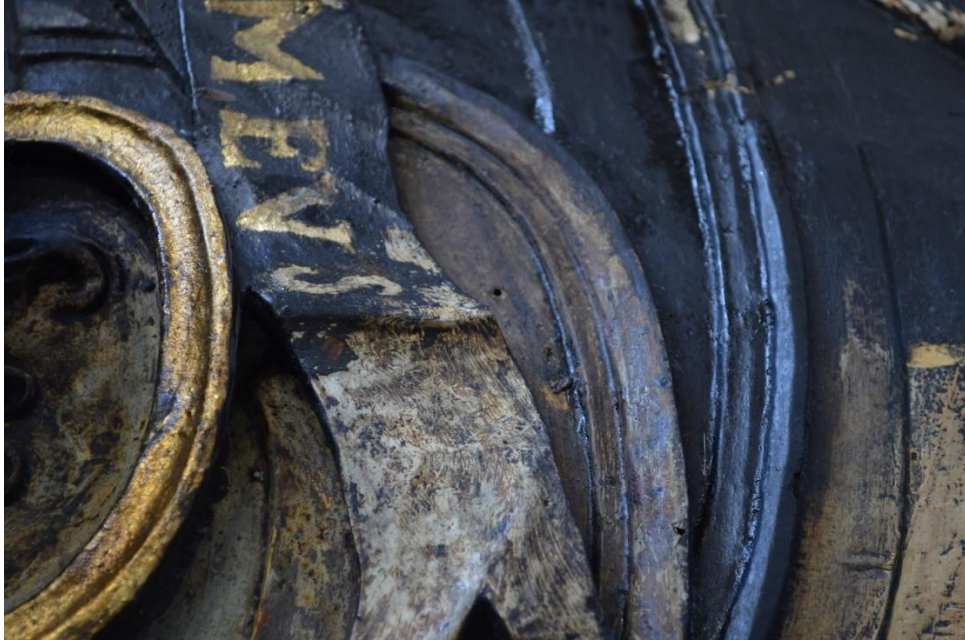
Zdjęcie ilustrujące etap usuwania bitumicznej farby z 2 poł XIX w.
