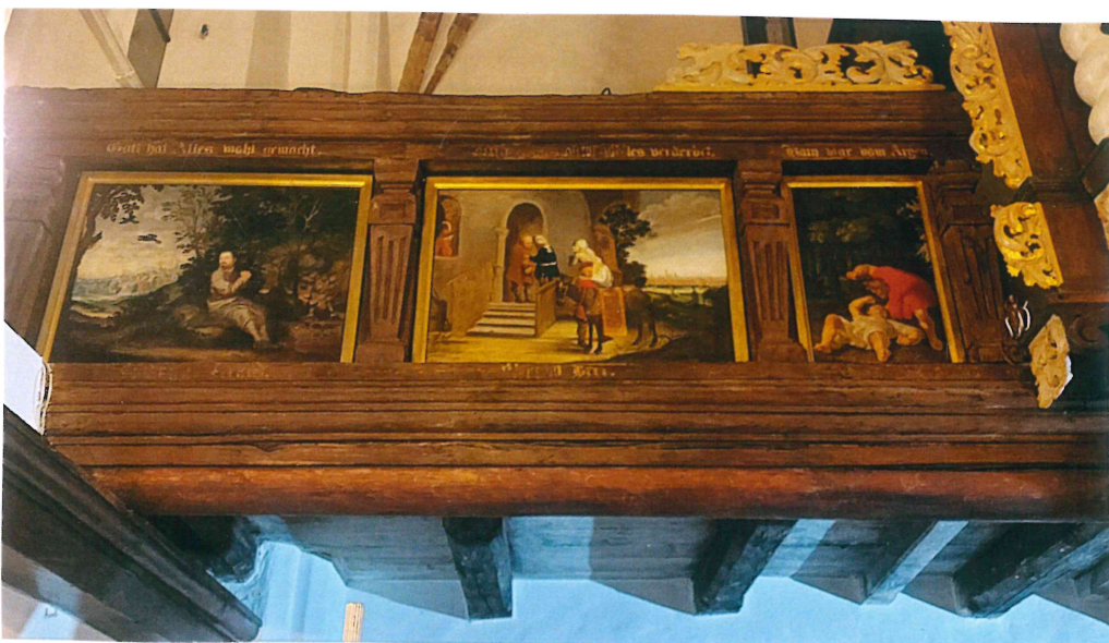
Widok podniebia empory /strop malowany/
