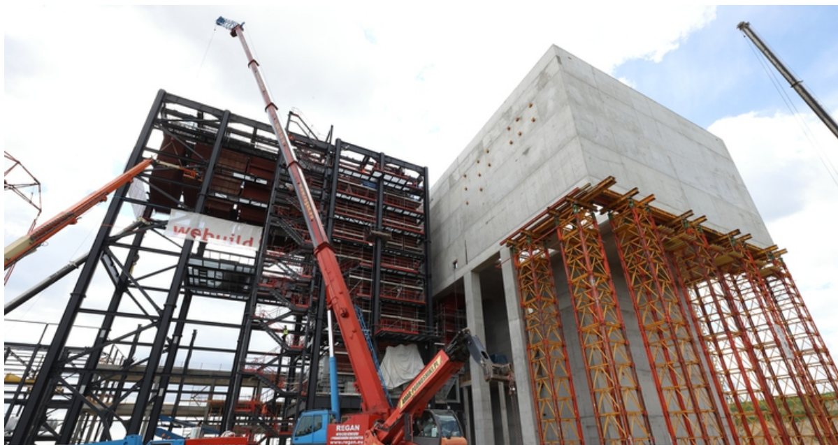
ryc. 2. Prace budowlane na terenie Portu Czystej Energii. Fot. G. Mehring / gdansk.pl
