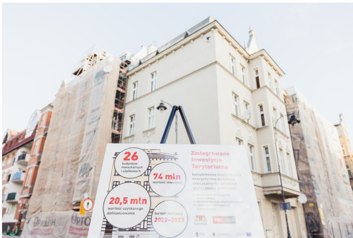
ryc. 1. Termomodernizacja 26 budynków komunalnych. Fot. D. Paszliński /gdansk.pl
