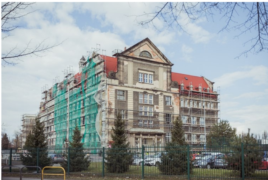
Rycina 5. Prace remontowe budynku ZSO nr 6 przy ul. Głębokiej. Fotograf: Dominik Paszliński / www.gdansk.pl
