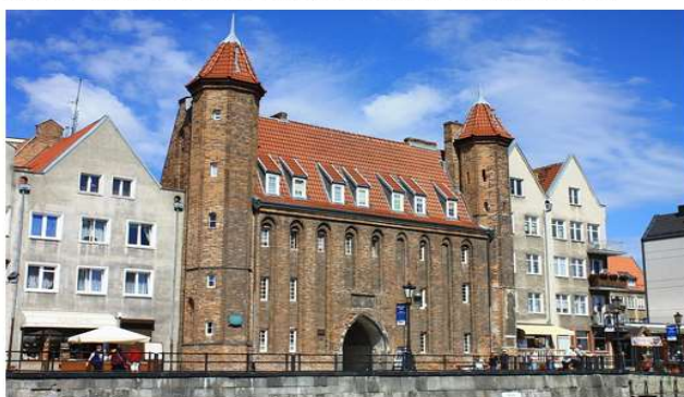
Wspólnota Mieszkaniowa ul. Straganiarska 37 A i B - Brama Straganiarska Wykonanie izolacji poziomej południowej części Bramy
