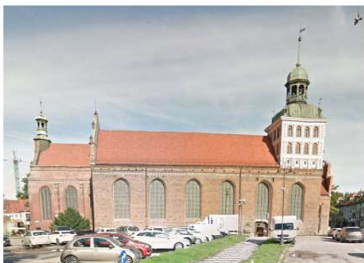
Parafia Rzymskokatolicka pw. Św. Brygidy - Kościół pw. Św. Brygidy Stabilizacja i wzmocnienie murów (etap II)
