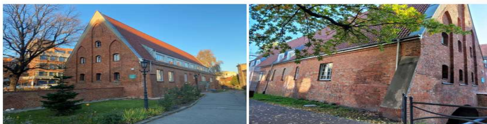
Polski Związek Wędkarski Okręg w Gdańsku – Mały Młyn Prace konserwatorskie zachodniej części elewacji północnej wraz z przyporą
