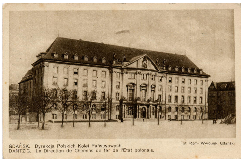
Ryc. 39. Lipy na ulicy Dyrekcyjnej 2-4 (Am Olivaer Tor), przed budynkiem Dyrekcji Kolei, lata 20. XX w.
