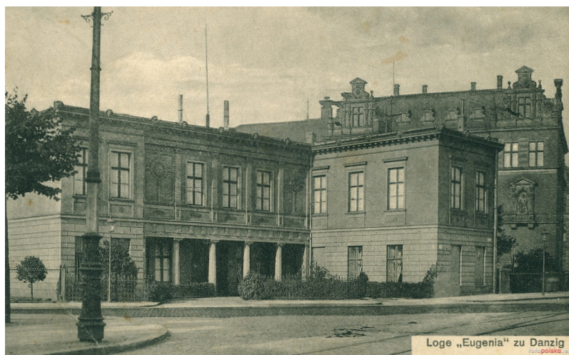
Ryc. 75. Przednia elewacja budynku łoży „Eugenia” przy ulicy Nowe Ogrody 18, po 1883.
