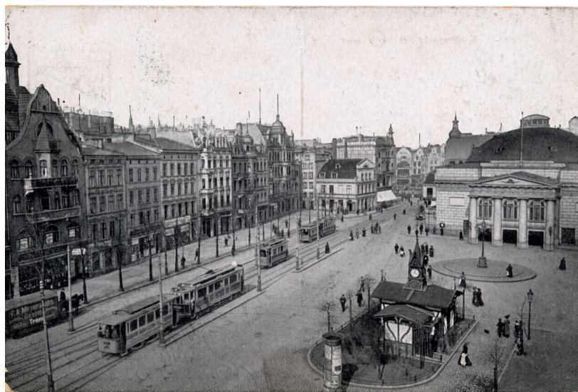
Ryc. 46. Szpaler drzew (pozostałość po wcześniejszej alei?) po zachodniej stronie Targu Węglowego i regularne obsadzenie drzewami szaletu miejskiego na pocztówce z 1917 roku.
