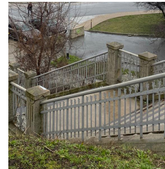
balustrady z betonu i stali w kolorze szarym
