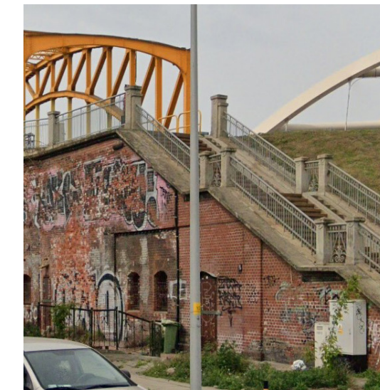
mur z cegły
