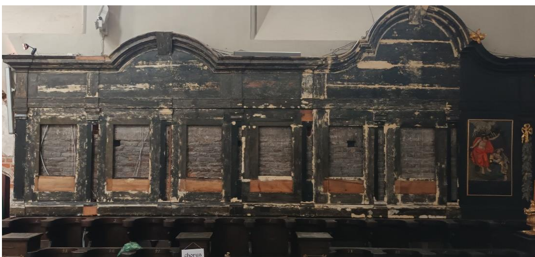
Stan po usunięciu zamalowań XIX wiekowych, dezynsekcji, impregnacji i uzupełnieniu ubytków drewna i zaprawy
