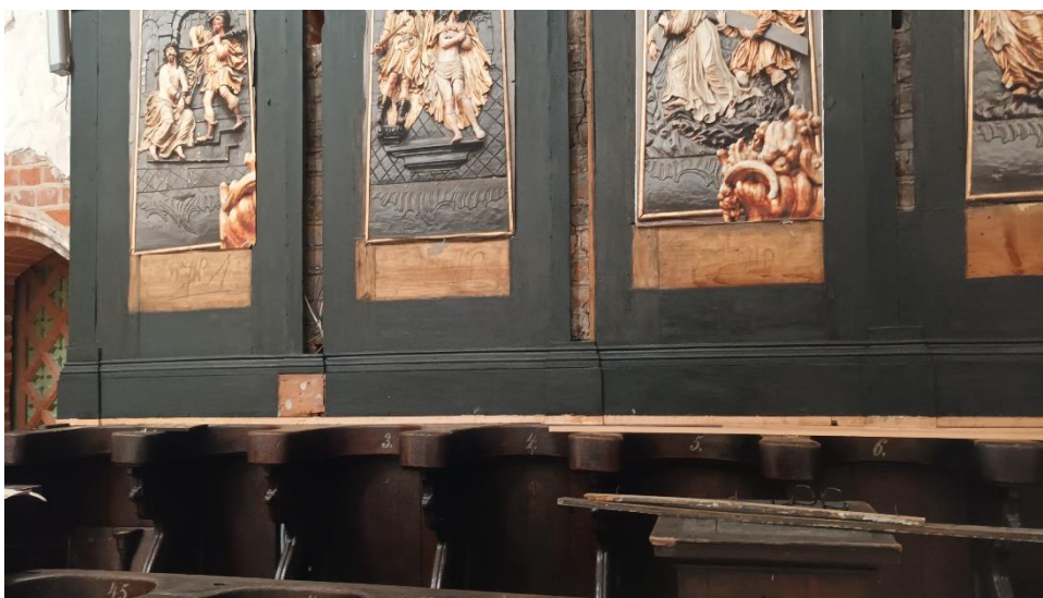
Stolarskie uzupełnienia szczeliny między zapleckami i siedziskami
