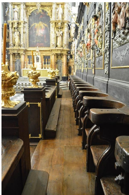
Deski podłogowe po flekowaniu, kitowaniu i scaleniu kolorystycznym nawiązującym do siedzisk gotyckich
