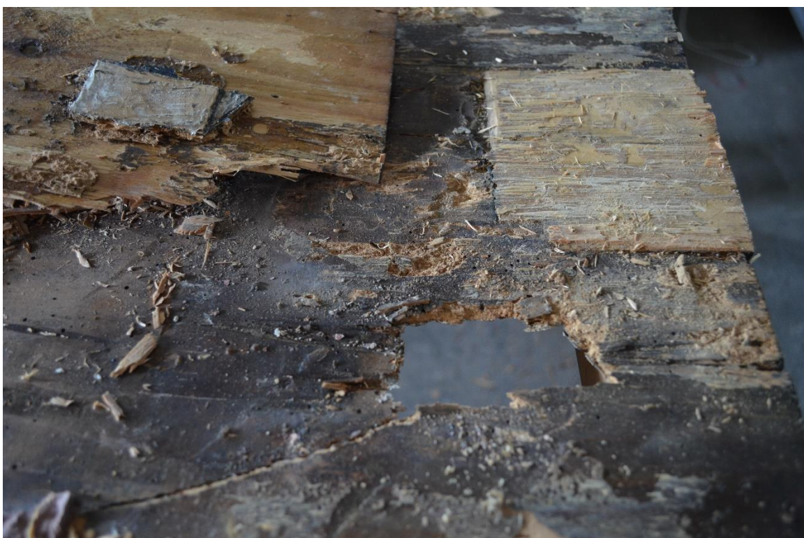
W trakcie usuwania listew wzmacniających odwrocie. Drewno rozpadające się przy niewielkim nacisku.
