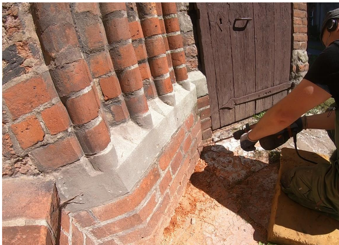
Ilustracja 24. Pogłębianie otworów przy użyciu wiertła 120 cm w najgrubszych partiach muru
