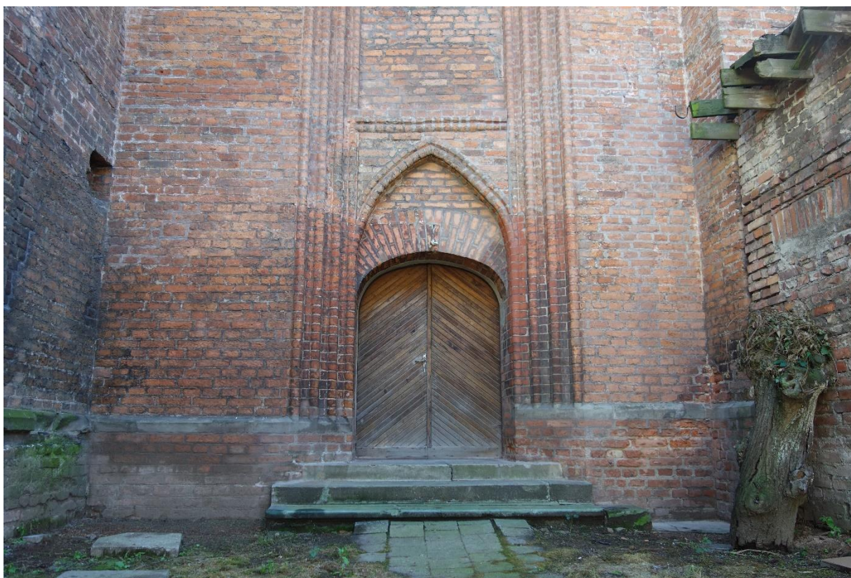
Ilustracja 49. Po zakończeniu prac
