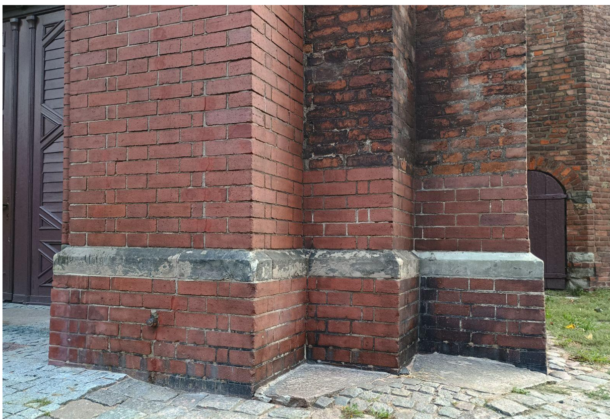
Ilustracja 44. Po zakończeniu prac
