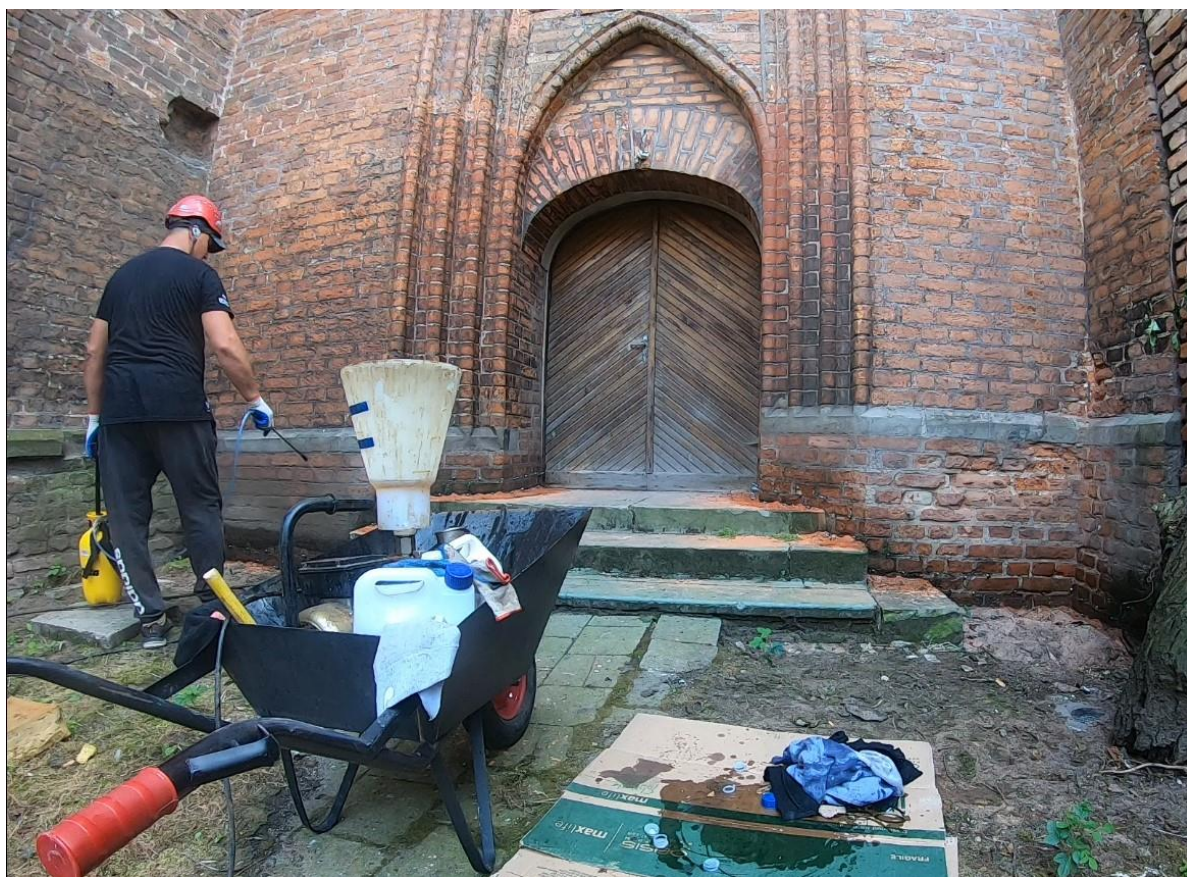
Ilustracja 33. Zwilżanie otworów przed wprowadzeniem mieszanki iniekcyjnej
