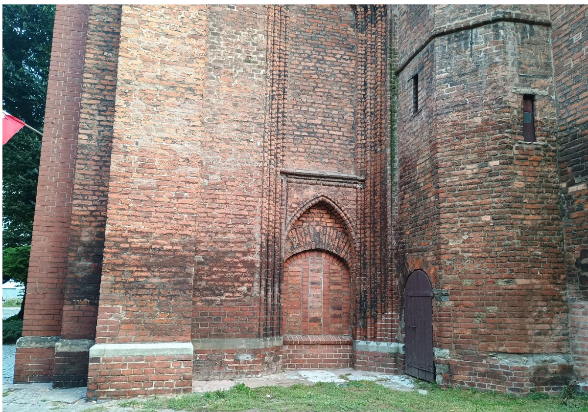
Ilustracja 45. Po zakończeniu prac
