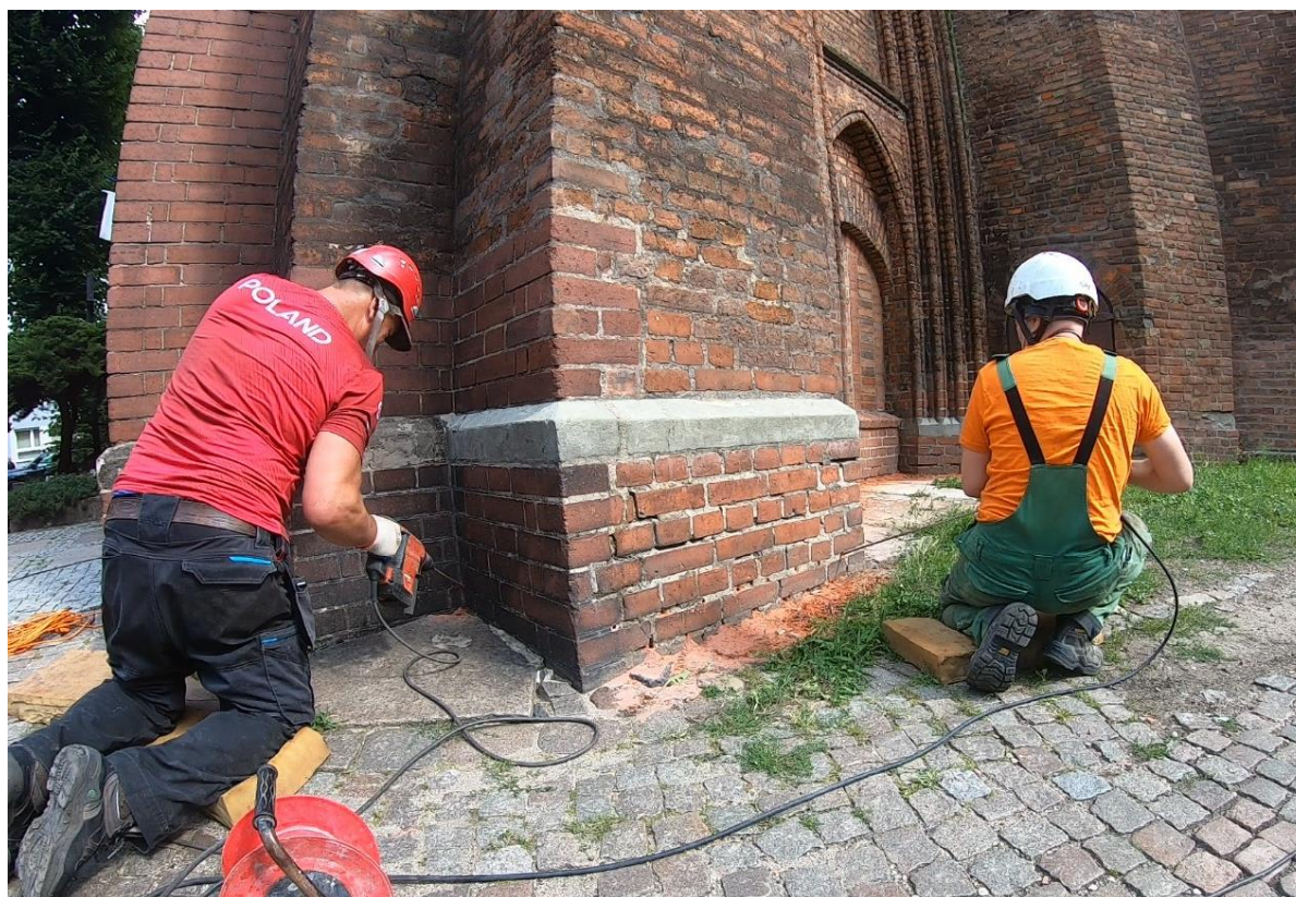
Ilustracja 20. Wykonywanie odwiertów pod iniektory. Z prawej pogłębianie otworów przy użyciu wierła 90 cm
