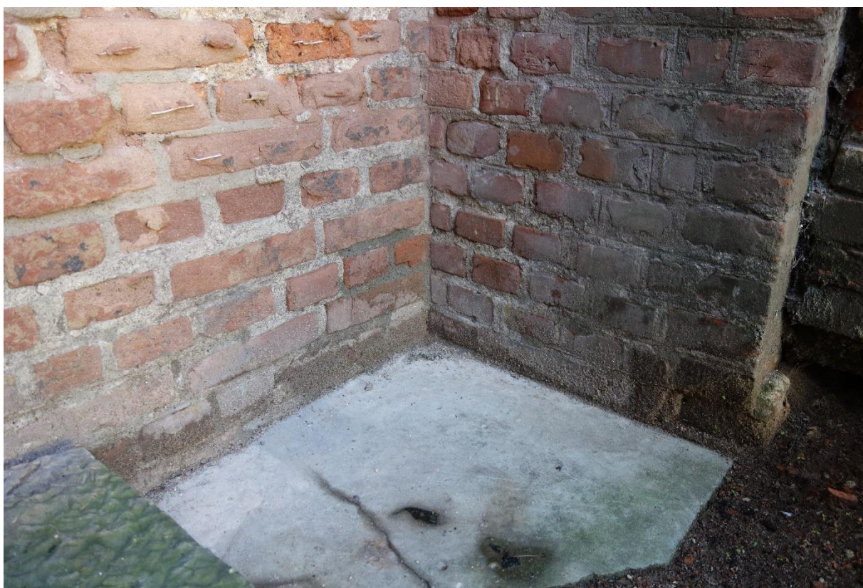
Ilustracja 52. Po zakończeniu prac
