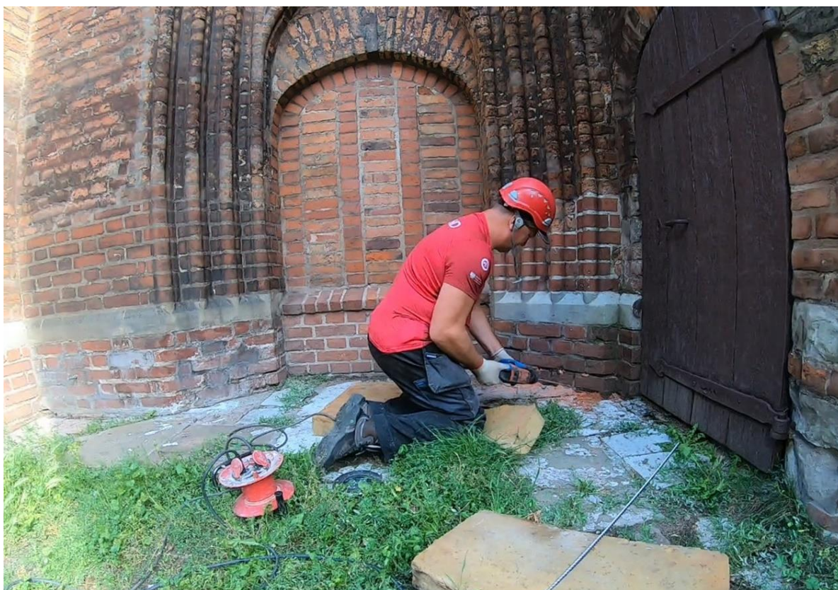
Ilustracja 19. Wykonywanie odwiertów pod iniektory (wierło dł. 40 cm)
