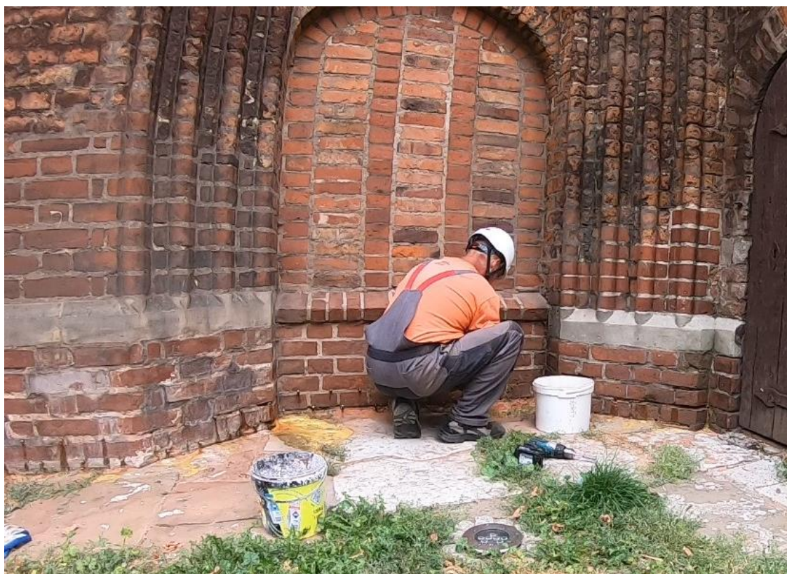
Ilustracja 37. Usuwanie iniektorów po aplikacji środka iniekcyjnego. Widoczne odwierty po wysyceniu żywicą
