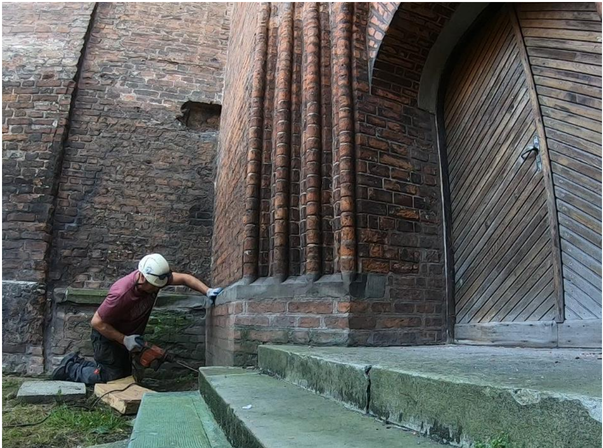
Ilustracja 25. Wykonywanie odwiertów pod iniektory
