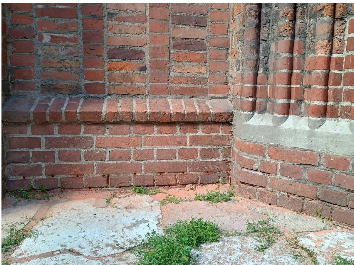
Ilustracja 30. Oczyszczone odwierty przygotowane do osadzenia iniektorów
