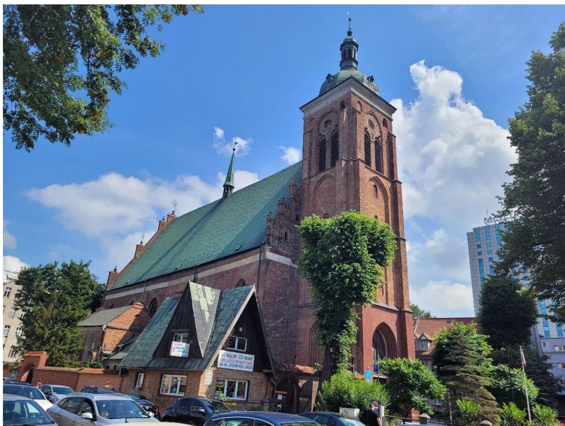
Ilustracja 8. Widok ogólny od północnego zachodu
