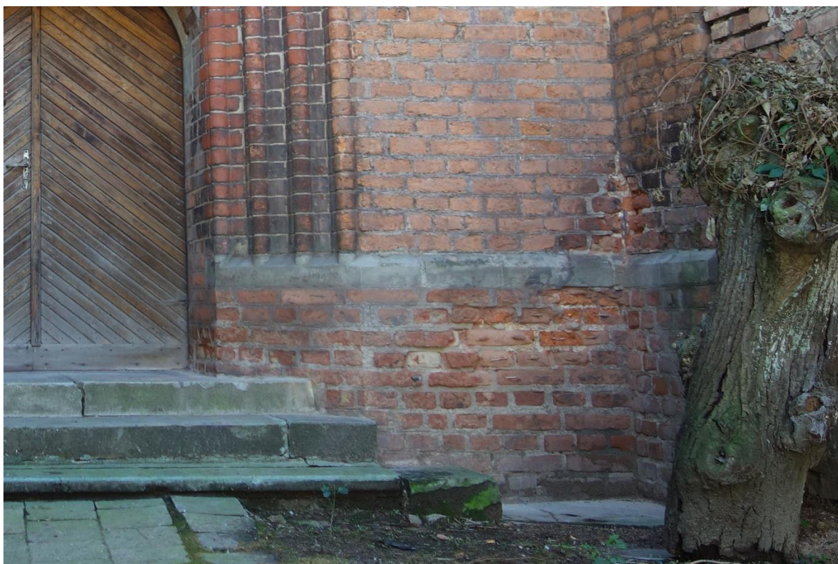
Ilustracja 51. Po zakończeniu prac
