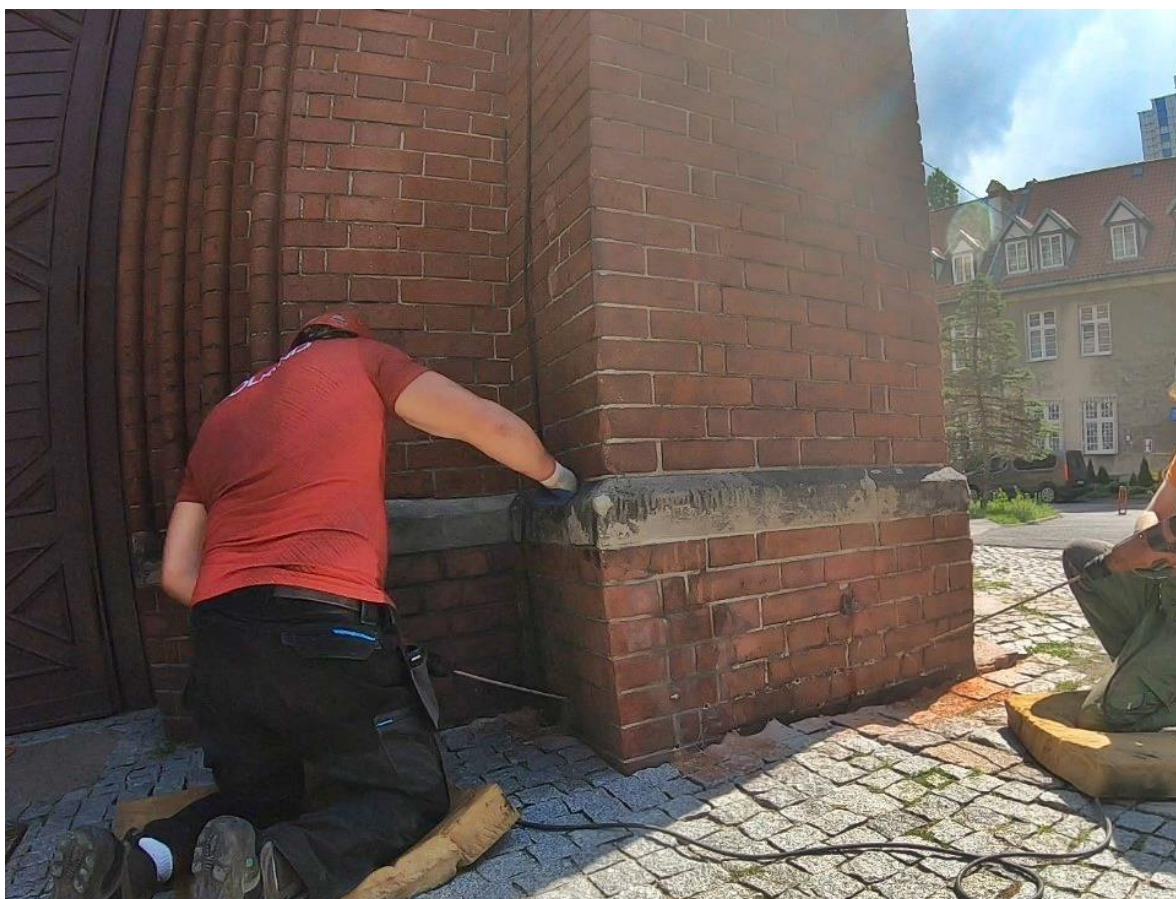
Ilustracja 21. Wykonywanie odwiertów pod iniektory. Z prawej pogłębianie otworów przy użyciu wiertła 90 cm
