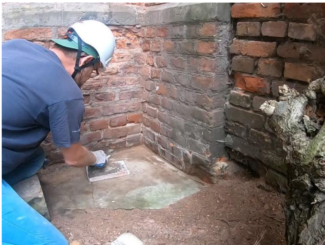
Ilustracja 38. Zabezpieczanie otworów zaprawą
