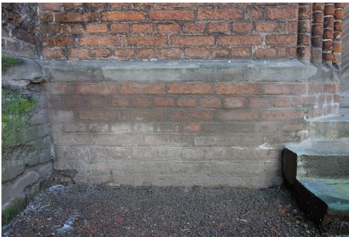
Ilustracja 50. Po zakończeniu prac
