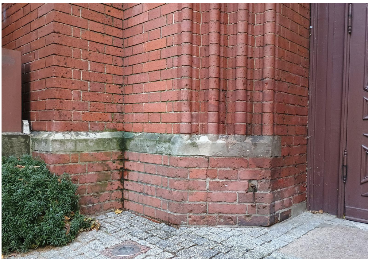
Ilustracja 42. Po zakończeniu prac
