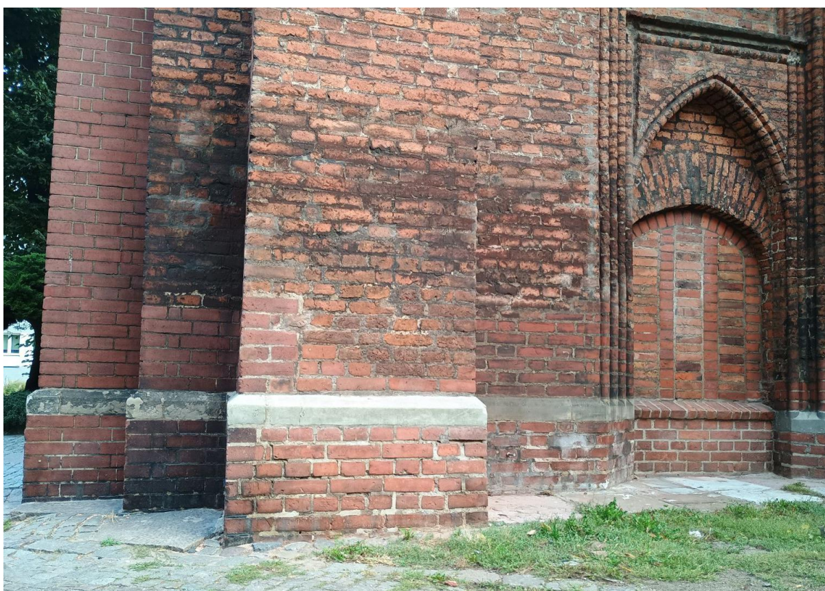
Ilustracja 46. Po zakończeniu prac
