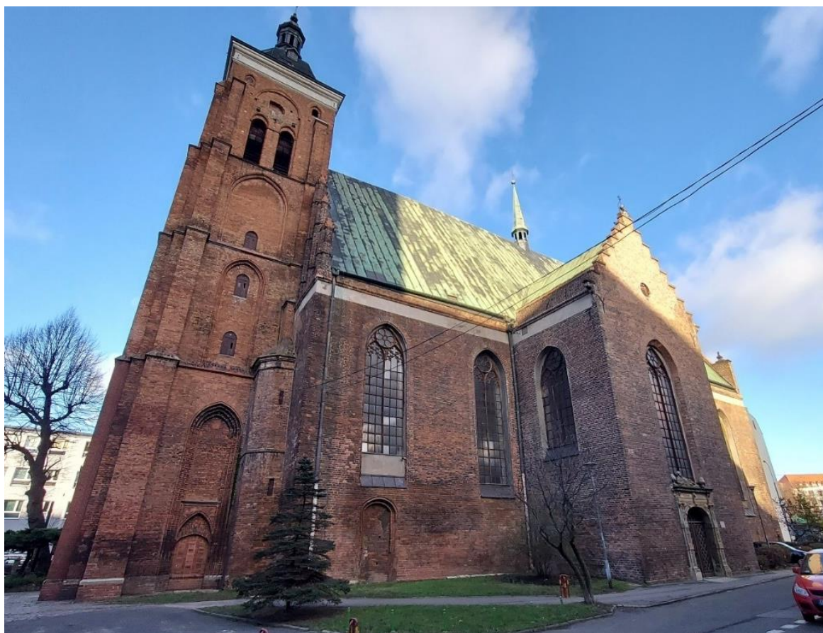
Ilustracja 9. Widok ogólny od południowego zachodu
