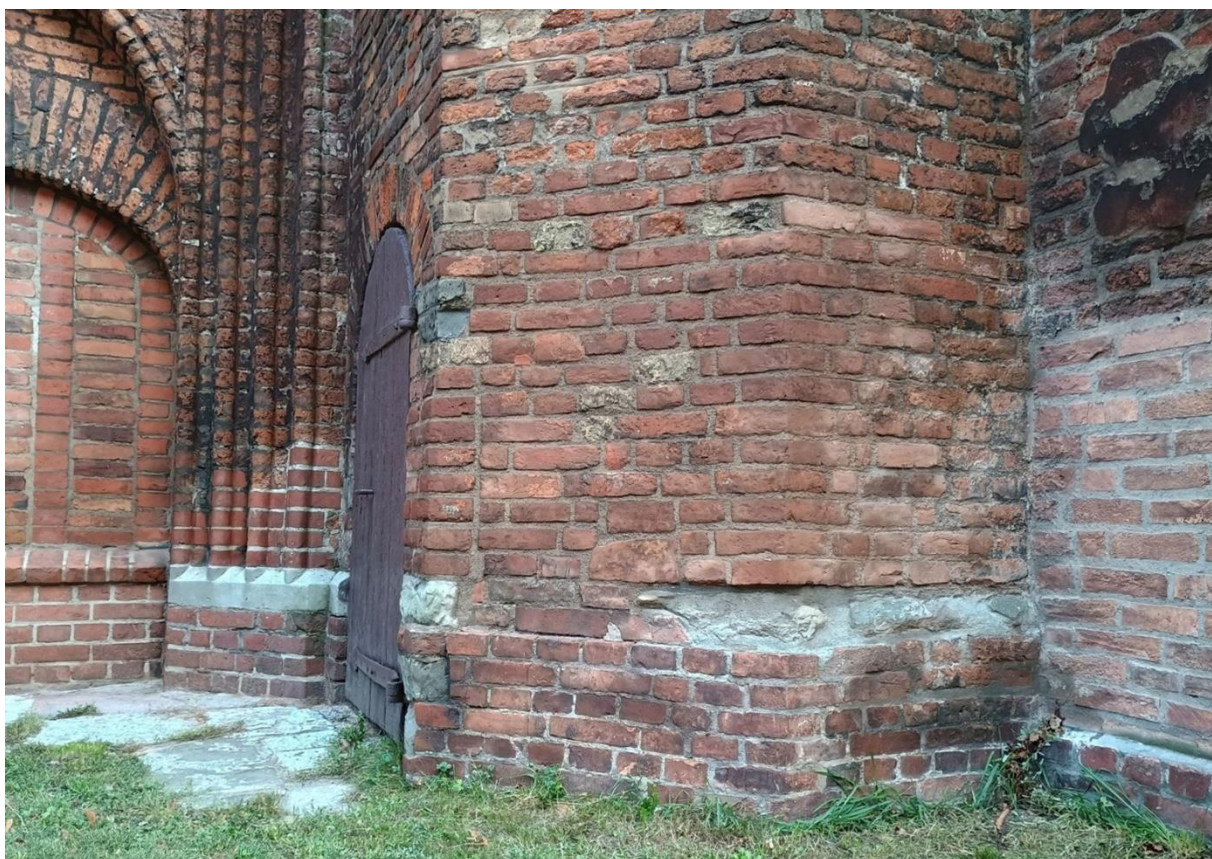
Ilustracja 48. Po zakończeniu prac
