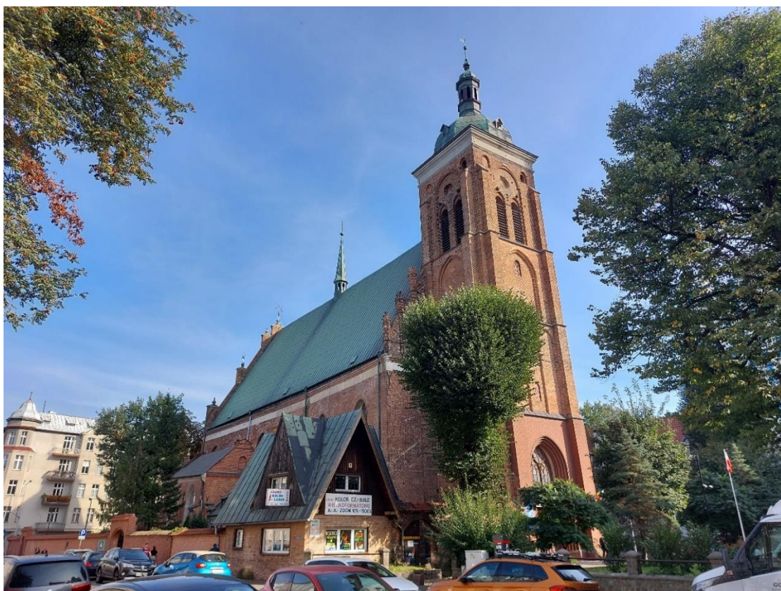
Ilustracja 39. Widok ogólny po zakończeniu prac
