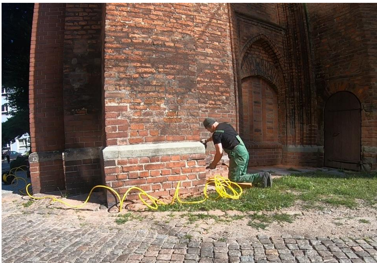
Ilustracja 29. Oczyszczanie odwiertów z materiałów luźnych
