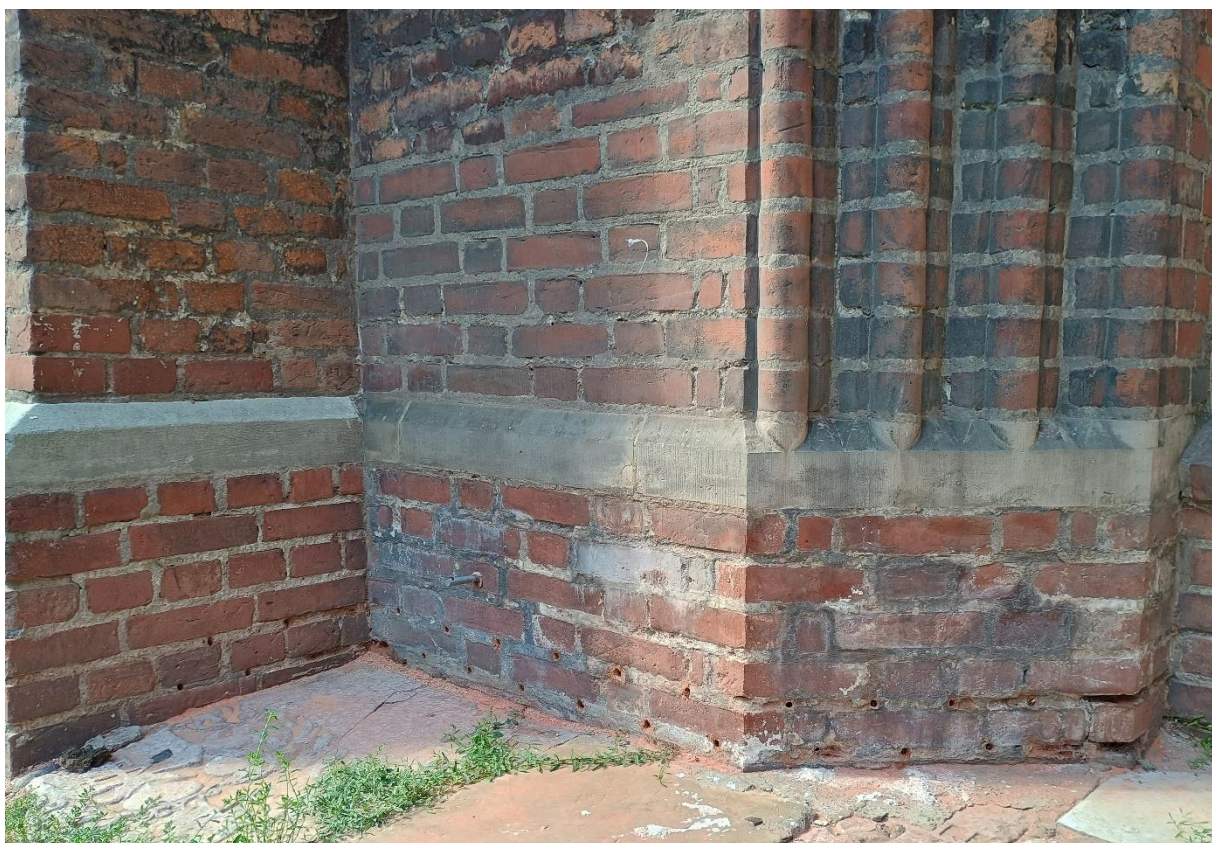
Ilustracja 31. Oczyszczzone otwory przygotowane do osadzenia iniektorów
