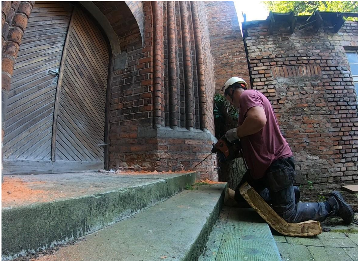
Ilustracja 26. Wykonywanie odwiertów pod iniektory
