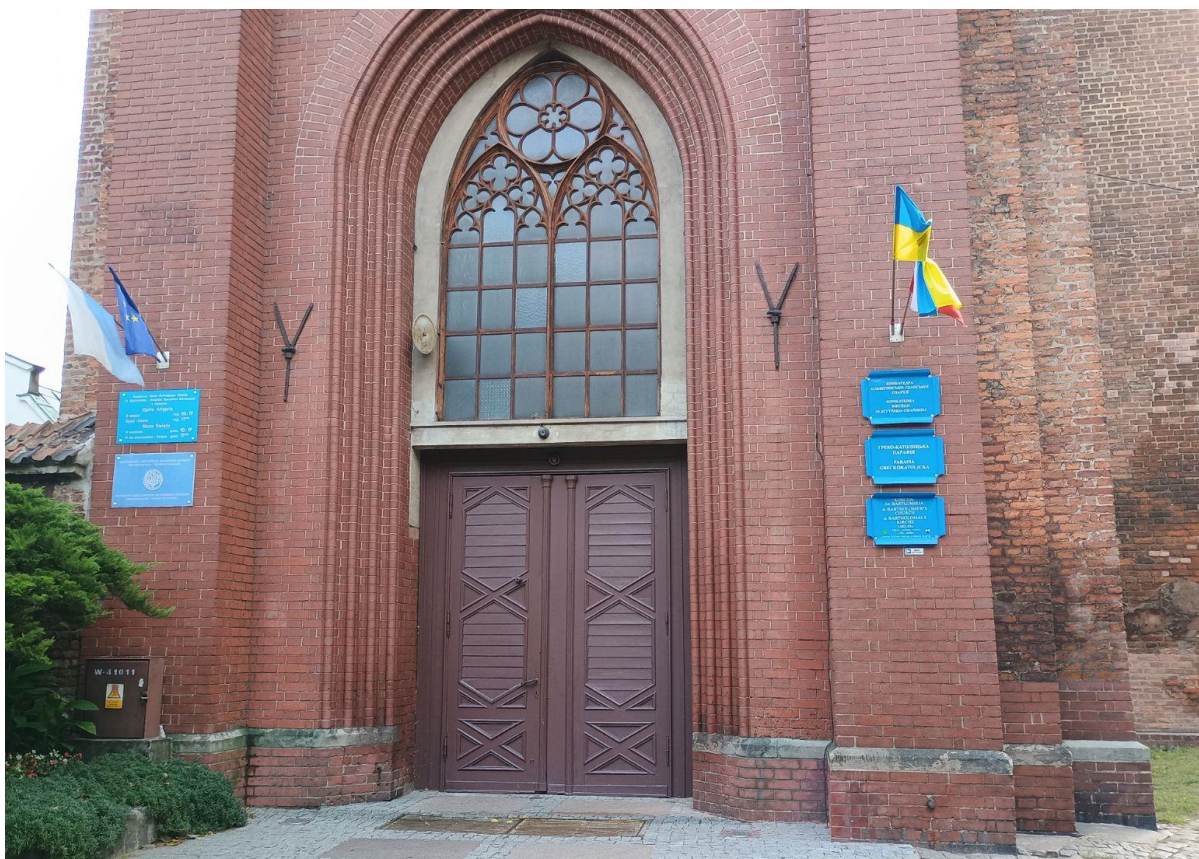
Ilustracja 41. Po zakończeniu prac
