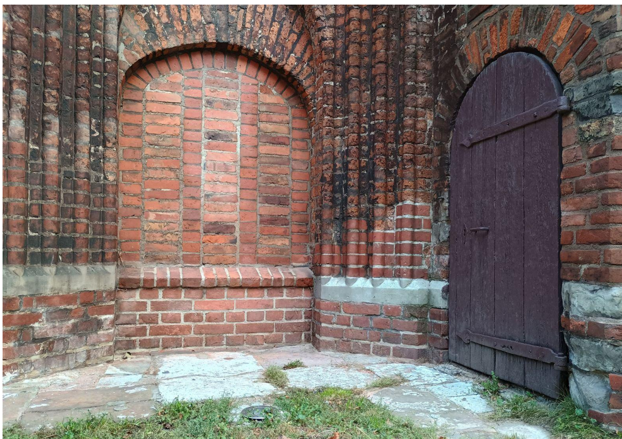
Ilustracja 47. Po zakończeniu prac
