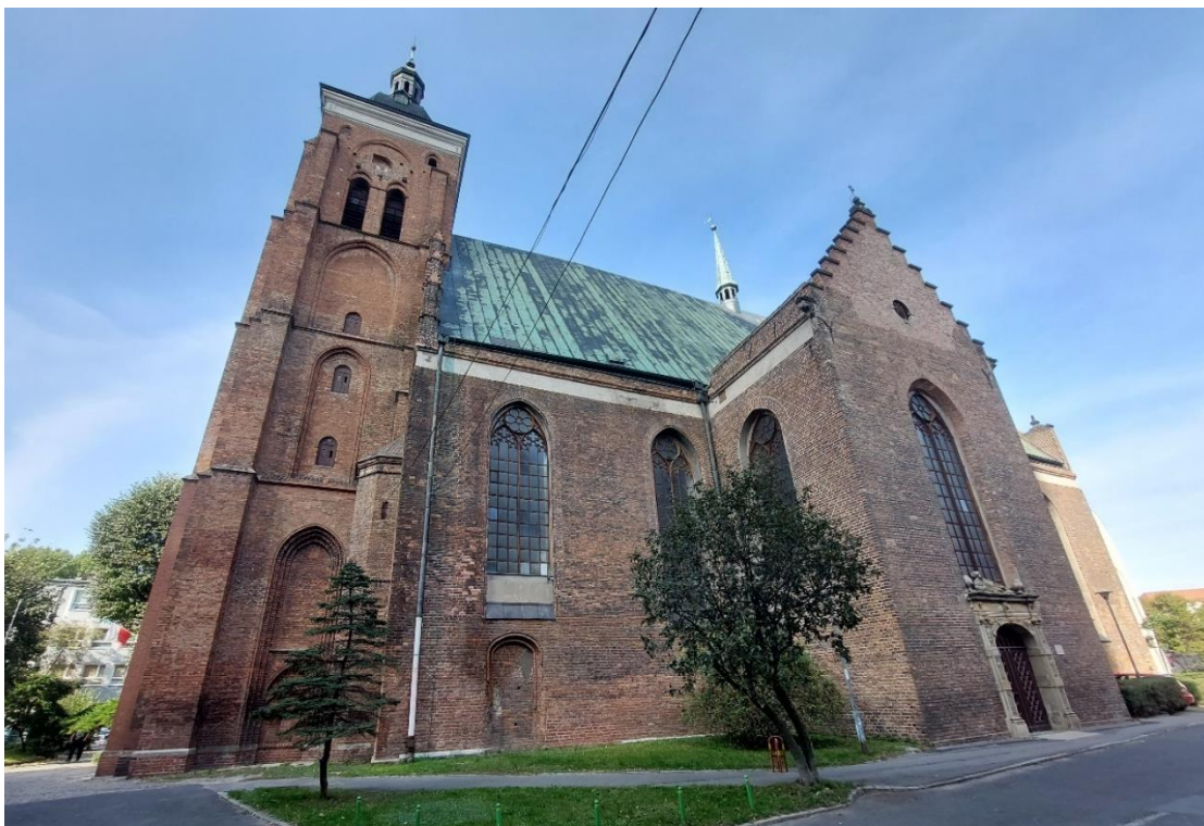
Ilustracja 40. Widok ogólny po zakończeniu prac
