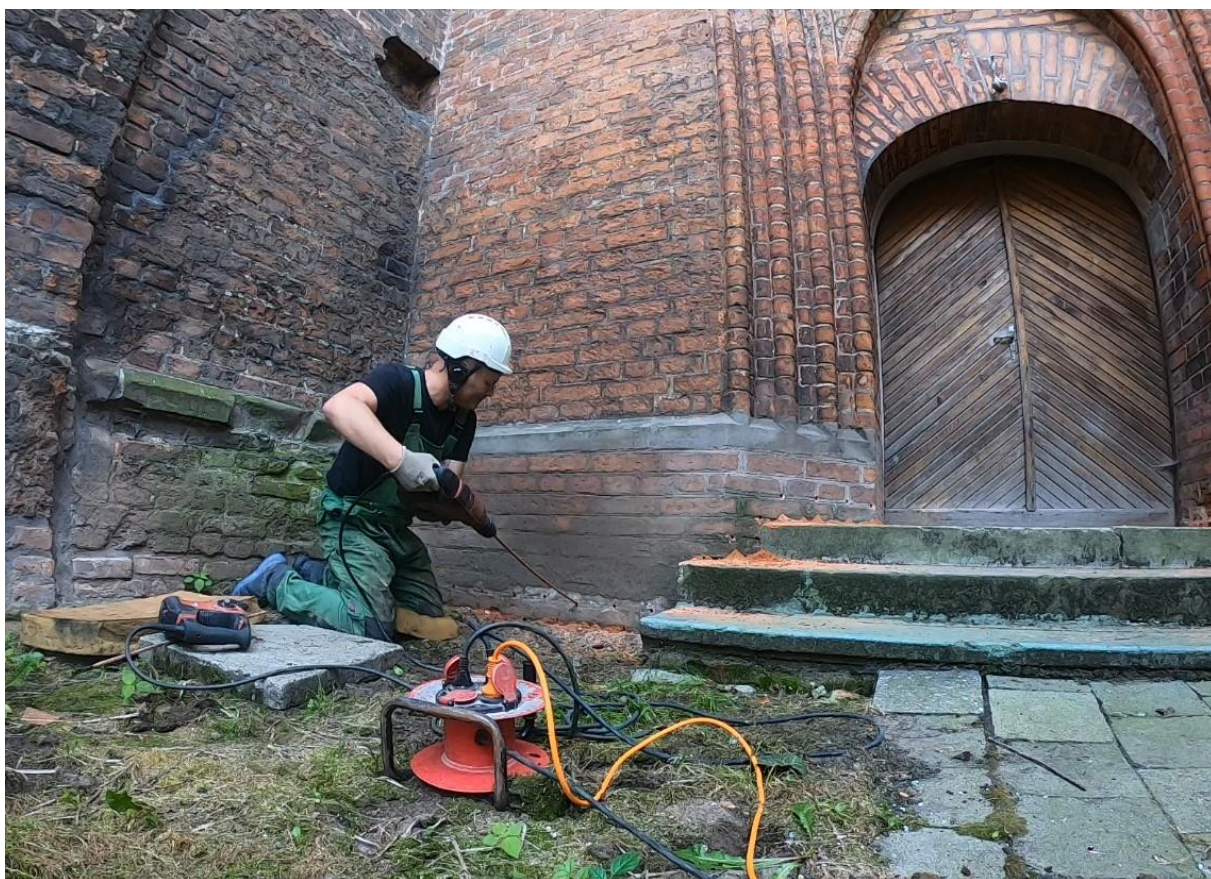
Ilustracja 27. Pogłębianie otworów przy użyciu wiertła 120 cm w najgrubszych partiach muru
