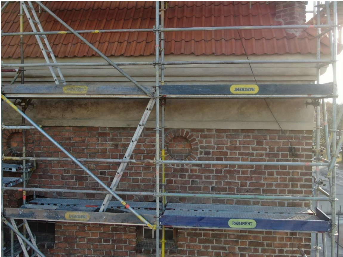
Ilustracja 58. Obiekt po zakończeniu prac
