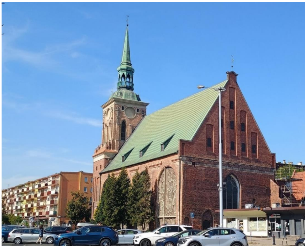
Ilustracje 52-53. Obiekt po zakończeniu prac
