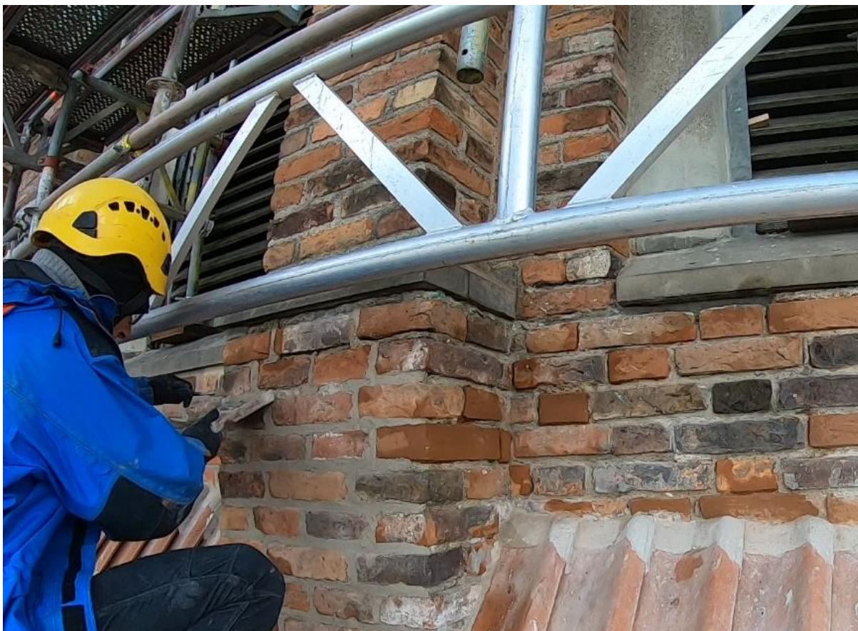
Ilustracja 42. Uzupełnianie ubytków zapraw
