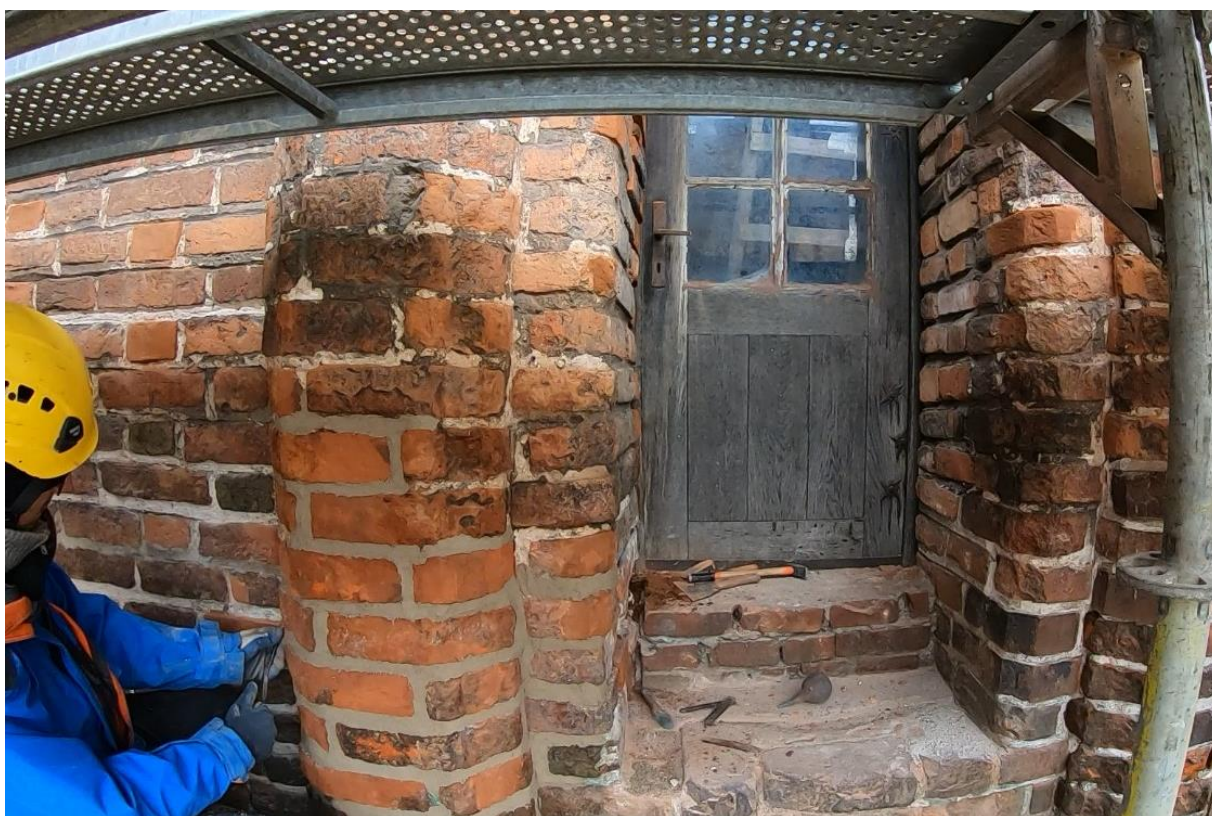
Ilustracja 45. Uzupełnianie ubytków zaprawy
