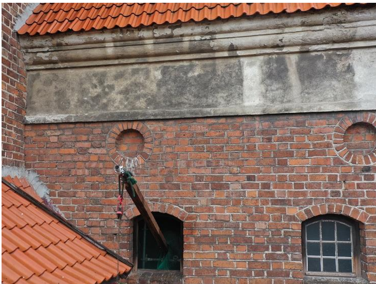
Ilustracja 15. Uszkodzony gzyms
