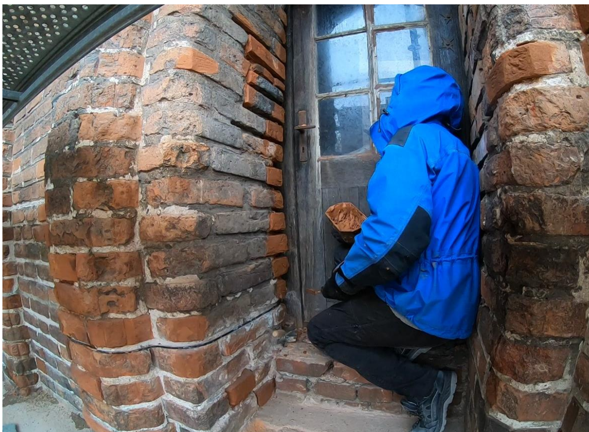
Ilustracja 44. Uzupełnianie ubytków cegieł
