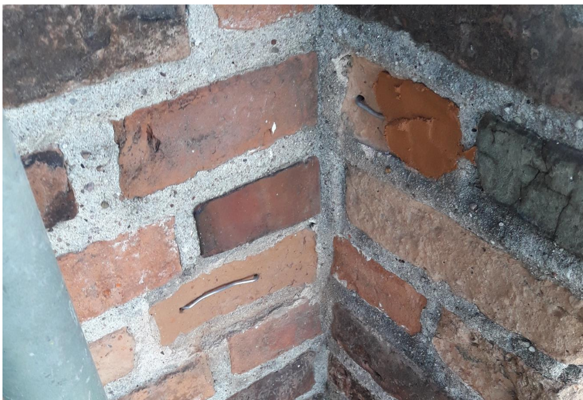
Ilustracja 37. Zbrojenia pod uzupełnienie ubytków cegieł
