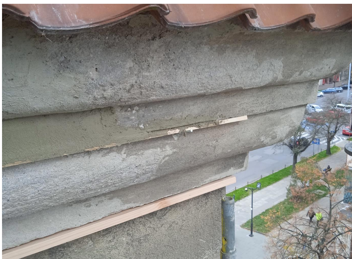
Ilustracje 48-49. Uzupełnianie ubytków gzymsu
