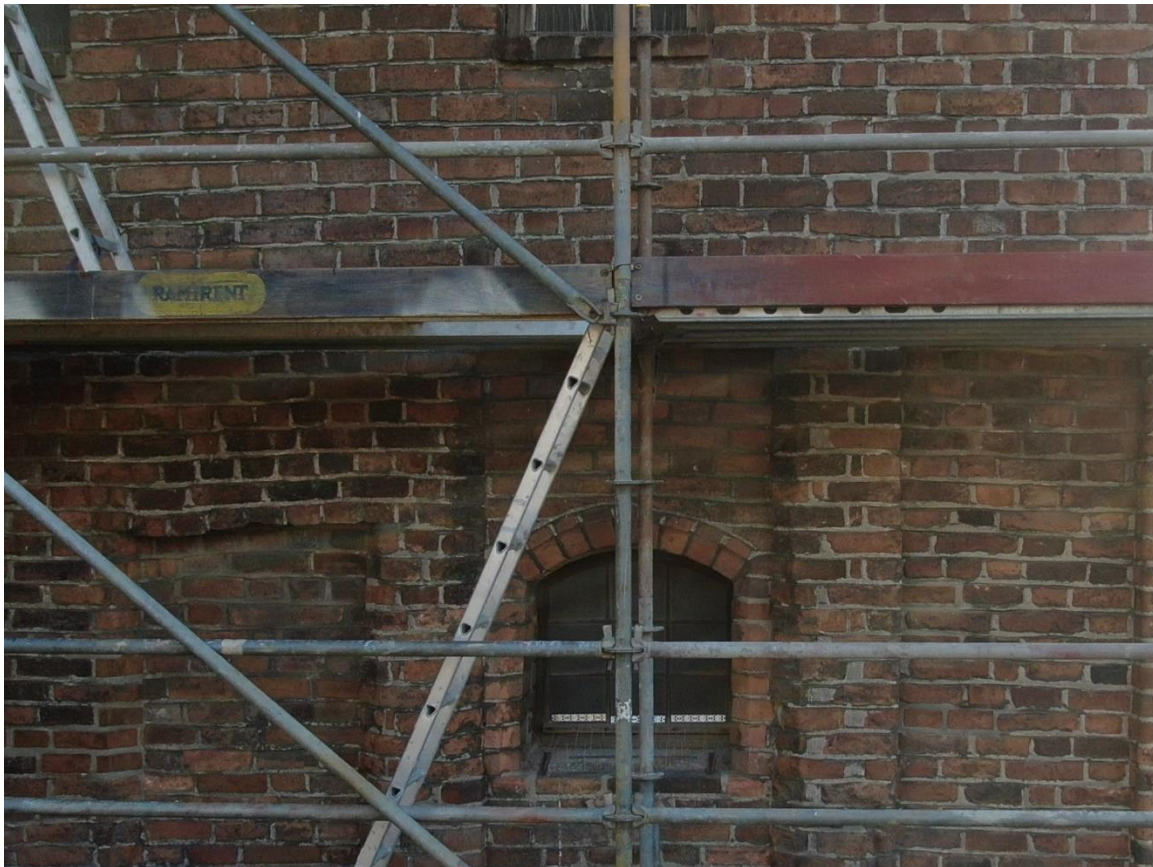
Ilustracja 56. Obiekt po zakończeniu prac
