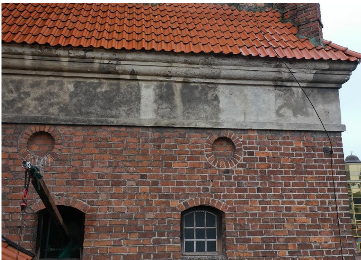
Ilustracja 16. Uszkodzony gzyms
