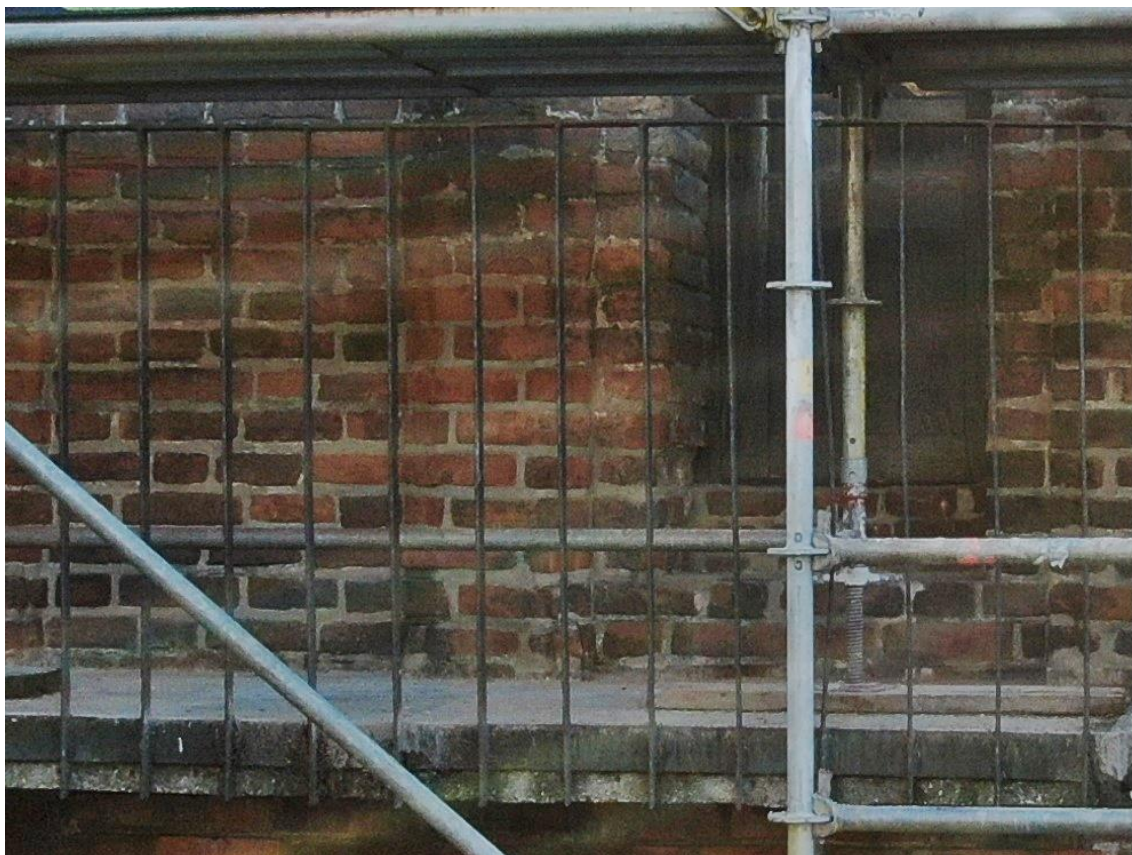
Ilustracja 63. Obiekt po zakończeniu prac
