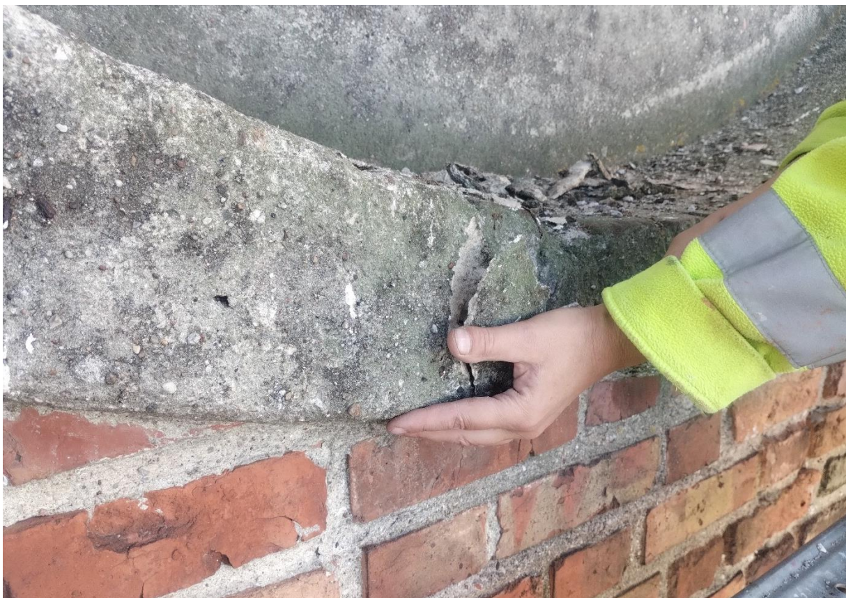
Ilustracja 24. Demontaż luźnych elementów
