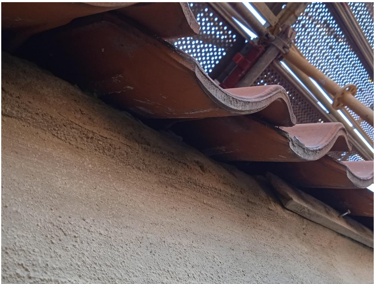
Ilustracje 46-47. Uzupełnianie ubytków gzymsu
