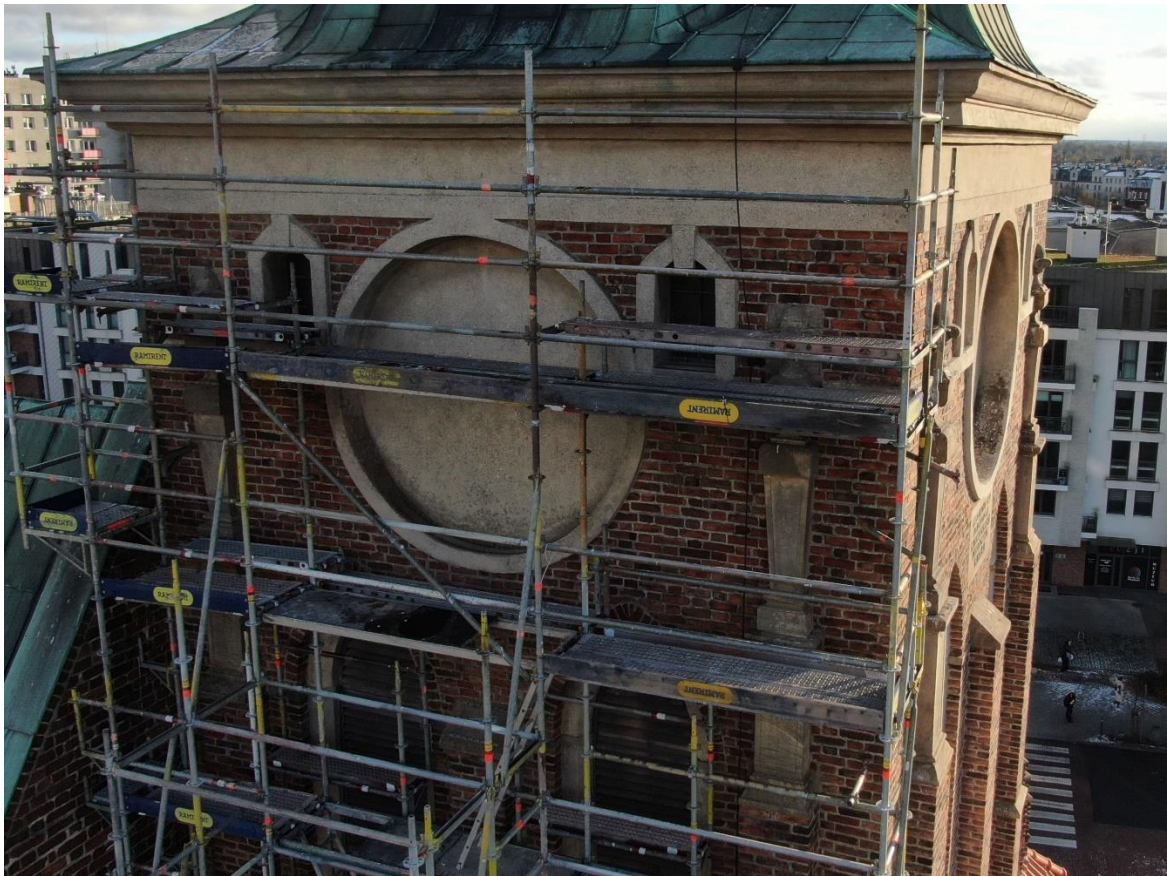
Ilustracja 60. Obiekt po zakończeniu prac
