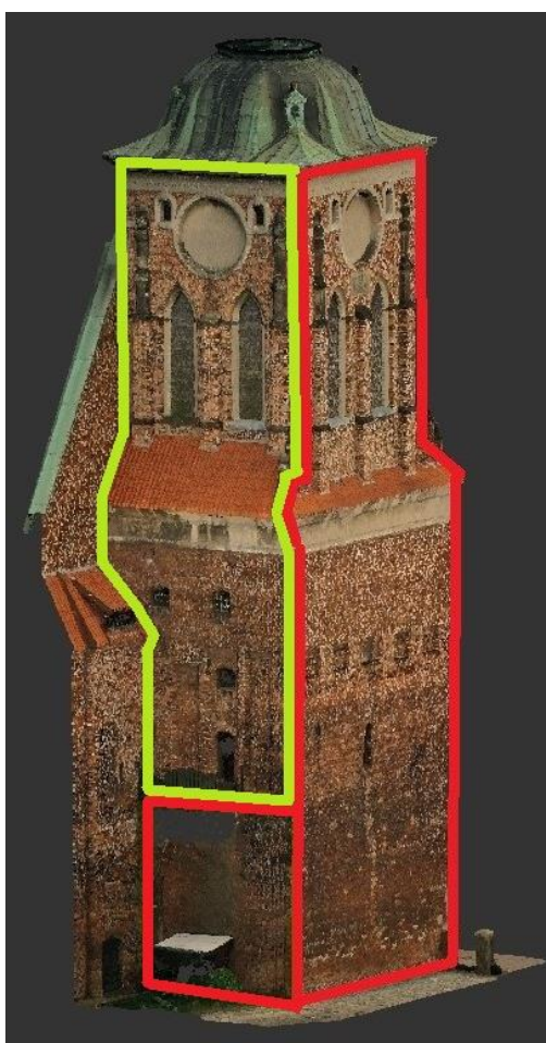
Kościół pw. Św. Barbary, widok na wieżę od północnego zachodu
