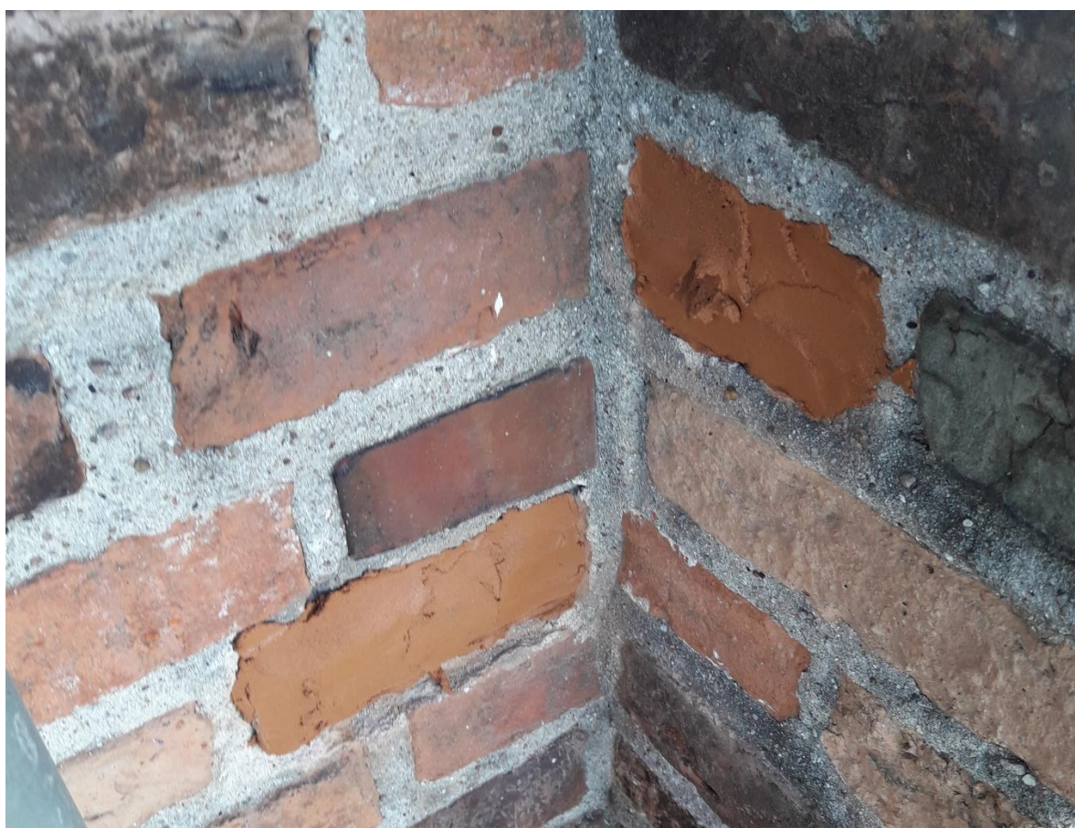
Ilustracja 38. Uzupełnianie ubytków cegieł
