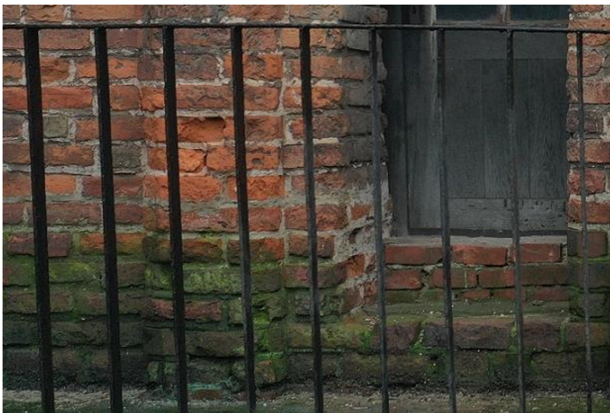
Ilustracja 21. Porosty oraz ubytki cegieł i zapraw
