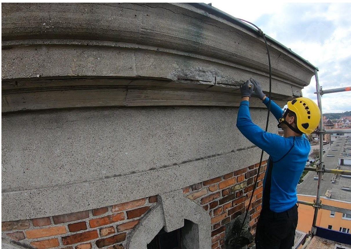
Ilustracja 27. Demontaż luźnych elementów
