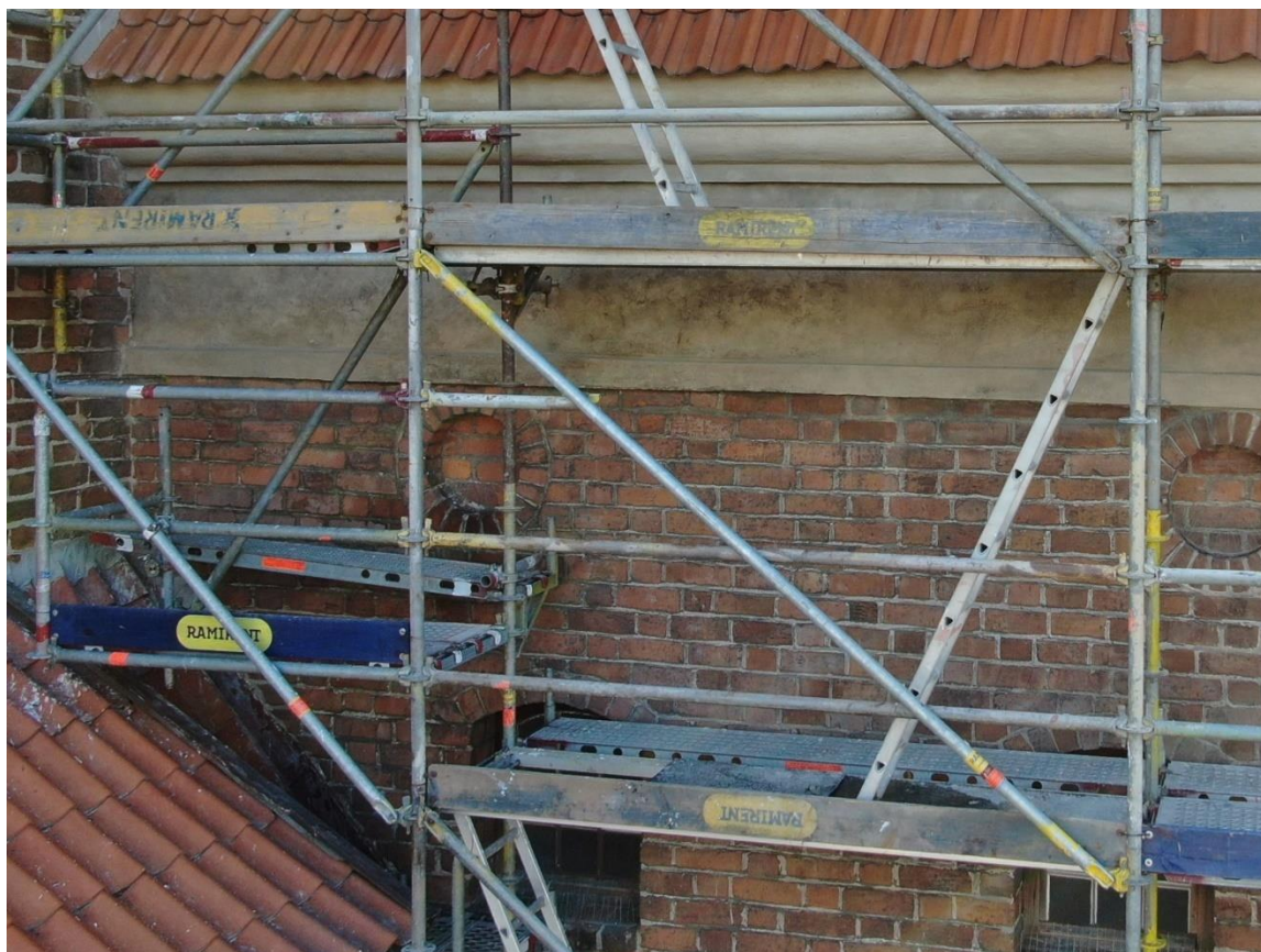
Ilustracja 57. Obiekt po zakończeniu prac
