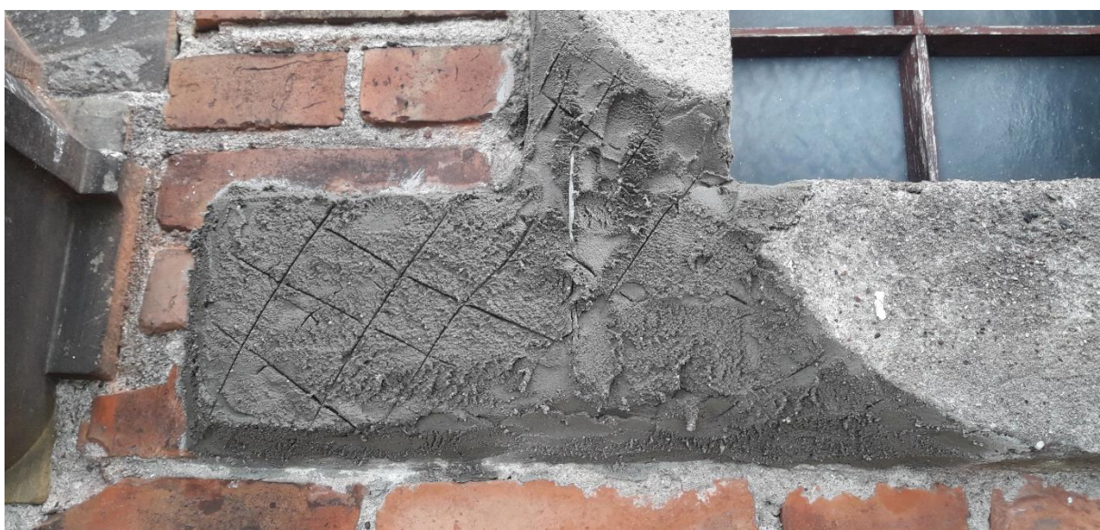
Ilustracje 34-36. Wykonanie zbrojeń i uzupełnianie ubytków tynkarskich
