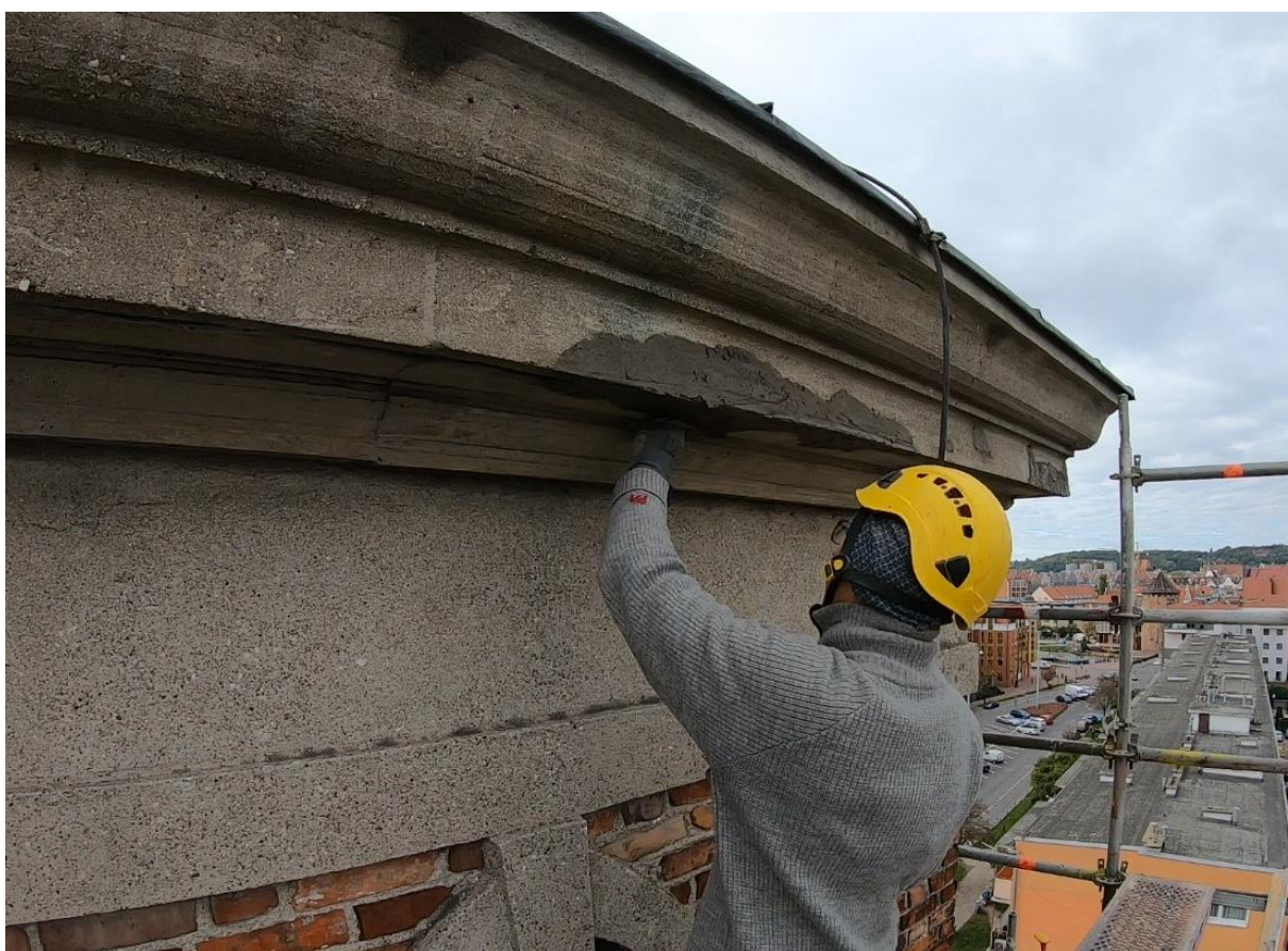
Ilustracja 31. Uzupełnianie ubytków
