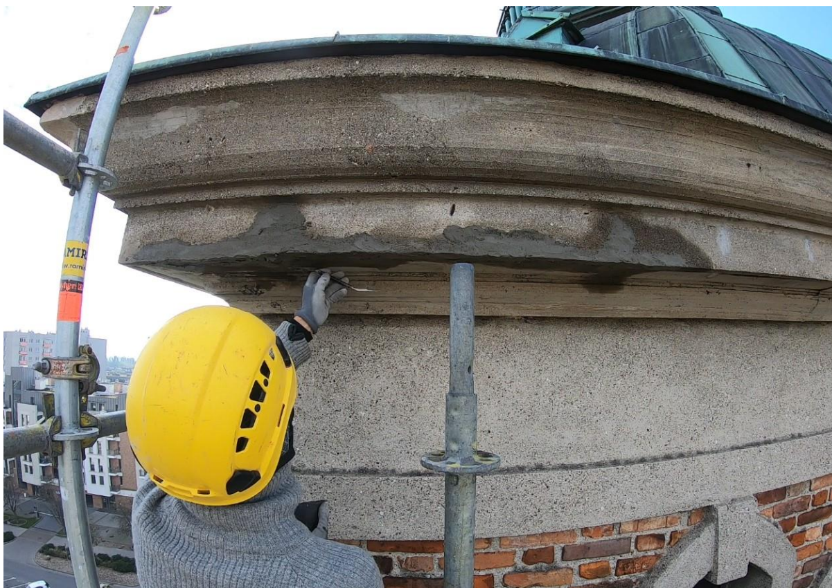
Ilustracja 30. Uzupełnianie ubytków
