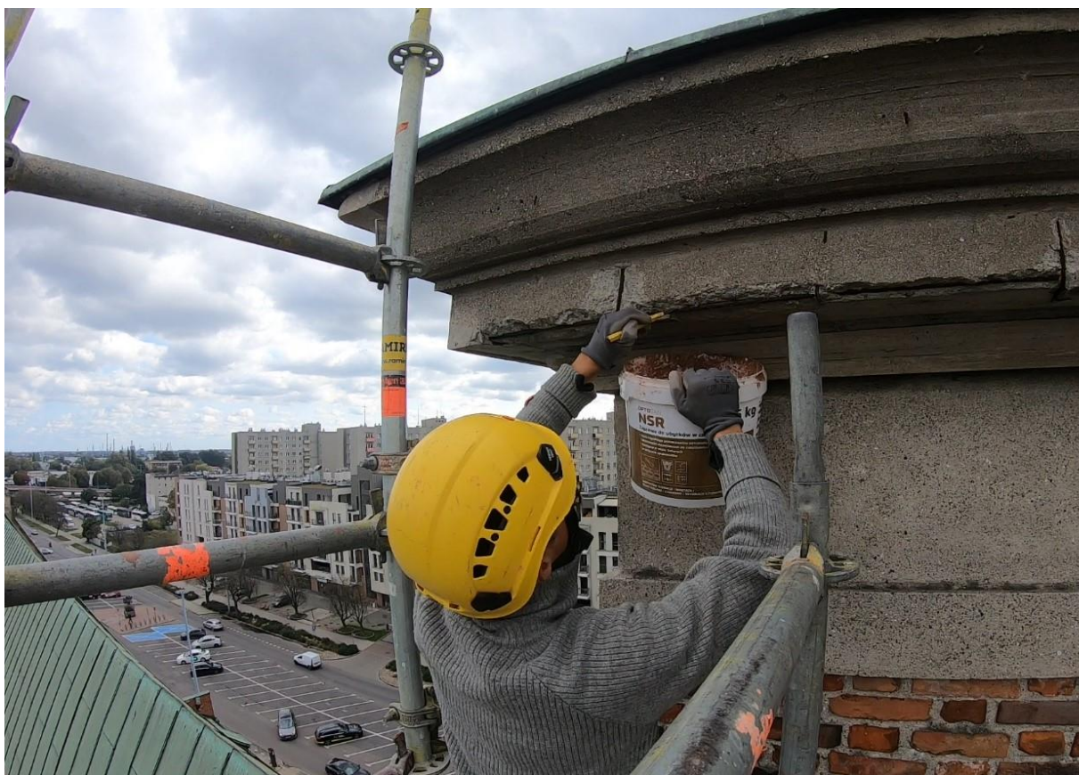
Ilustracja 26. Demontaż luźnych elementów
