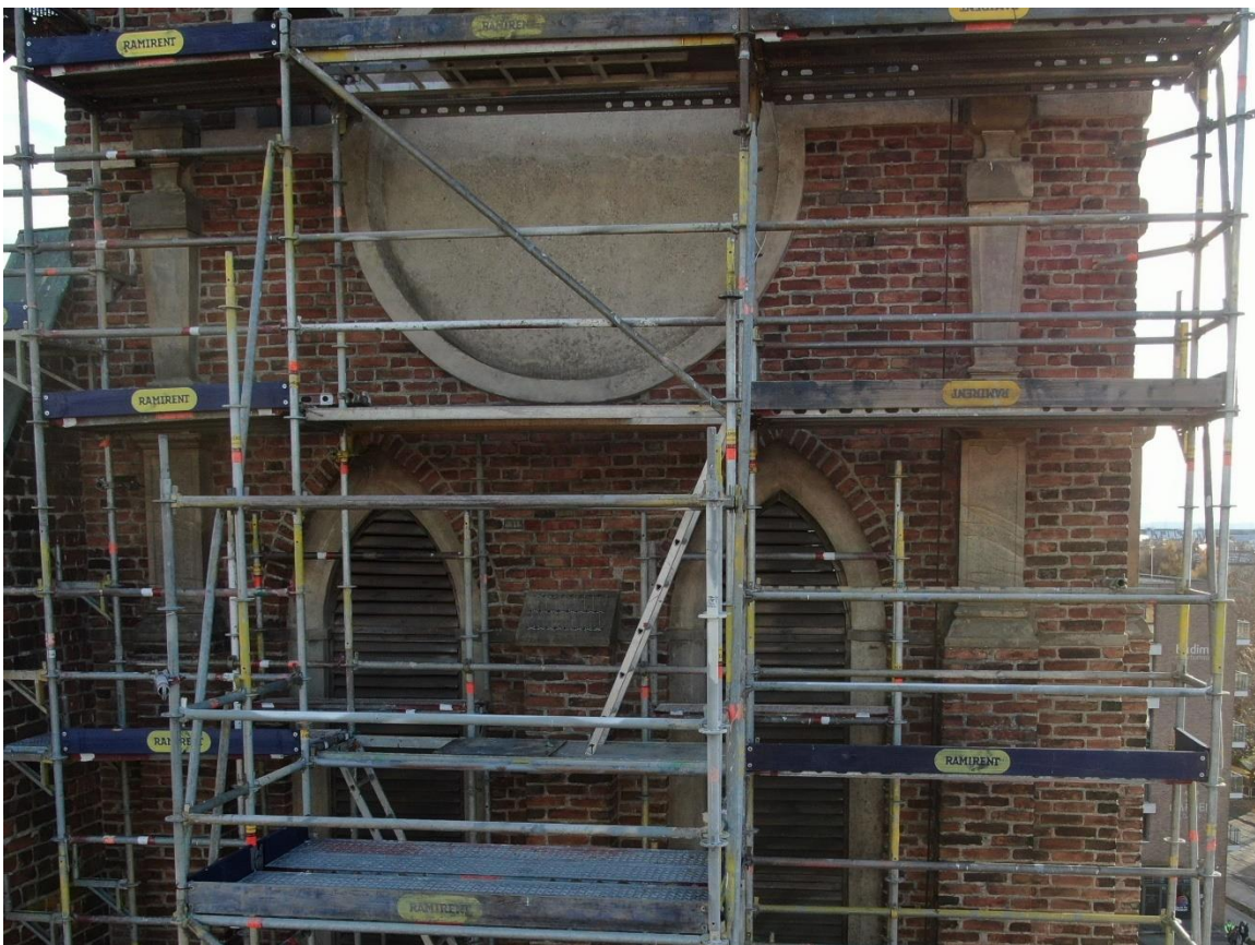
Ilustracja 59. Obiekt po zakończeniu prac
