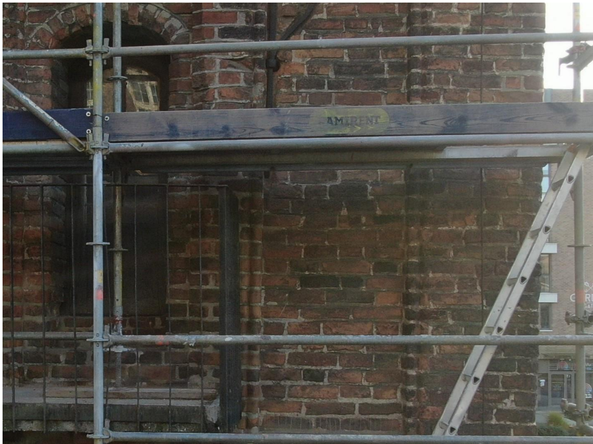
Ilustracja 61. Obiekt po zakończeniu prac
