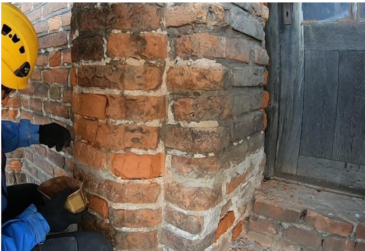
Ilustracja 43. Uzupełnianie ubytków cegieł
