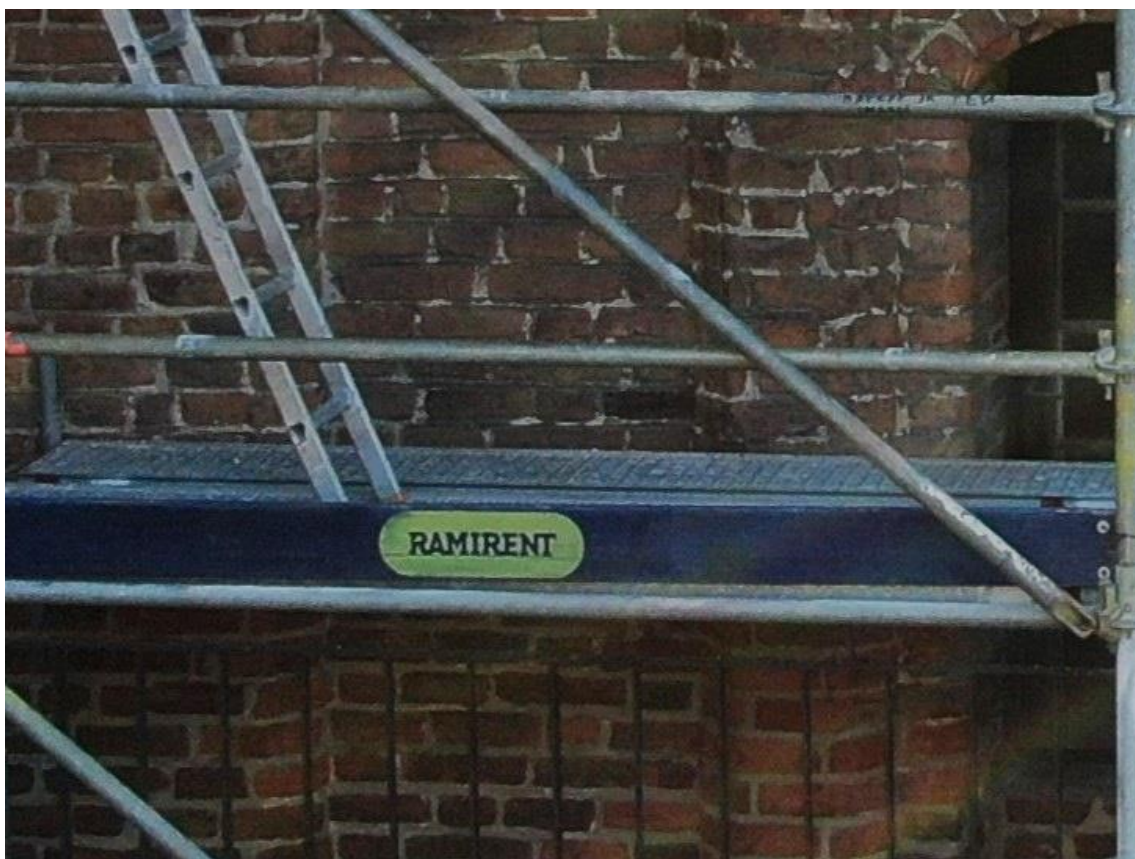
Ilustracja 62. Obiekt po zakończeniu prac
