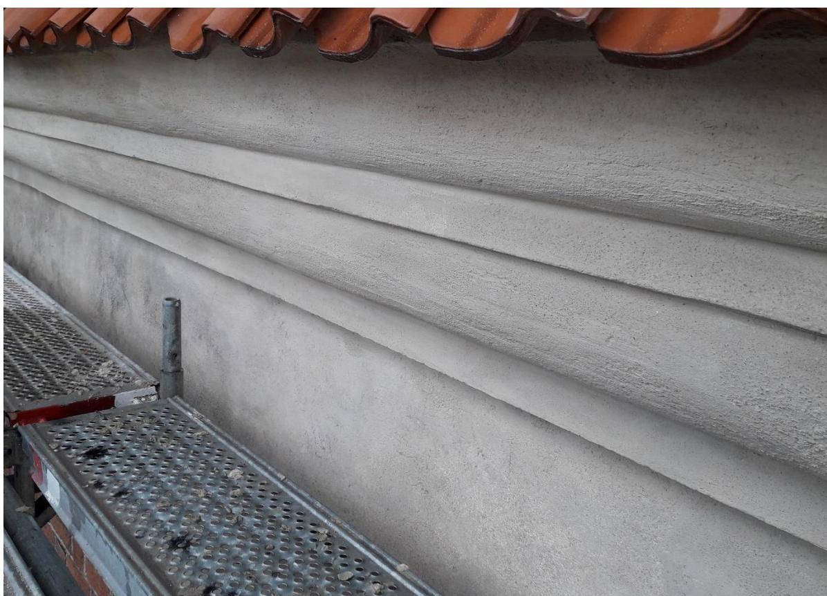
Ilustracje 50-51. Uzupełnianie ubytków gzymsu
