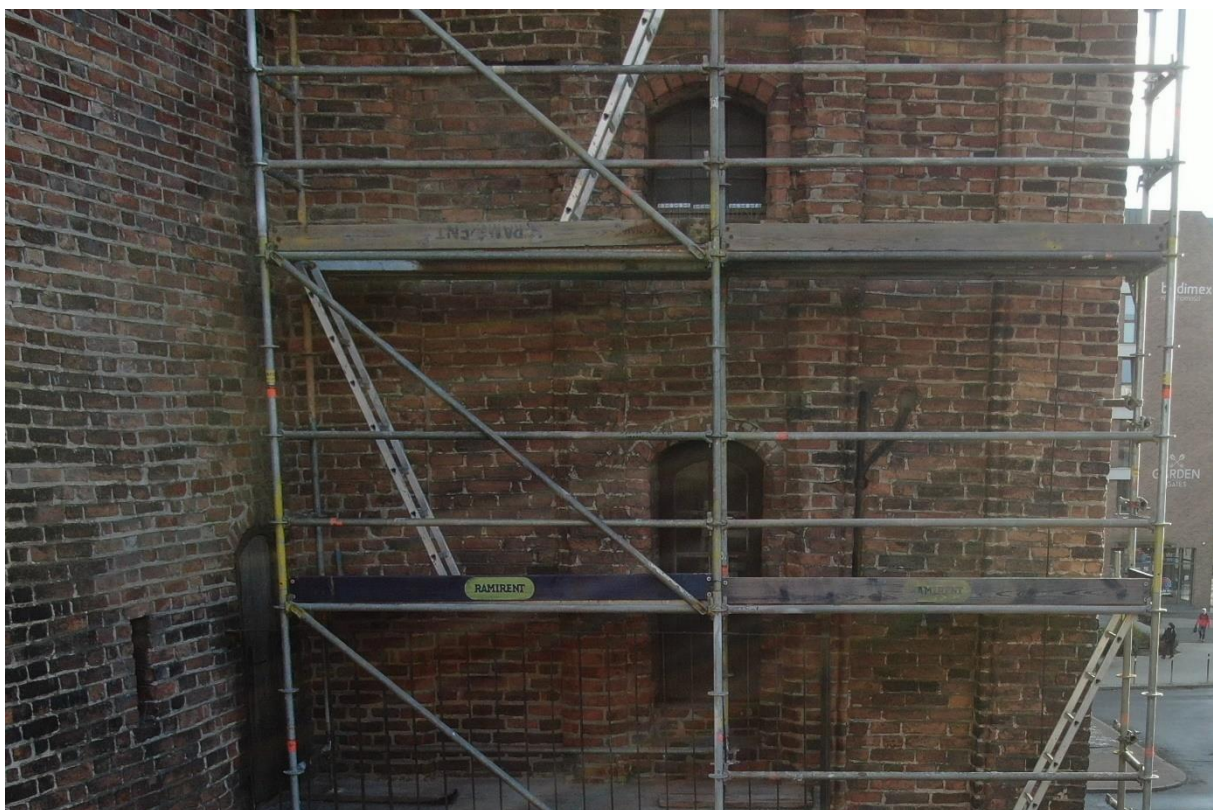
Ilustracja 54. Obiekt po zakończeniu prac
