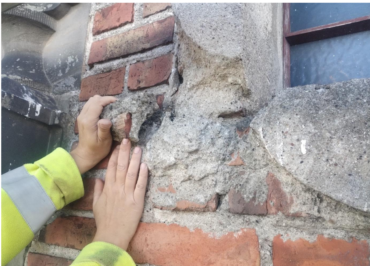
Ilustracja 25. Demontaż luźnych elementów
