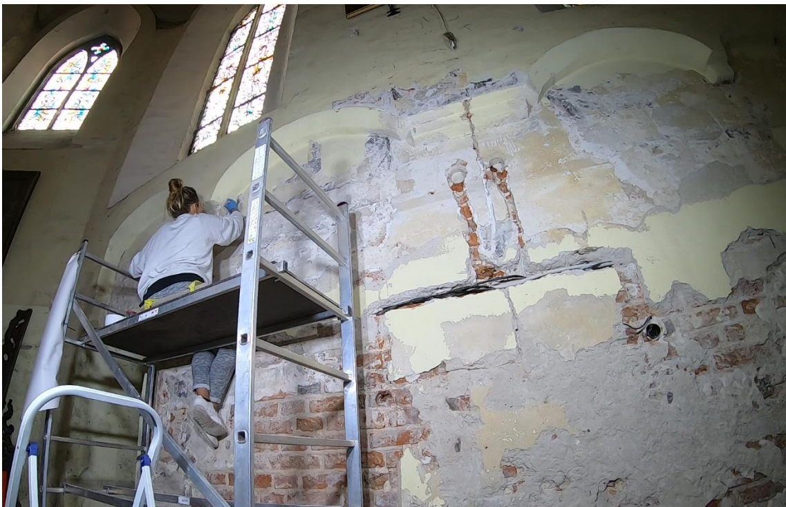
Ilustracja 37. Usuwanie wtórnych warstw
