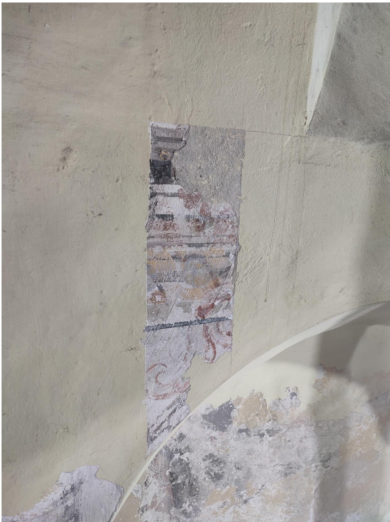
Ilustracja 66. Fragment malowidła po podklejeniu krawędzi i uzupełnieniu pobrały
