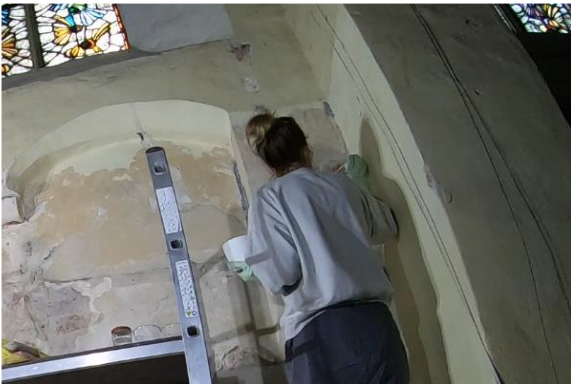
Ilustracja 45. Uzupełnianie ubytków tynku
