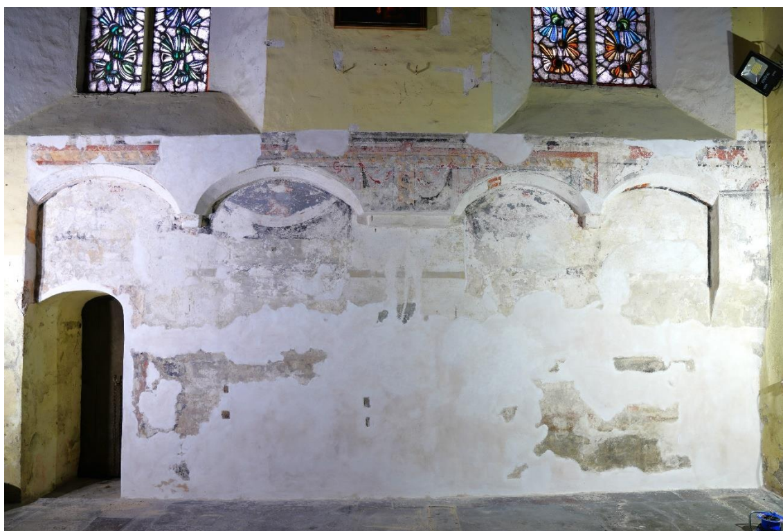
Ilustracja 73. Ściana południowa prezbiterium po zakończeniu prac
