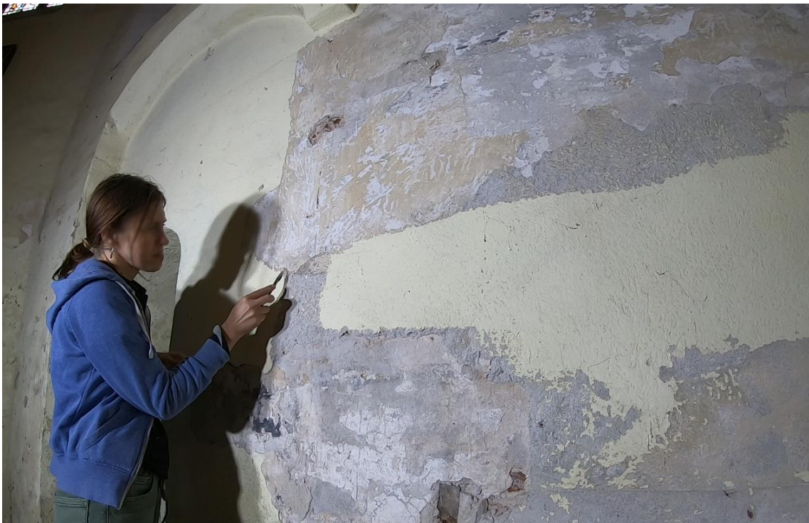
Ilustracja 33. Mechaniczne usuwanie wtórnych warstw za pomocą skalpela
