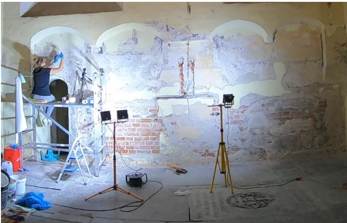
Ilustracja 42. Wzmacnianie strukturalne zaprawą do iniekcji aplikowaną przez strzykawkę
