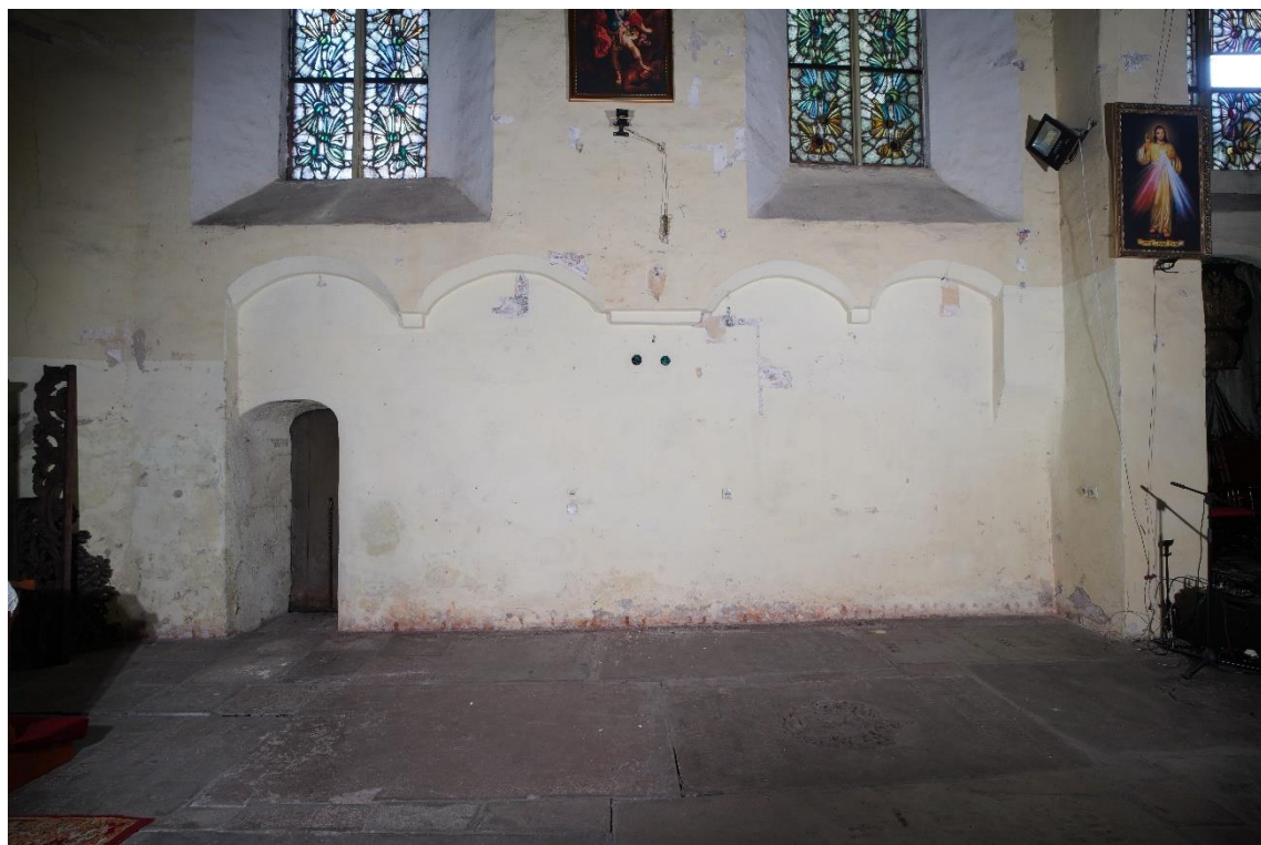
Ilustracja 30. Ściana południowa prezbiterium po zdemontowaniu dekoracji i elementów instalacji elektrycznej
