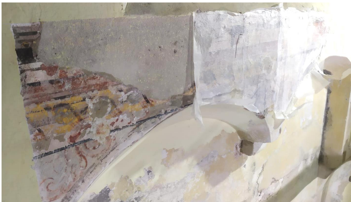
Ilustracja 50. Trzecia i czwarta nisza od wschodu. Fragment malowidła w trakcie konsolidacji
