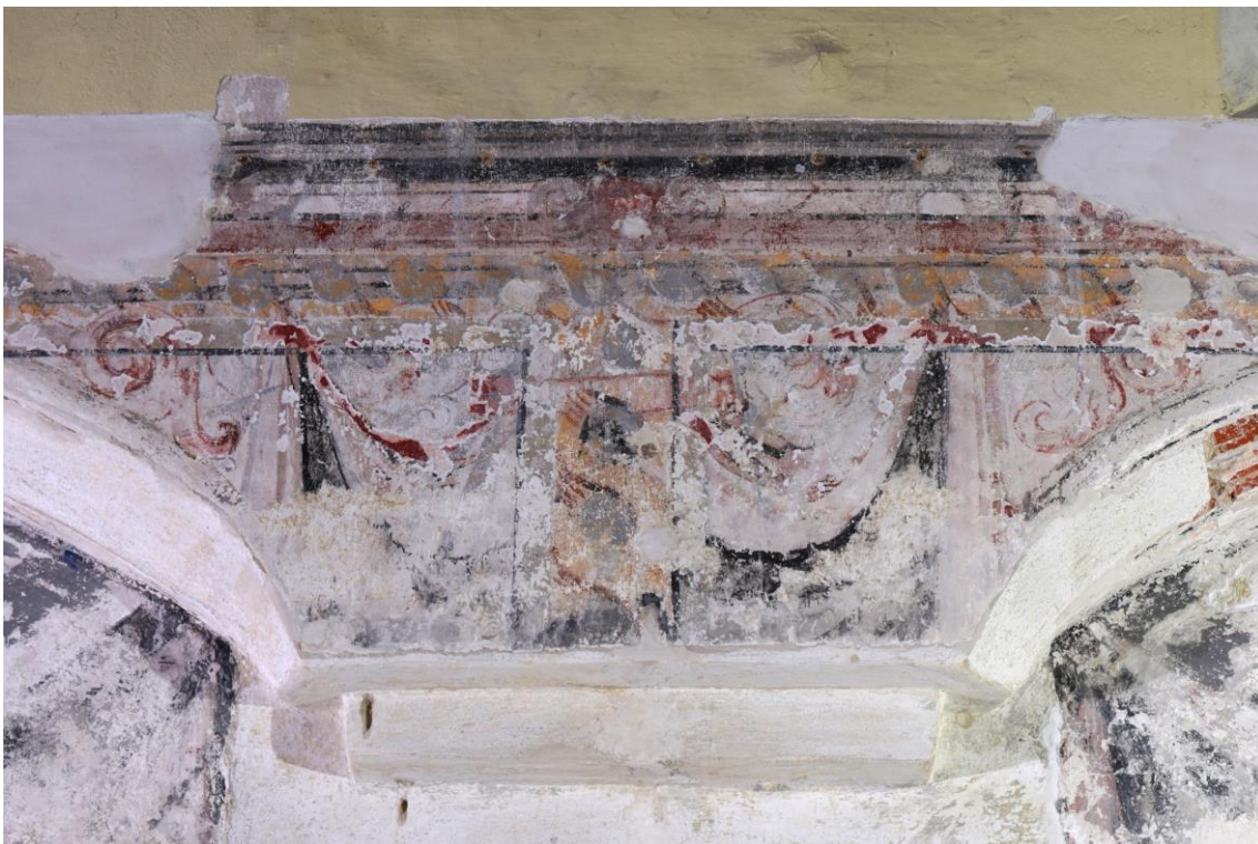
Ilustracja 76. Fragment malowidła pomiędzy drugą i trzecią niszą po zakończeniu prac
