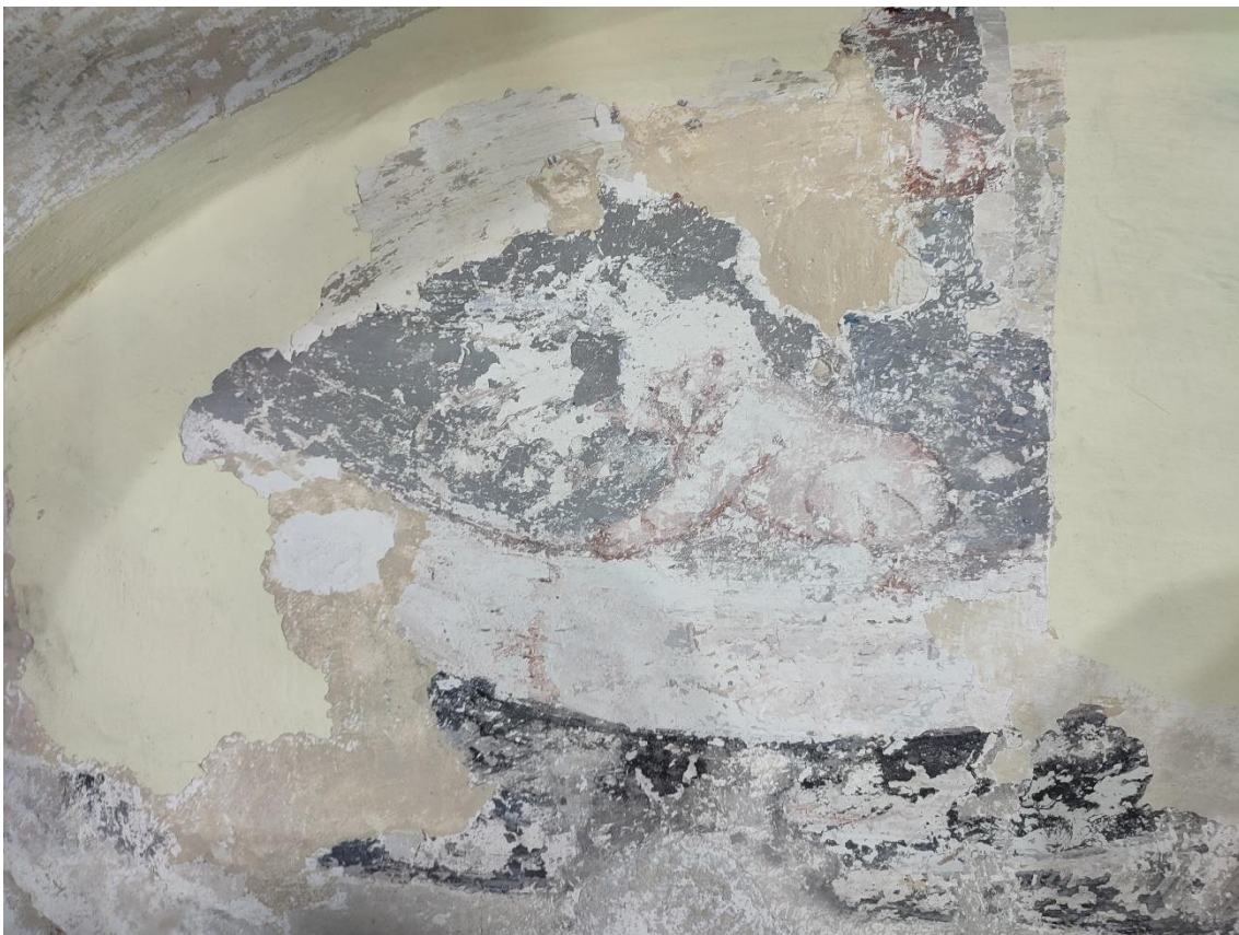
Ilustracja 61. Dalsze usuwanie wtórnych warstw i podklejanie krawędzi
