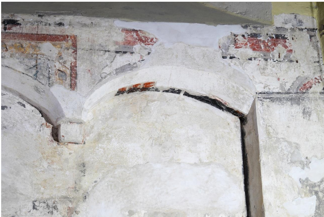
Ilustracja 78. Górna część czwartej niszy od wschodu wraz z fragmentem malowidła nad jej krawędzią i przy łuku tęczowym po zakończeniu prac
