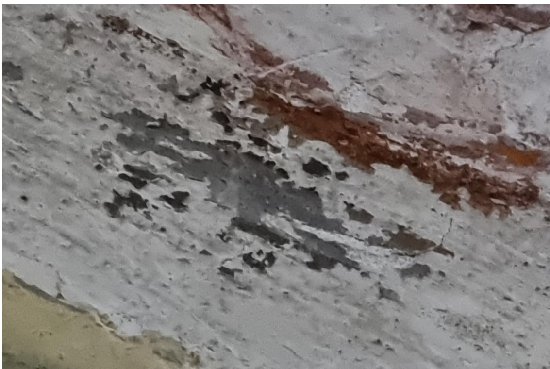
Ilustracja 23. Zbliżenie na fragment odkrywki. Widoczna pudrująca się warstwa malarska
