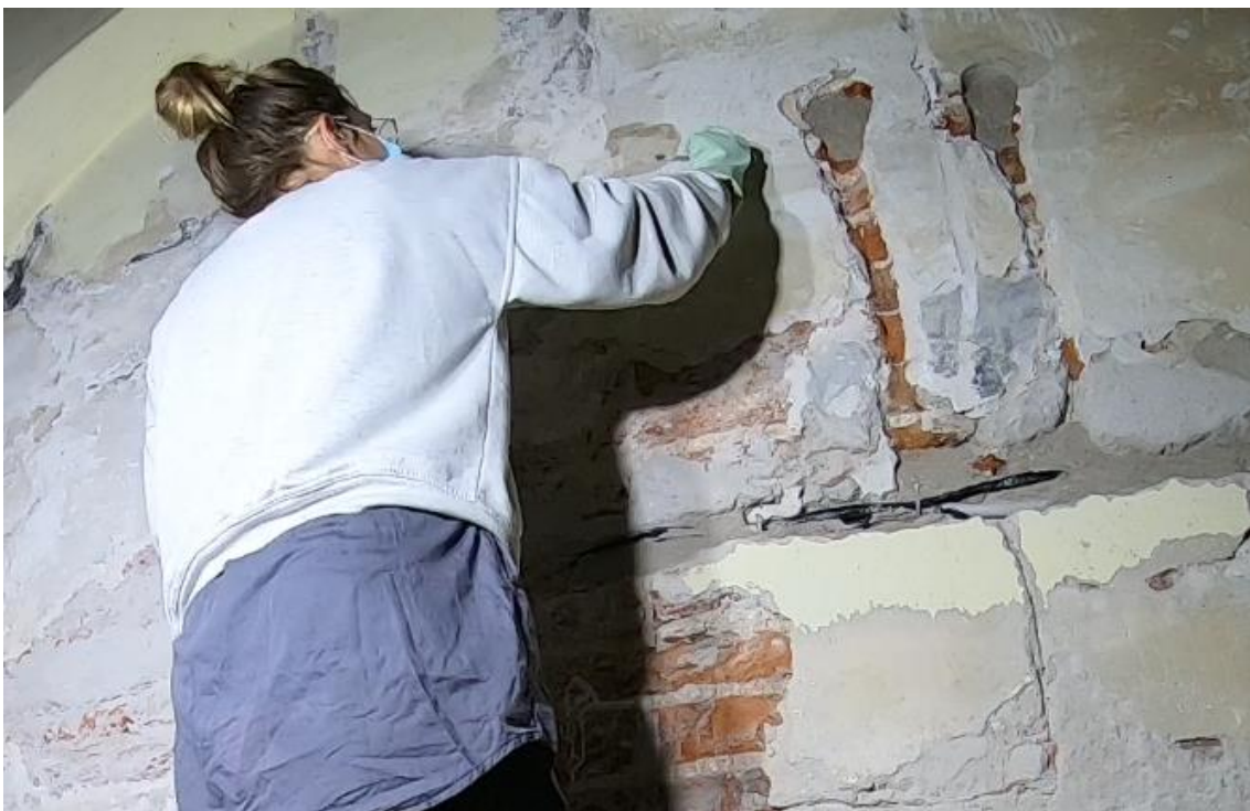
Ilustracja 43. Zwilżanie tynku przed uzupełnieniem ubytku
