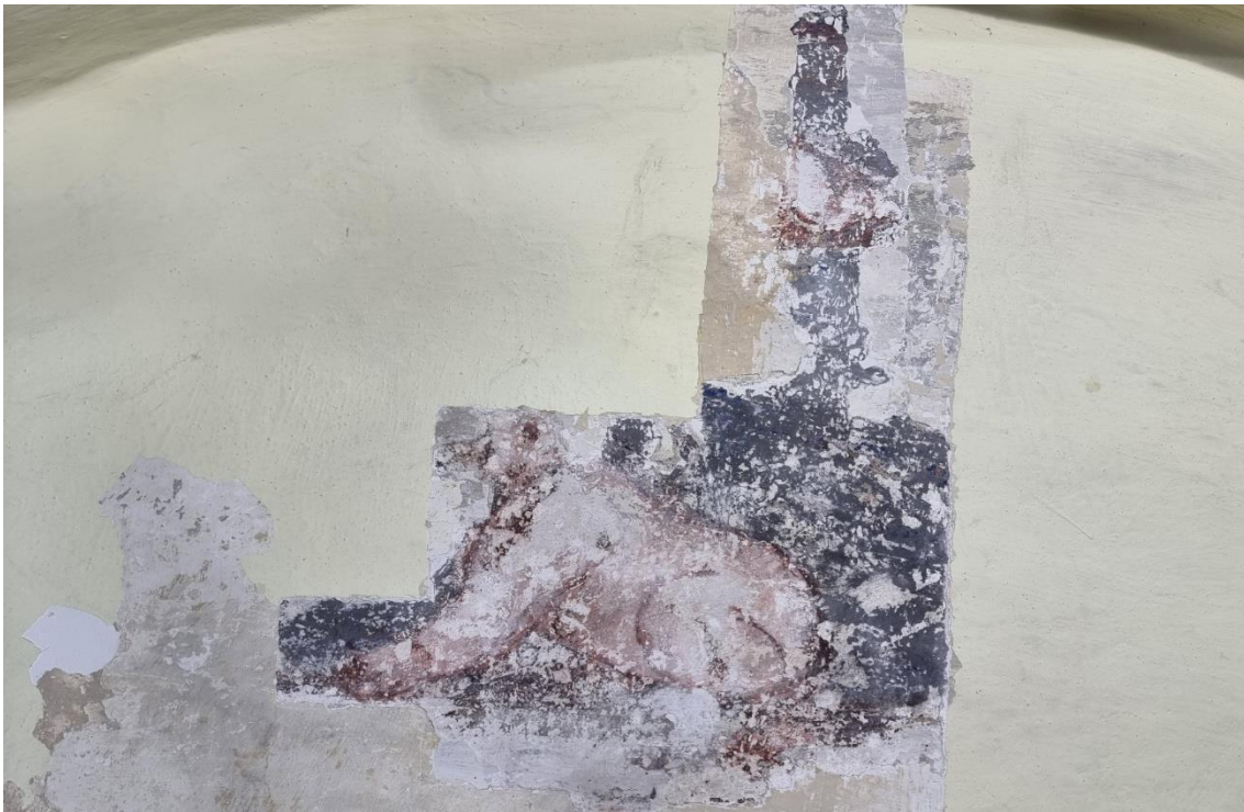
Ilustracja 58. Fragment malowidła z barankiem w trakcie oczyszczania z wtórnych warstw
