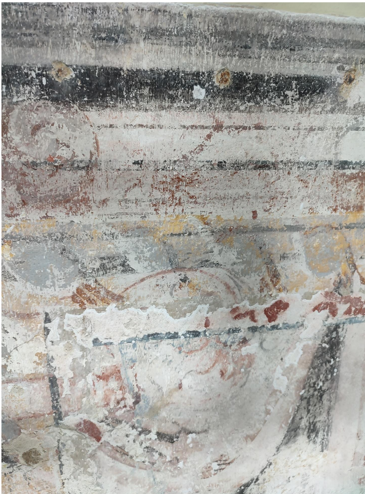
Ilustracja 71. Fragment malowidła nad pierwszą niszą od wschodu po zabezpieczeniu opaskami z zaprawy wokół odsłoniętych warstw malarskich
