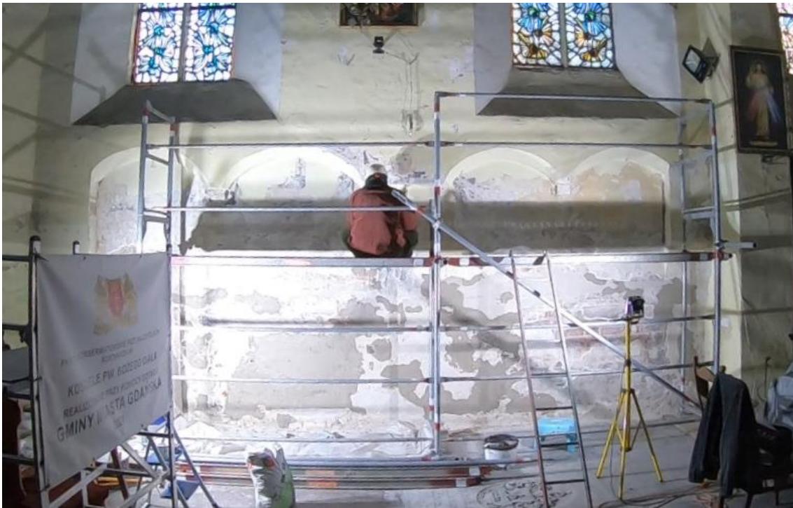
Ilustracja 46. Uzupełnianie ubytków tynku
