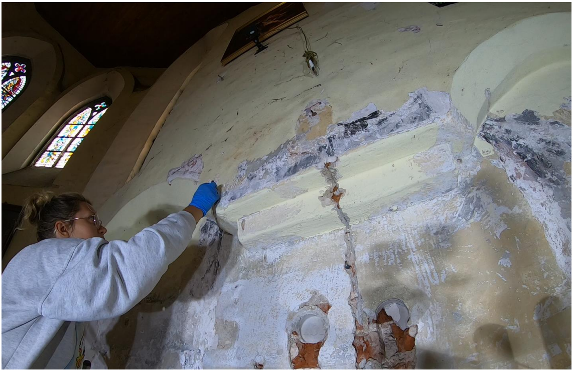
Ilustracja 38. Podklejanie i zabezpieczanie krawędzi tynku
