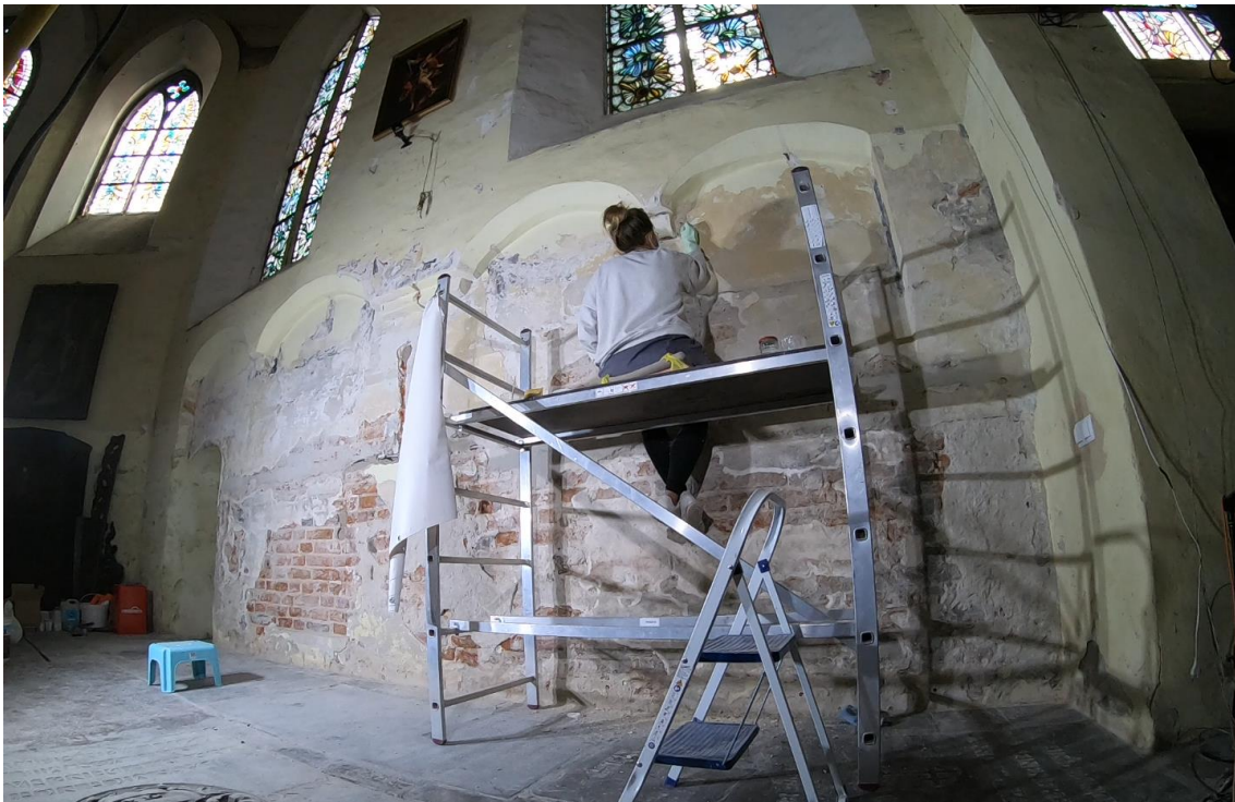
Ilustracja 44. Uzupełnianie ubytków tynku
