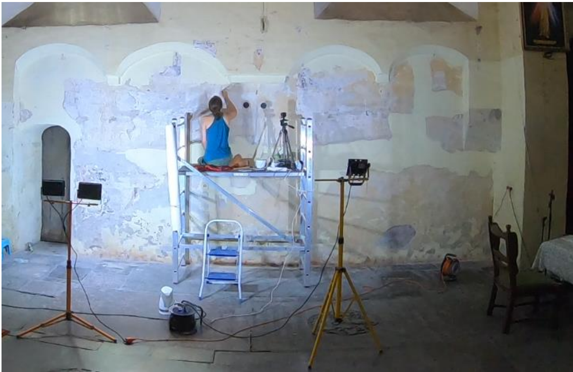
Ilustracja 34. Usuwanie wtórnych warstw
