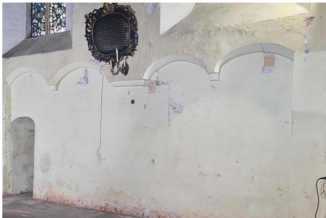
Ilustracja 31. Ściana południowa przed pracami
