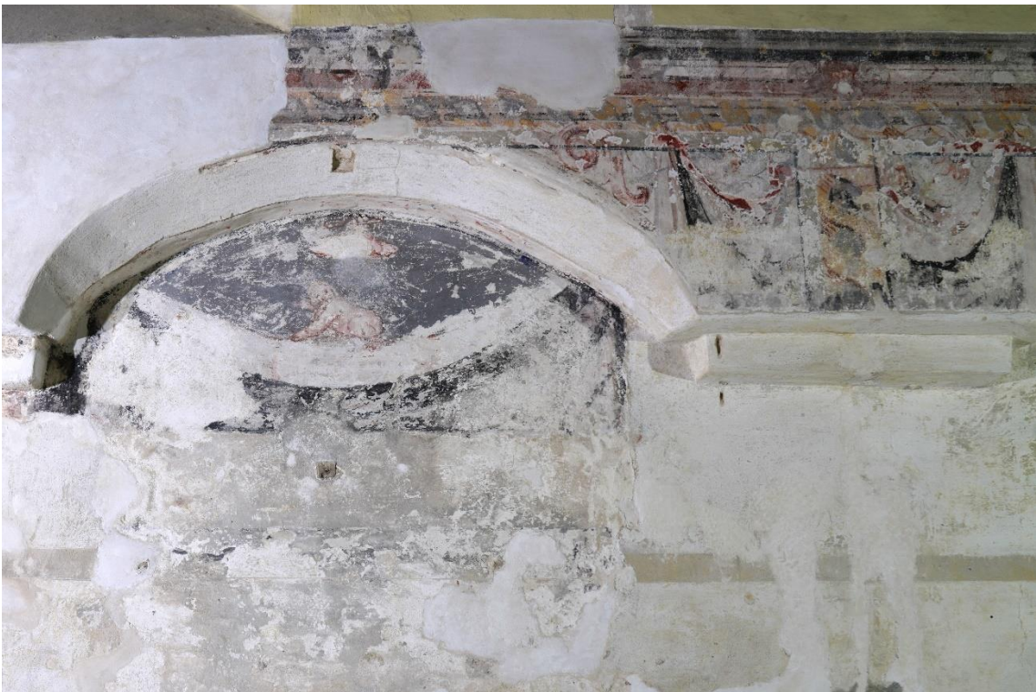
Ilustracja 75. Górna część drugiej niszy od wschodu wraz z fragmentem malowidła nad jej krawędzią po zakończeniu prac
