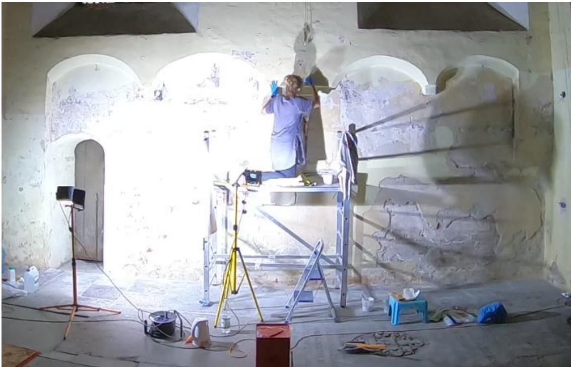
Ilustracja 40. Podklejanie i zabezpieczanie krawędzi tynku
