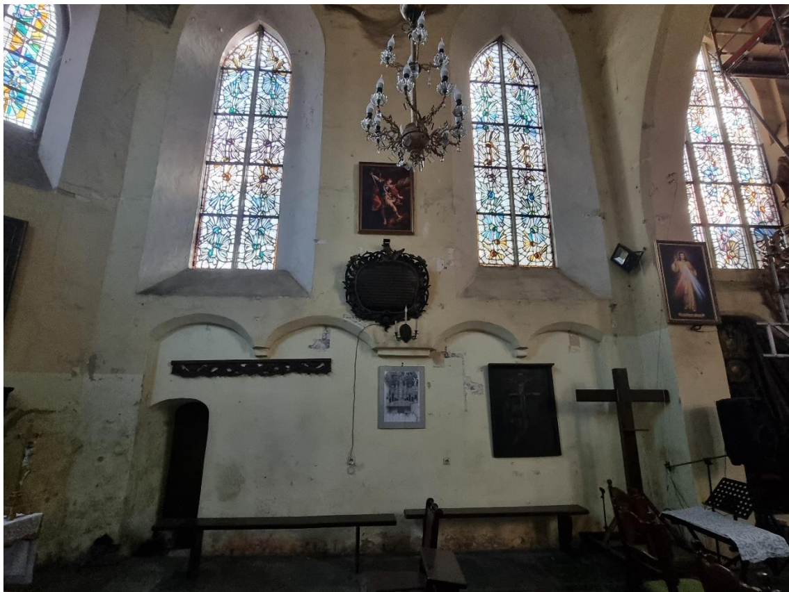
Ilustracja 17. Gotyckie prezbiterium z fragmentami odkrywek na ścianie południowej
