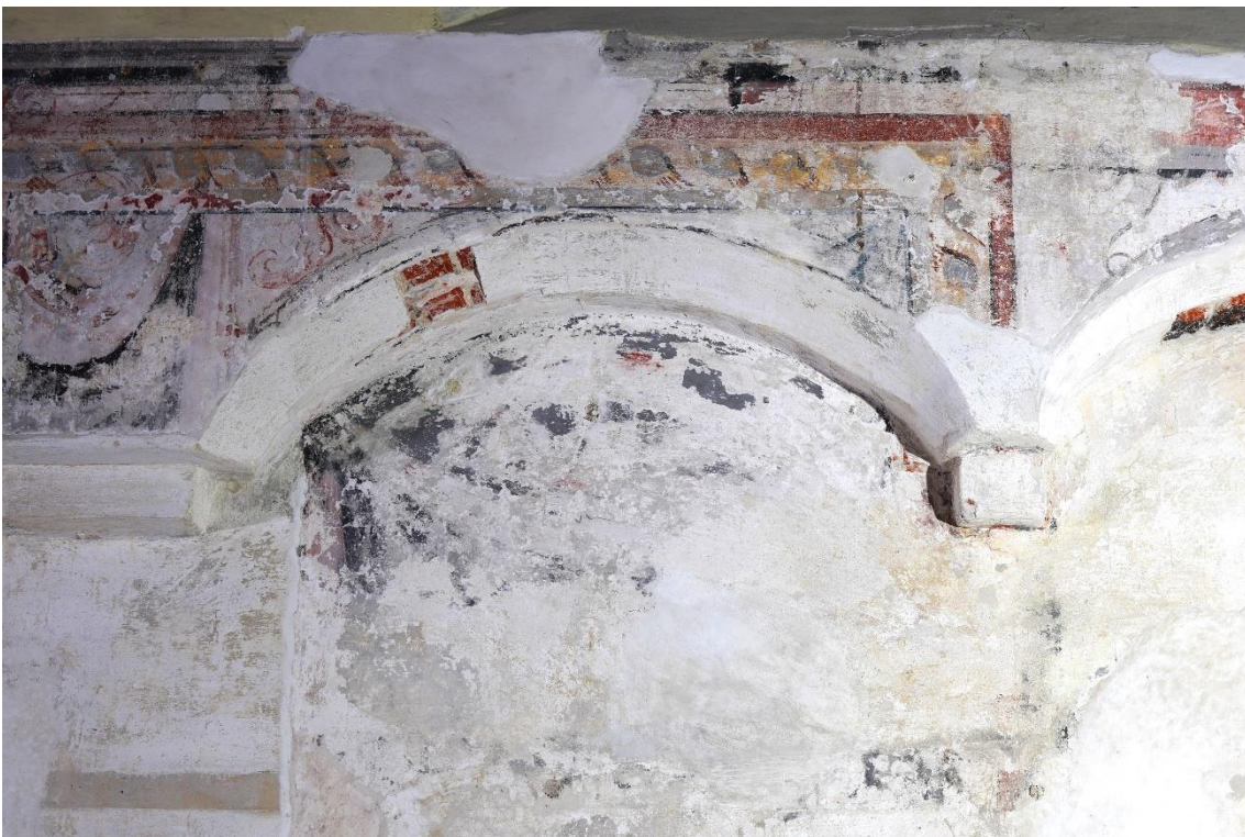
Ilustracja 77. Górna część trzeciej niszy od wschodu wraz z fragmentem malowidła nad jej krawędzią po zakończeniu prac
