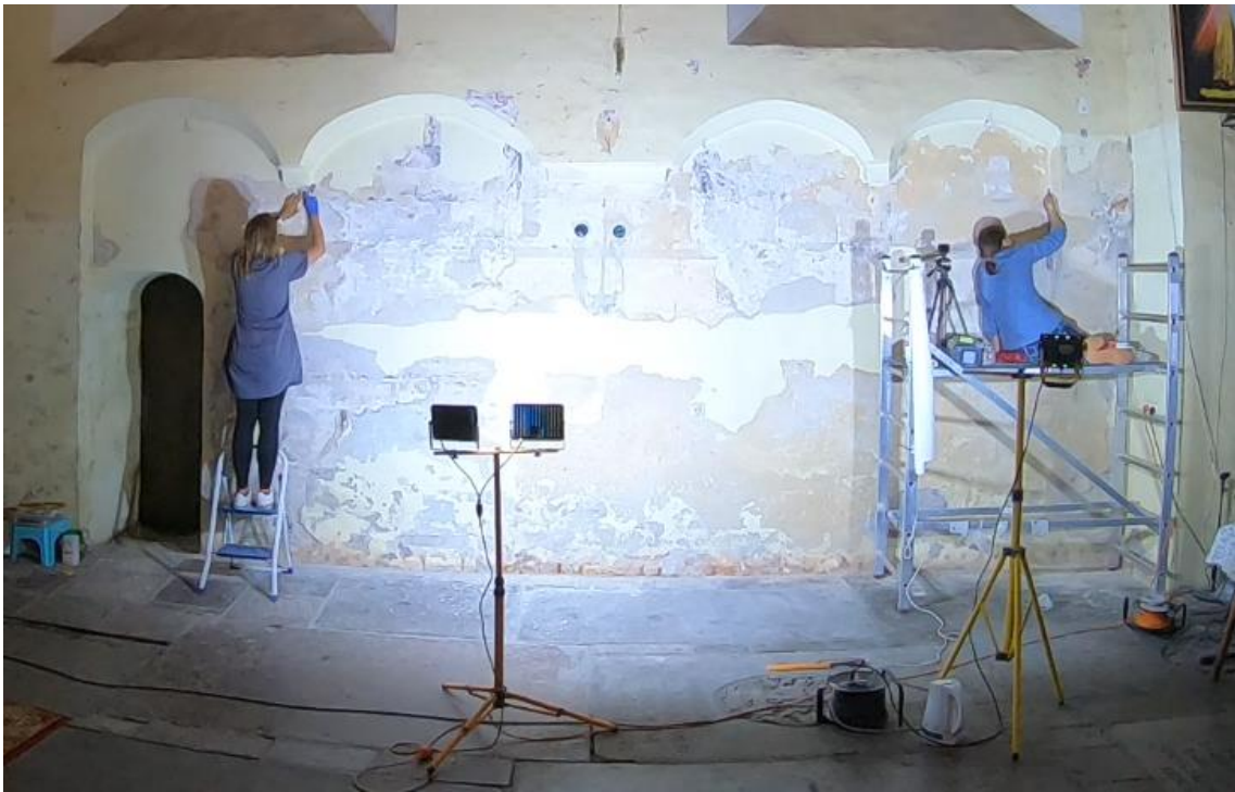
Ilustracja 36. Usuwanie wtórnych warstw
