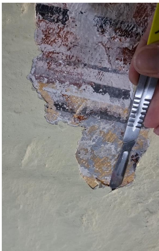
Ilustracja 53. Dalsze odsłanianie fragmentu malowidła poprzez usuwanie wtórnych warstw przy pomocy skalpela
