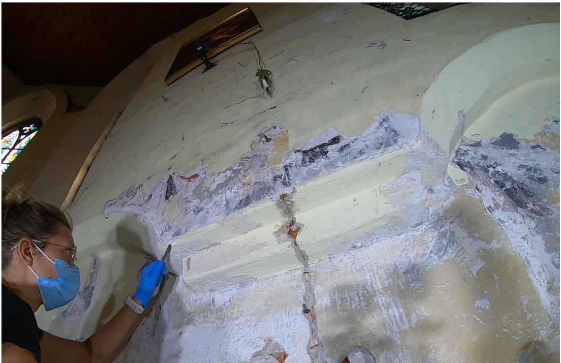
Ilustracja 39. Usuwanie wtórnych warstw
