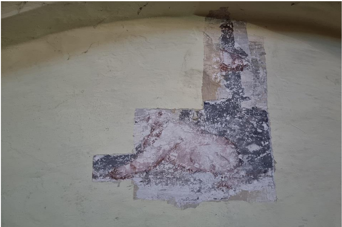
Ilustracja 19. Odkrywka znajdująca się w drugiej niszy od wschodu, przy górnej krawędzi
