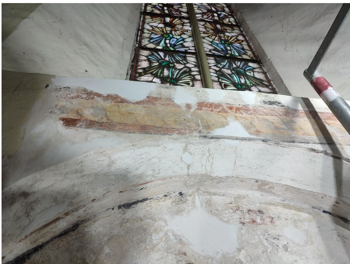
Ilustracja 65. Fragment malowidła nad krawędzią pierwszej niszy od wschodu po uzupełnieniu ubytków i opracowaniu kitów
