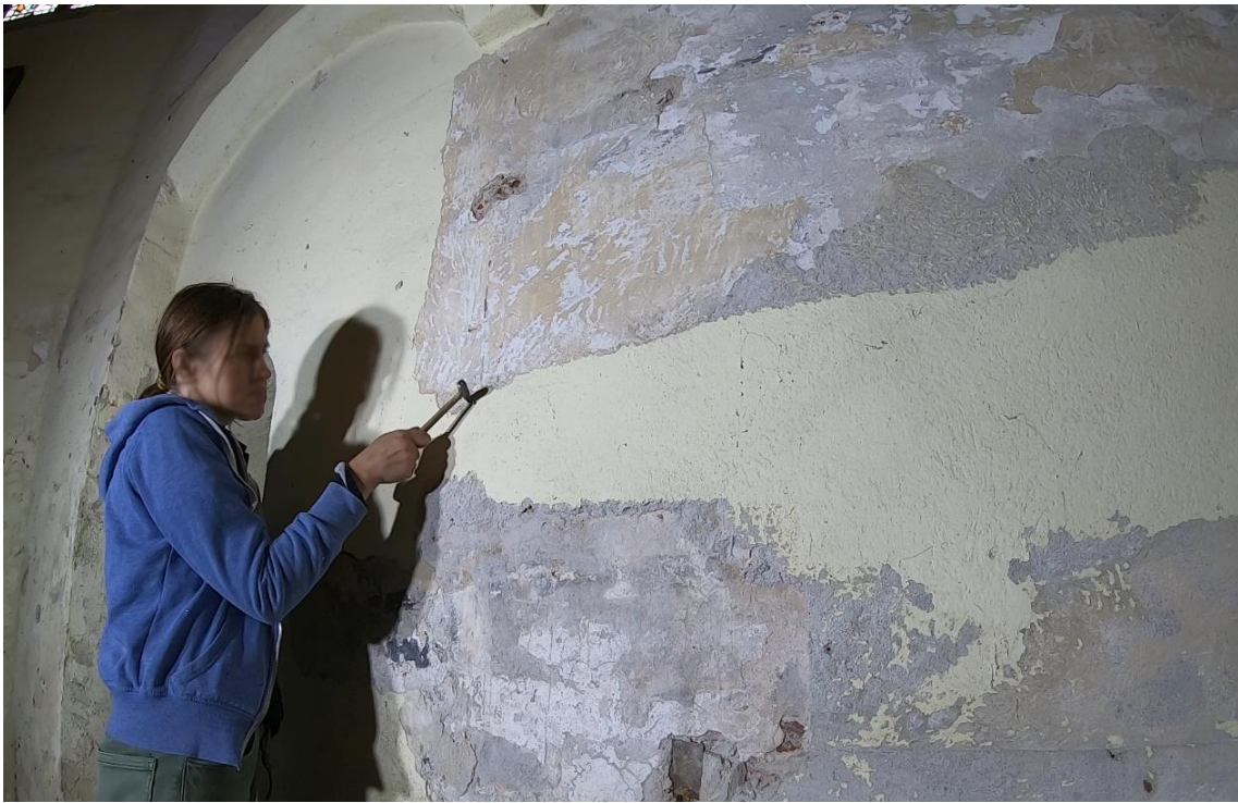
Ilustracja 32. Mechaniczne usuwanie wtórnych warstw przy pomocy młotka
