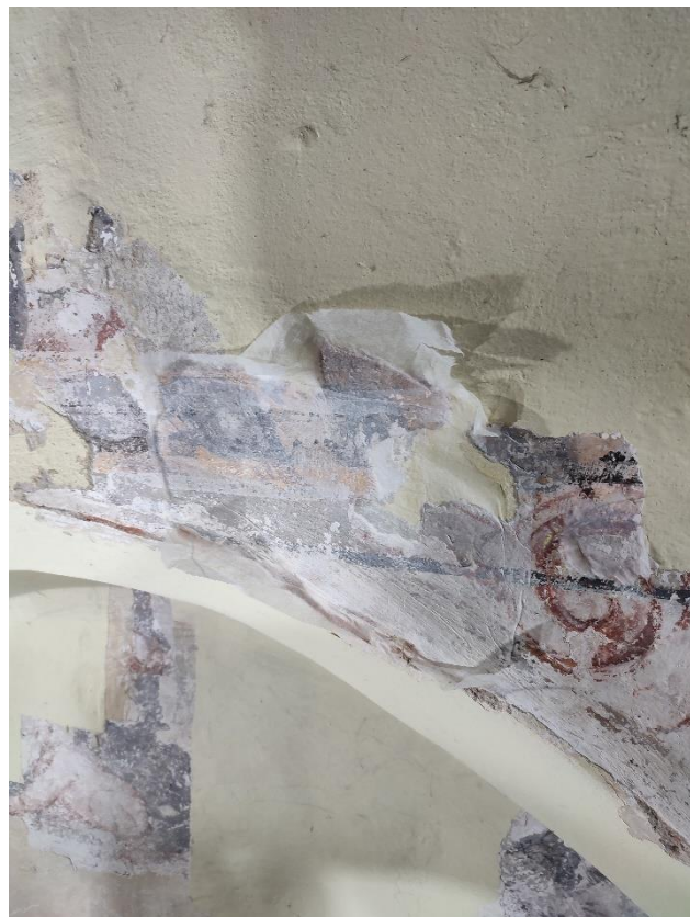
Ilustracja 56. Fragment malowidła z elementem woluty w trakcie konsolidacji pędzlem przez bibułę
