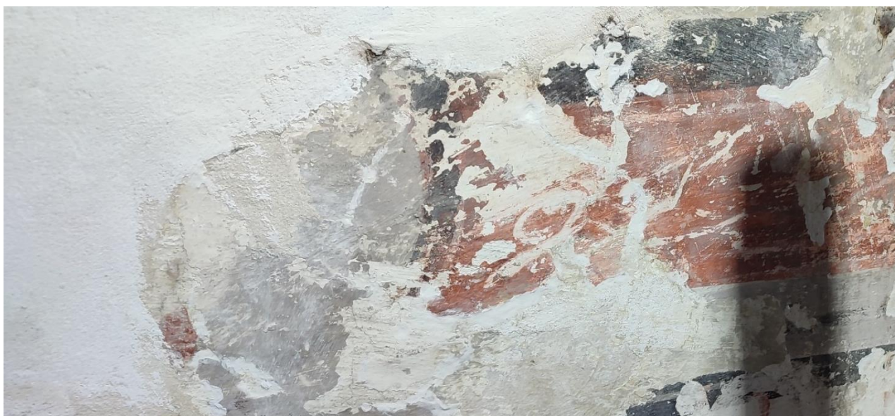
Ilustracja 70. Zbliżenie na fragment malowidła w okolicy łuku tęczowego po zabezpieczeniu opaskami z zaprawy wokół odsłoniętych warstw malarskich
