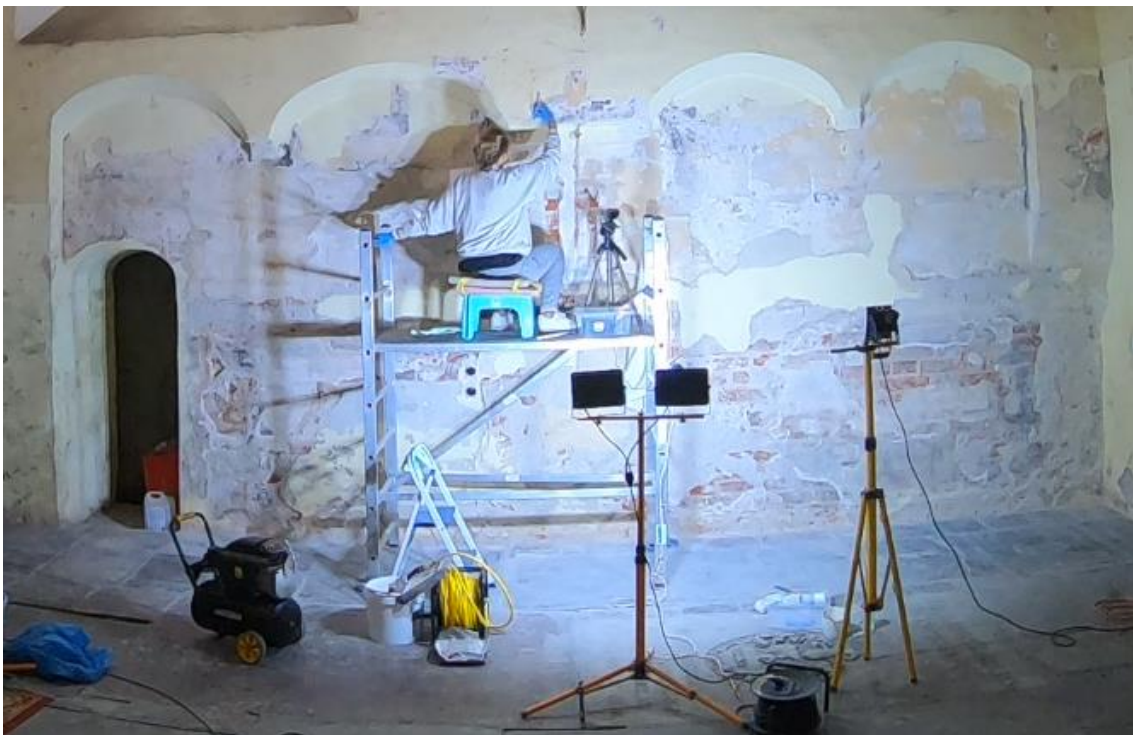
Ilustracja 41. Dalsze usuwanie wtórnych warstw
