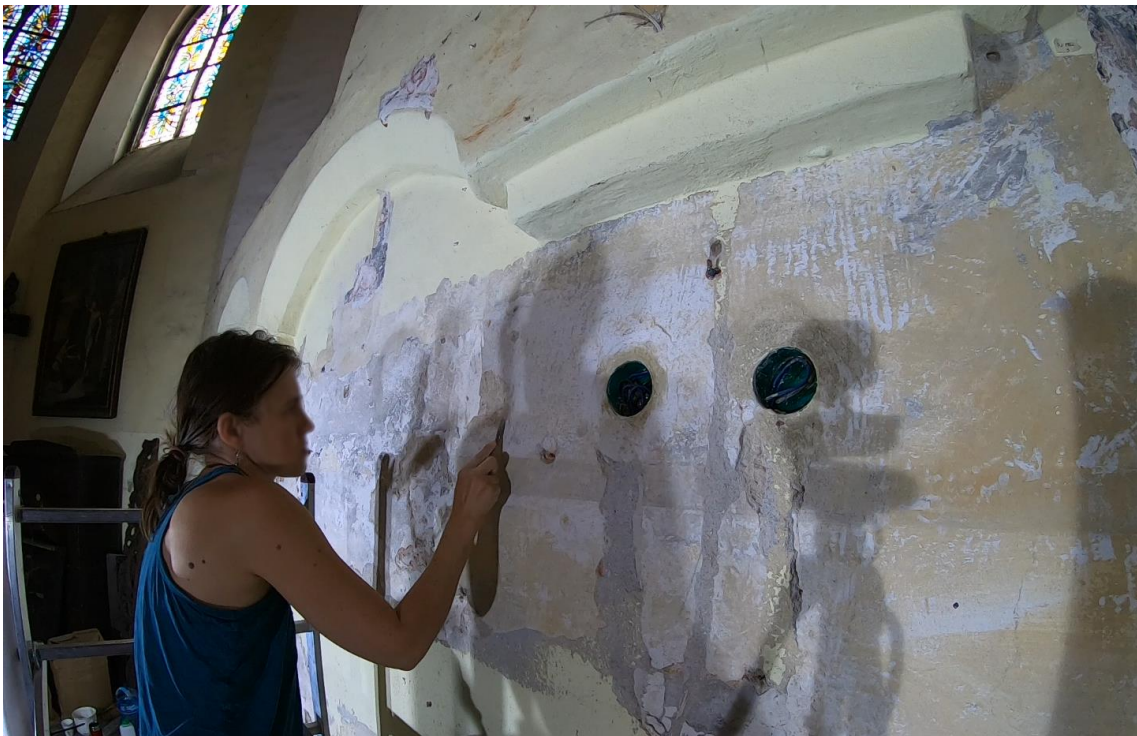
Ilustracja 35. Mechaniczne usuwanie wtórnych warstw za pomocą skalpela
