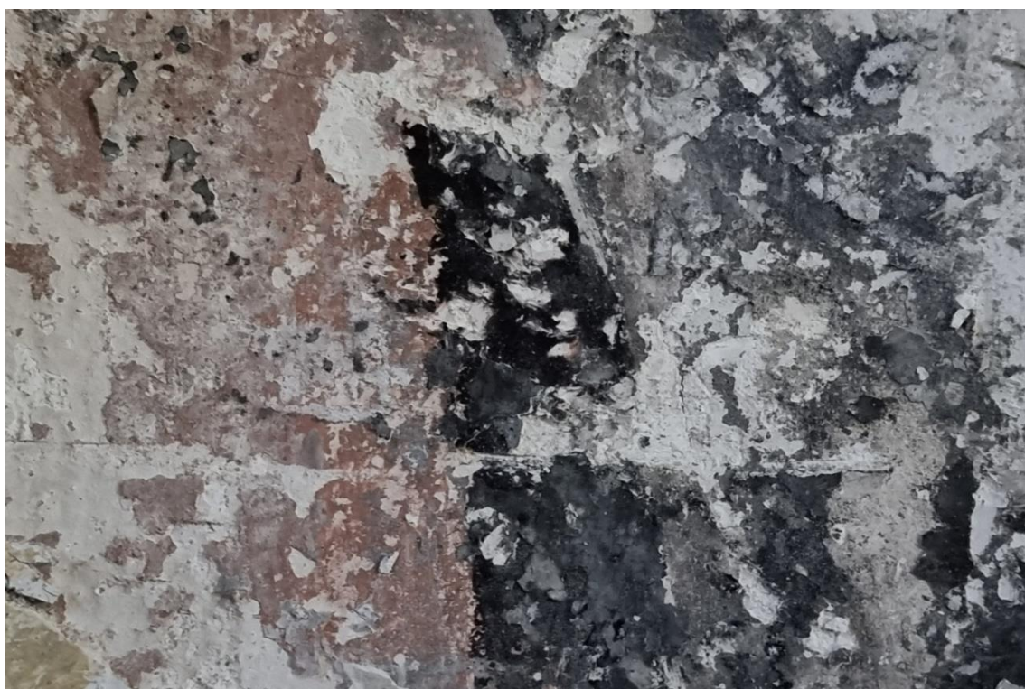
Ilustracja 26. Zbliżenie na fragment odkrywki. Widoczna pudrująca się warstwa malarska
