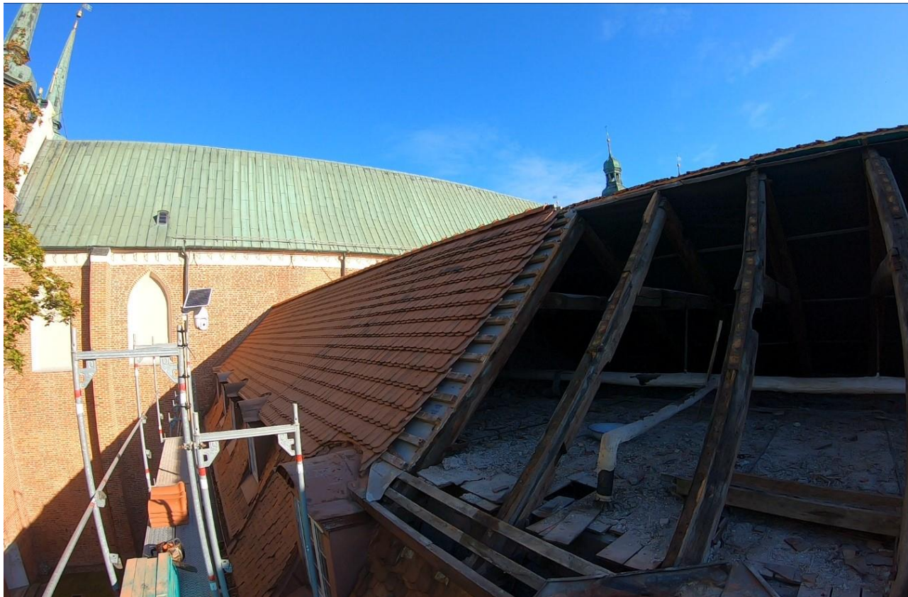
Ilustracja 19. Stan po demontażu łacenia i membrany paroprzepuszczalnej
