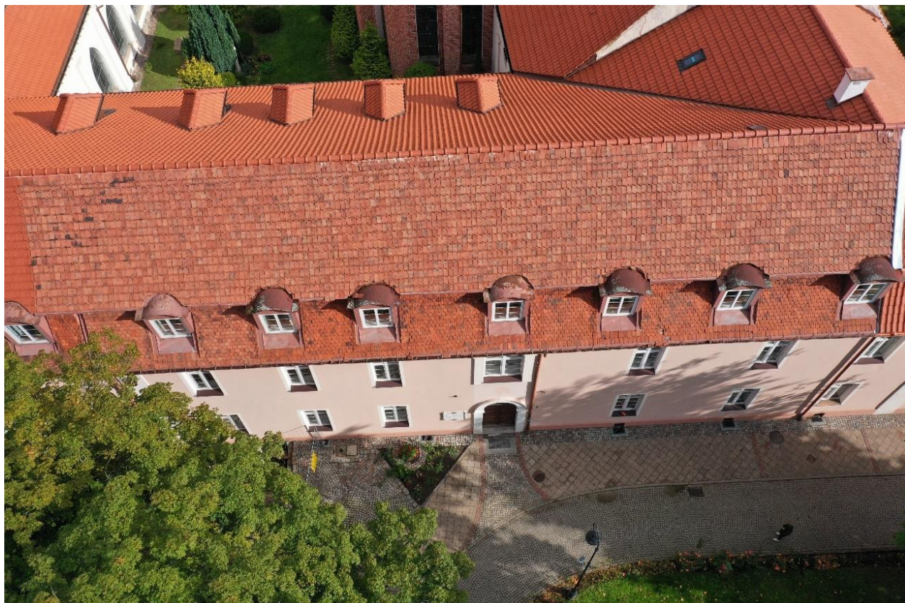
Ilustracja 8. Fragment połaci zachodniej skrzydła zachodniego przed pracami
