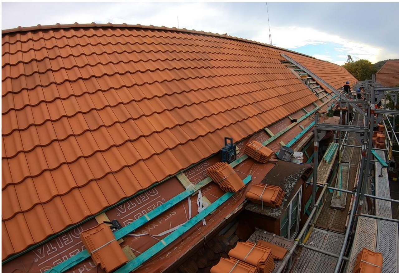
Ilustracja 30. Montaż dachówek
