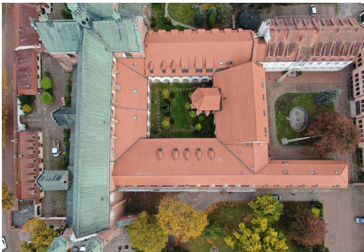
Ilustracja 38. Widok ogólny obiektu po zakończeniu prac
