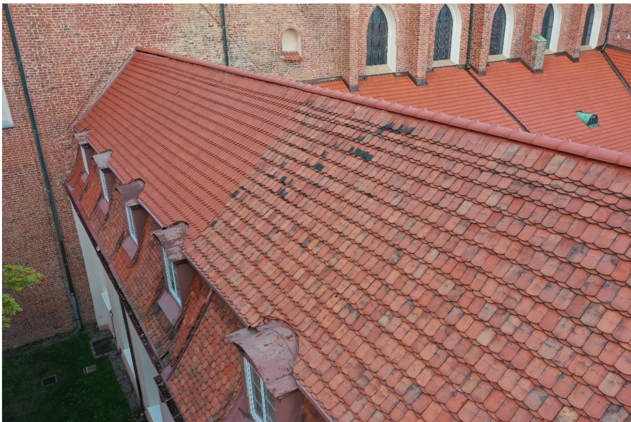
Ilustracja 10. Fragment połaci zachodniej skrzydła zachodniego przed pracami
