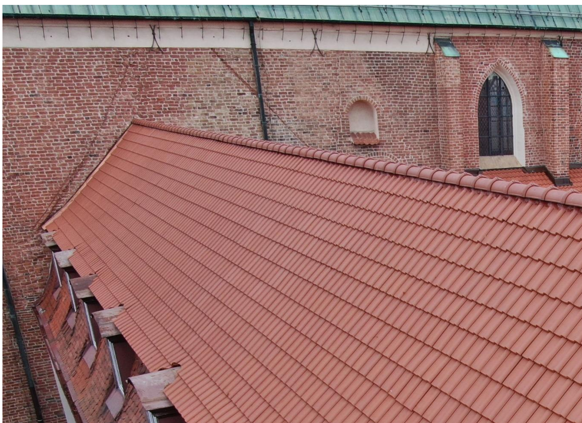
Ilustracja 43. Stan po zakończeniu prac
