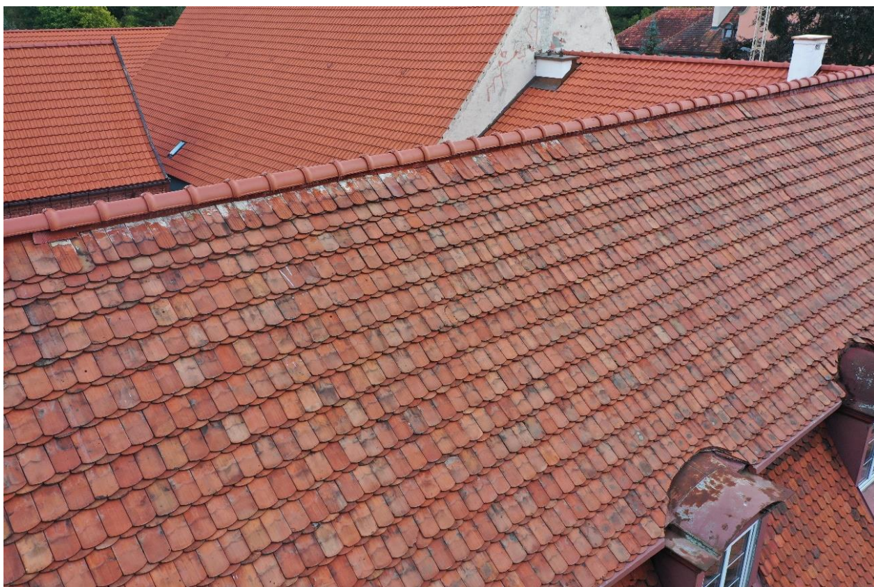
Ilustracja 11. Fragment połaci zachodniej skrzydła zachodniego przed pracami
