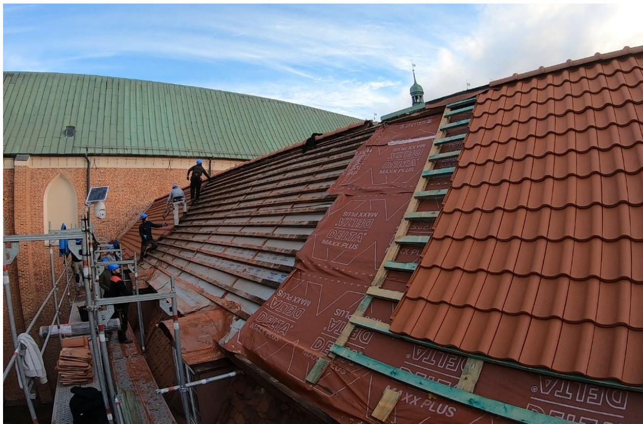
Ilustracja 22. Demontaż dachówek
