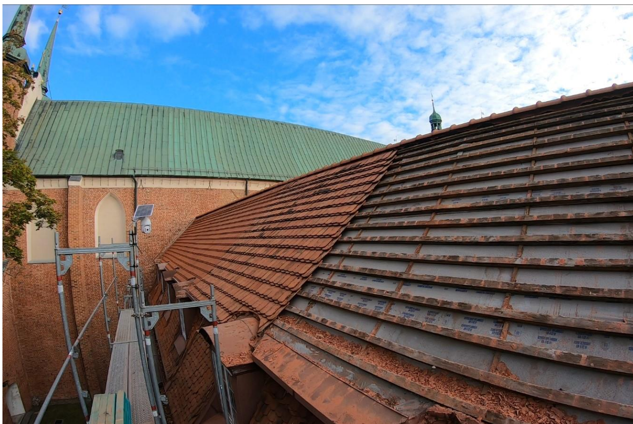
Ilustracja 18. Stan po demontażu dachówek
