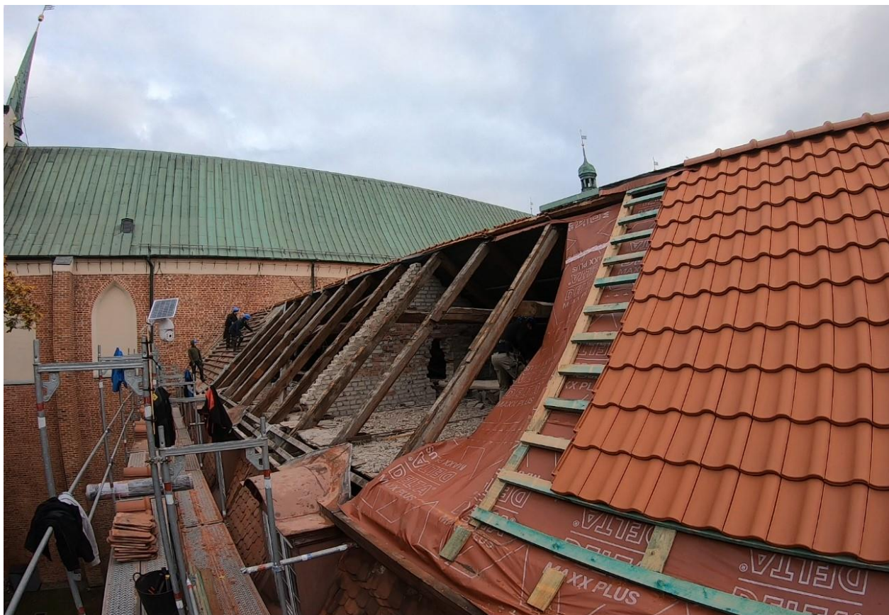
Ilustracja 24. Stan po demontażu łączenia i membrany paroprzepuszczalnej
