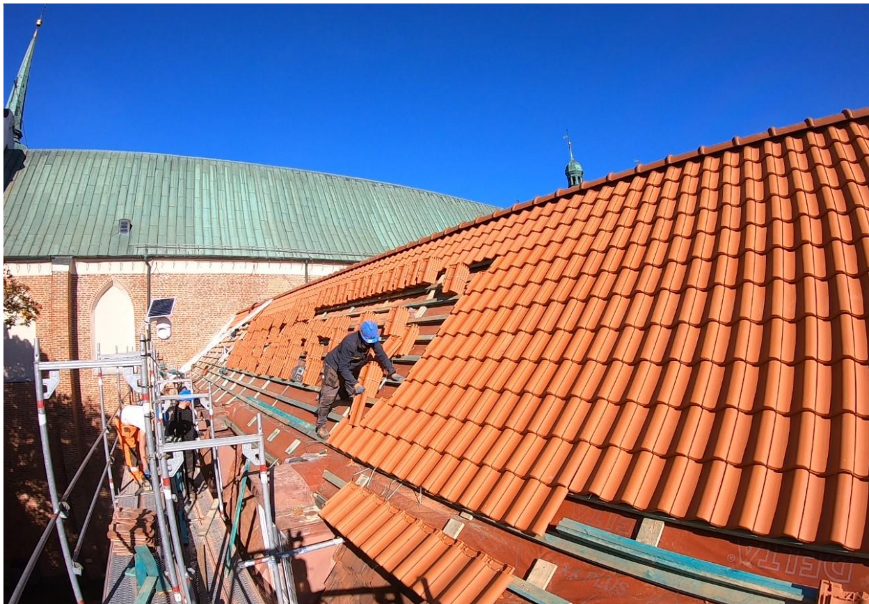
Ilustracja 26. Montaż dachówek
