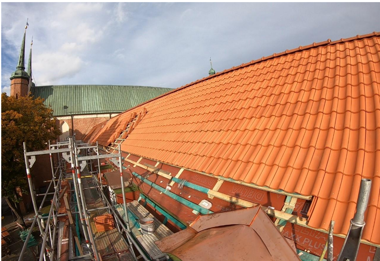
Ilustracja 36. Montaż dachówek
