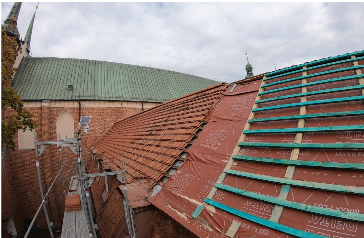
Ilustracja 20. Montaż membrany paroprzepuszczalnej i łączenia. Część północna, widok od południa
