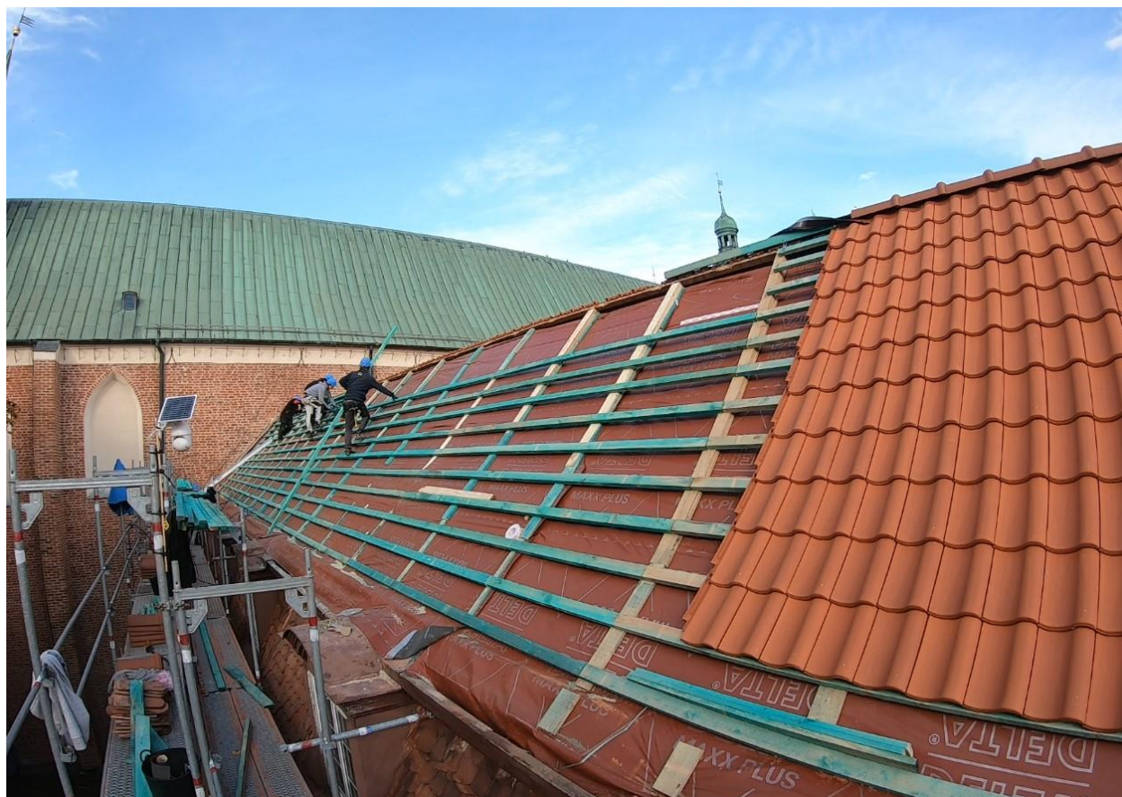
Ilustracja 25. Montaż membrany paroprzepuszczalnej i łączenia
