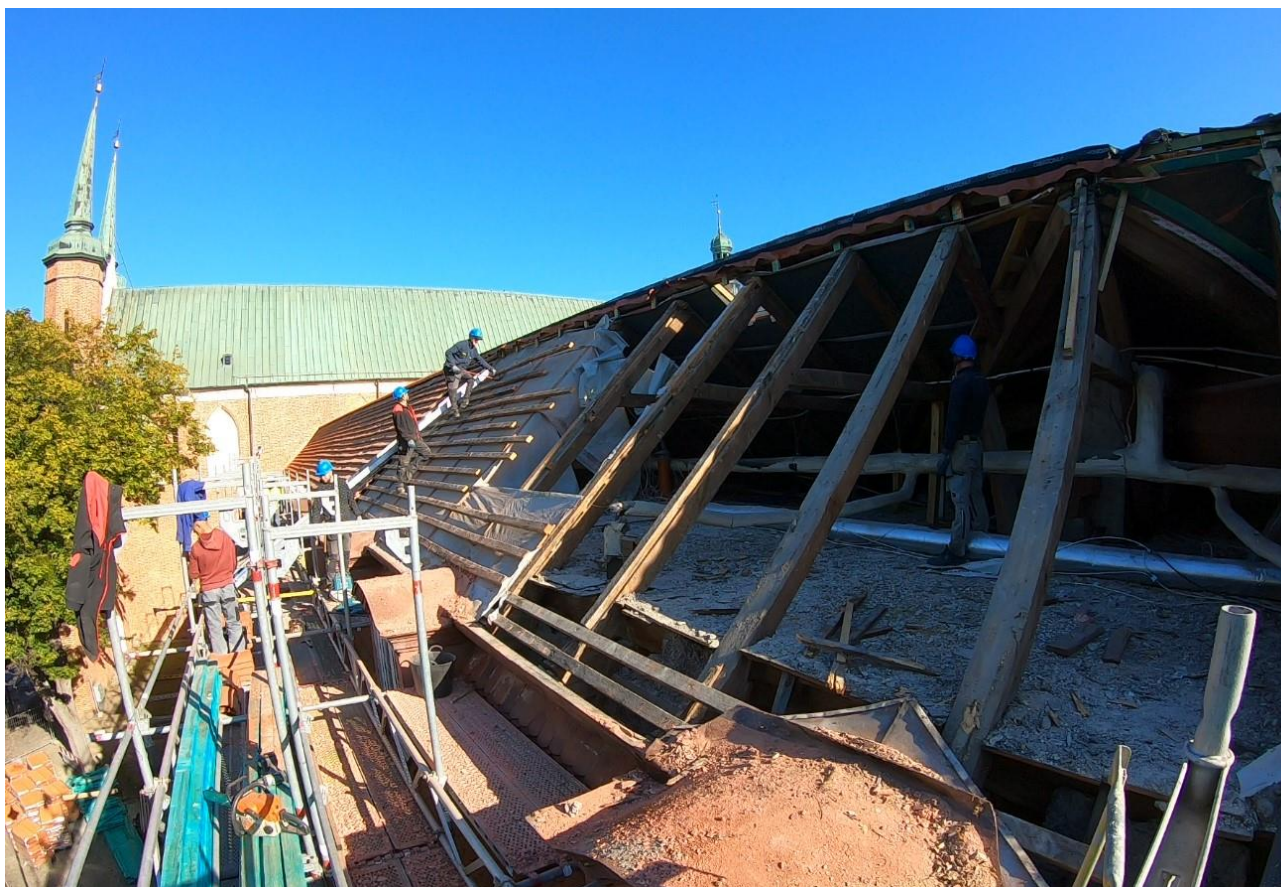
Ilustracja 33. Demontaż łączenia i membrany paroprzepuszczalnej
