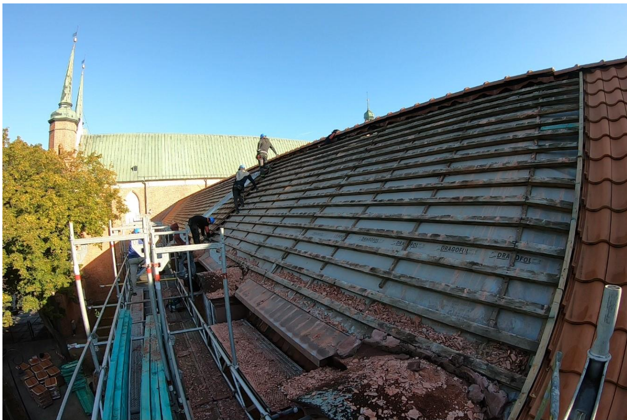
Ilustracja 32. Demontaż dachówek. Część południowa, widok od południa
