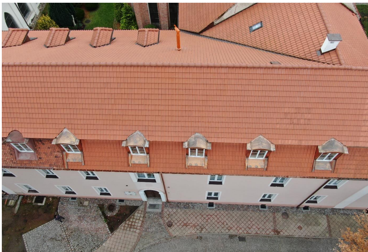
Ilustracja 41. Stan po zakończeniu prac
