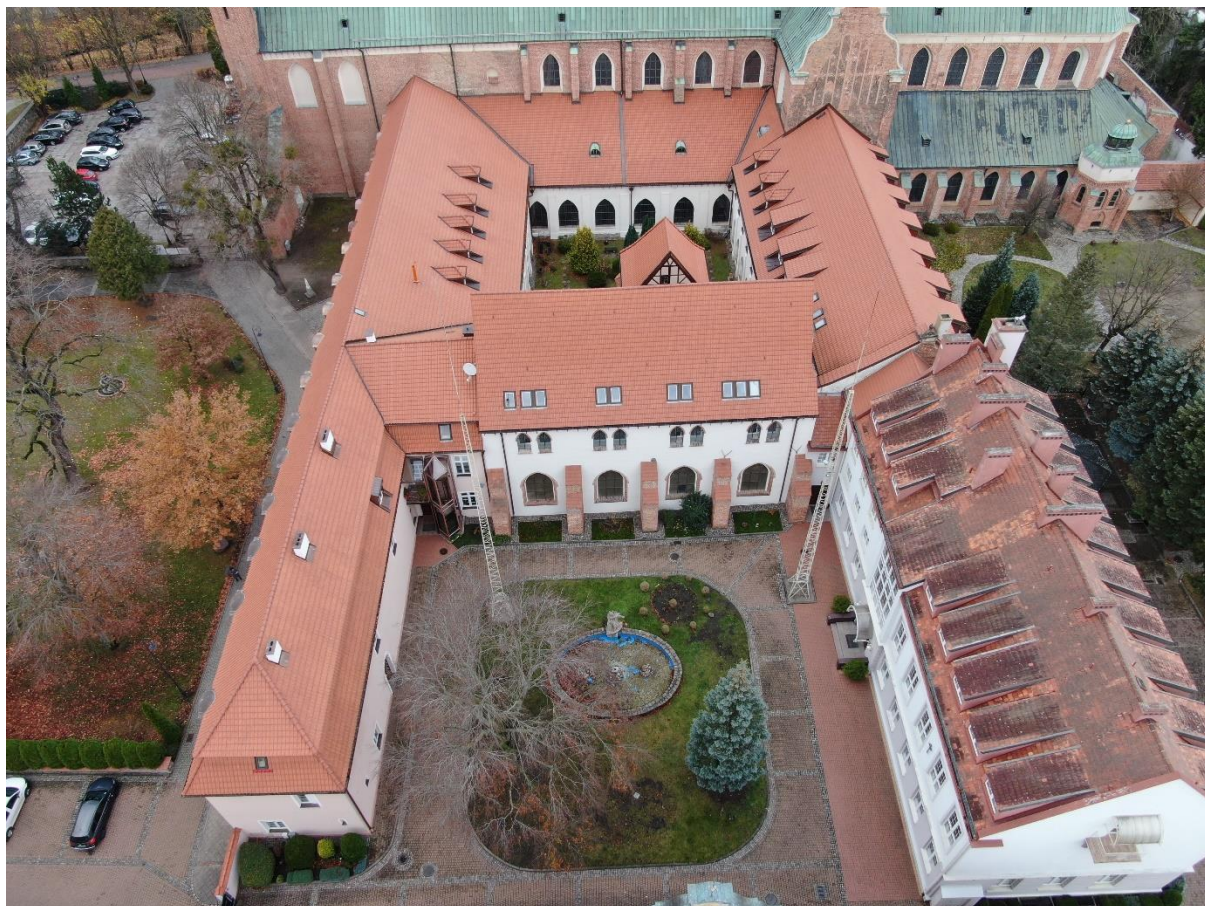
Ilustracja 40. Widok ogólny obiektu po zakończeniu prac
