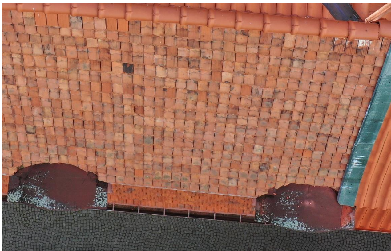
Ilustracja 15. Fragment połaci zachodniej skrzydła zachodniego przed pracami
