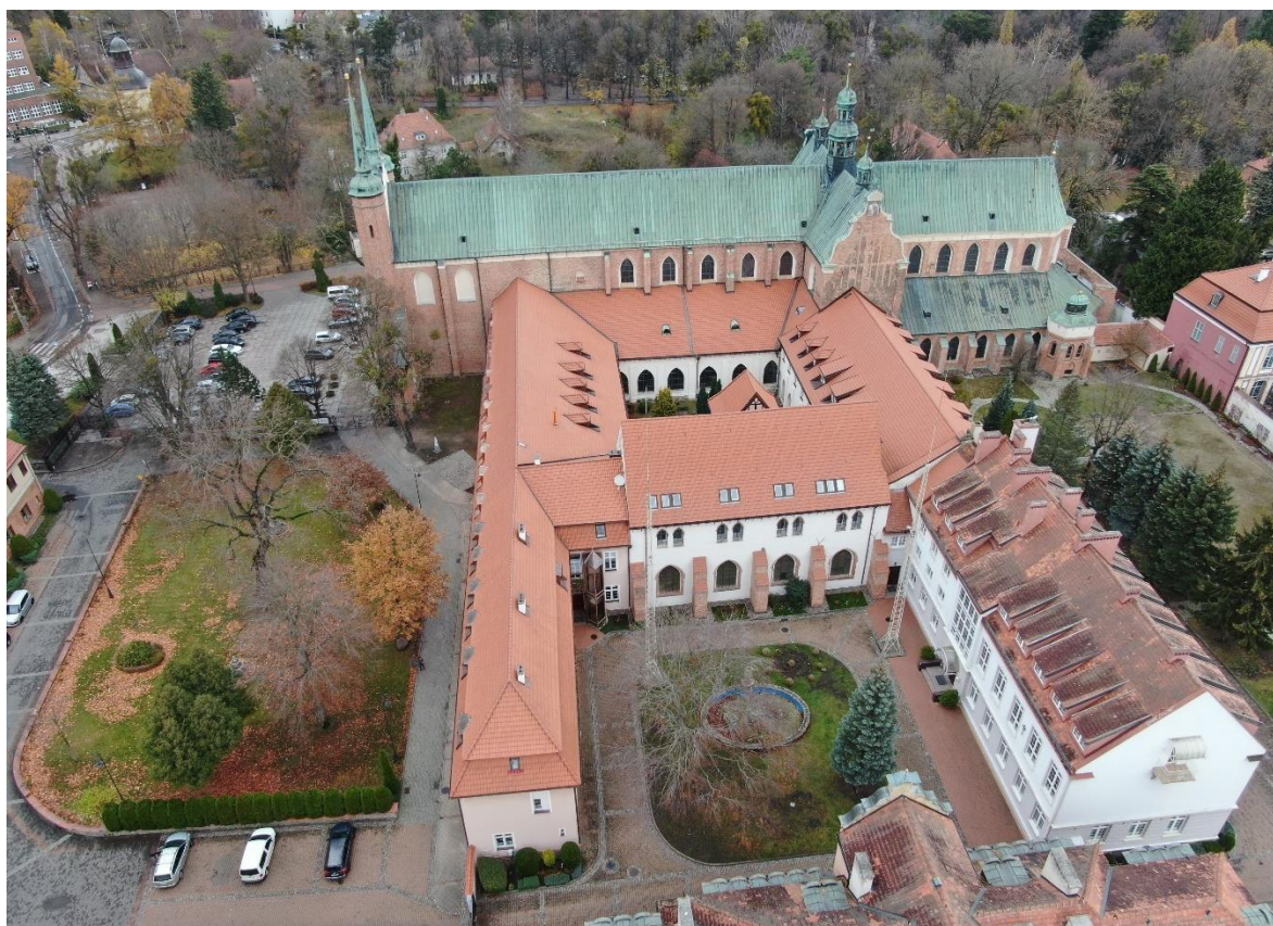
Ilustracja 39. Widok ogólny obiektu po zakończeniu prac
