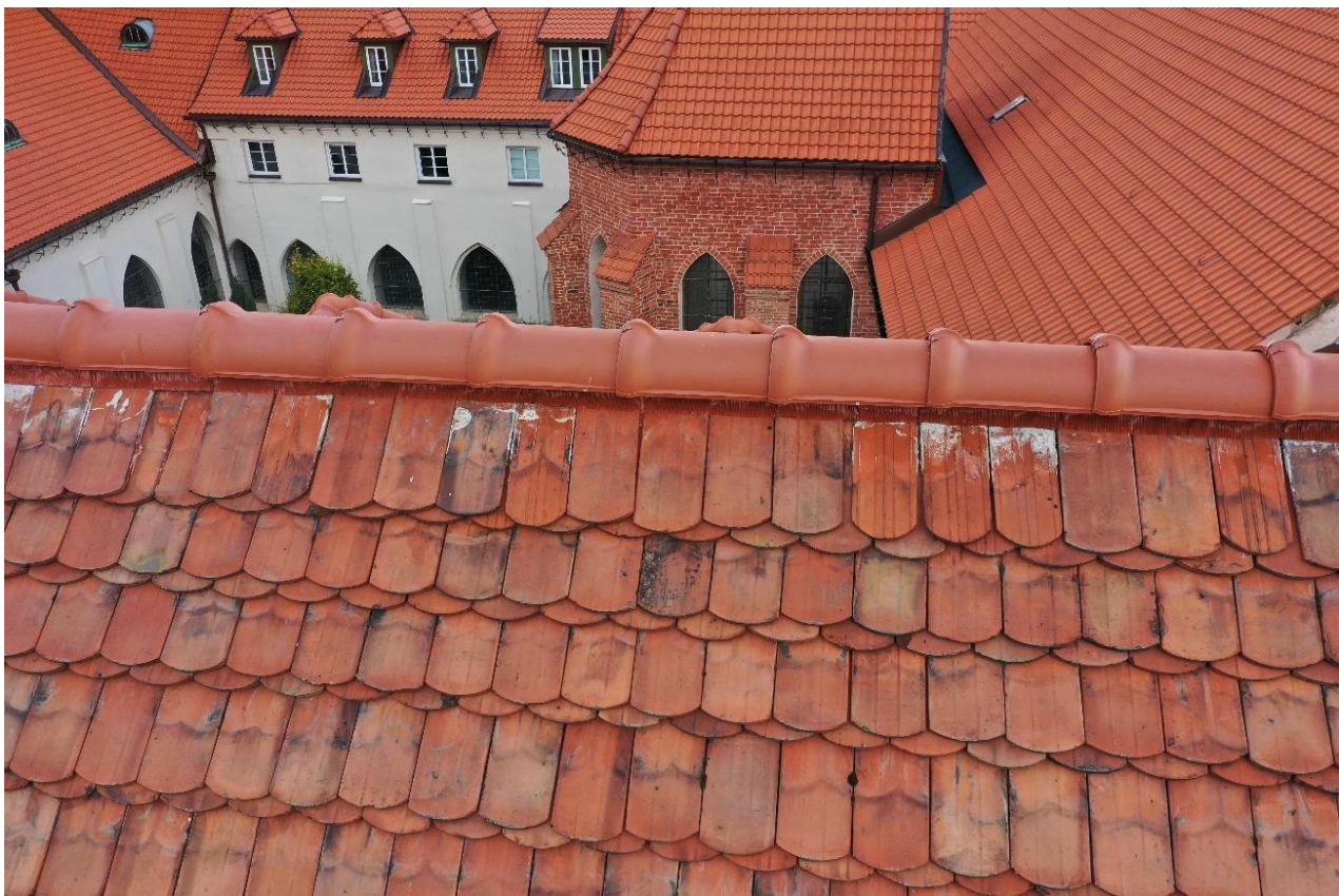
Ilustracja 13. Fragment połaci zachodniej skrzydła zachodniego przed pracami
