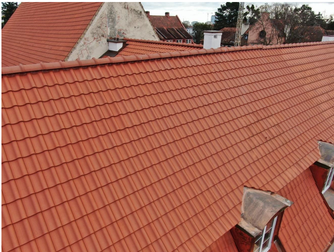
Ilustracja 44. Stan po zakończeniu prac
