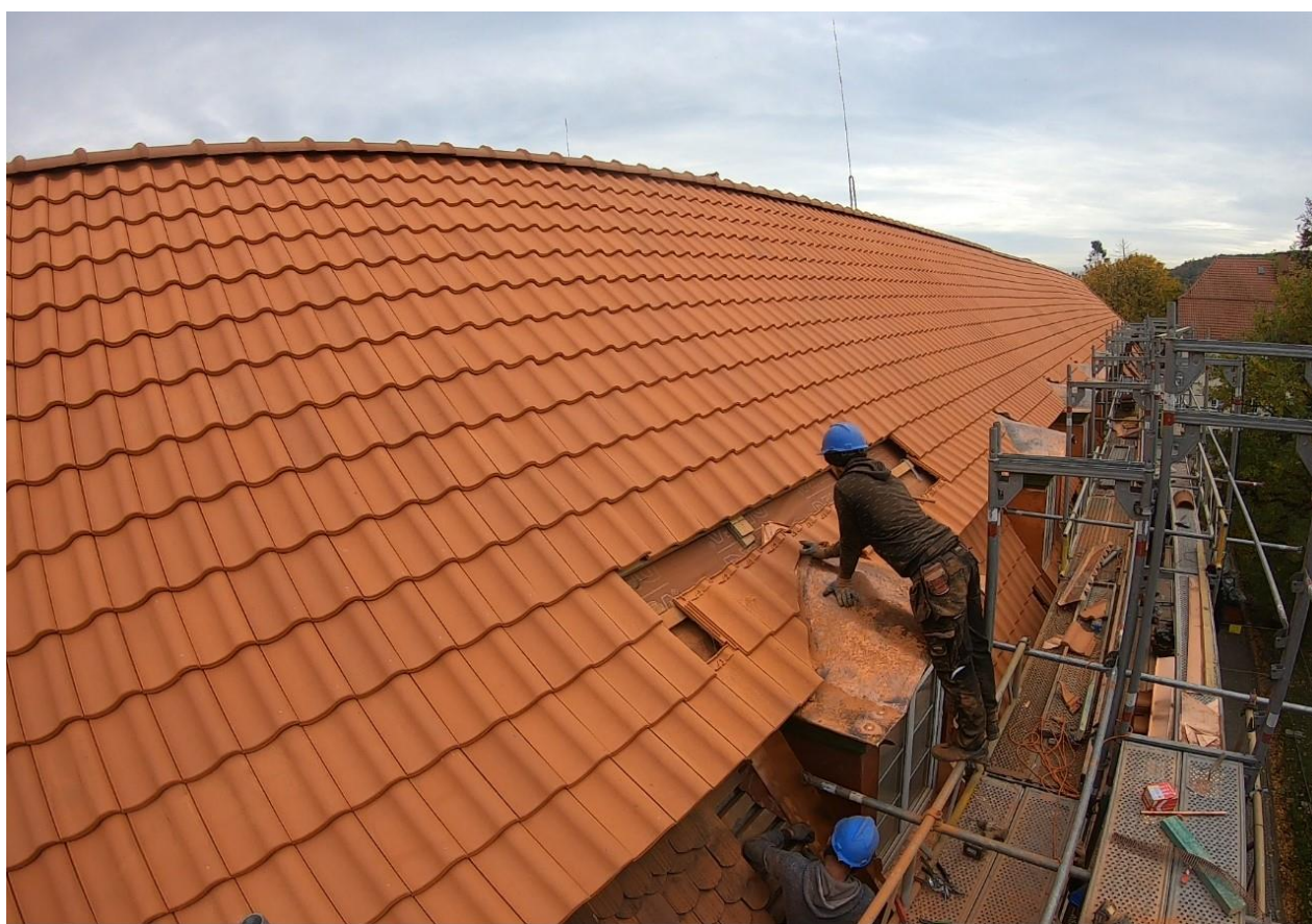
Ilustracja 31. Montaż dachówek
