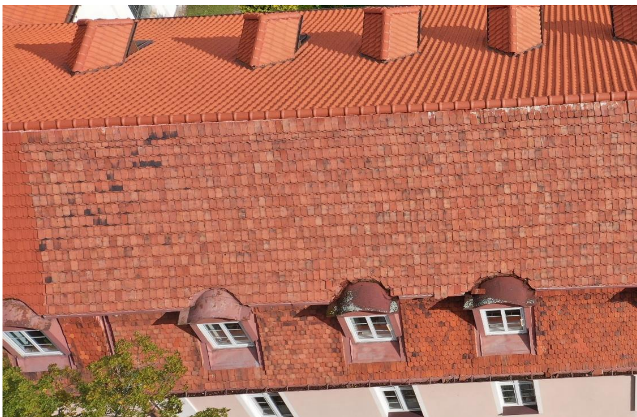
Ilustracja 9. Fragment połaci zachodniej skrzydła zachodniego przed pracami
