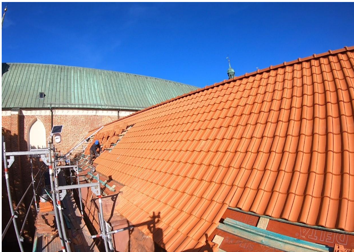
Ilustracja 27. Montaż dachówek
