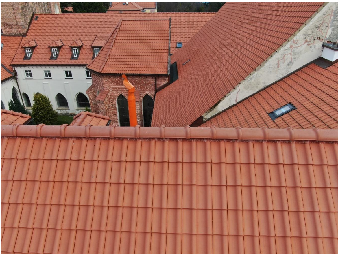
Ilustracja 46. Stan po zakończeniu prac
