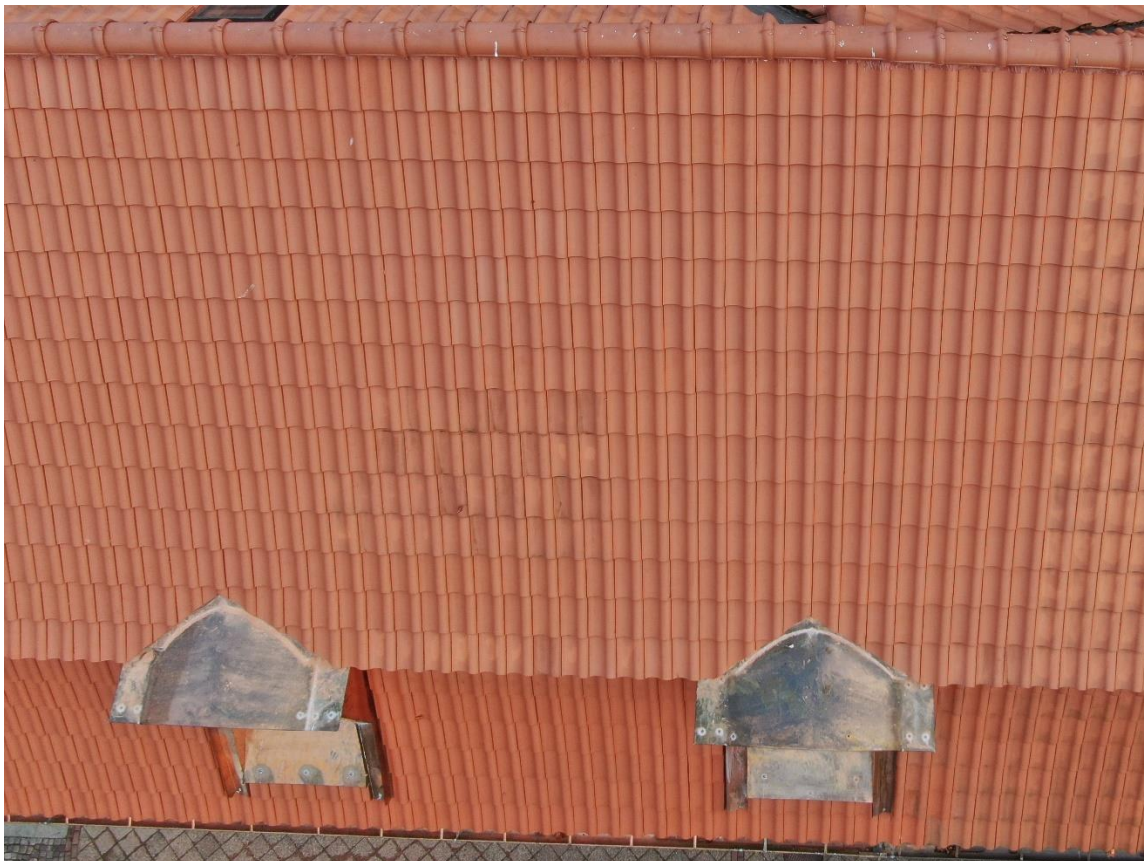
Ilustracja 48. Stan po zakończeniu prac
