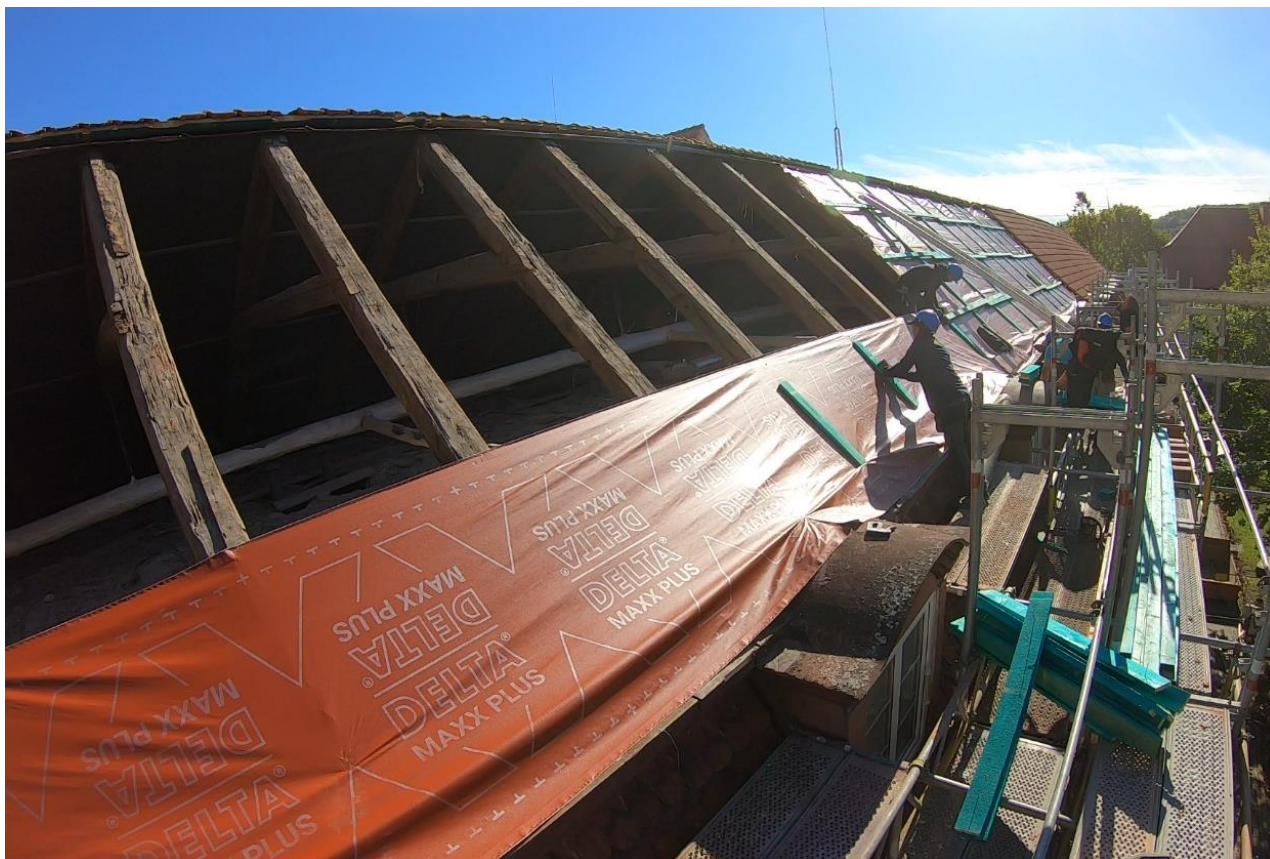
Ilustracja 28. Montaż membrany paroprzepuszczalnej i łączenia. Część środkowa, widok od północy
