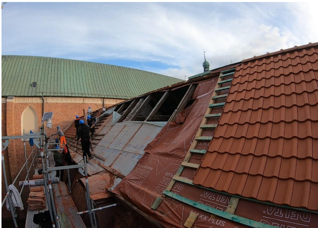
Ilustracja 23. Demontaż łączenia i membrany paroprzepuszczalnej
