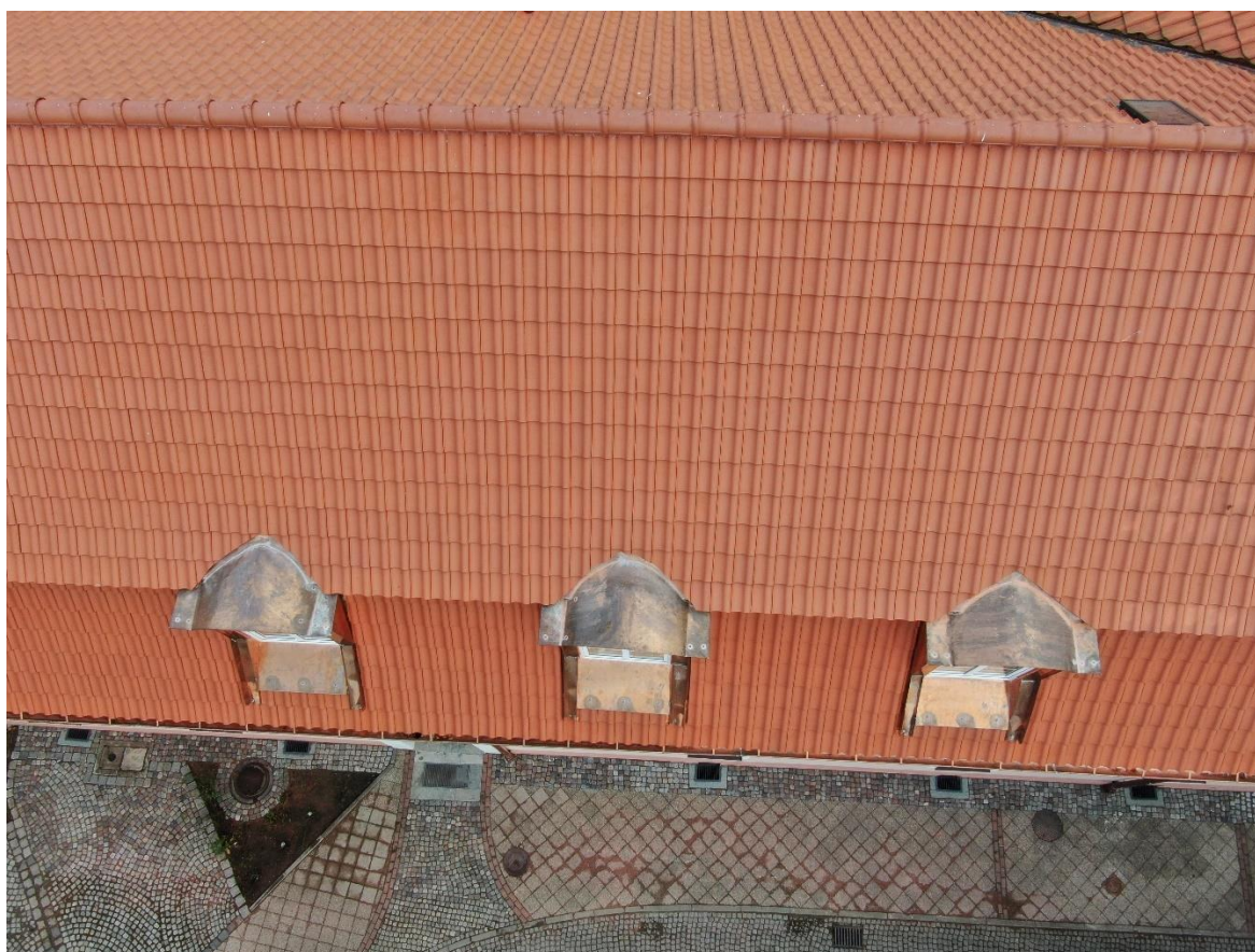
Ilustracja 45. Stan po zakończeniu prac
