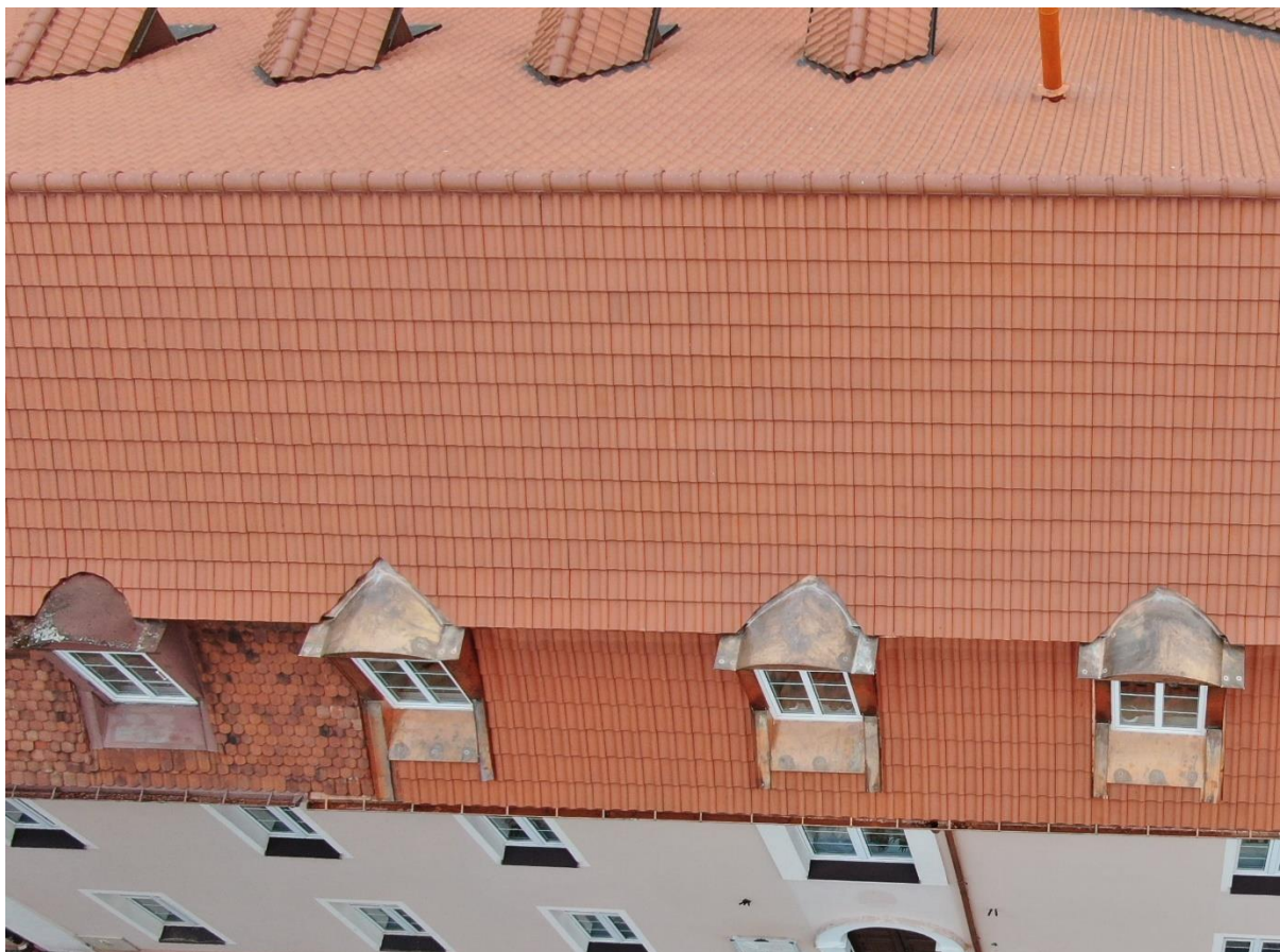
Ilustracja 42. Stan po zakończeniu prac
