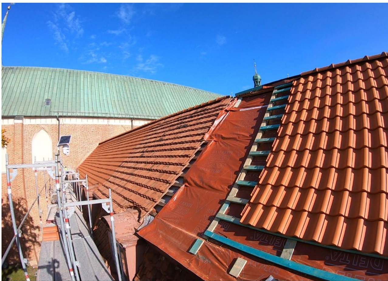
Ilustracja 21. Montaż dachówek
