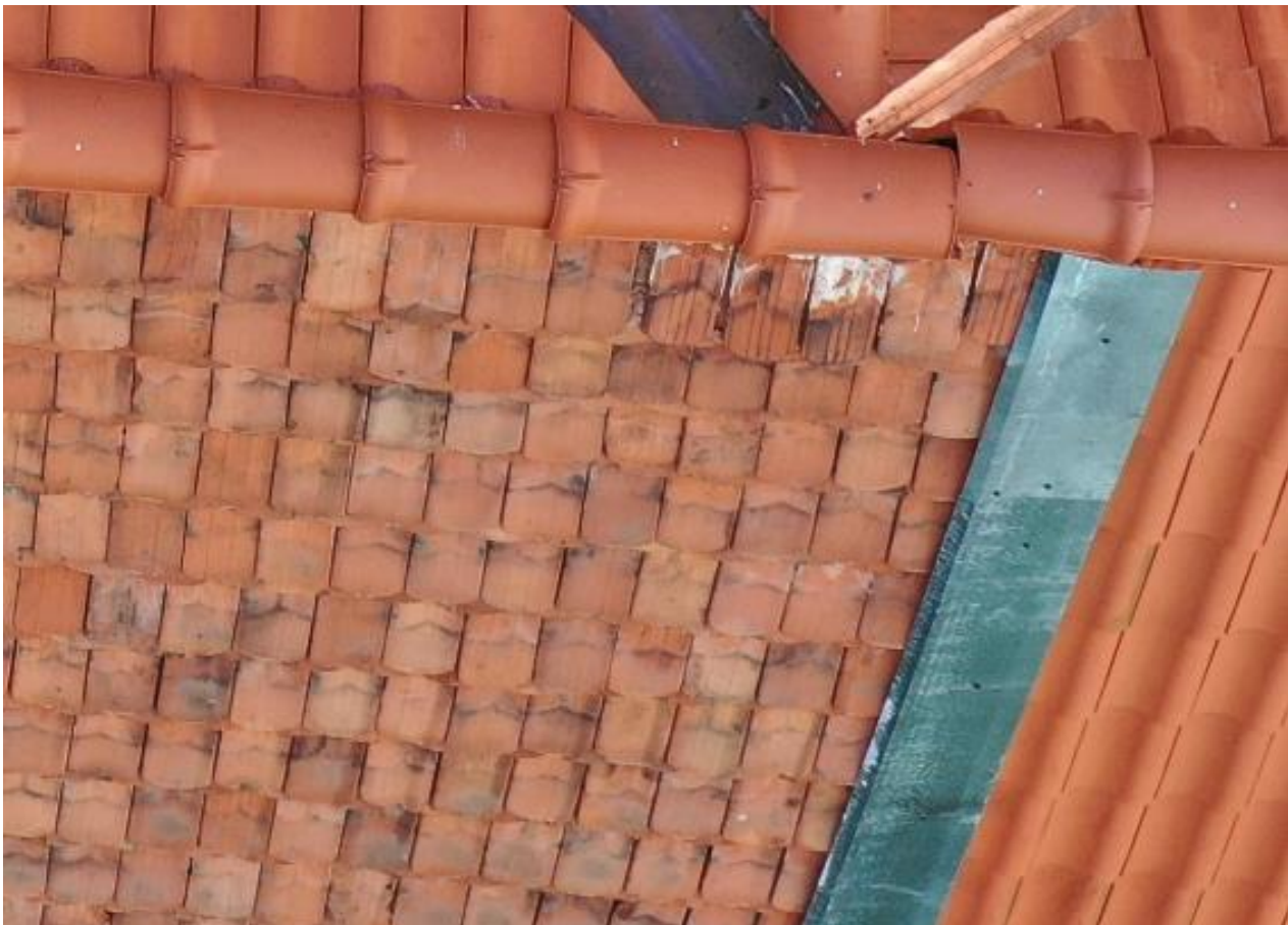
Ilustracja 16. Fragment połaci zachodniej skrzydła zachodniego przed pracami
