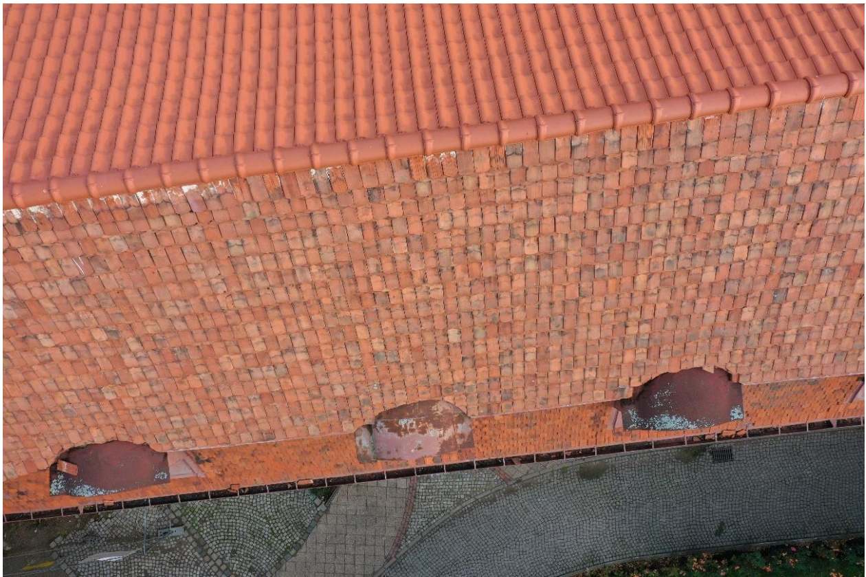
Ilustracja 12. Fragment połaci zachodniej skrzydła zachodniego przed pracami
