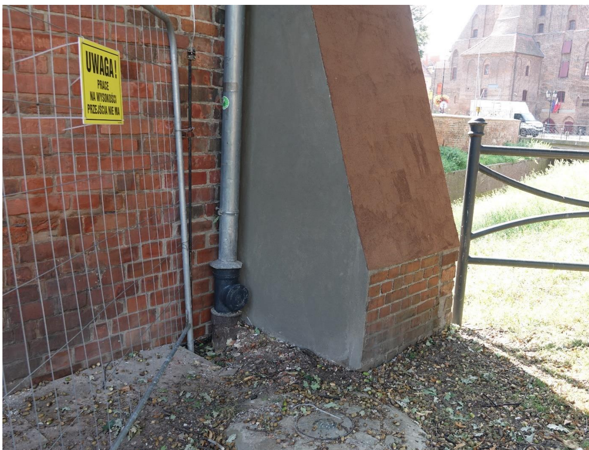
Ilustracja 76. Przypora po pracach konserwatorskich
