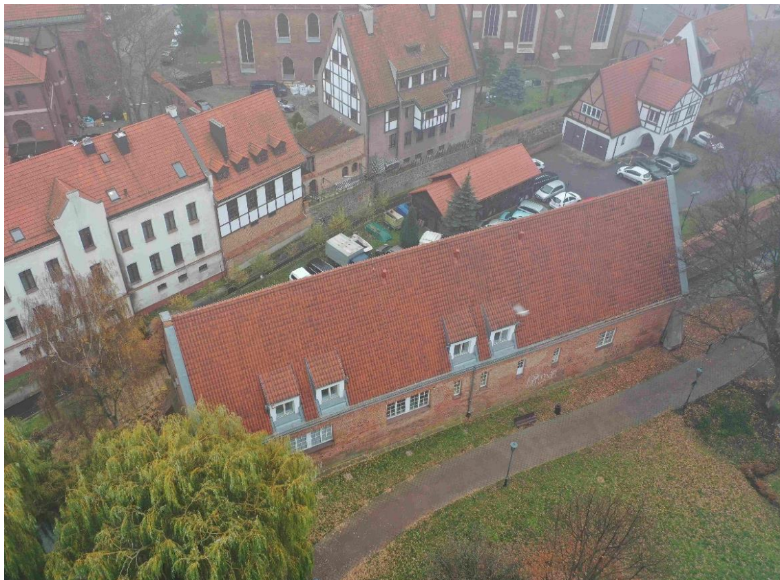
Ilustracja 5. Mały Młyn. Widok ogólny obiektu przed pracami
