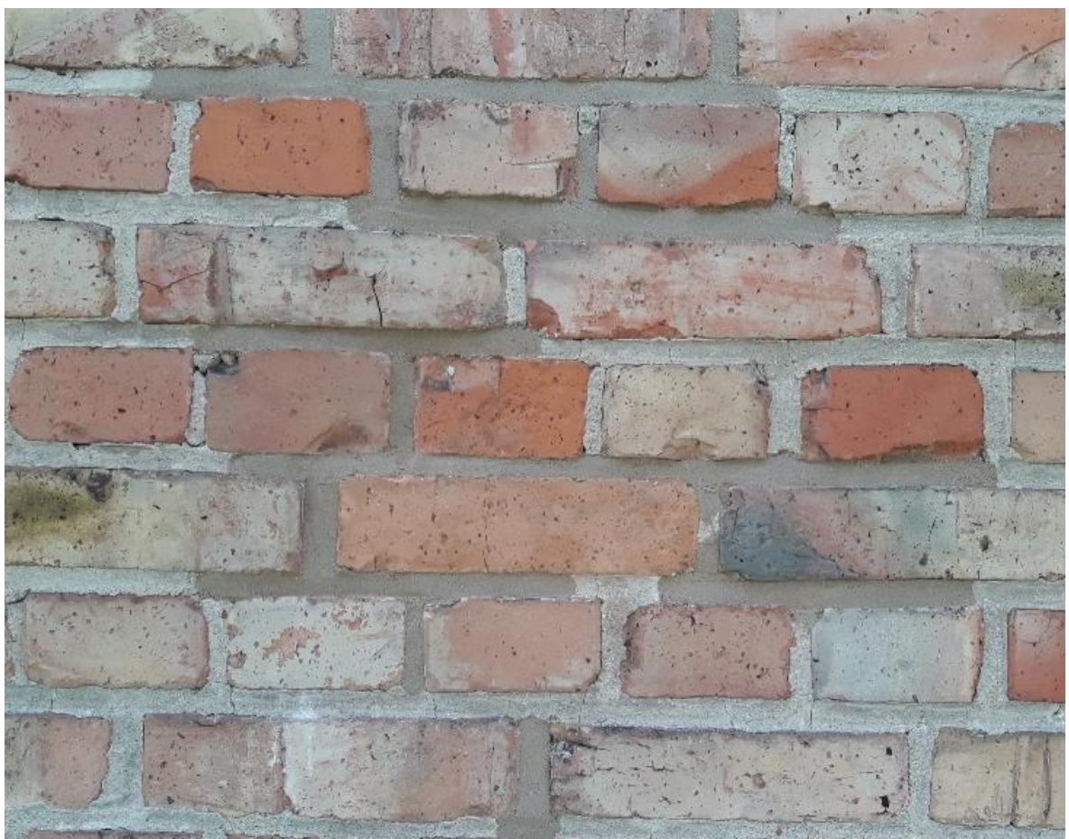
Ilustracje 58-59. Uzupełnienia ubytków zaprawy w spoinach: przed i po
