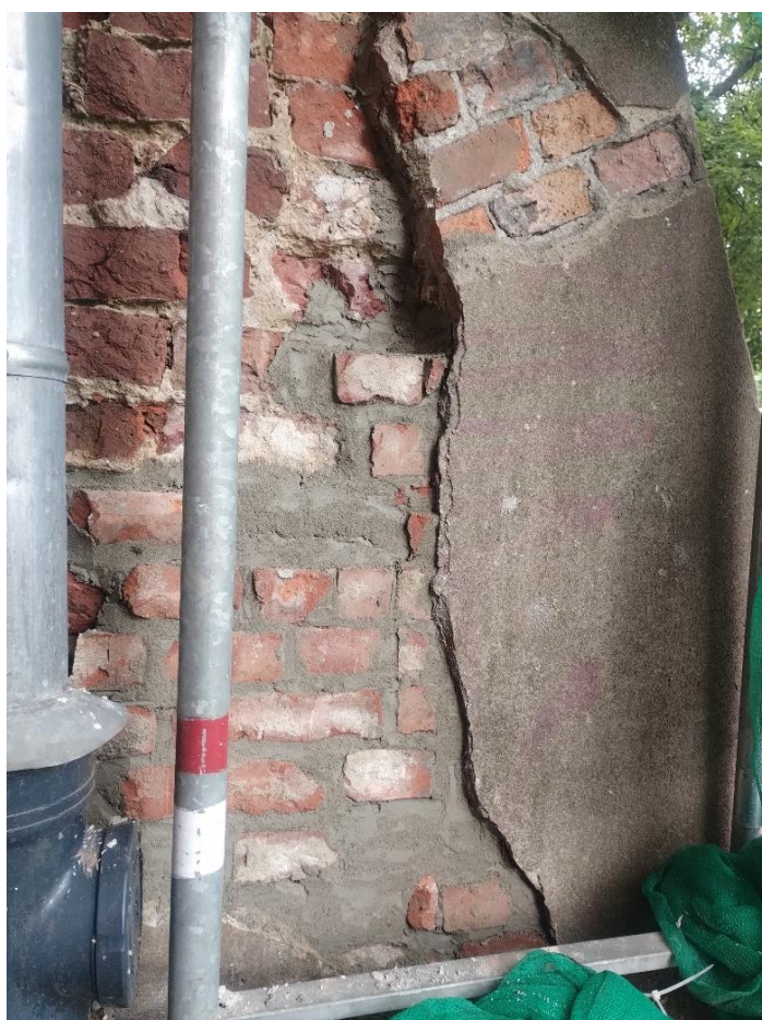
Ilustracja 32. Przygotowanie do prac murarsko-tynkarskich w obrębie przypory
