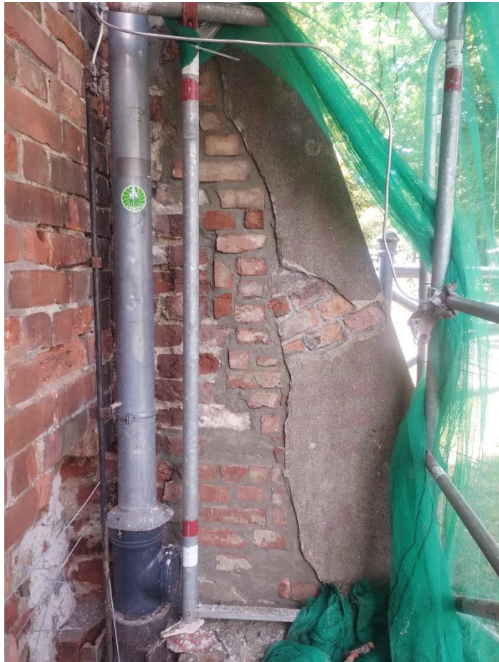
Ilustracja 33. Prace murarsko-tynkarskie w obrębie przypory
