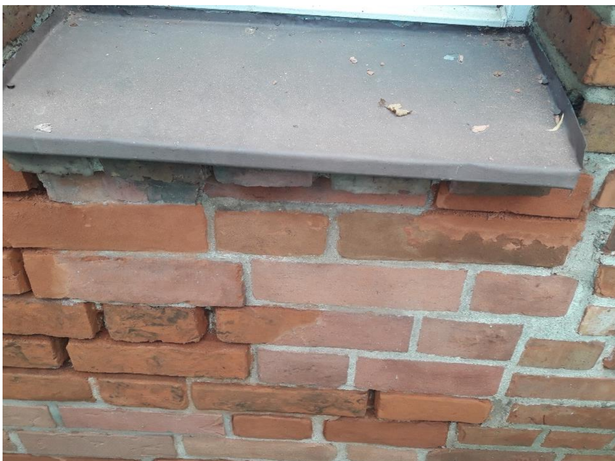
Ilustracja 52. Uzupełnianie ubytków w cegle
