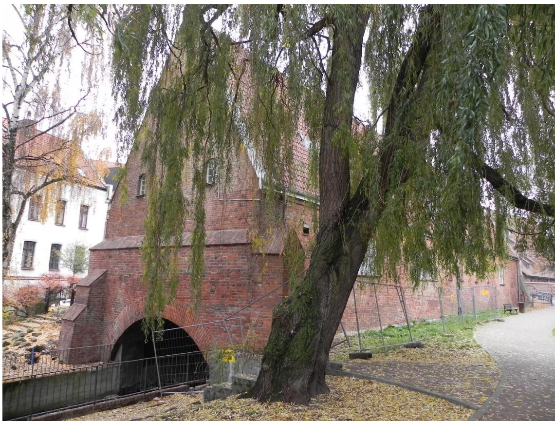
Ilustracja 6. Mały Młyn. Widok ogólny obiektu przed pracami
