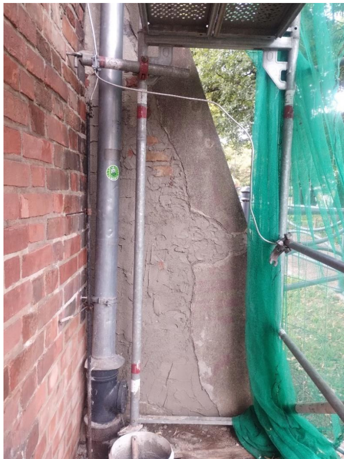
Ilustracja 35. Prace murarsko-tynkarskie w obrębie przypory
