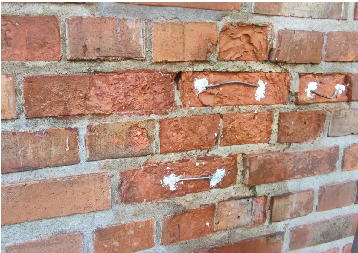
Ilustracja 49. Zbrojenia pod uzupełnianie ubytków
