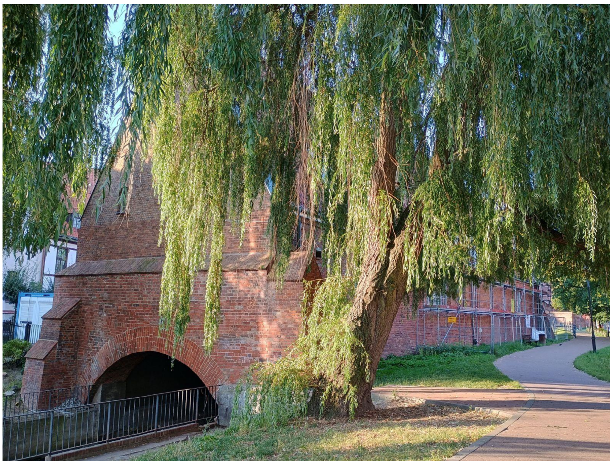
Ilustracja 70. Widok ogólny obiektu po pracach konserwatorskich
