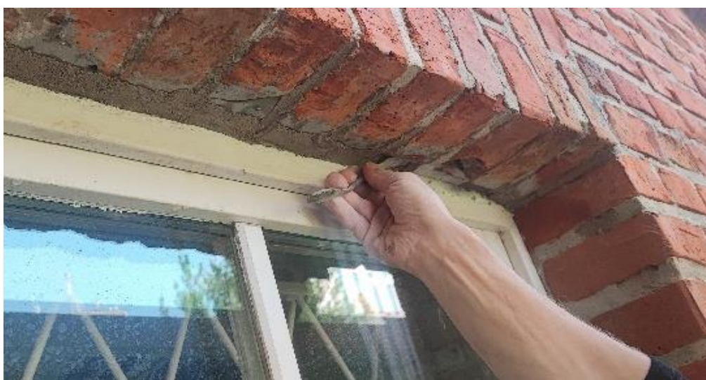
Ilustracja 57. Uzupełnianie ubytków zaprawy w spoinach
