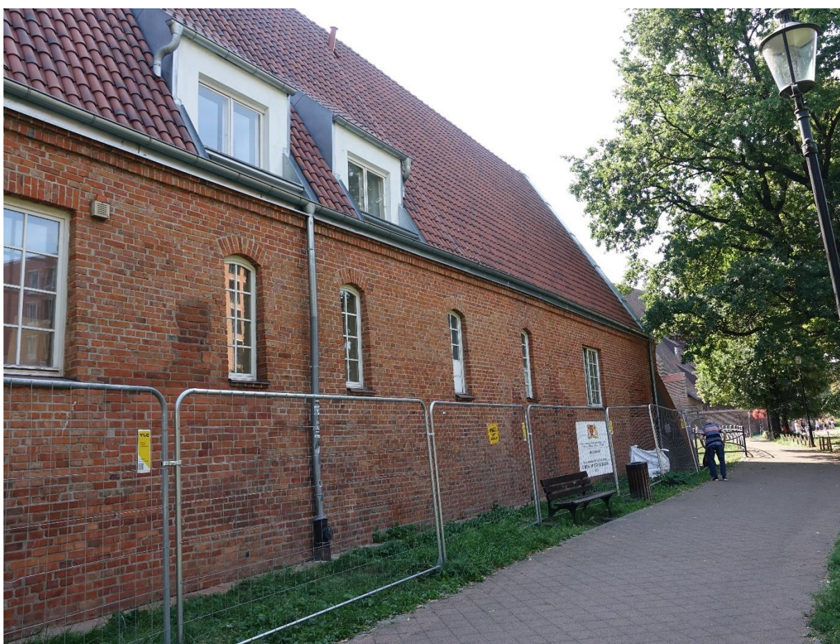
Ilustracja 72. Zachodnia część elewacji północnej
