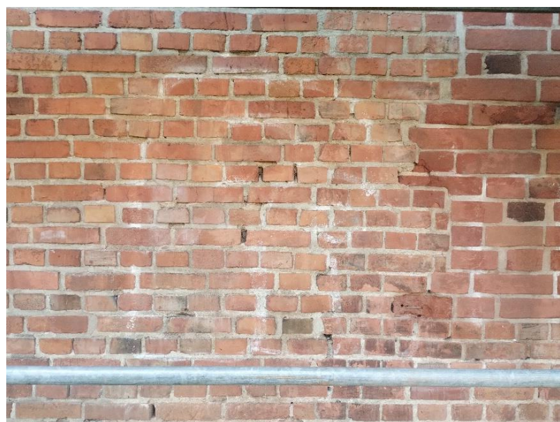
Ilustracje 40-42. W trakcie usuwania wtórnych nawarstwień (graffiti) – kolejne etapy prac
