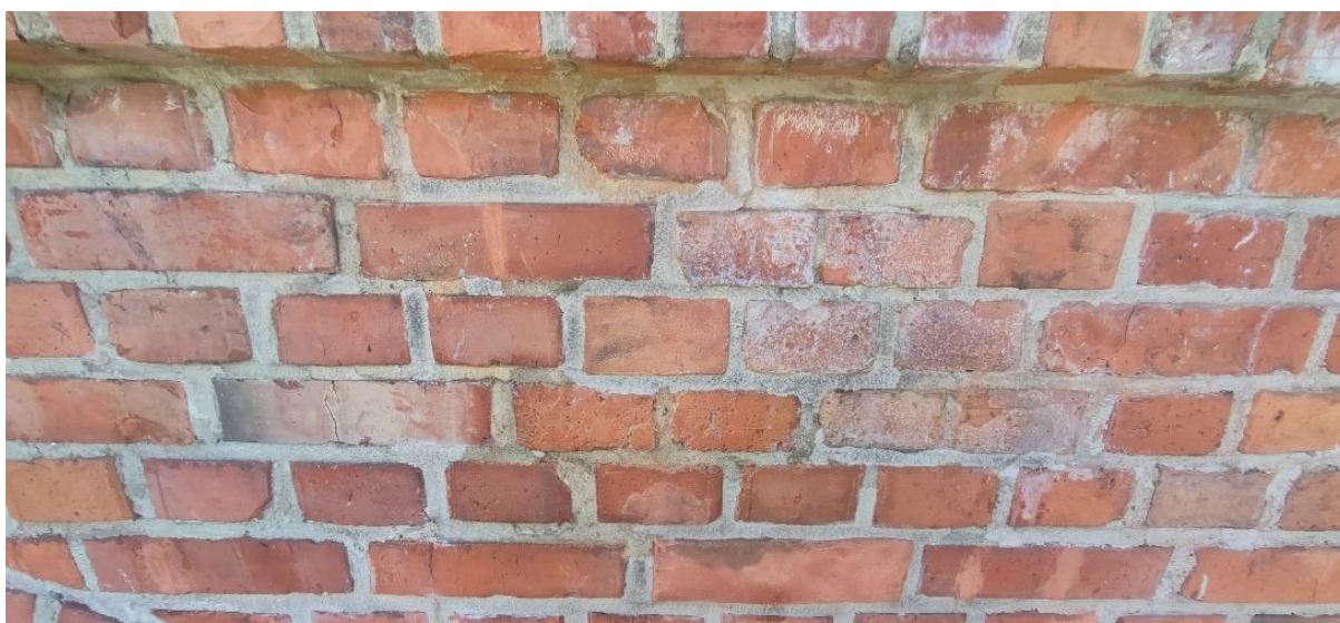
Ilustracje 62-63. Scalanie kolorystyczne uzupełnionych spoin: przed i po
