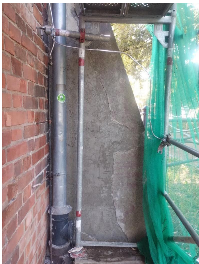
Ilustracja 36. Prace murarsko-tynkarskie w obrębie przypory
