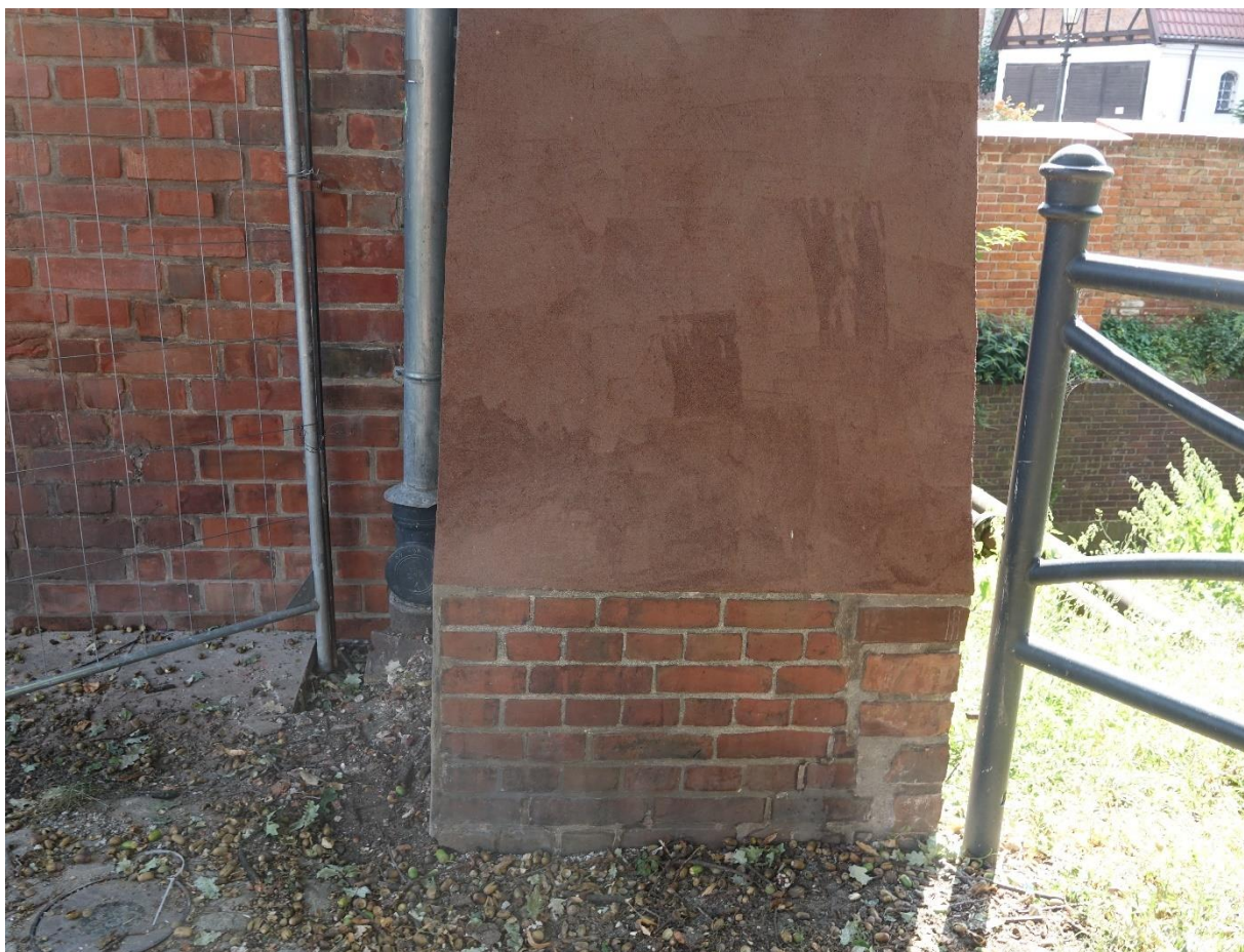
Ilustracja 77. Przypora po pracach konserwatorskich
