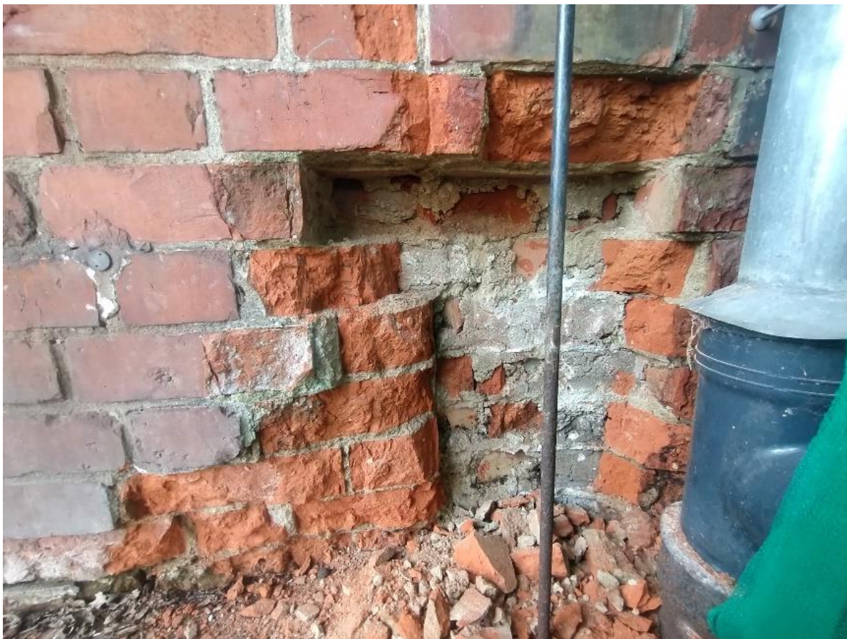
Ilustracja 25. Przygotowanie do prac murarskich
