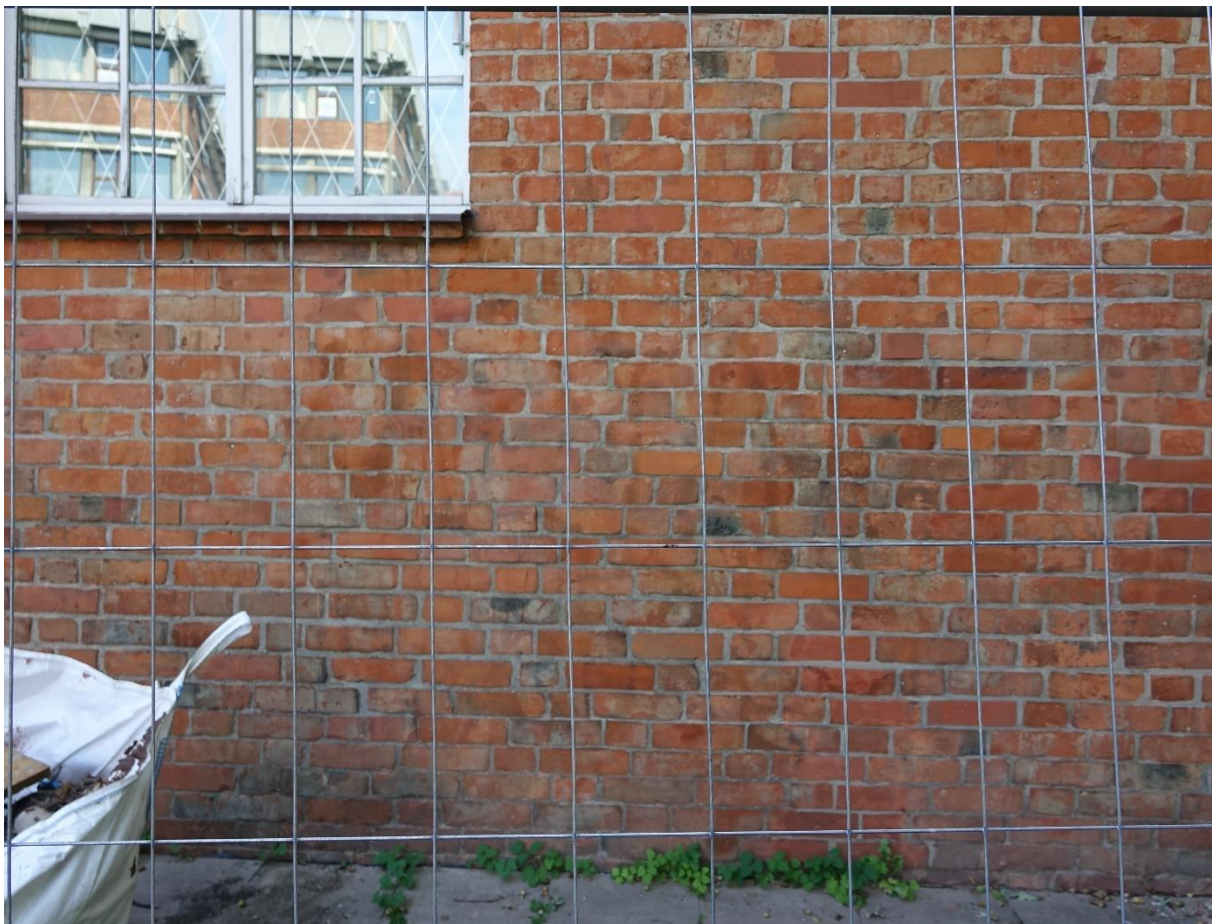
Ilustracja 73. Elewacja po pracach konserwatorskich
