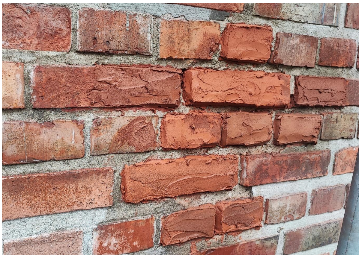
Ilustracja 50. Uzupełnianie ubytków w cegle
