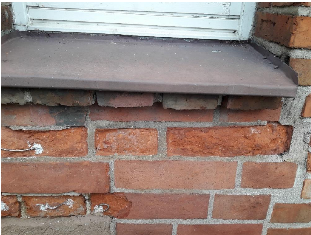
Ilustracja 51. Montaż zbrojeń pod uzupełnianie ubytków
