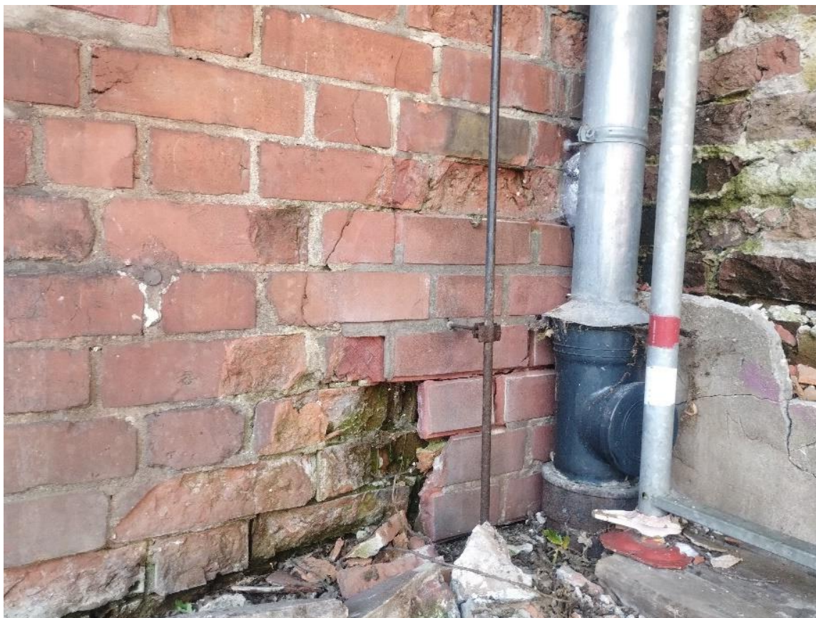
Ilustracja 19. Demontaż luźnych elementów
