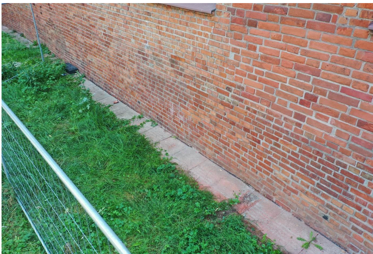
Ilustracja 82. Elewacja w strefie przyziemia po pracach konserwatorskich
