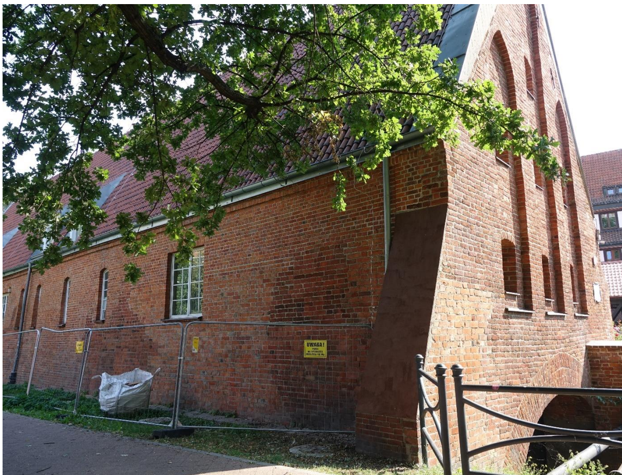
Ilustracja 71. Zachodnia część elewacji północnej
