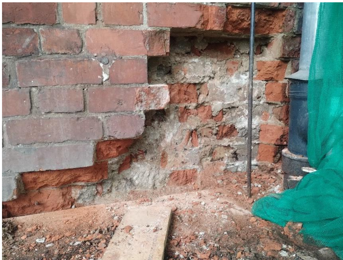
Ilustracja 26. Przygotowanie do prac murarskich
