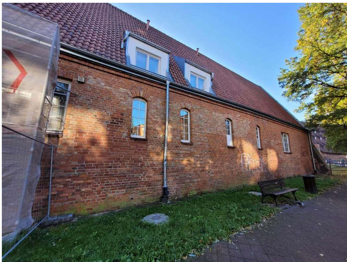
Ilustracja 8. Zachodnia część elewacji północnej
