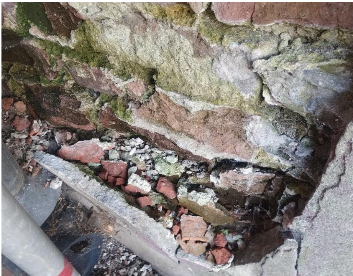
Ilustracja 21. Demontaż luźnych elementów
