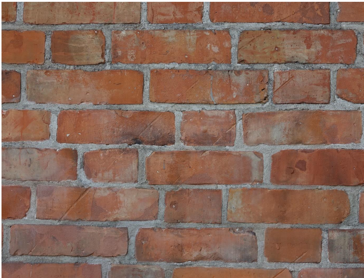
Ilustracja 75. Elewacja po pracach konserwatorskich
