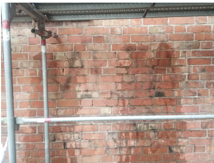
Ilustracje 43-45. W trakcie usuwania wtórnych nawarstwień (graffiti) – kolejne etapy prac
