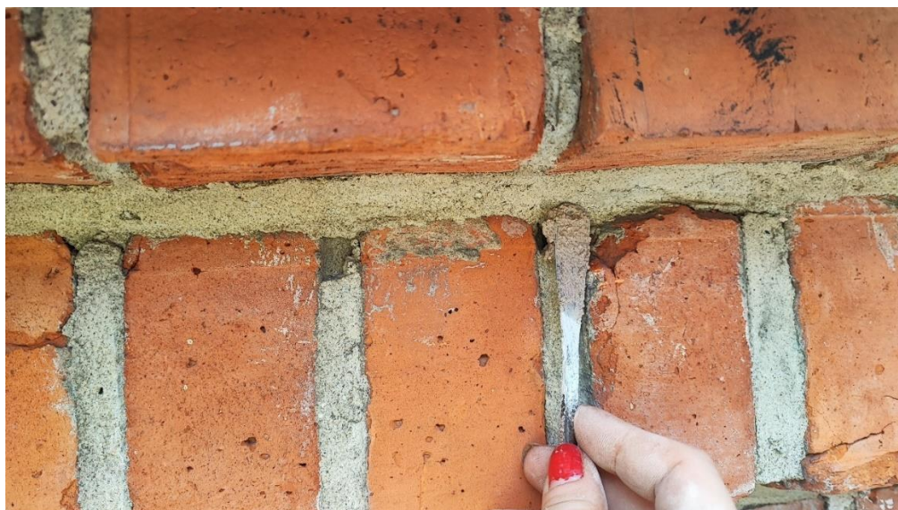
Ilustracja 56. Uzupełnianie ubytków zaprawy w spoinach
