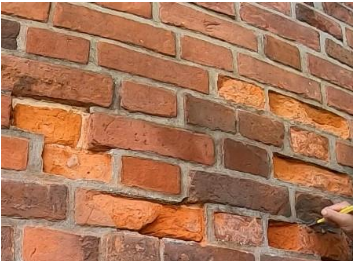
Ilustracja 24. Demontaż luźnych elementów
