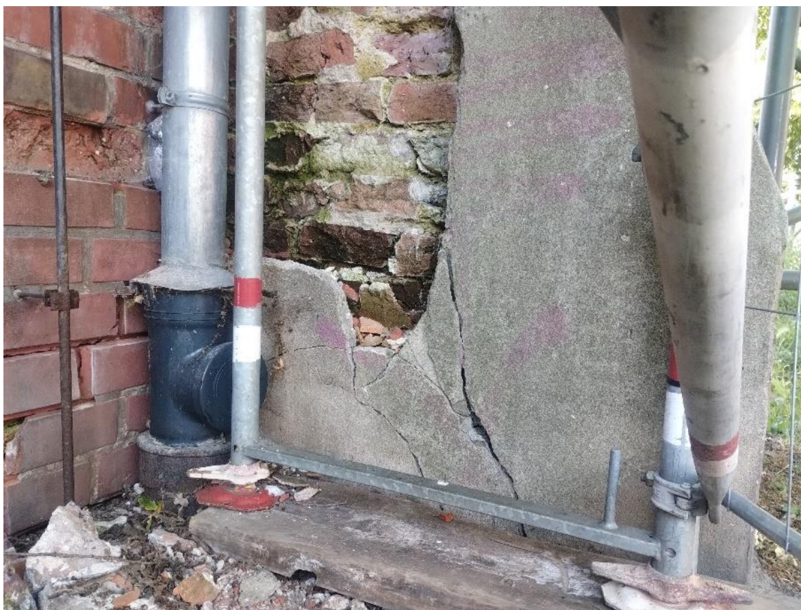
Ilustracja 20. Demontaż luźnych elementów
