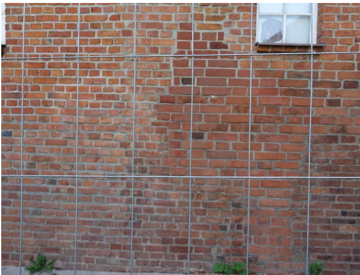
Ilustracja 74. Elewacja po pracach konserwatorskich
