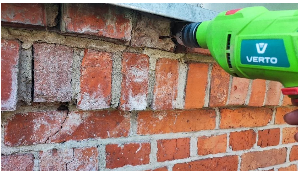
Ilustracja 39. Nawiercanie otworów pod montaż zbrojeń
