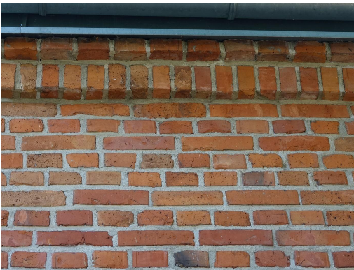
Ilustracja 78. Elewacja po pracach konserwatorskich
