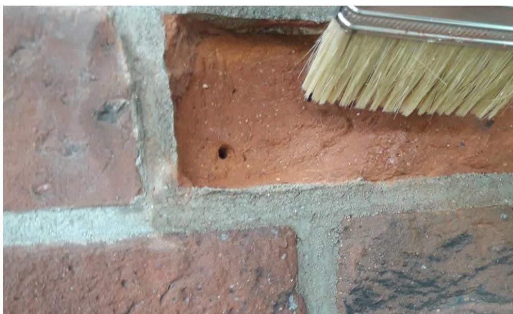
Ilustracja 38. Wzmacnianie strukturalne cegieł
