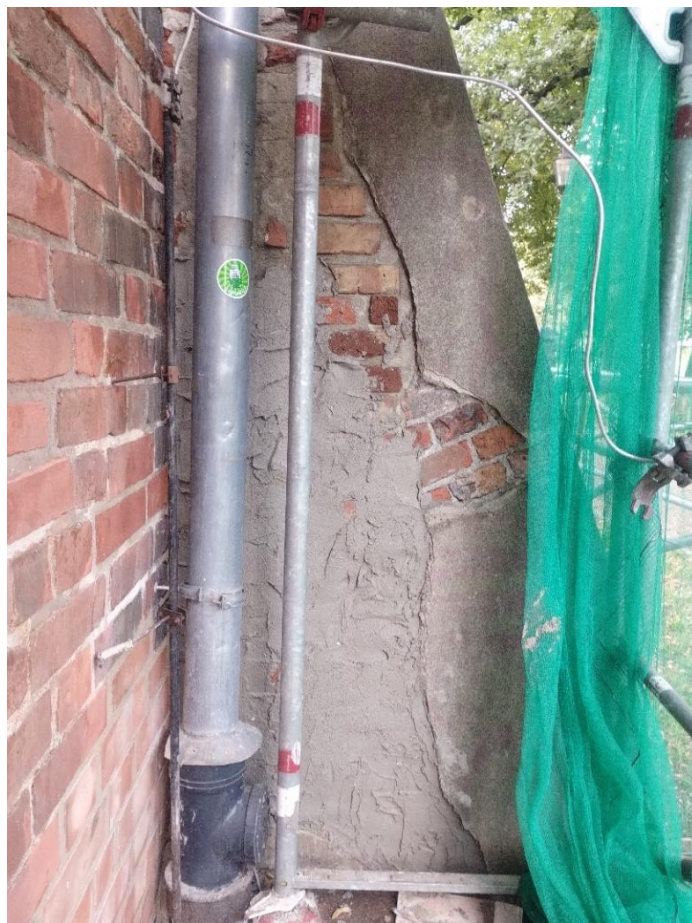
Ilustracja 34. Prace murarsko-tynkarskie w obrębie przypory
