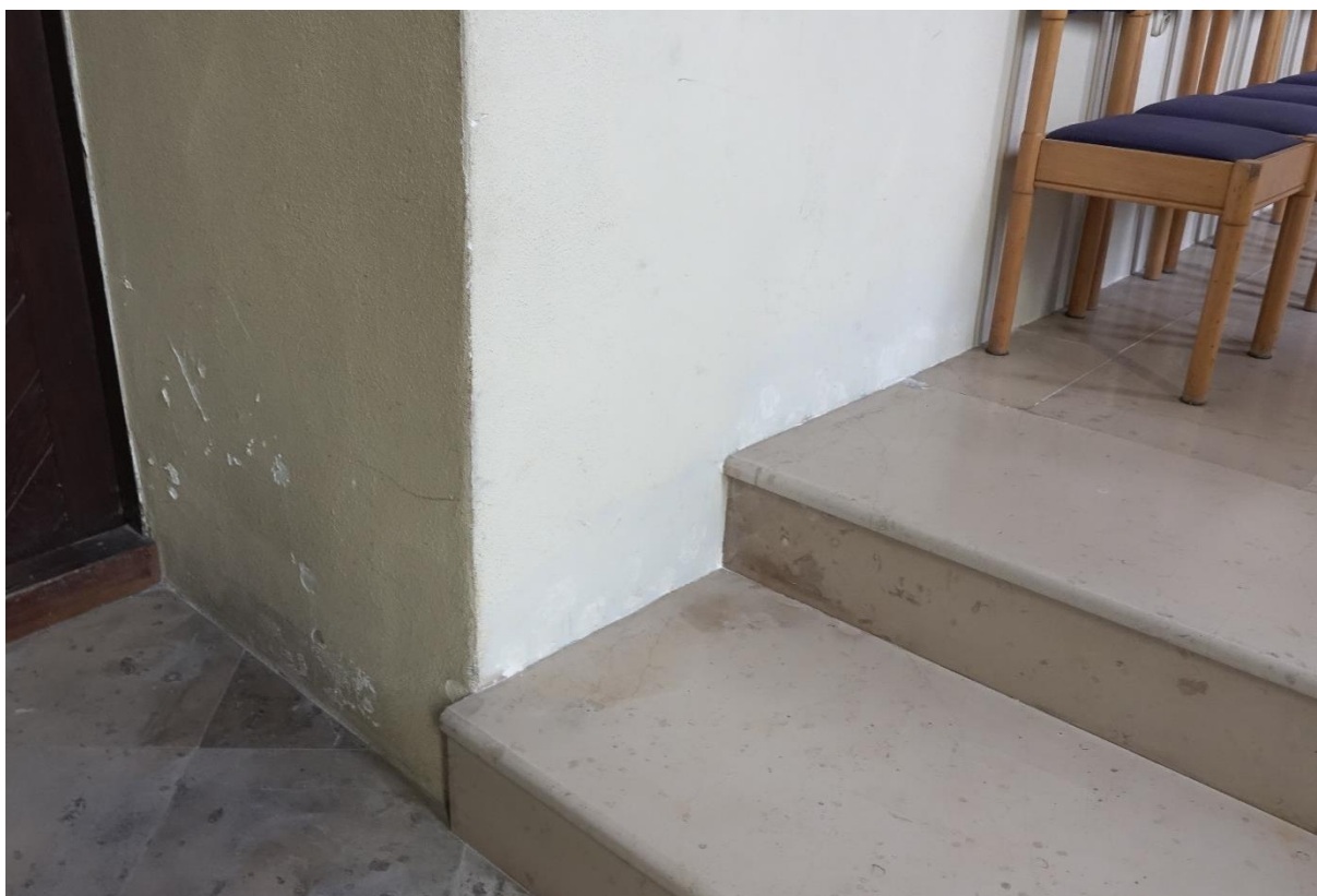
Ilustracja 64. Po zakończeniu prac
