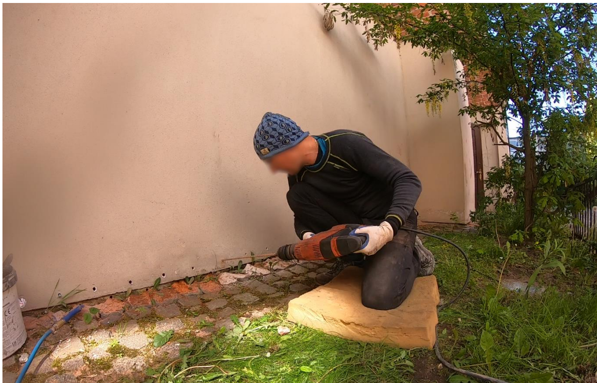
Ilustracja 21. Poglębianie otworów pod iniektory
