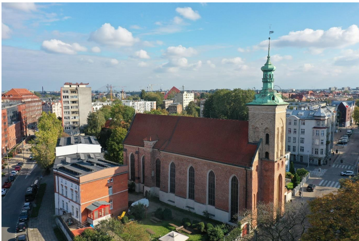
Ilustracja 44. Widok ogólny po zakończeniu prac
