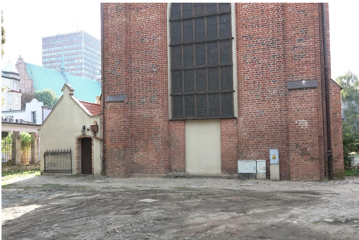
Ilustracja 53. Po zakończeniu prac
