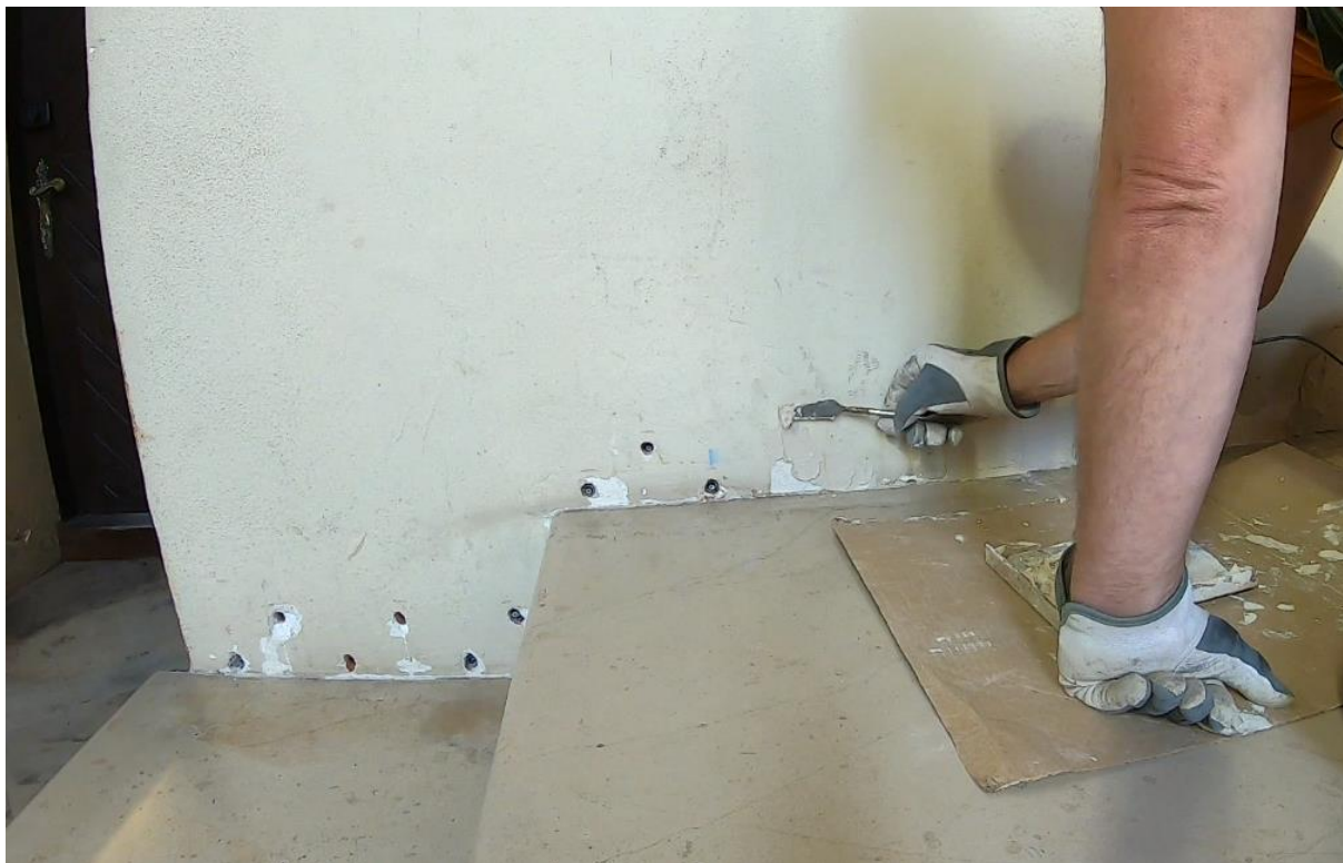
Ilustracja 37. Zabezpieczanie otworów zaprawą
