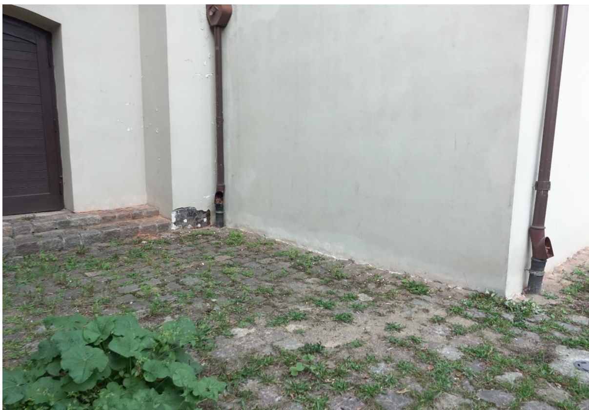
Ilustracja 45. Po zakończeniu prac
