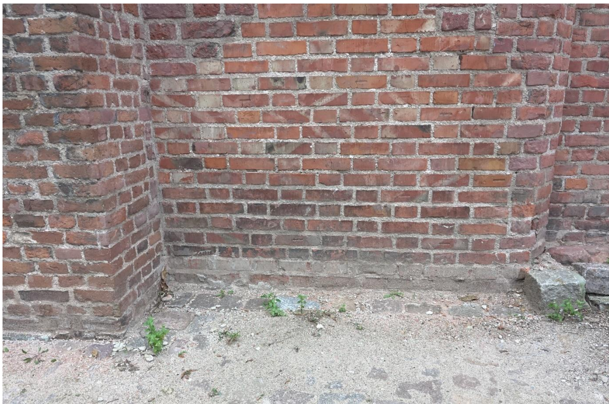
Ilustracja 51. Po zakończeniu prac
