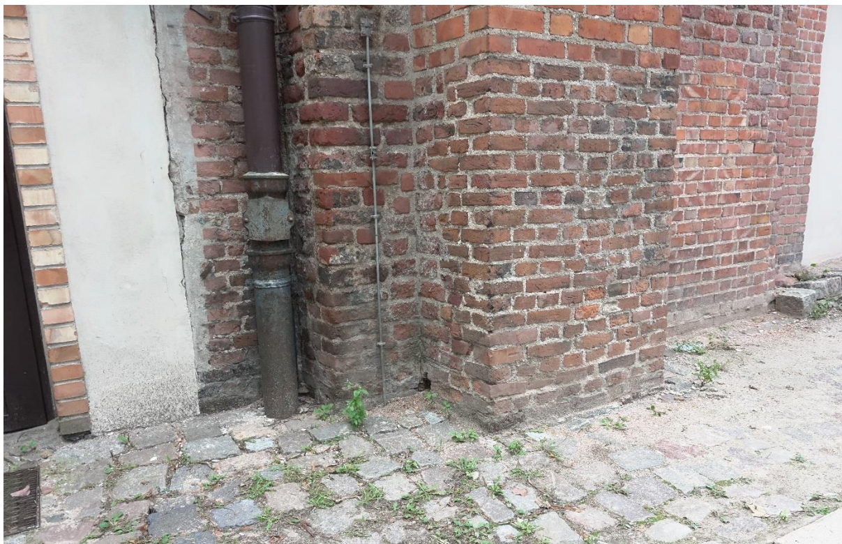
Ilustracja 50. Po zakończeniu prac
