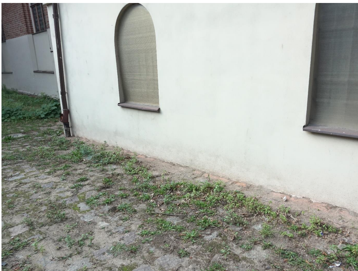
Ilustracja 46. Po zakończeniu prac
