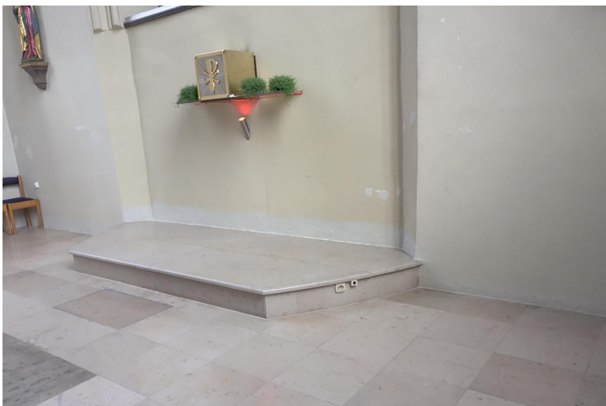
Ilustracja 60. Po zakończeniu prac
