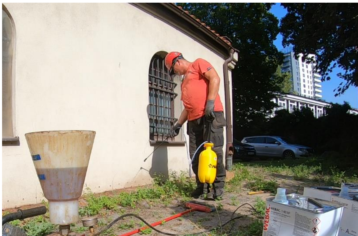
Ilustracja 30. Zwilżanie otworów przed wprowadzeniem materiału iniekcyjnego
