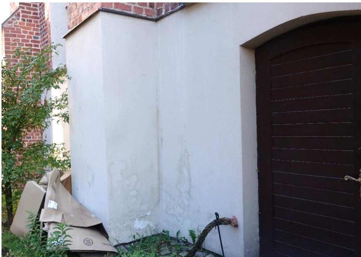
Ilustracja 11. Skutki zawilgocenia
