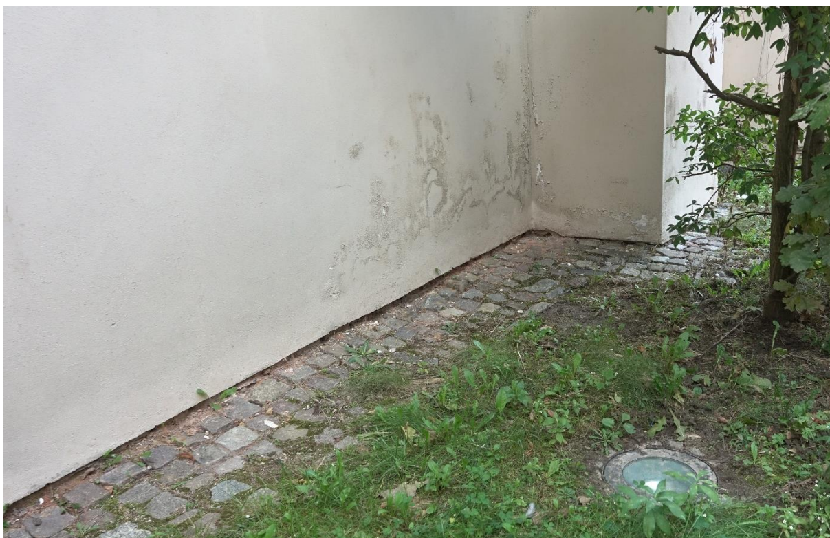
Ilustracja 54. Po zakończeniu prac
