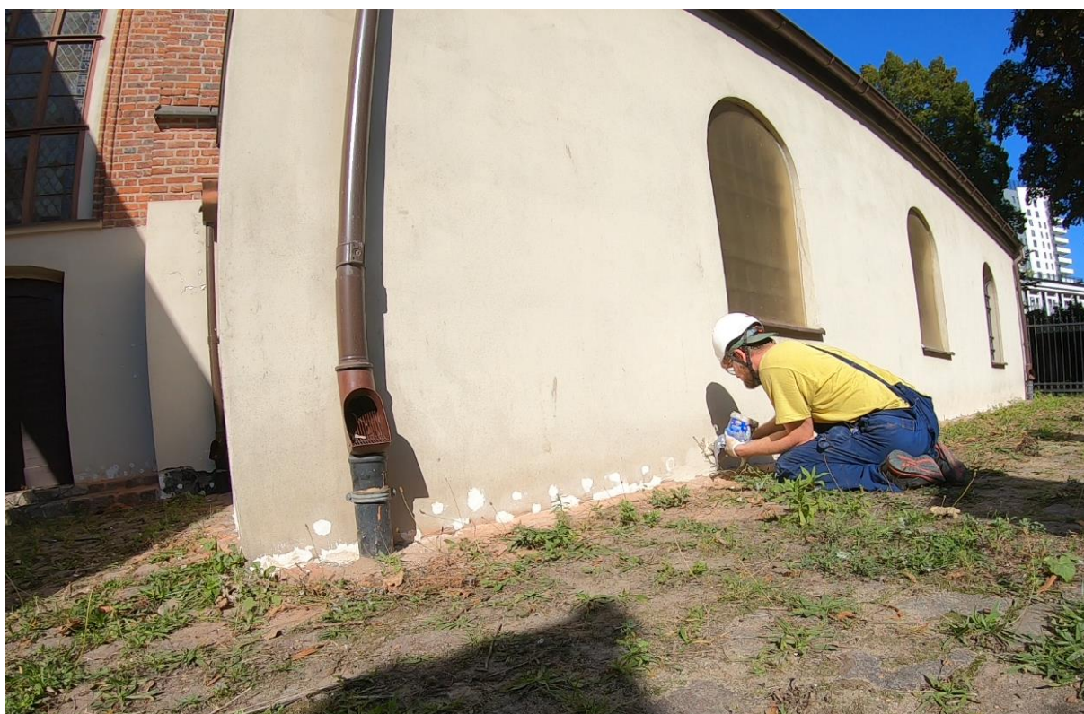
Ilustracja 42. Scalanie kolorystyczne po zasklepieniu otworów
