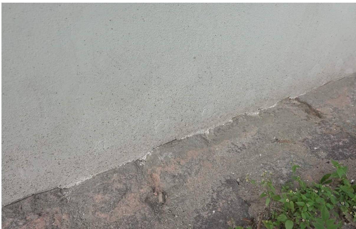
Ilustracja 48. Po zakończeniu prac
