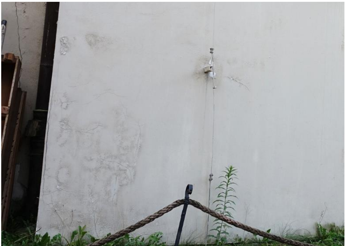
Ilustracja 10. Skutki zawilgocenia
