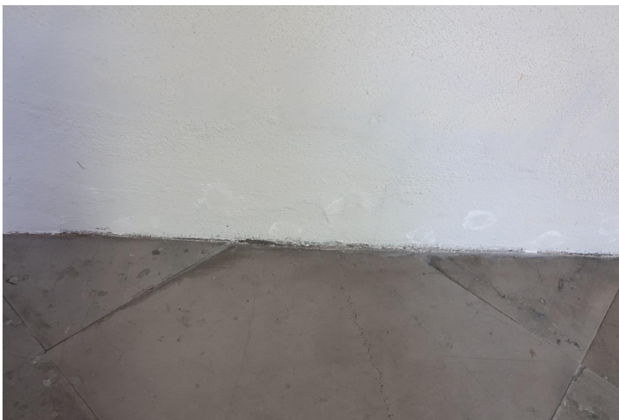
Ilustracja 58. Po zakończeniu prac
