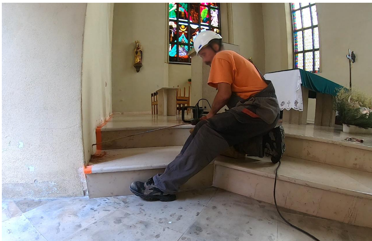
Ilustracja 22. Poglębianie otworów pod iniektory
