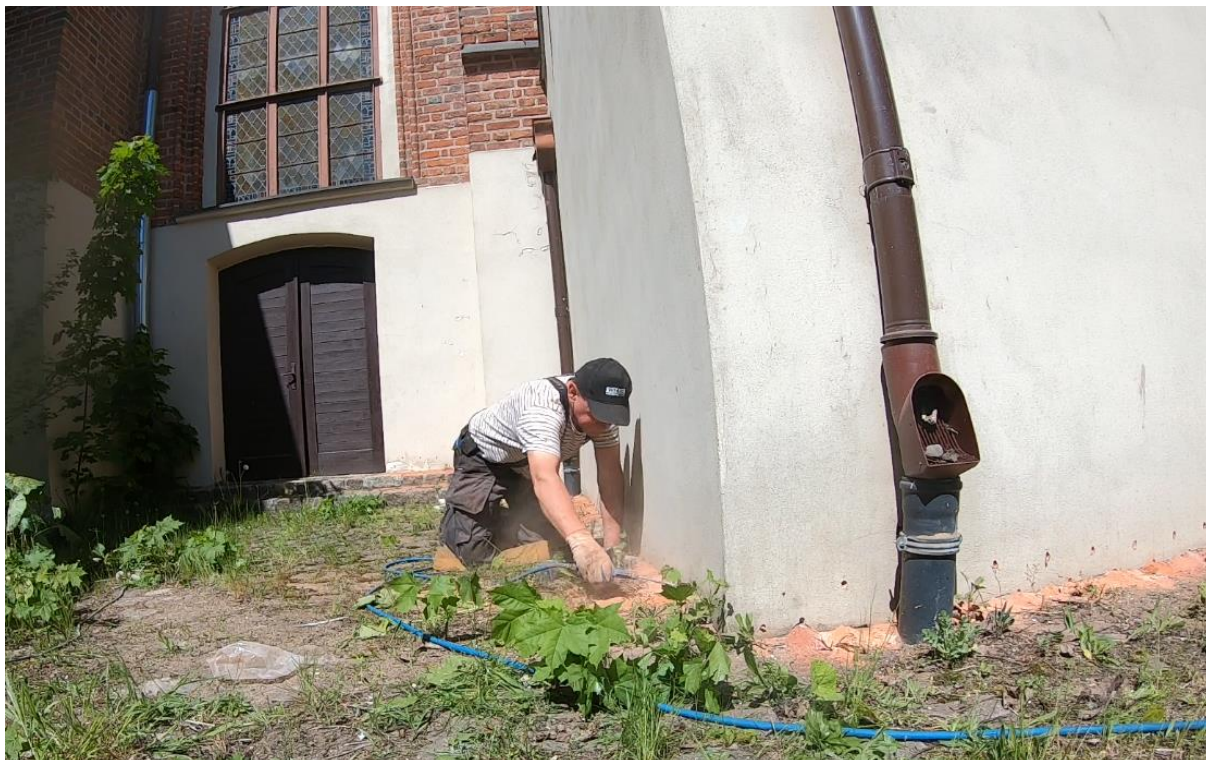
Ilustracja 23. Oczyszczanie otworów z materiałów luźnych
