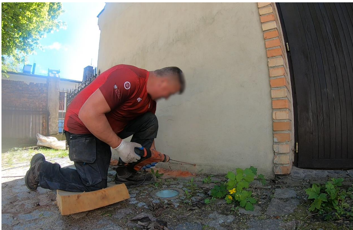
Ilustracja 17. Wykonywanie odwiertów pod iniektory
