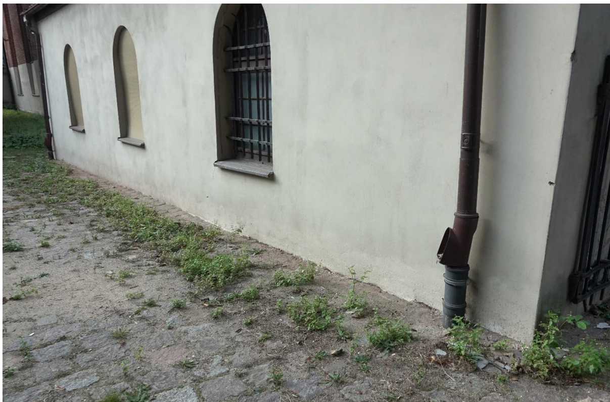
Ilustracja 47. Po zakończeniu prac
