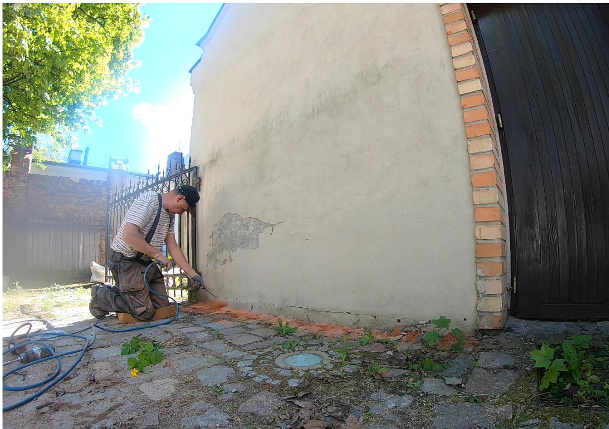
Ilustracja 25. Oczyszczanie otworów z materiałów luźnych
