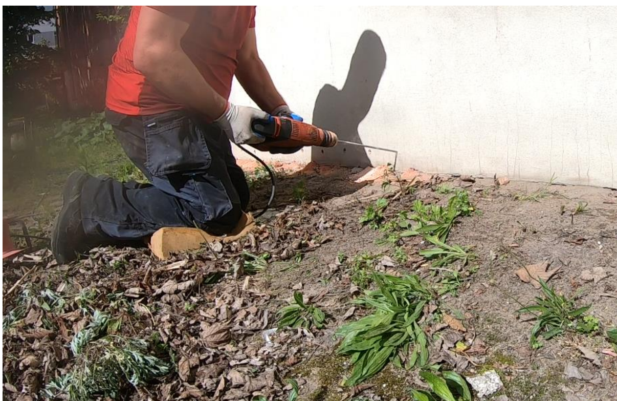
Ilustracja 16. Wykonywanie odwiertów pod iniektory
