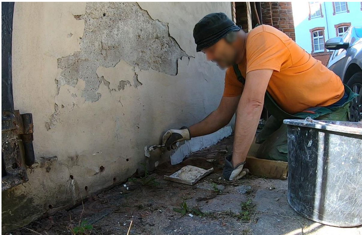
Ilustracja 39. Zabezpieczanie otworów zaprawą
