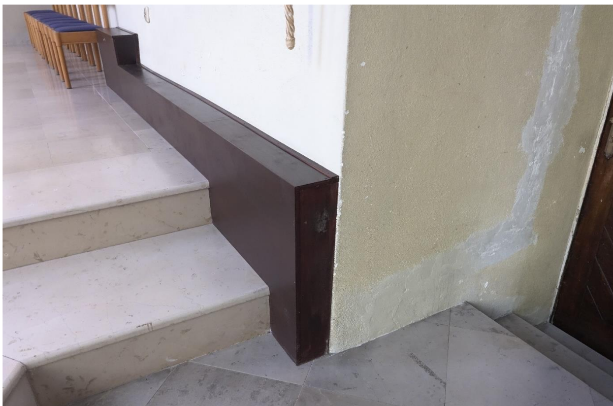
Ilustracja 59. Po zakończeniu prac
