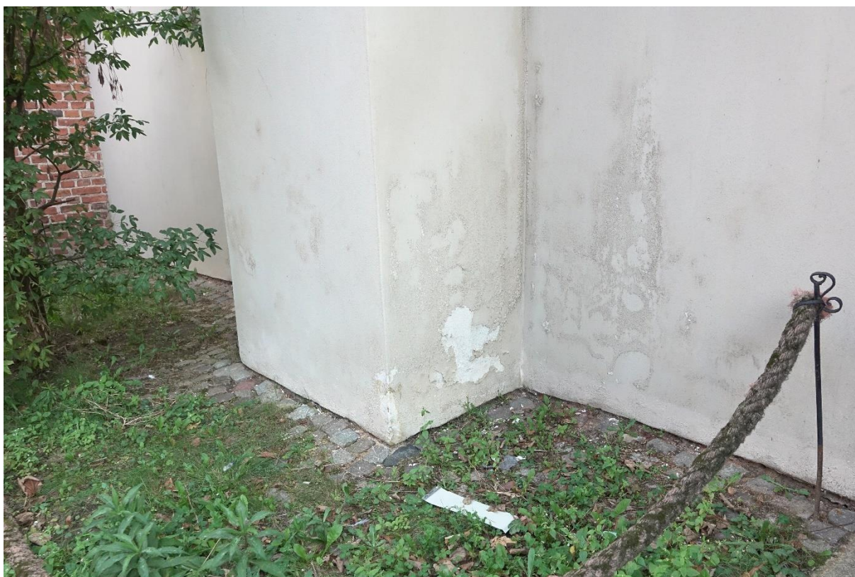
Ilustracja 56. Po zakończeniu prac
