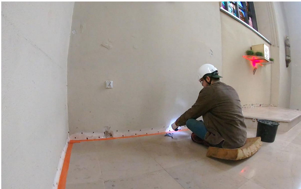
Ilustracja 29. Osadzanie iniektorów w odwiertach
