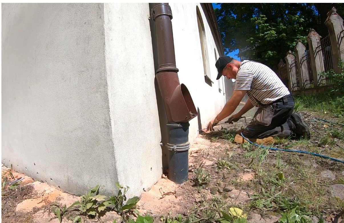
Ilustracja 24. Oczyszczanie otworów z materiałów luźnych
