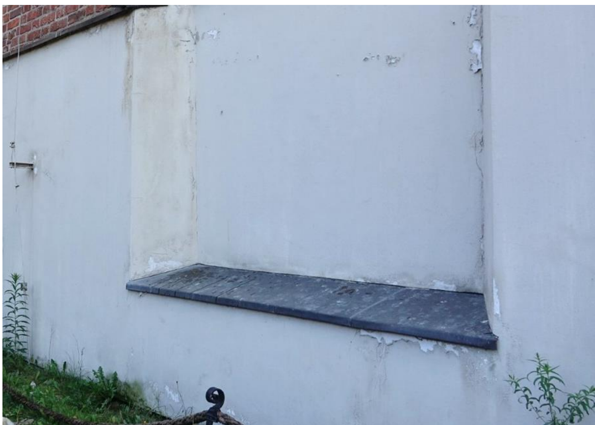
Ilustracja 12. Skutki zawilgocenia
