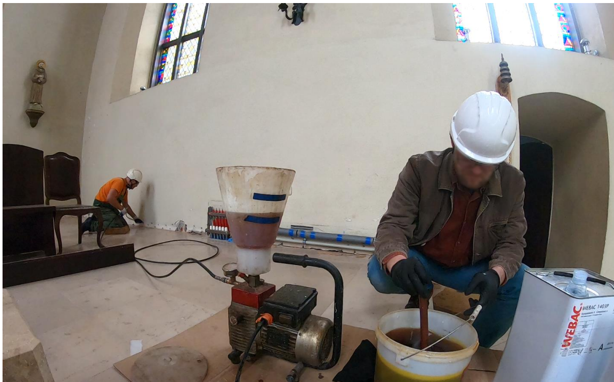
Ilustracja 31. Aplikacja środka iniekcyjnego
