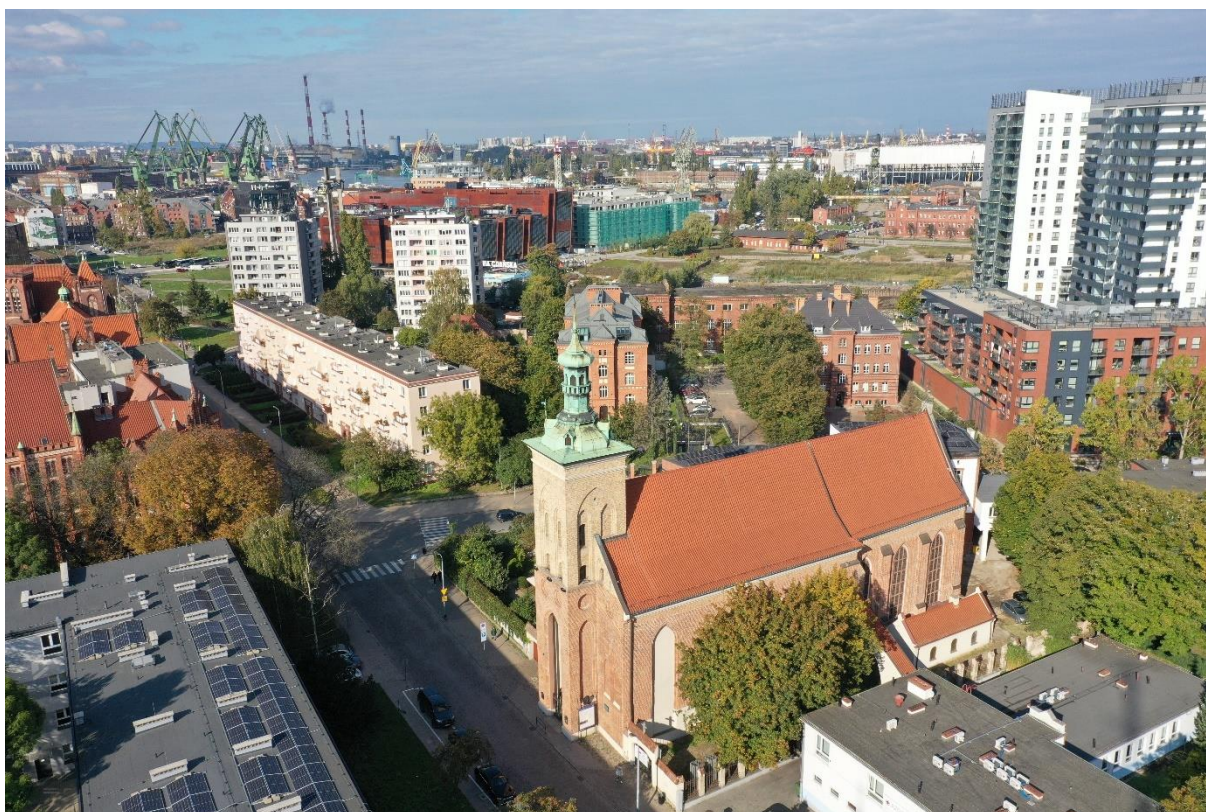
Ilustracja 43. Widok ogólny po zakończeniu prac
