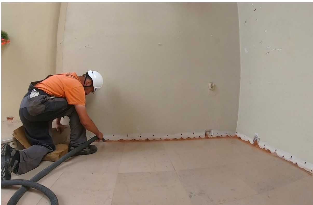
Ilustracja 26. Oczyszczanie otworów z materiałów luźnych
