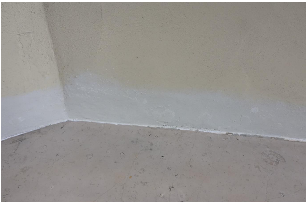
Ilustracja 62. Po zakończeniu prac
