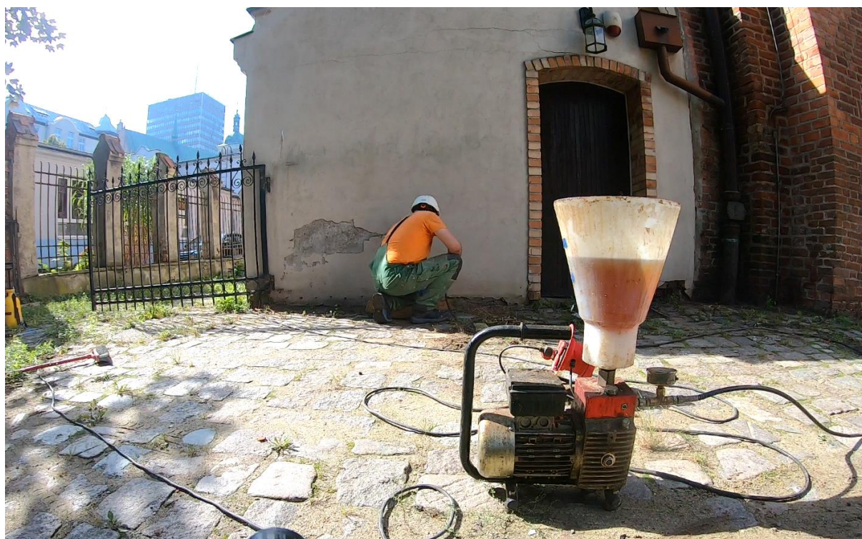
Ilustracja 34. Aplikacja środka iniekcyjnego
