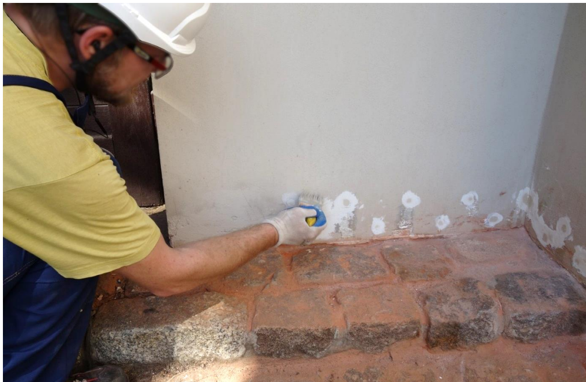
Ilustracja 41. Scalanie kolorystyczne po zasklepieniu otworów
