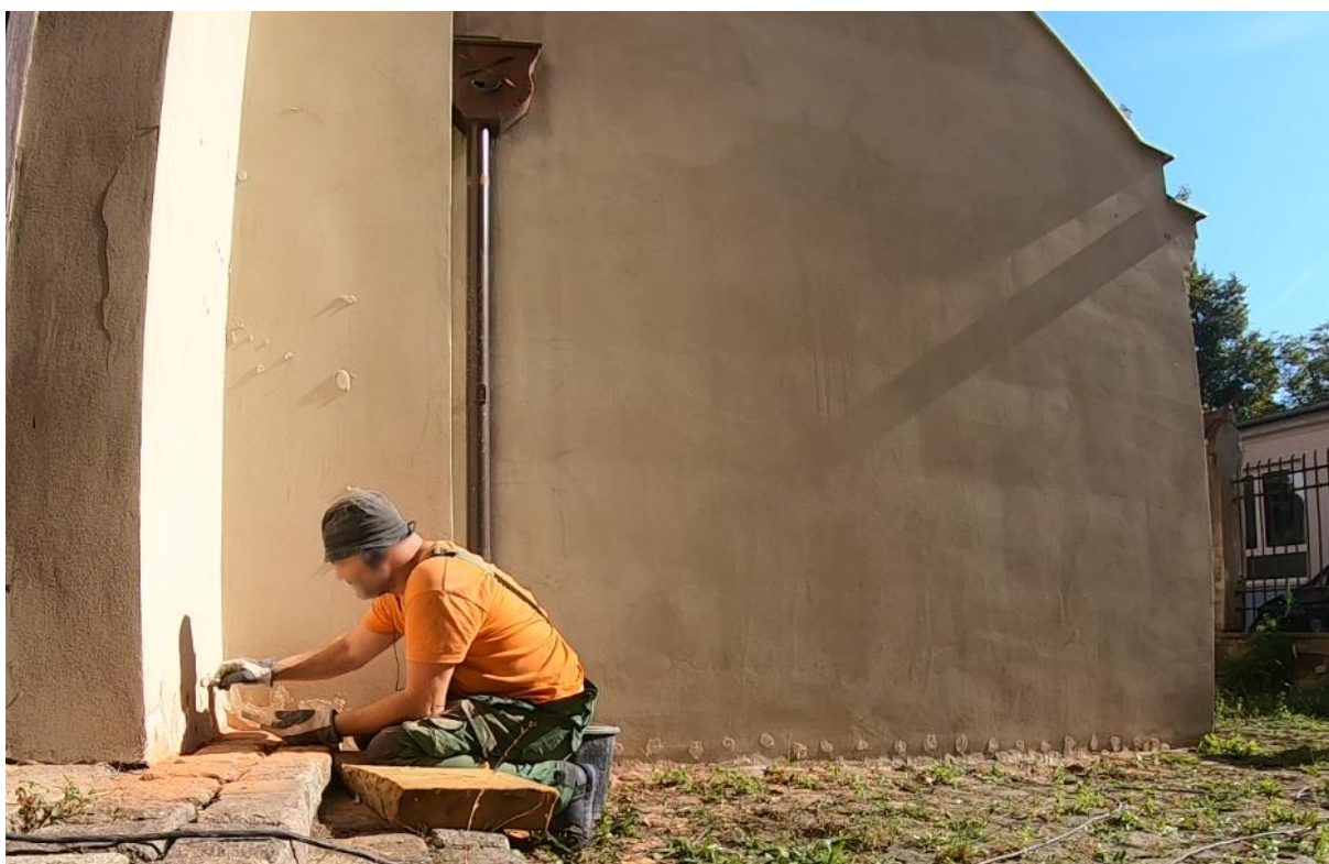
Ilustracja 38. Zabezpieczanie otworów zaprawą
