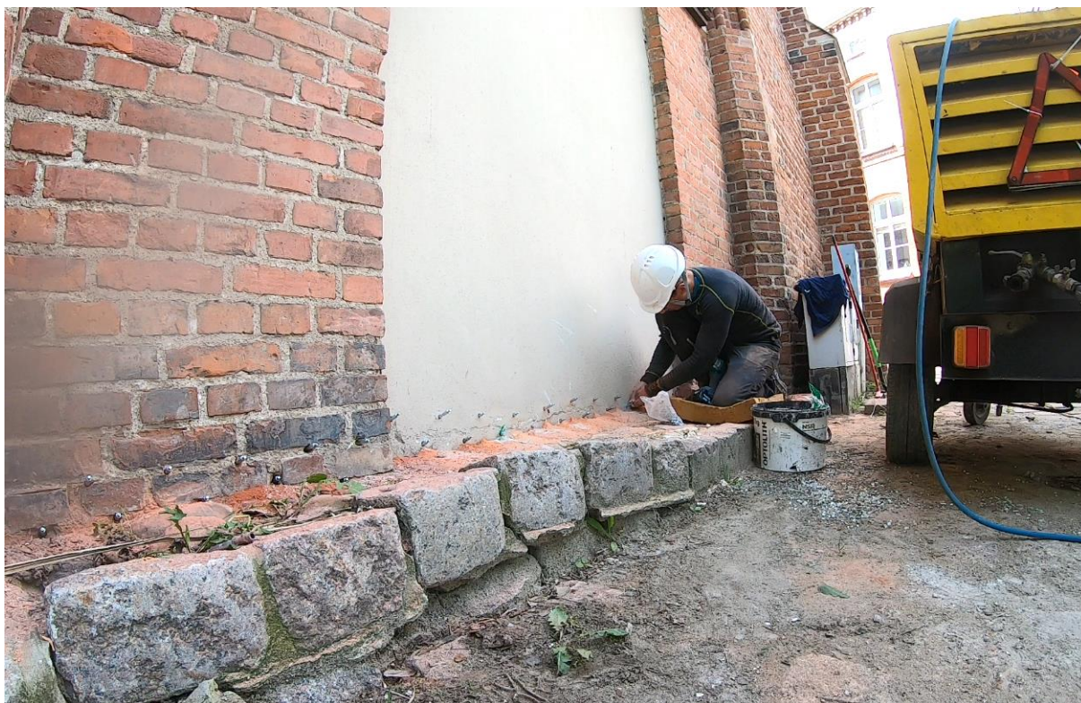
Ilustracja 27. Osadzanie iniektorów w odwiertach
