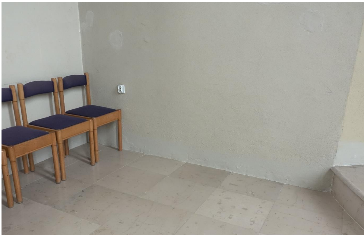
Ilustracja 63. Po zakończeniu prac
