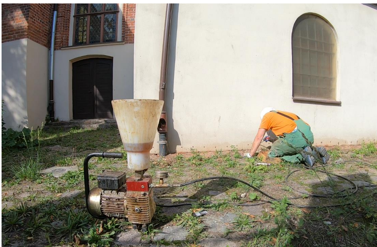
Ilustracja 32. Aplikacja środka iniekcyjnego
