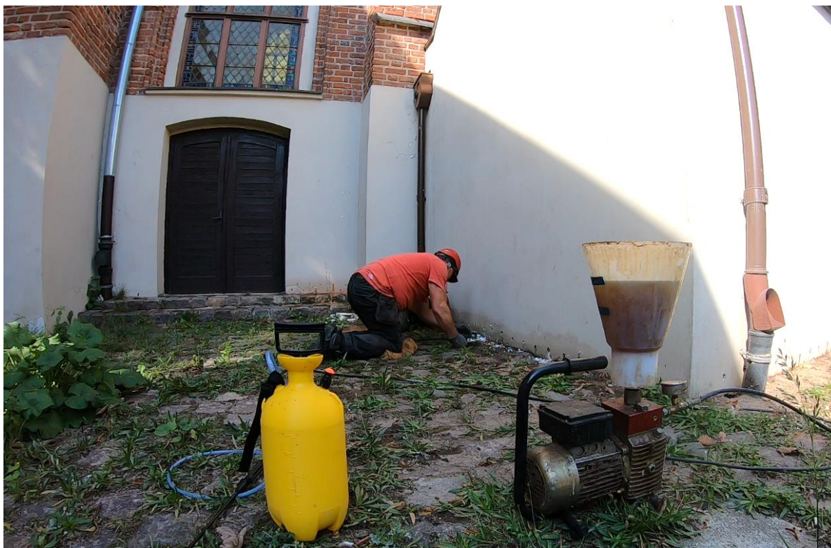
Ilustracja 33. Aplikacja środka iniekcyjnego
