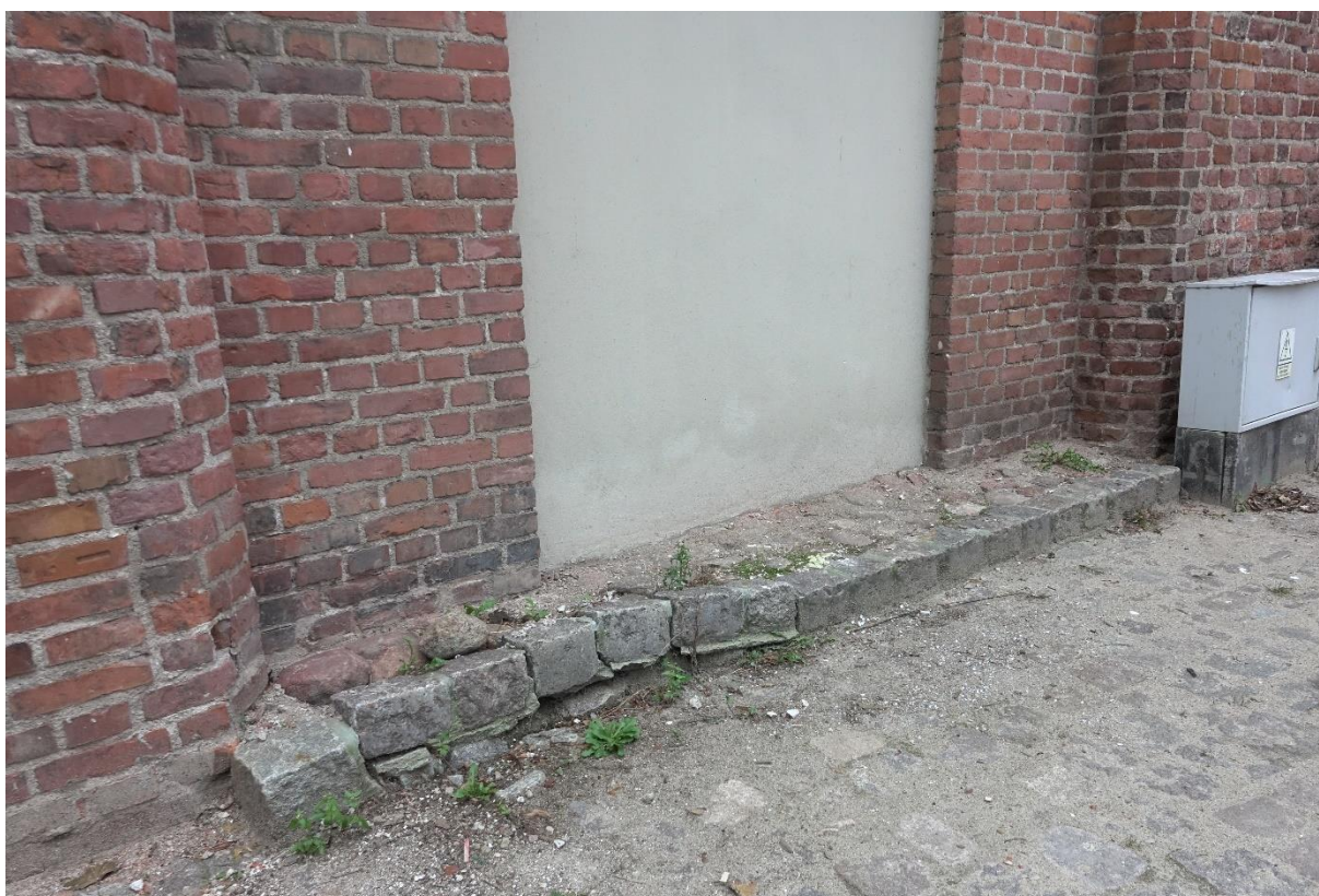
Ilustracja 52. Po zakończeniu prac
