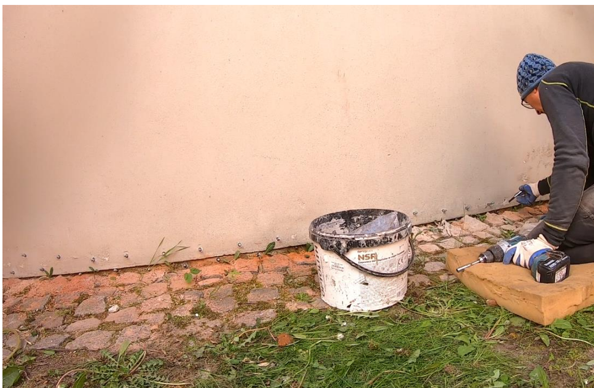
Ilustracja 28. Osadzanie iniektorów w odwiertach
