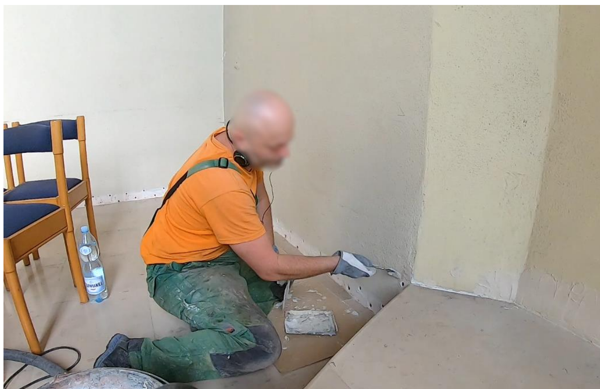
Ilustracja 36. Zabezpieczanie otworów zaprawą
