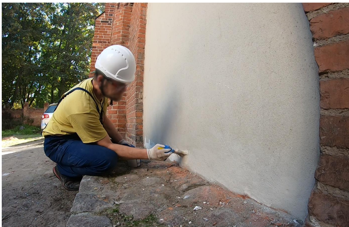
Ilustracja 40. Scalanie kolorystyczne po zasklepieniu otworów
