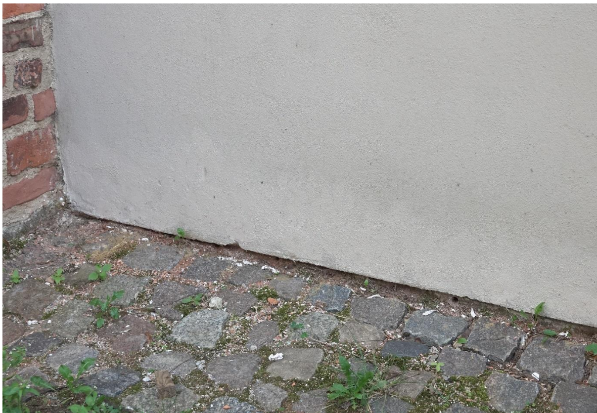
Ilustracja 55. Po zakończeniu prac
