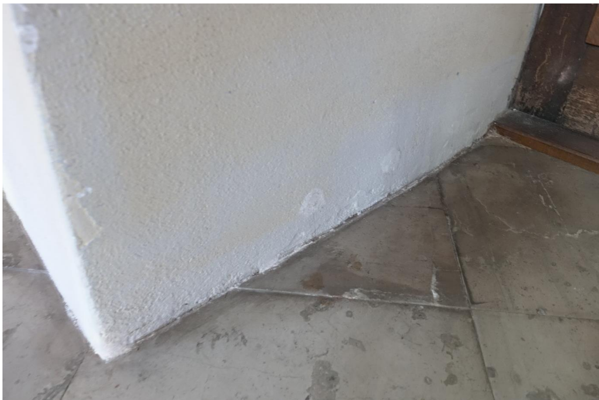
Ilustracja 57. Po zakończeniu prac
