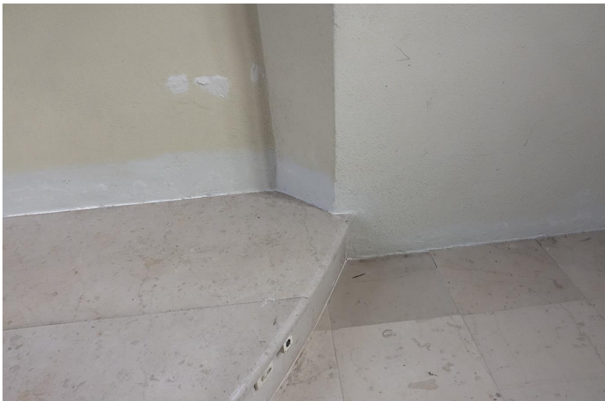
Ilustracja 61. Po zakończeniu prac
