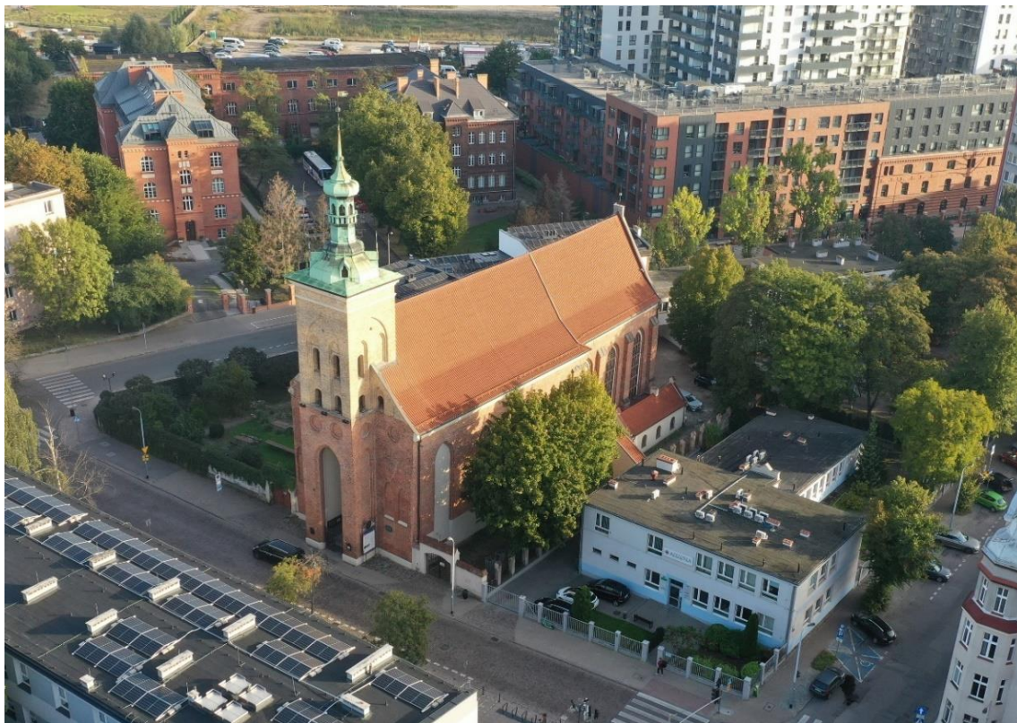
Ilustracja 7. Kościół pw. św. Jakuba. Widok ogólny od południowego zachodu
