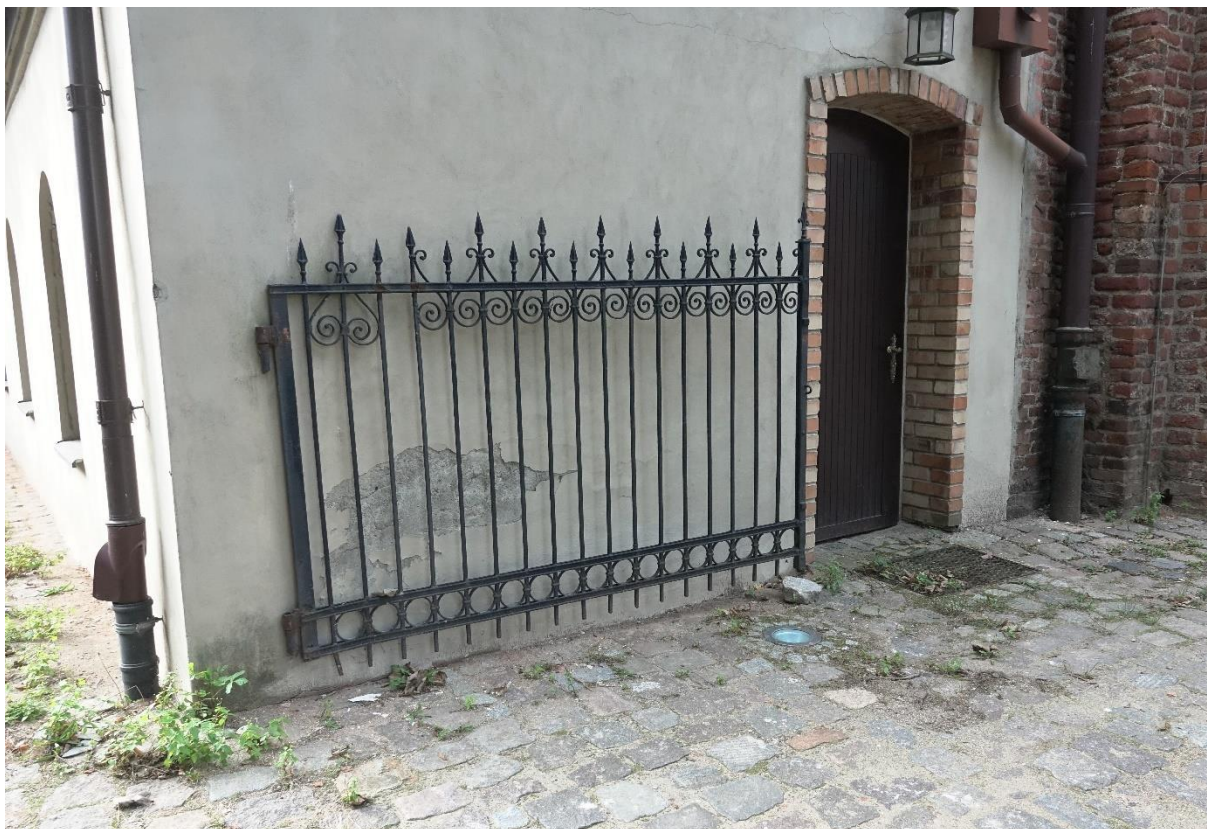
Ilustracja 49. Po zakończeniu prac
