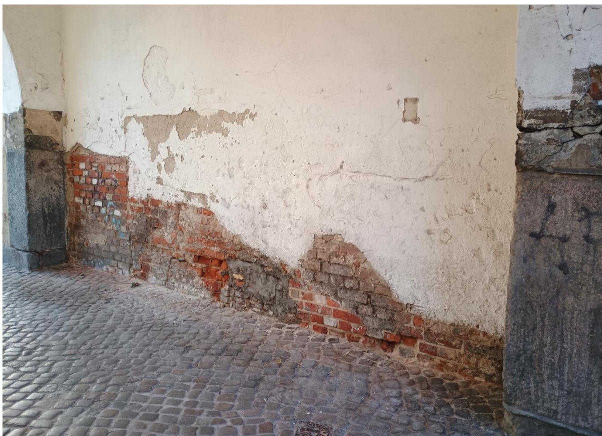
Ilustracja 52. Po zakończeniu prac
