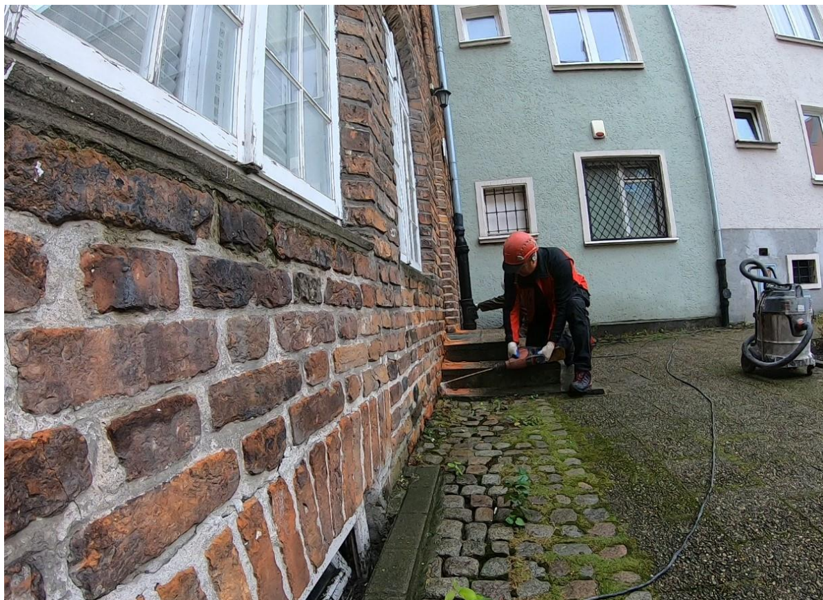
Ilustracja 23. Wykonywanie odwiertów pod iniektory
