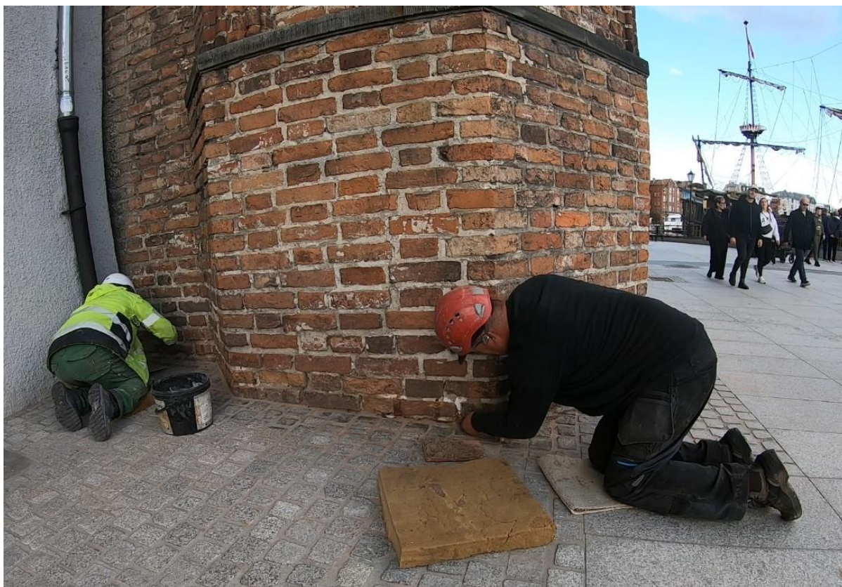
Ilustracja 45. Zabezpieczanie otworów zaprawą
