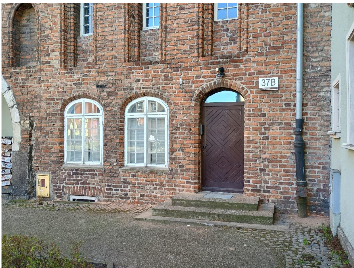
Ilustracja 48. Po zakończeniu prac
