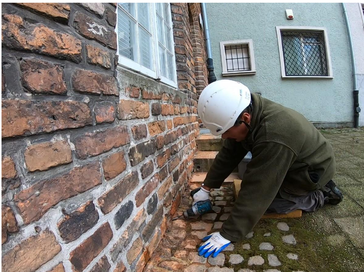
Ilustracja 38. Usuwanie iniektorów po aplikacji środka iniekcyjnego
