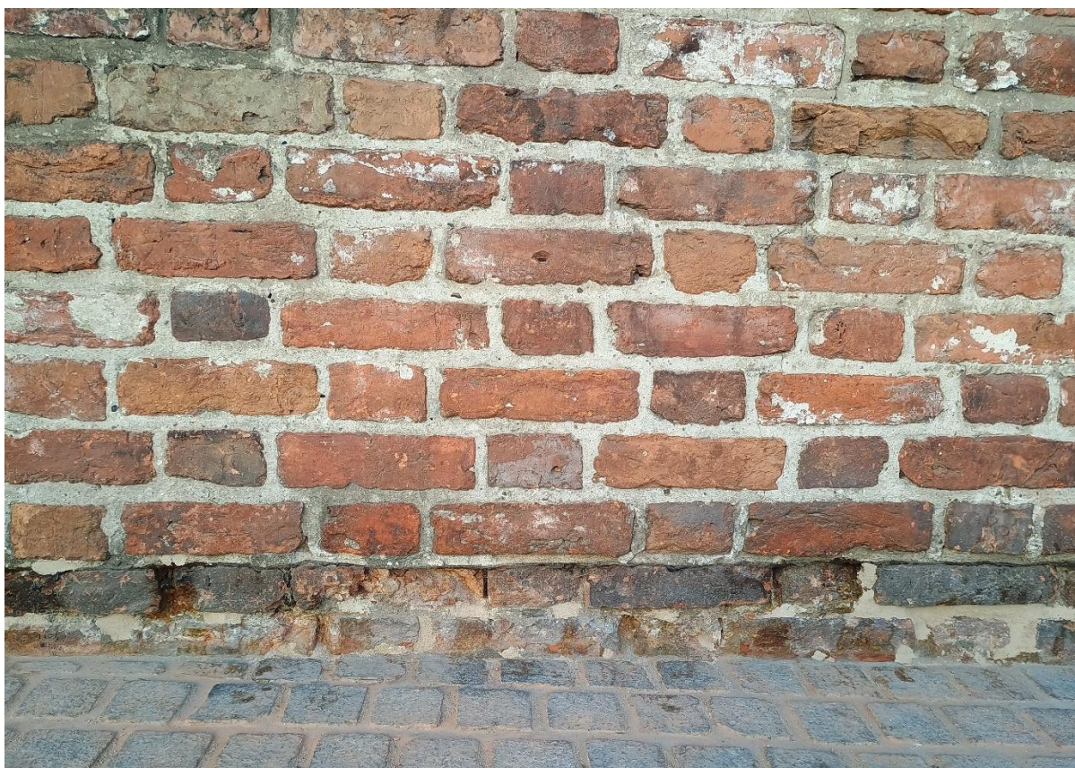
Ilustracja 55. Po zakończeniu prac
