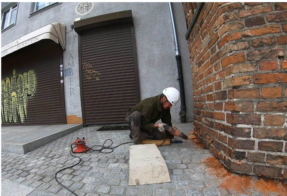
Ilustracja 29. Pogłębianie otworów przy użyciu dłuższego wiertła
