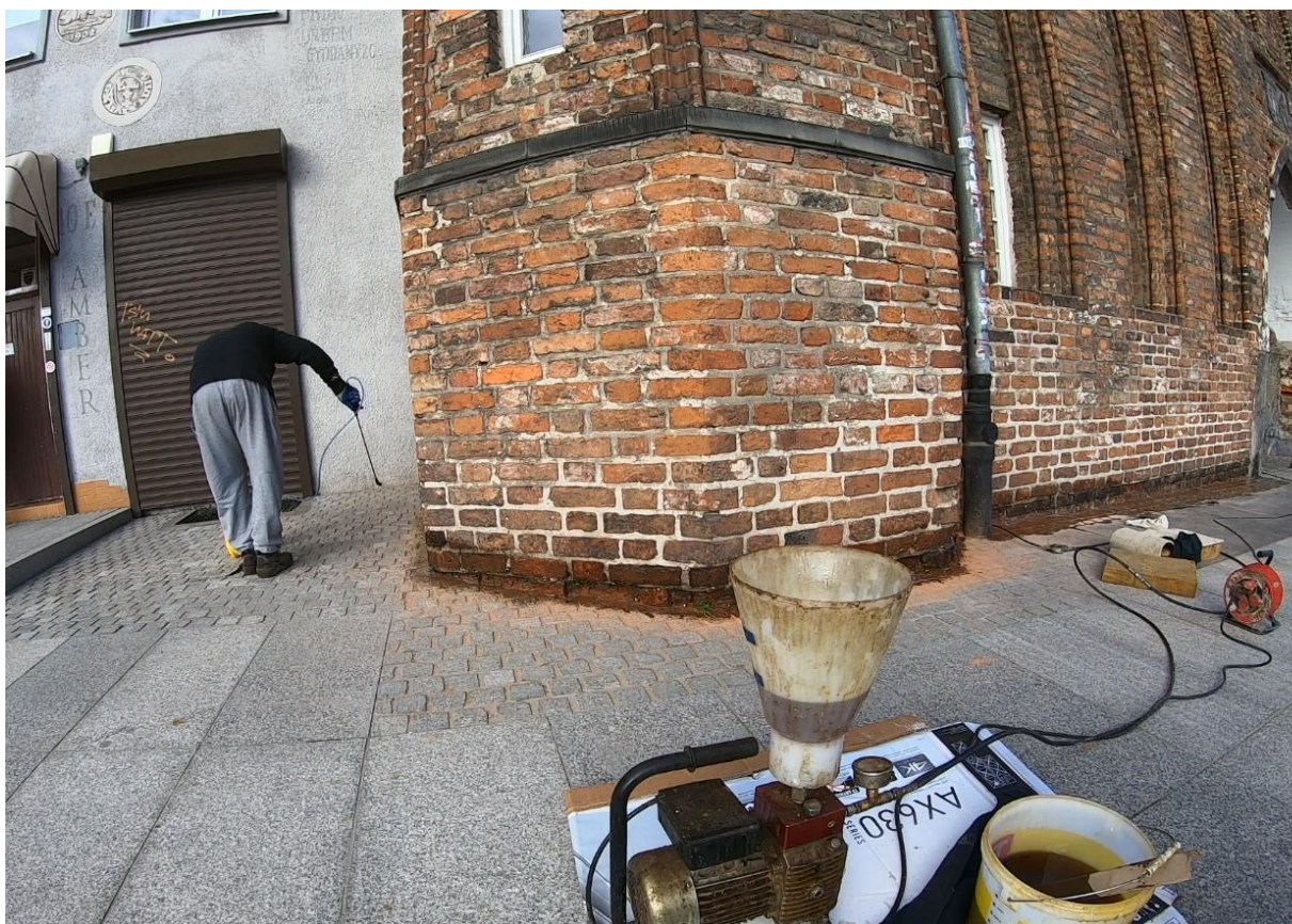
Ilustracja 32. Zwilżanie otworów przed wprowadzeniem mieszanki iniekcyjnej
