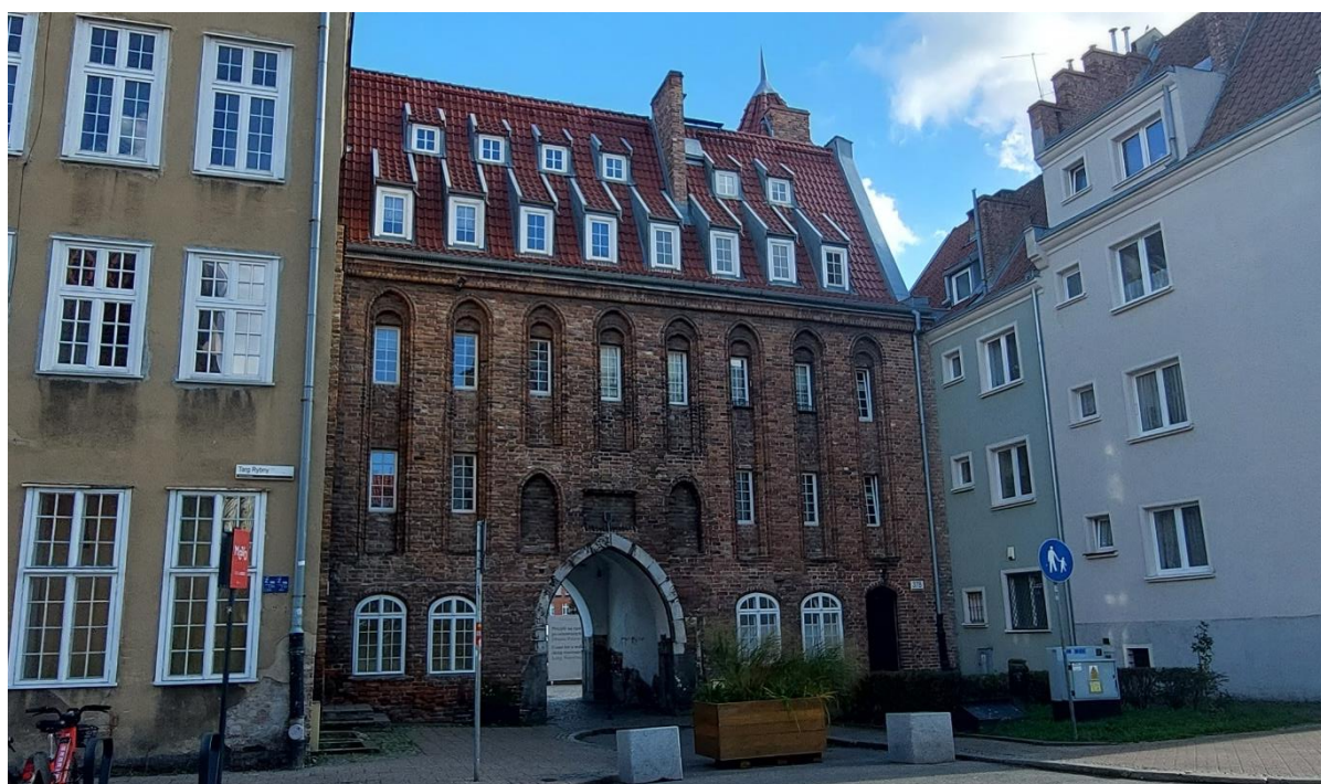
Ilustracja 13. Widok ogólny zabytku od zachodu
