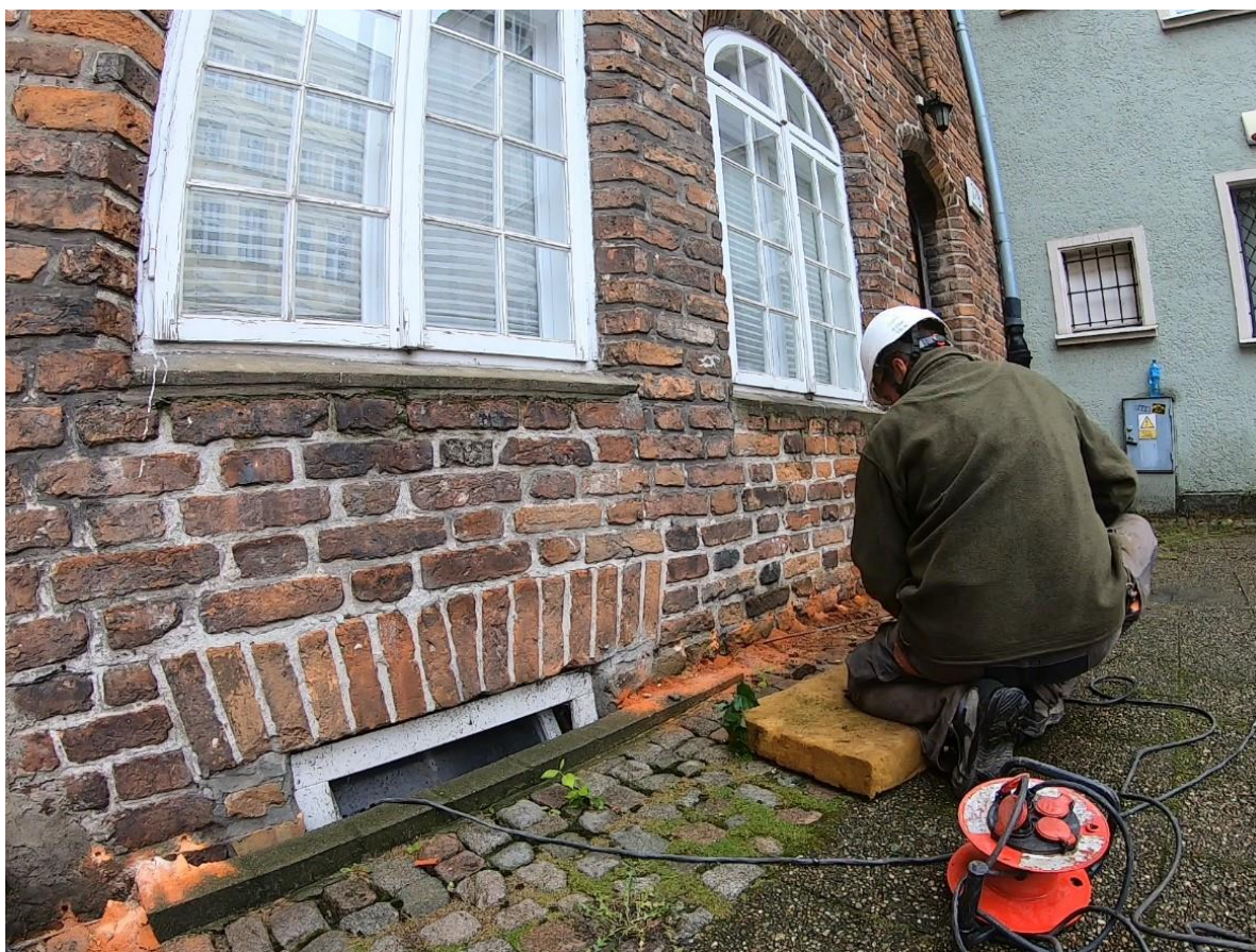
Ilustracja 24. Pogłębianie otworów przy użyciu dłuższego wiertła
