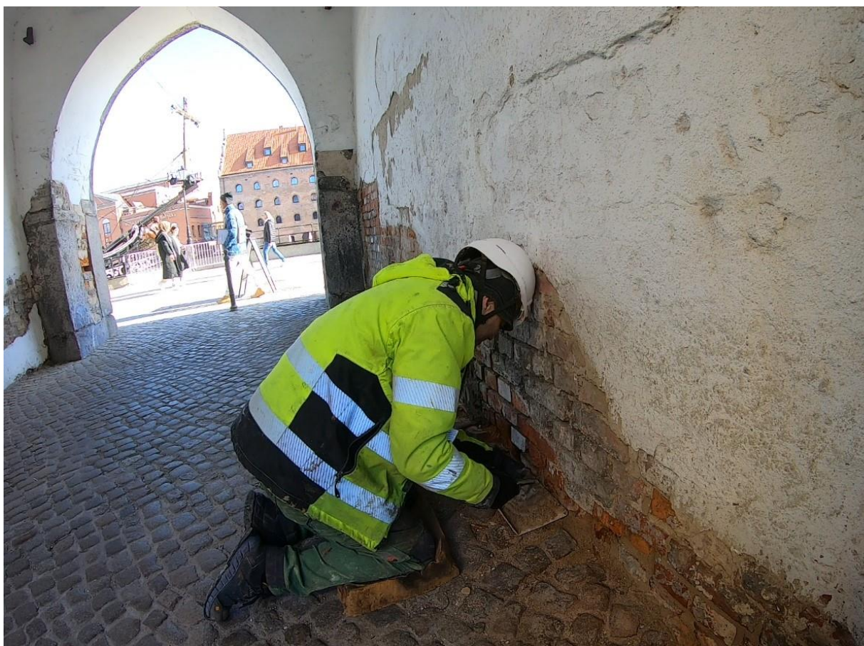
Ilustracja 42. Zabezpieczanie otworów zaprawą
