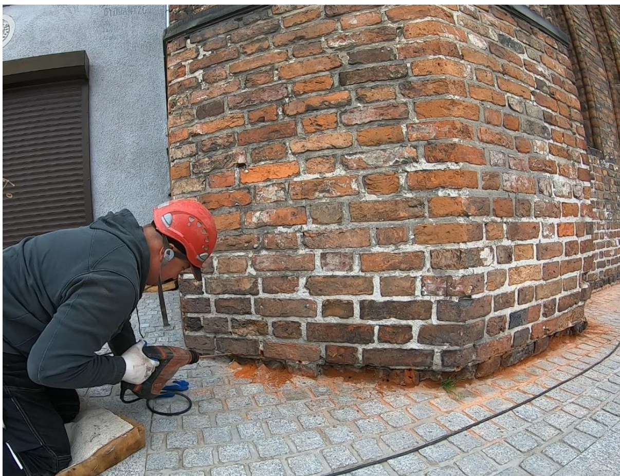
Ilustracja 28. Wykonywanie odwiertów pod iniektory
