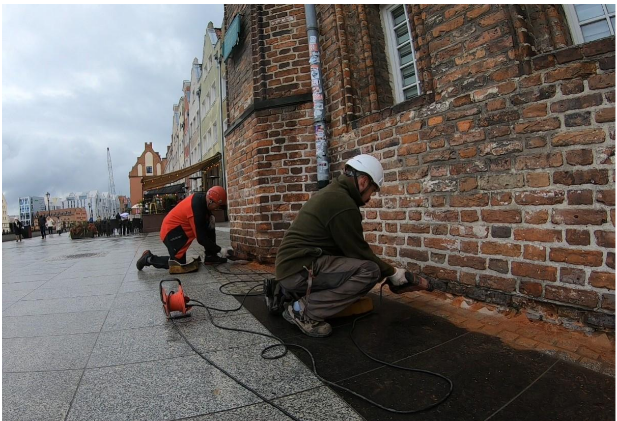
Ilustracja 27. Wykonywanie odwiertów pod iniektory. Z prawej pogłębianie otworów przy użyciu dłuższego wiertła
