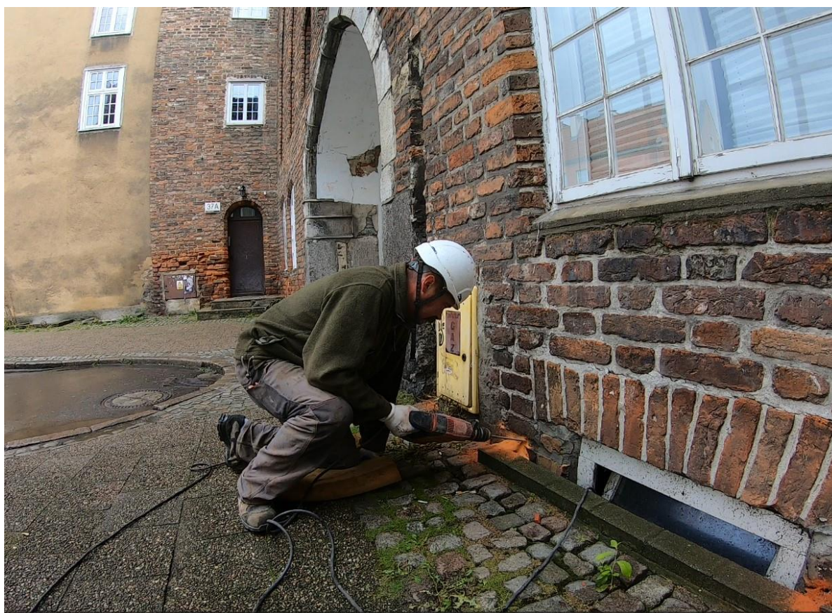
Ilustracja 25. Pogłębianie otworów przy użyciu dłuższego wiertła
