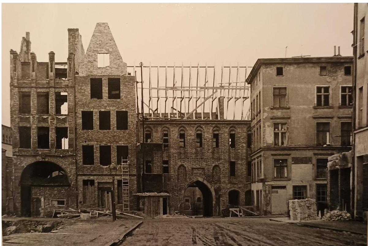
Ilustracja 10. Brama Straganiarska, montaż więźby dachowej [źródło: archiwum NID]
