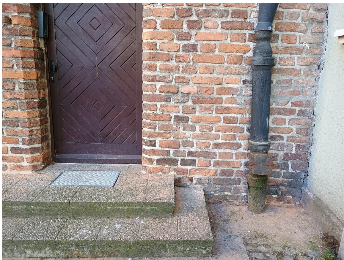
Ilustracja 49. Po zakończeniu prac
