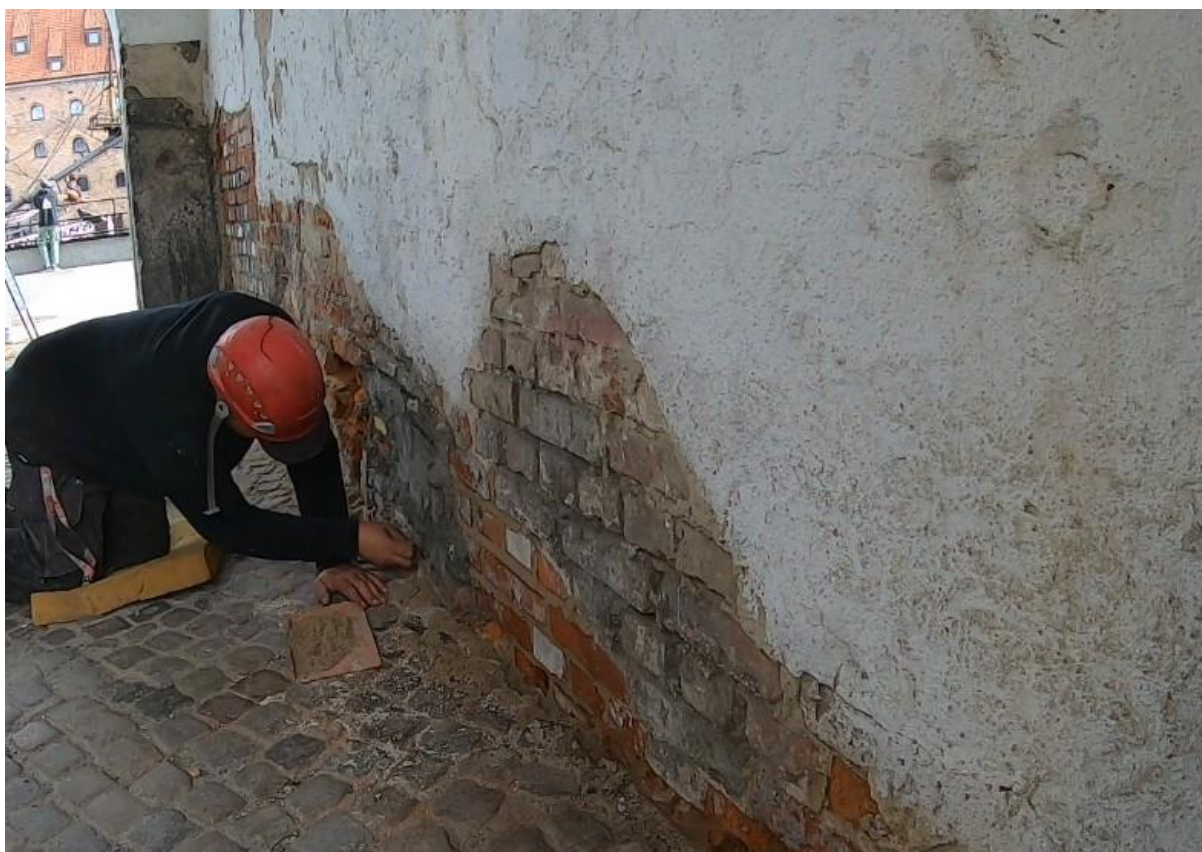
Ilustracja 43. Zabezpieczanie otworów zaprawą
