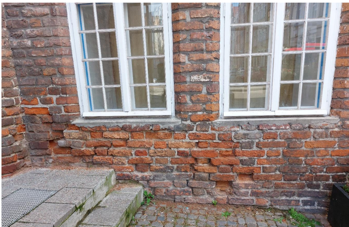
Ilustracja 16. Skutki zawilgocenia
