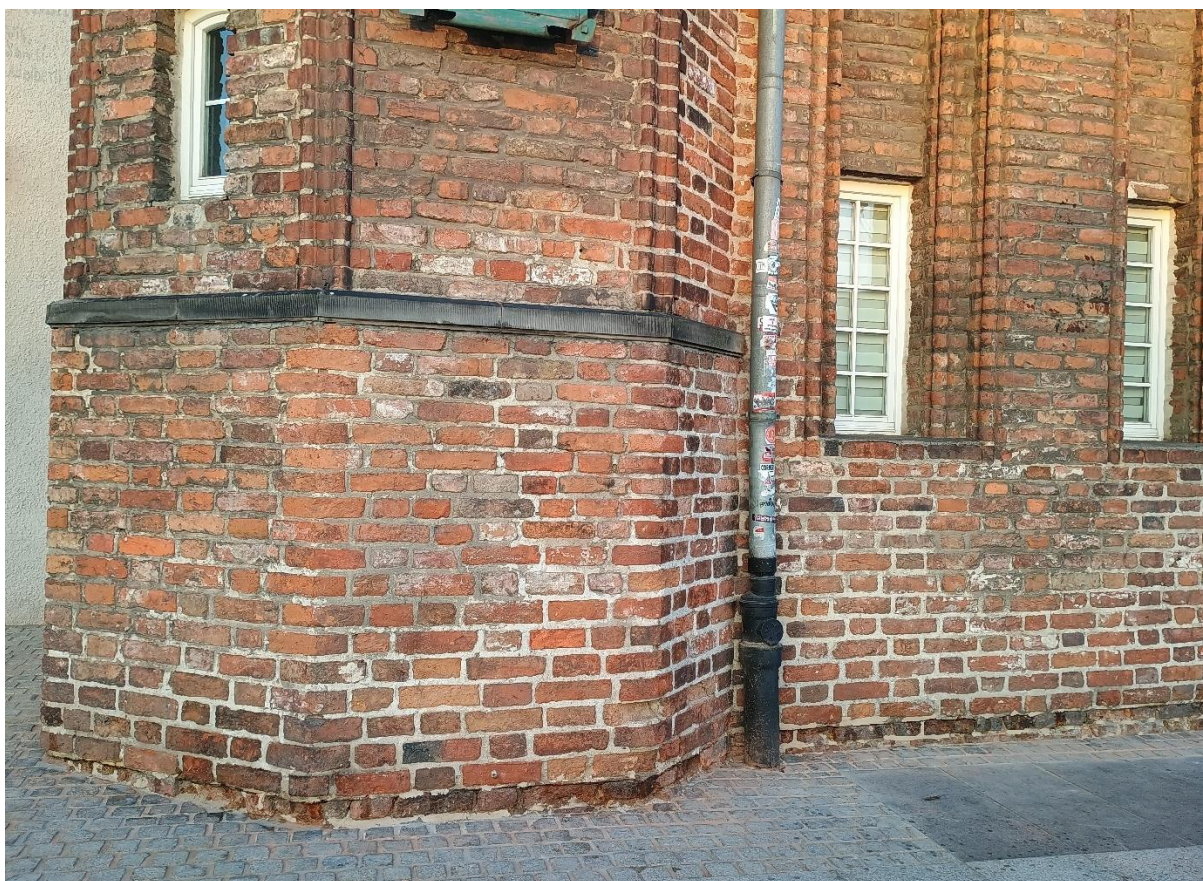
Ilustracja 56. Po zakończeniu prac
