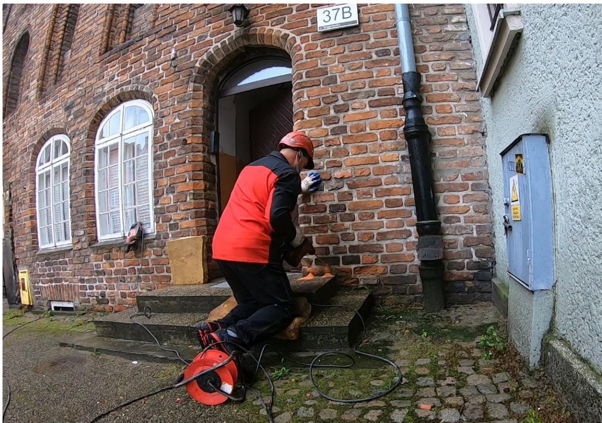
Ilustracja 22. Wykonywanie odwiertów pod iniektory
