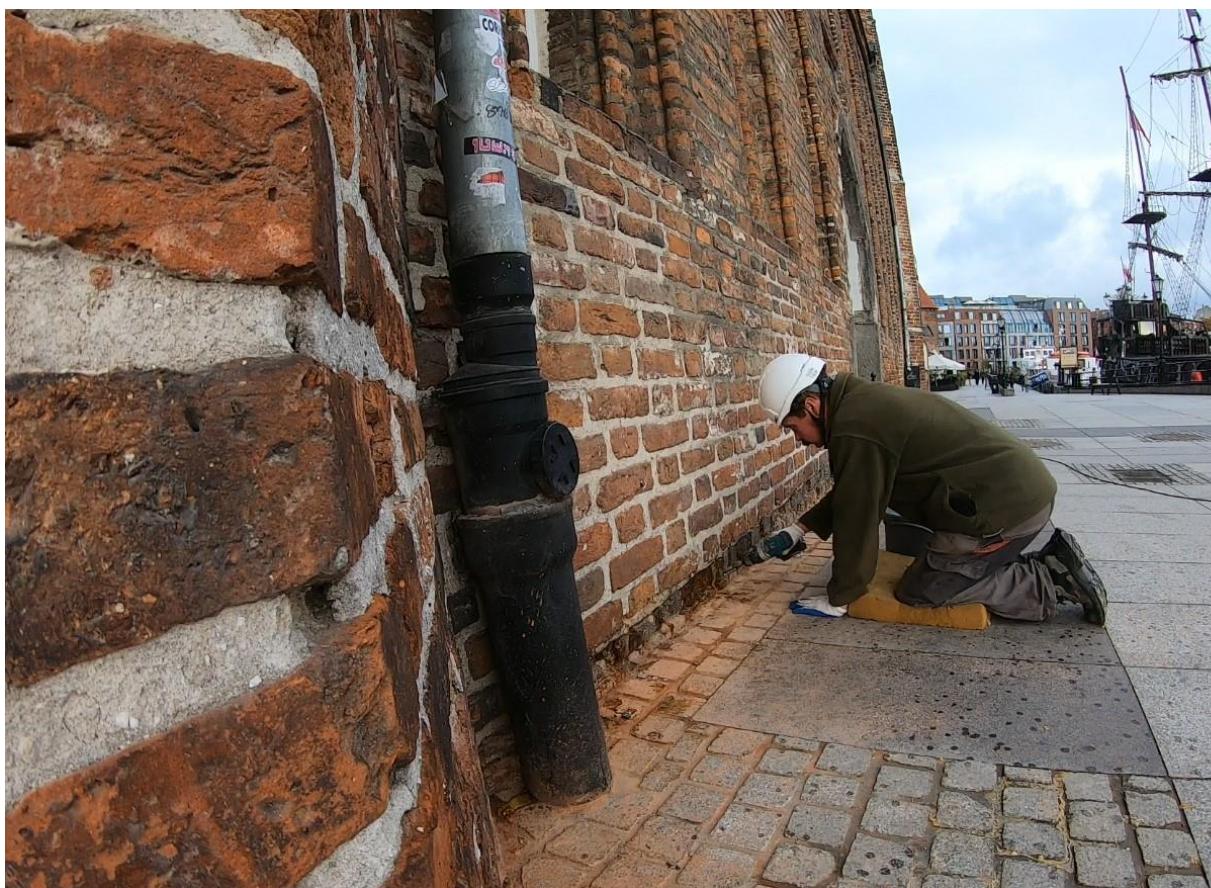
Ilustracja 40. Usuwanie iniektorów po aplikacji środka iniekcyjnego
