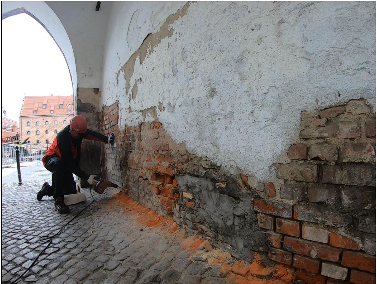
Ilustracja 26. Wykonywanie odwiertów pod iniektory
