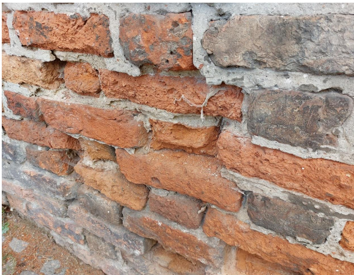
Ilustracja 17. Skutki zawilgocenia
