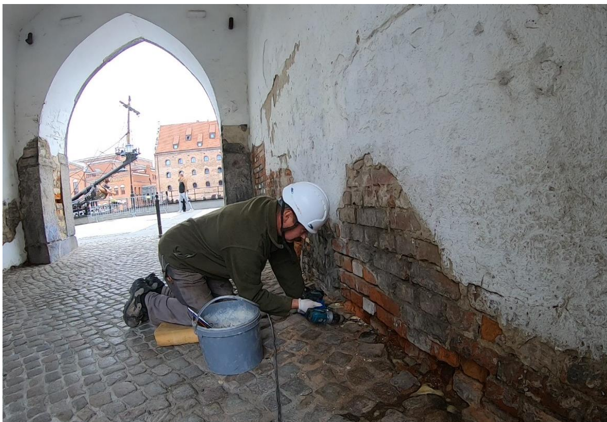
Ilustracja 39. Usuwanie iniektorów po aplikacji środka iniekcyjnego
