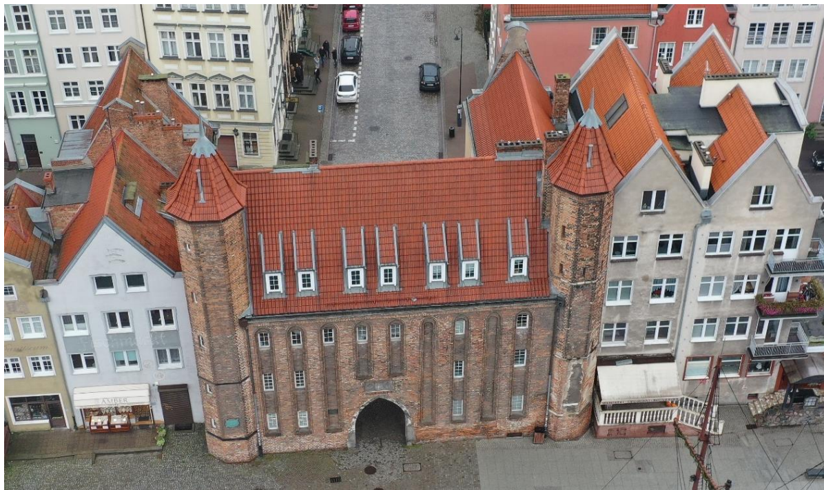
Ilustracja 12. Widok ogólny zabytku od wschodu
