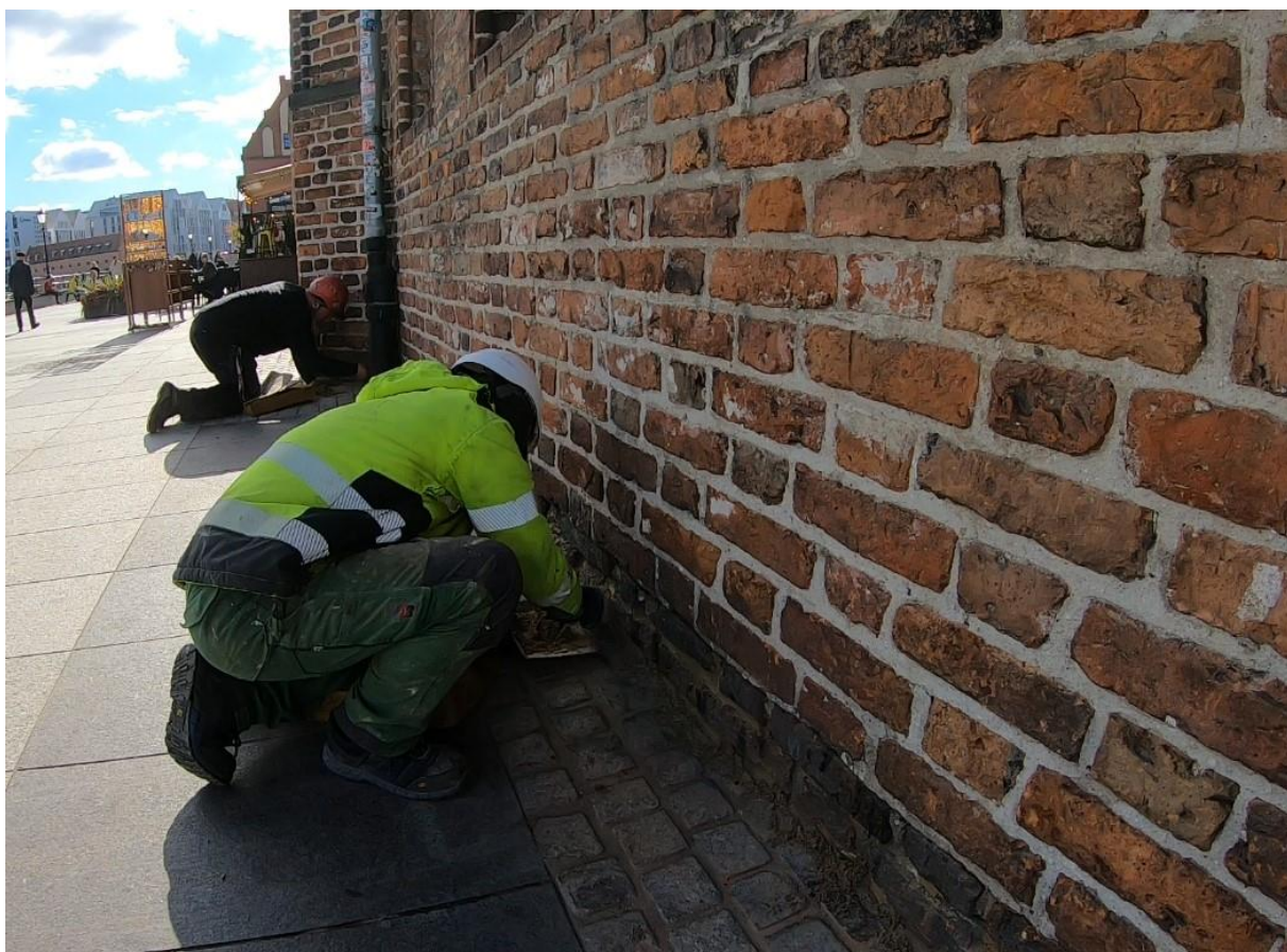
Ilustracja 44. Zabezpieczanie otworów zaprawą
