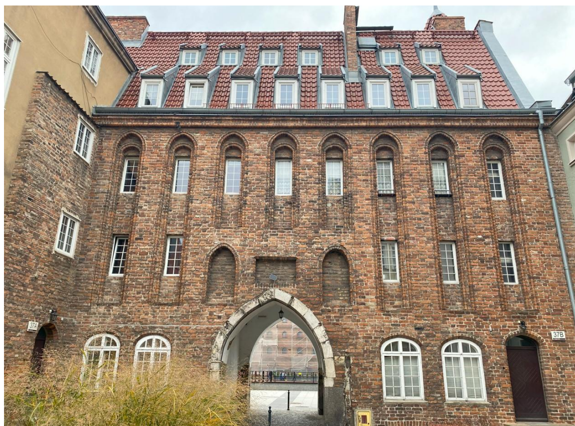
Ilustracja 47. Widok ogólny po zakończeniu prac
