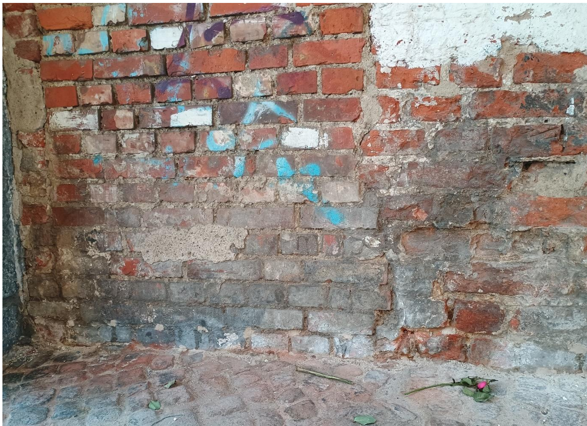
Ilustracja 53. Po zakończeniu prac
