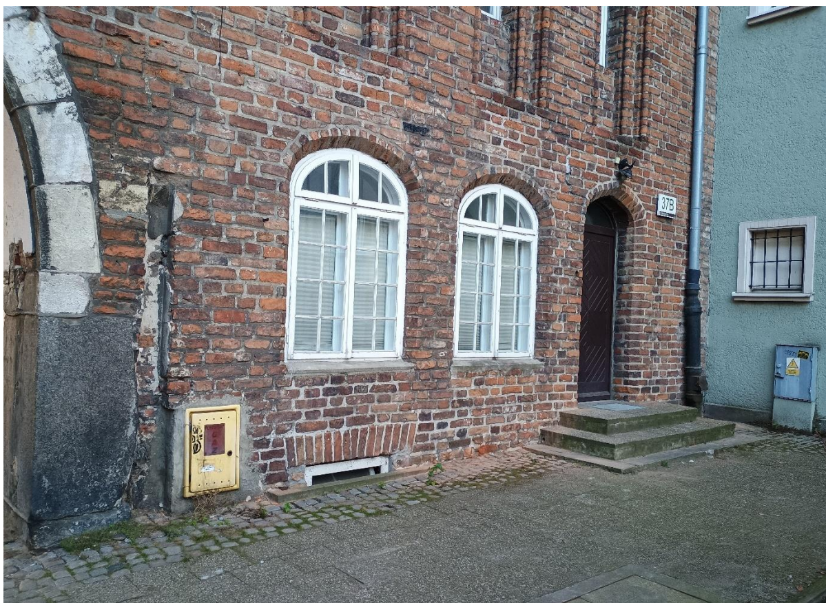
Ilustracja 50. Po zakończeniu prac
