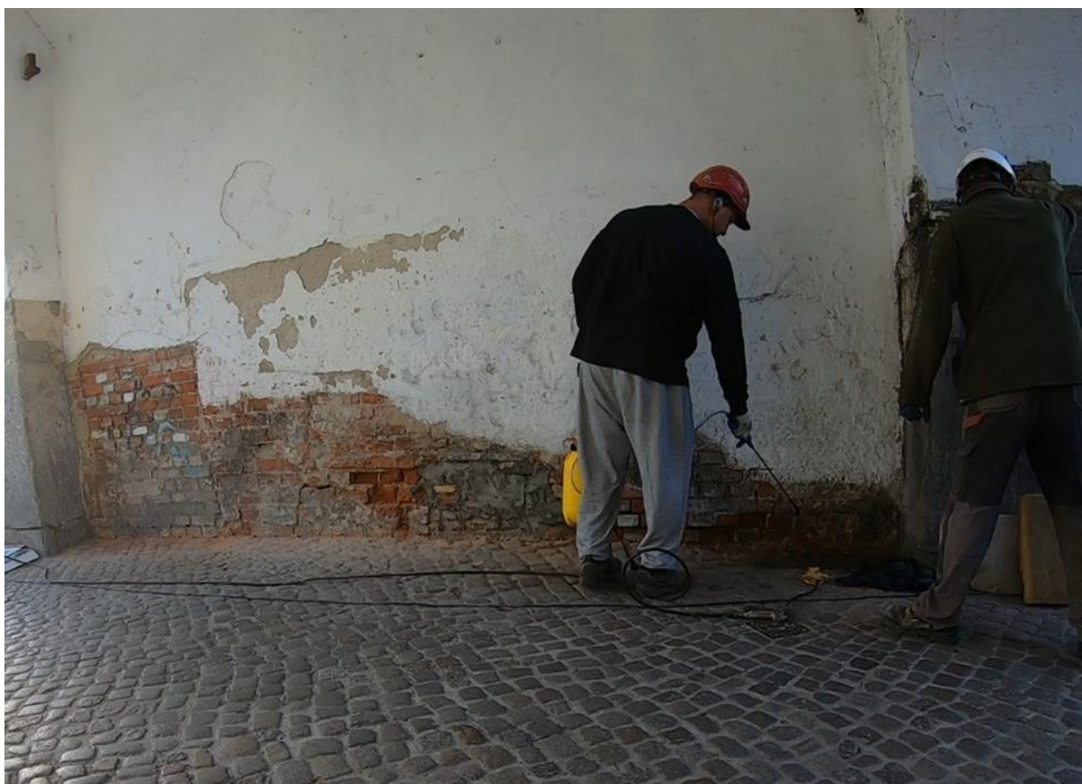
Ilustracja 30. Zwilżanie otworów przed wprowadzeniem mieszanki iniekcyjnej
