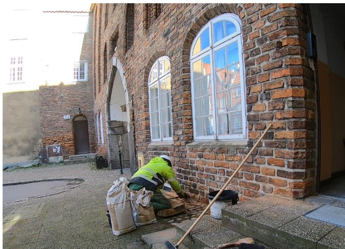
Ilustracja 41. Zabezpieczanie otworów zaprawą
