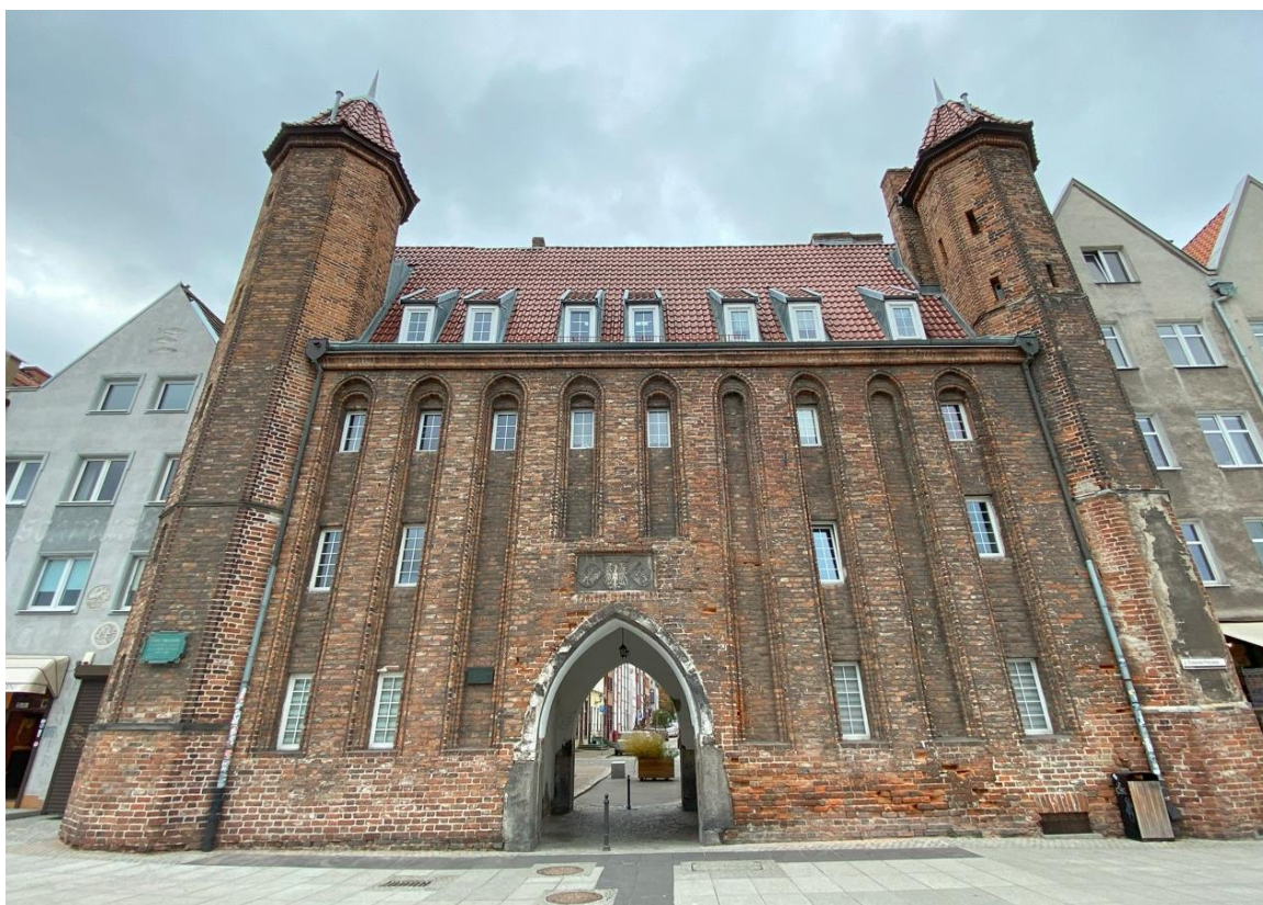
Ilustracja 46. Widok ogólny po zakończeniu prac
