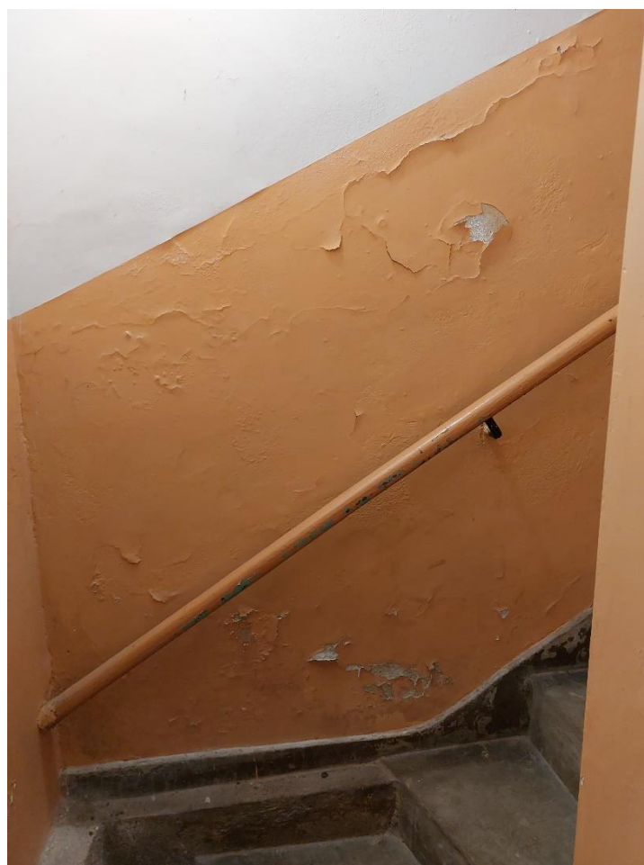
Ilustracja 21. Skutki zawilgocenia
