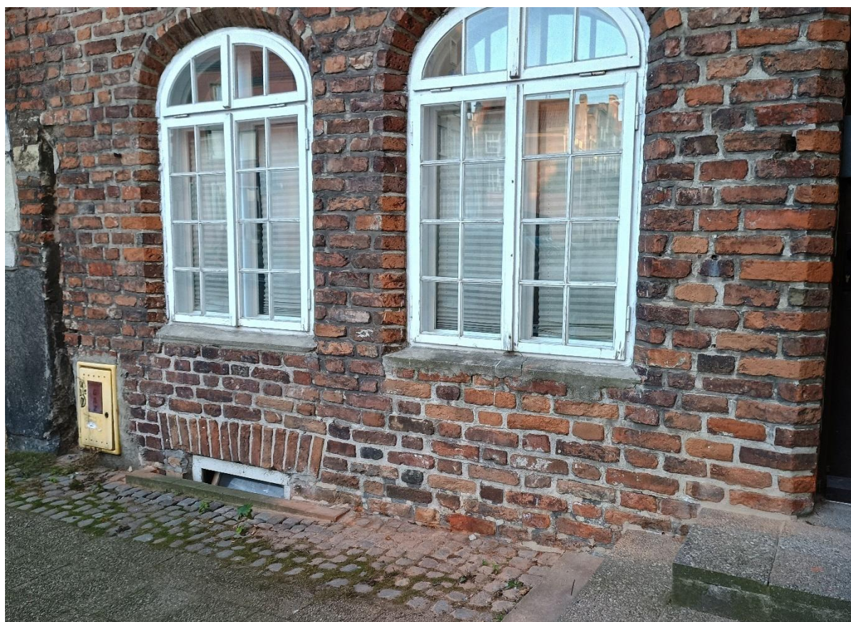
Ilustracja 51. Po zakończeniu prac
