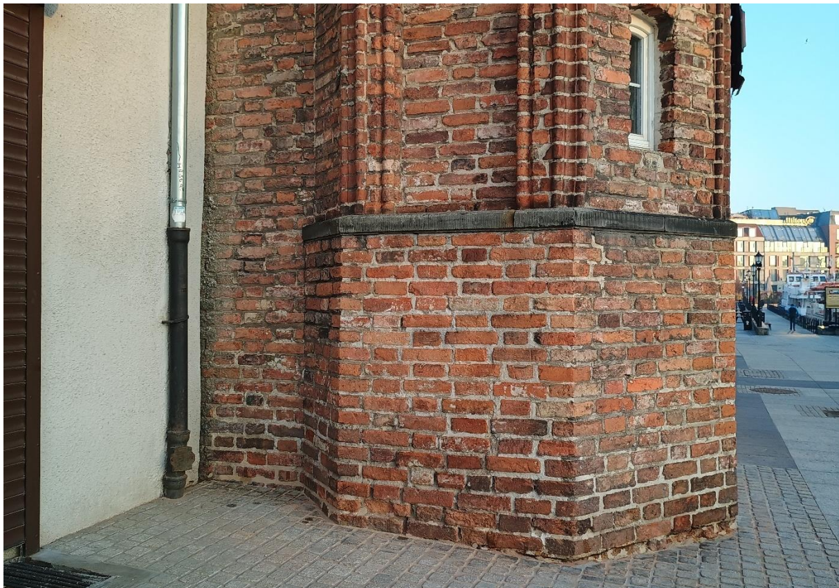
Ilustracja 57. Po zakończeniu prac
