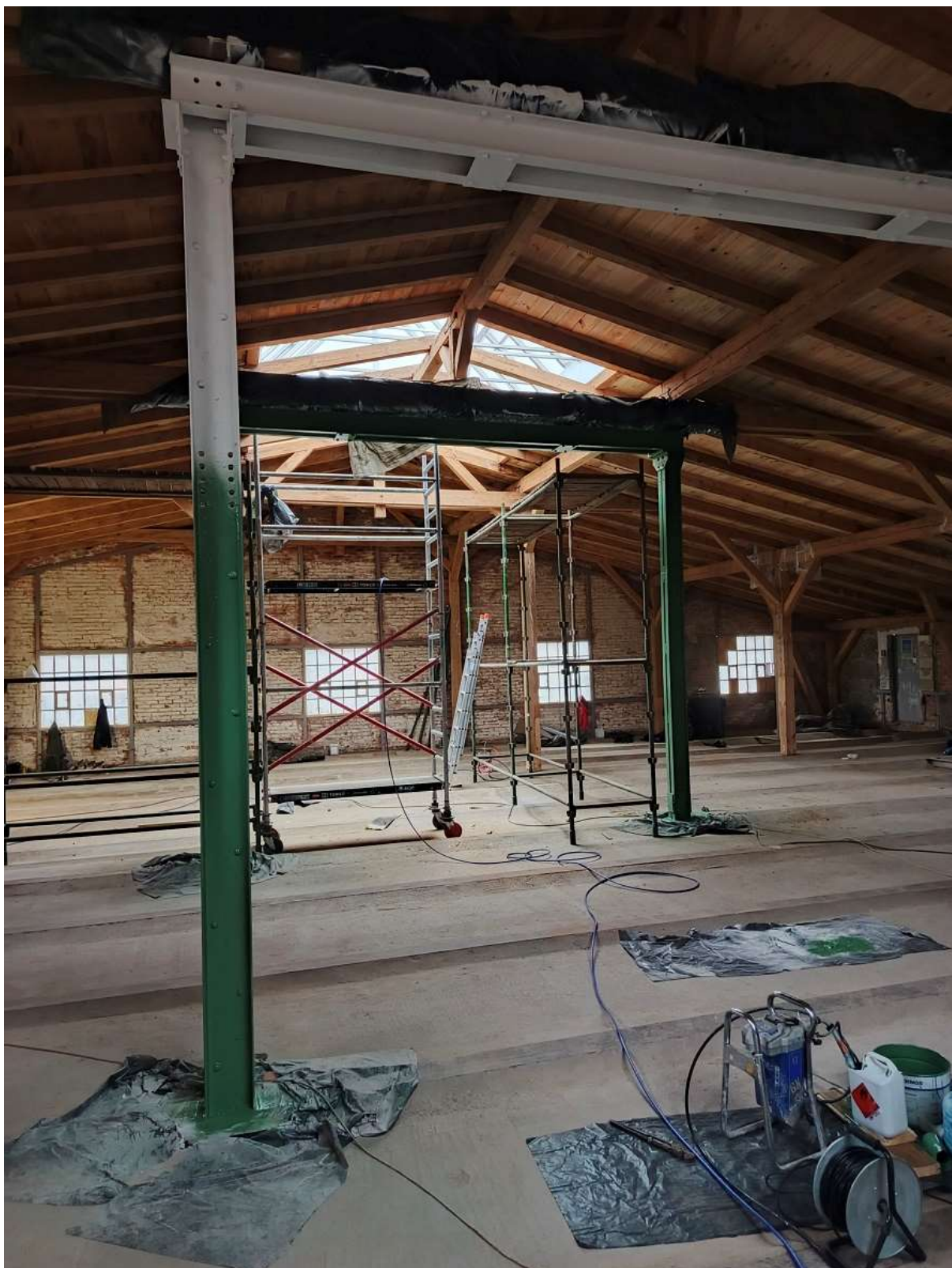
Fot. 33 Dach – część północna – budynku dawnych garaży elektrowozów/magazyn (86B) w trakcie prac – zabezpieczenie antykorozyjne farbą powierzchniową stalowych elementów konstrukcji dachu, fot. 2024r.
