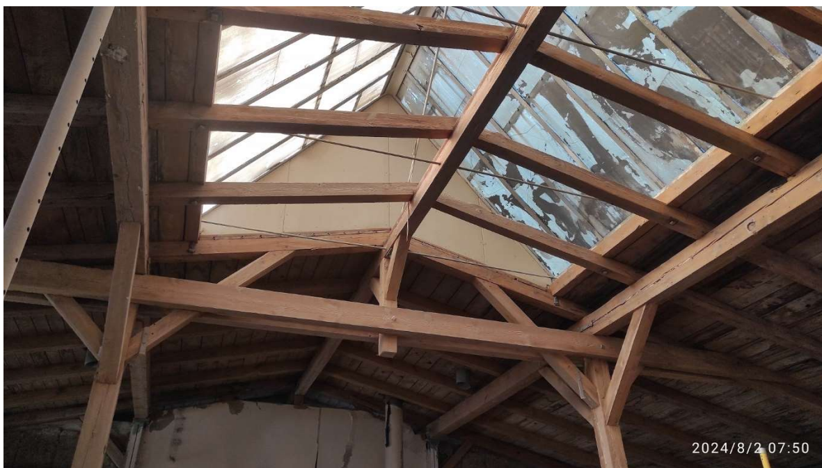
Fot. 2 Dach – część północna – budynku dawnych garaży elektrowozów/magazyn (86B) w trakcie prac – czyszczenie strumieniowo-ścierne konstrukcji drewnianej dachu, fot. 2024r.
