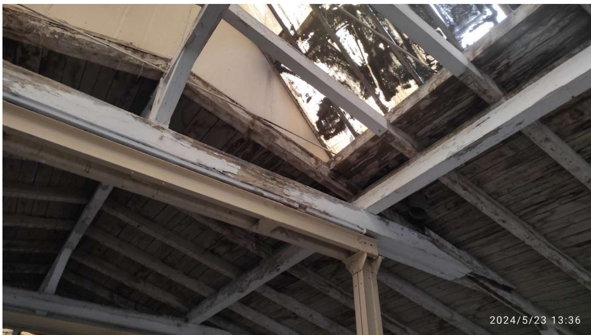
Fot. 49 Dach (konstrukcja dachu z deskowaniem pełnym i świetlikiem) – część północna – budynku dawnych garaży elektrowozów/magazyn (86B), stan przed pracami, fot. 2024r.
