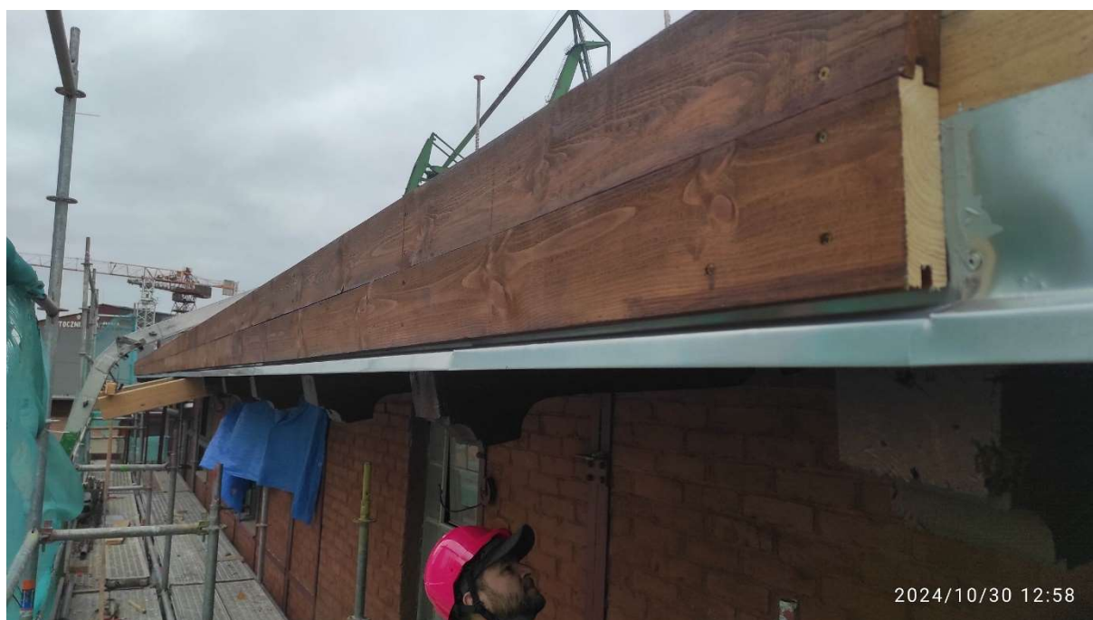
Fot. 20 Dach – część północna – budynku dawnych garaży elektrowozów/magazyn (86B) w trakcie prac – roboty dekarские, montaż deski okapowej, fot. 2024r.
