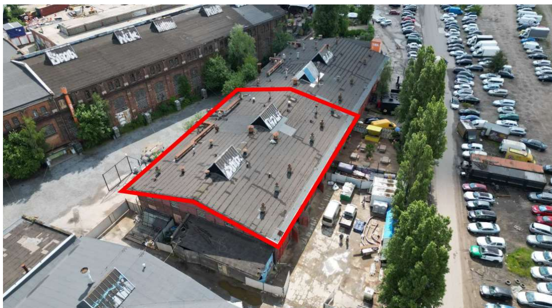
Fot. 2 Lokalizacja 50% powierzchni dachu budynku (strona północna) objętego remontem, oznaczony czerwoną ramką [źródło: materiały własne]
