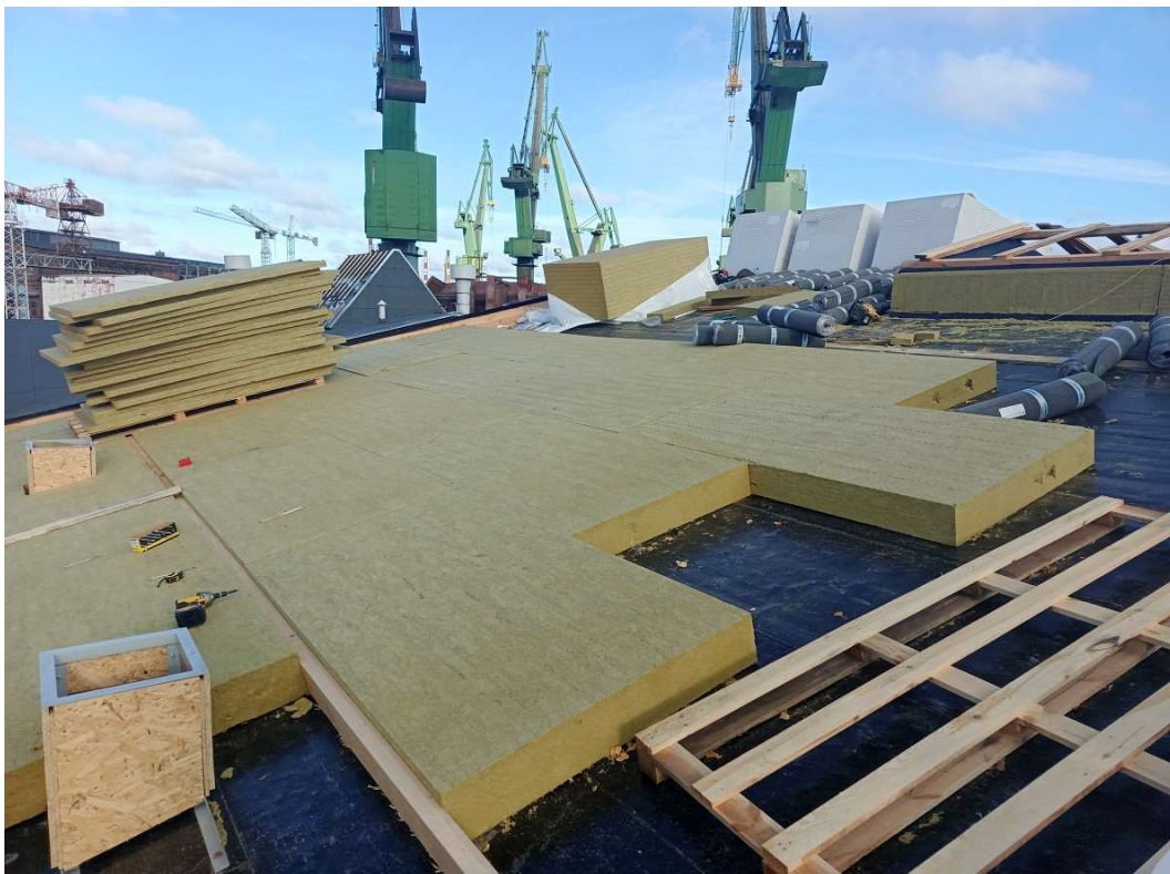
Fot. 23 Dach – część północna – budynku dawnych garaży elektrowozów/magazyn (86B) w trakcie prac – roboty dekarские, montaż wełny mineralnej, fot. 2024r.
