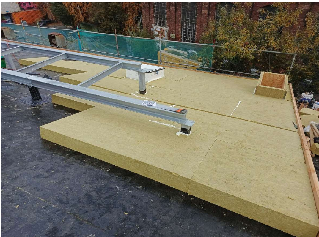
Fot. 25 Dach – część północna – budynku dawnych garaży elektrowozów/magazyn (86B) w trakcie prac – roboty dekarские, montaż wełny mineralnej, fot. 2024r.
