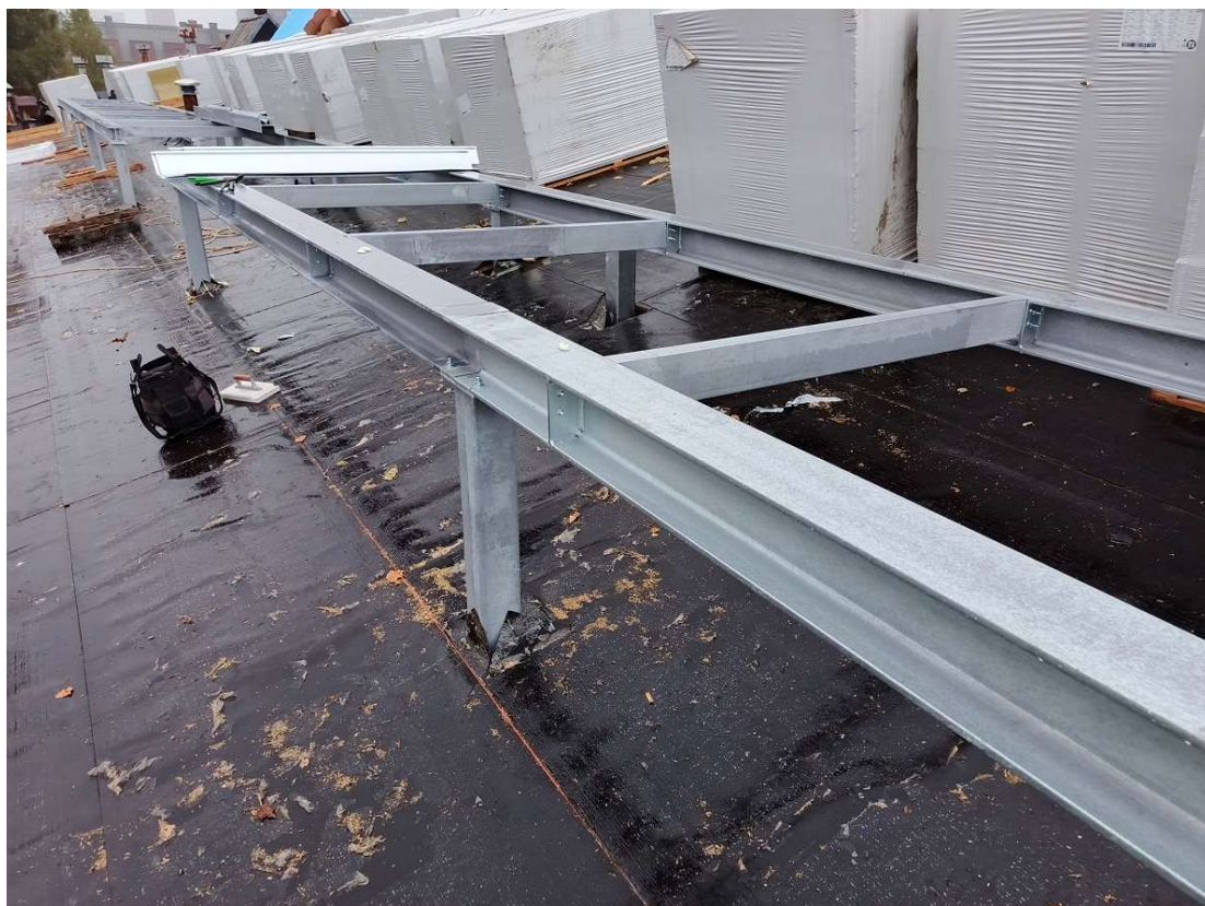
Fot. 21 Dach – część północna – budynku dawnych garaży elektrowozów/magazyn (86B) w trakcie prac – roboty dekarские, montaż stalowej podkonstrukcji pod centrale wentylacyjne, fot. 2024r.
