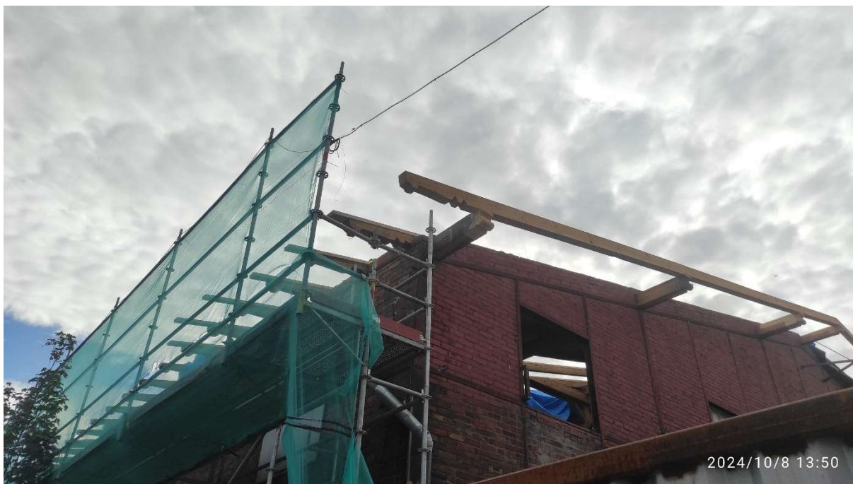
Fot. 14 Dach – część północna – budynku dawnych garaży elektrowozów/magazyn (86B) w trakcie prac – roboty ciesielskie, wymiana zdegradowanych elementów konstrukcji dachu, fot. 2024r.
