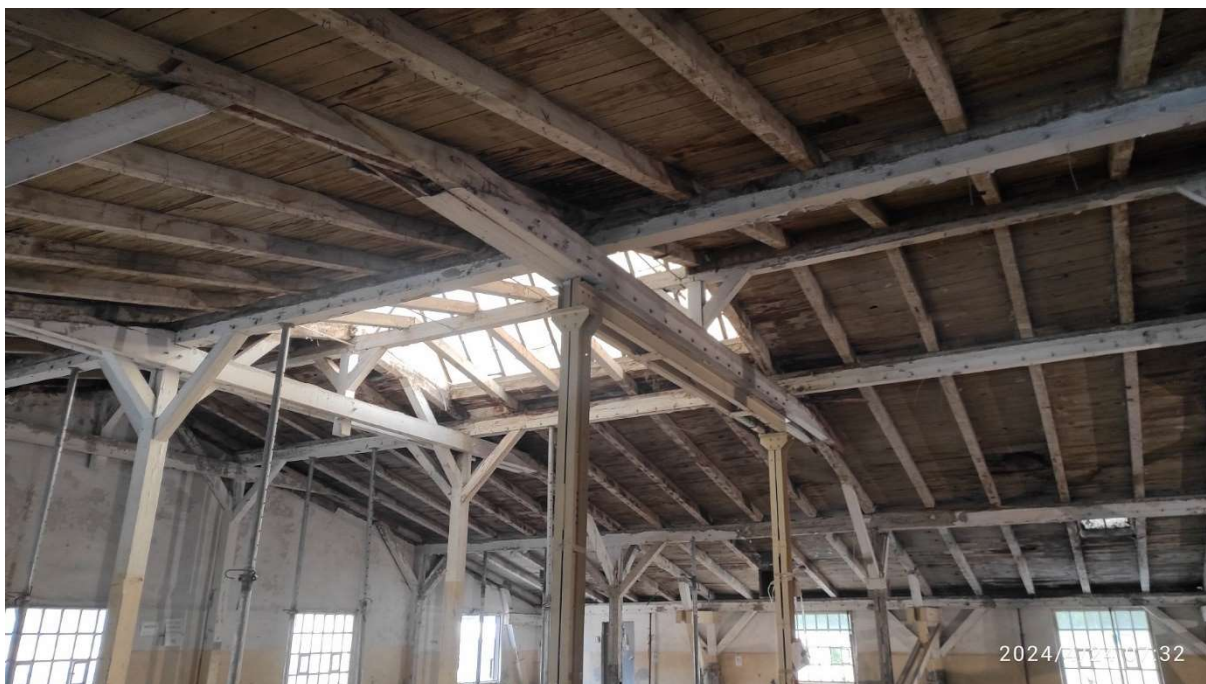
Fot. 51 Dach (konstrukcja dachu z deskowaniem pełnym) – część północna – budynku dawnych garaży elektrowozów/magazyn (86B), stan przed pracami, fot. 2024r.
