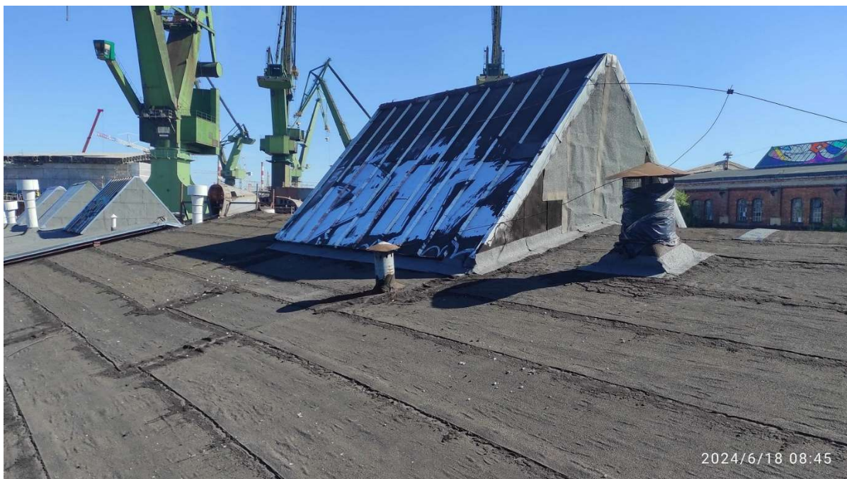
Fot. 39 Dach (światlik dachowy) – część północna – budynku dawnych garaży elektrowozów/magazyn (86B), stan przed pracami, fot. 2024r.
