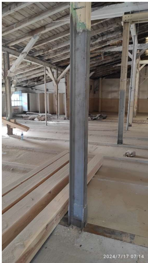
Fot. 3 Dach – część północna – budynku dawnych garaży elektrowozów/magazyn (86B) w trakcie prac – czyszczenie strumieniowo-ścierne konstrukcji stalowej dachu, fot. 2024r.
