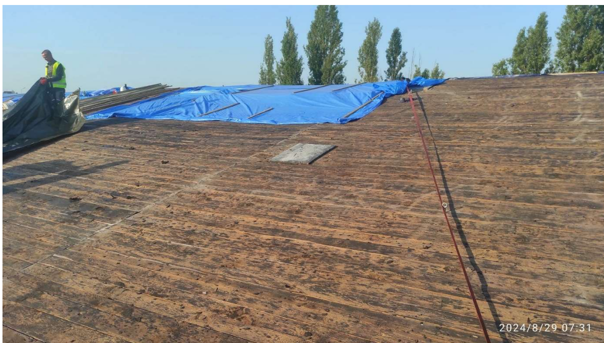
Fot. 8 Dach – część północna – budynku dawnych garaży elektrowozów/magazyn (86B) w trakcie prac – roboty rozbiórkowe pokrycia z papy, fot. 2024r.
