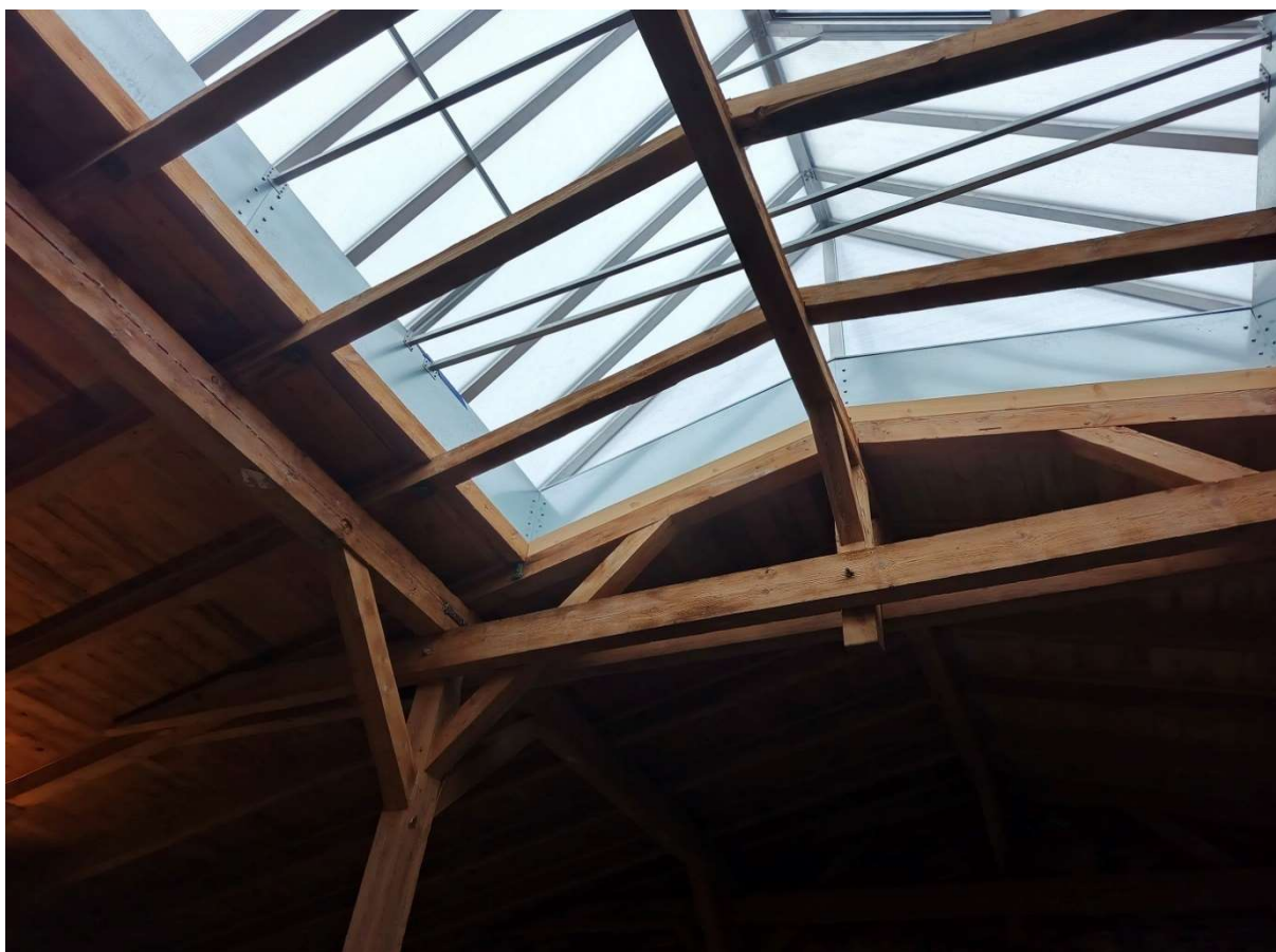
Fot. 56 Dach (konstrukcja dachu z świetlikiem) – część północna – budynku dawnych garaży elektrowozów/magazyn (86 B), stan po pracach, fot. 2024r.
