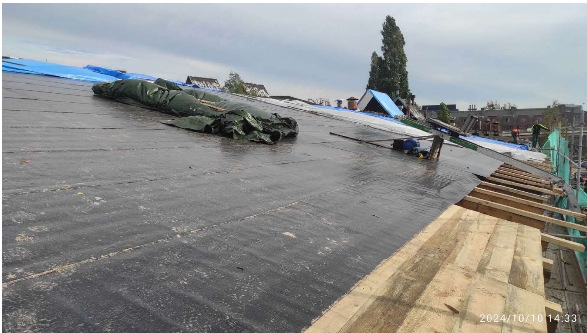
Fot. 19 Dach – część północna – budynku dawnych garaży elektrowozów/magazyn (86B) w trakcie prac – roboty dekarские, montaż papy podkładowej samoprzylepnej będącej paraizolacją dla wełny mineralnej, fot. 2024r.
