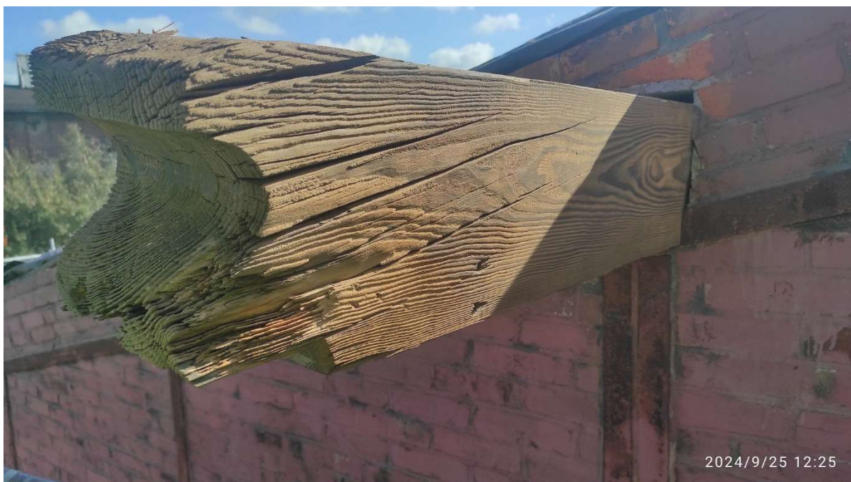
Fot. 12 Dach – część północna – budynku dawnych garaży elektrowozów/magazyn (86B) w trakcie prac – roboty ciesielskie, naprawa zdegradowanych elementów konstrukcji dachu, fot. 2024r.
