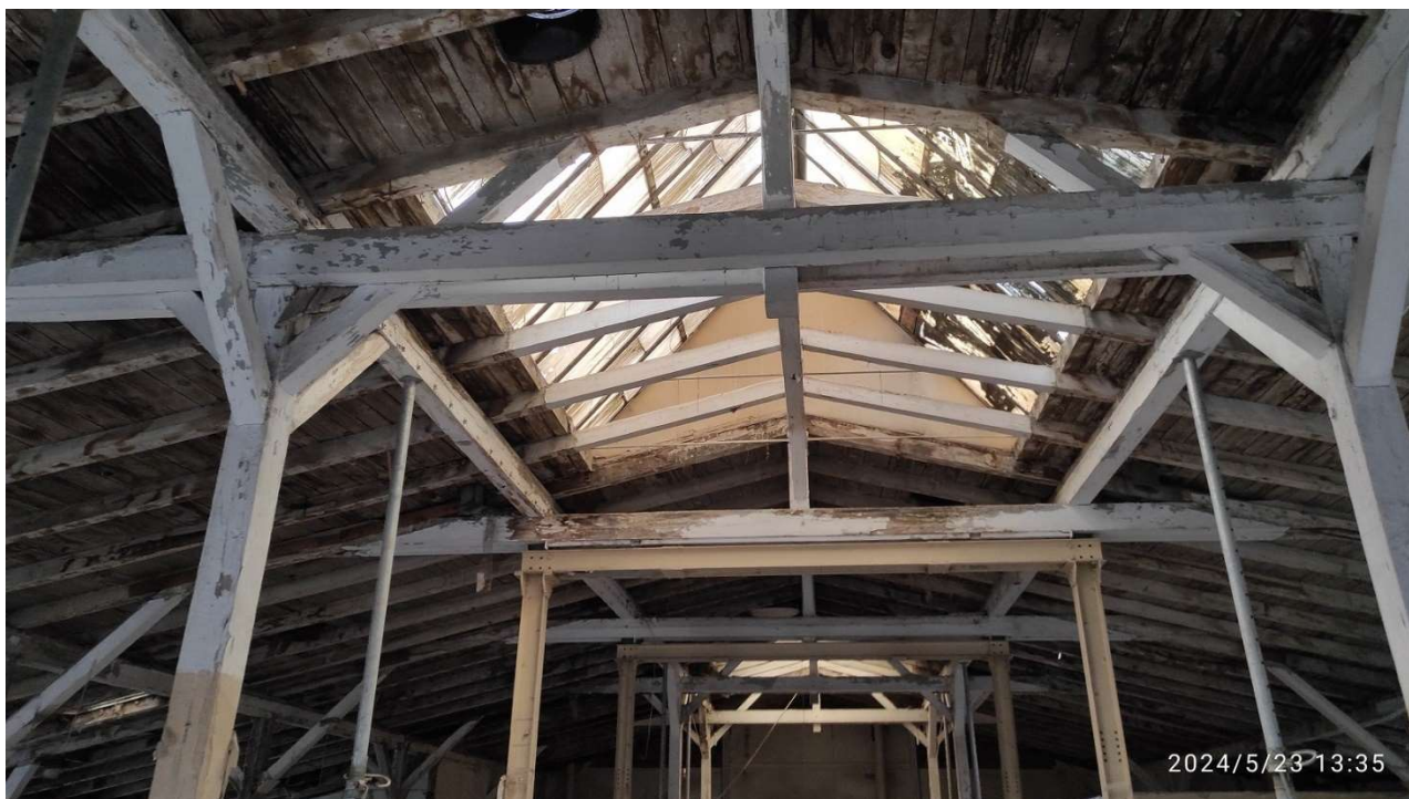
Fot. 47 Dach (konstrukcja dachu z deskowaniem pełnym) – część północna – budynku dawnych garaży elektrowozów/magazyn (86B), stan przed pracami, fot. 2024r.
