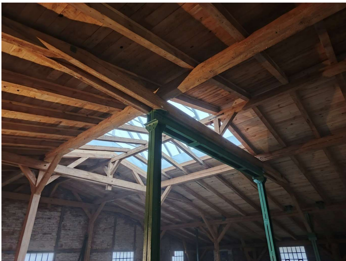
Fot. 52 Dach (konstrukcja dachu z deskowaniem pełnym) – część północna – budynku dawnych garaży elektrowozów/magazyn (86 B), stan po pracach, fot. 2024r.
