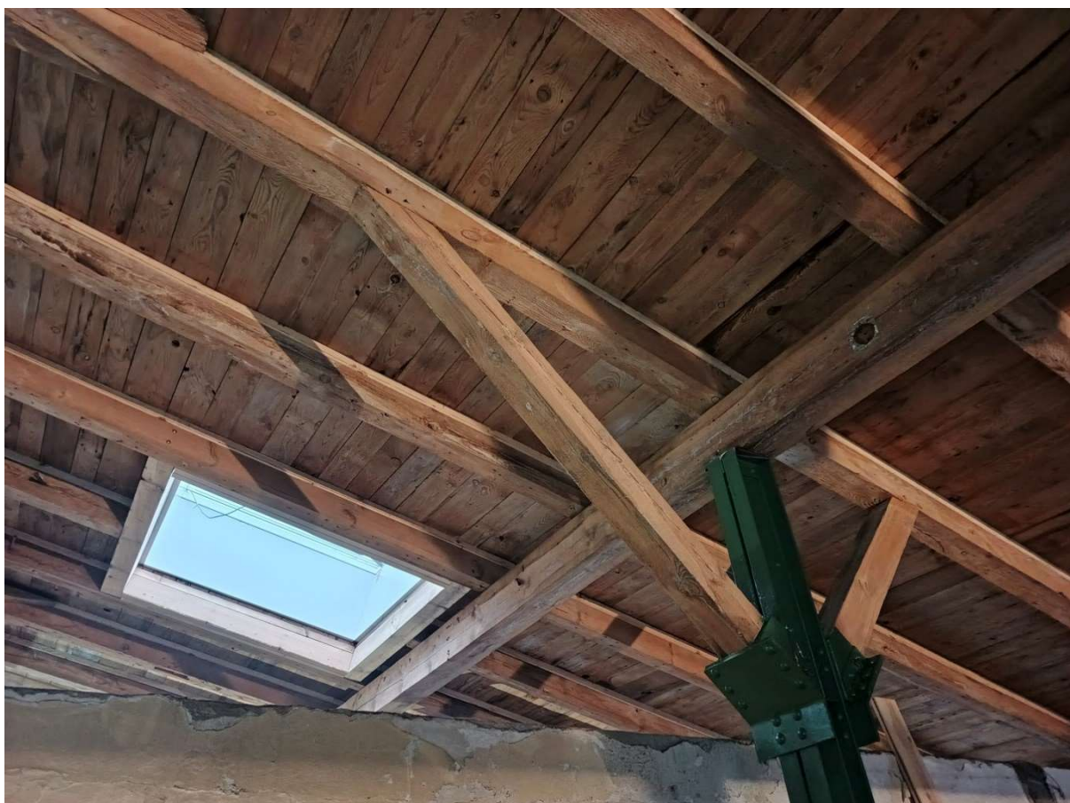
Fot. 54 Dach (konstrukcja dachu z deskowaniem pełnym) – część północna – budynku dawnych garaży elektrowozów/magazyn (86 B), stan po pracach, fot. 2024r.
