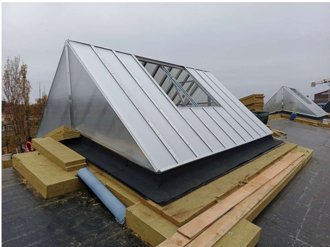
Fot. 24 Dach – część północna – budynku dawnych garaży elektrowozów/magazyn (86 B) – 50% powierzchni (strona północna) przy ul. Ks. Jerzego Popiełuszki 3
