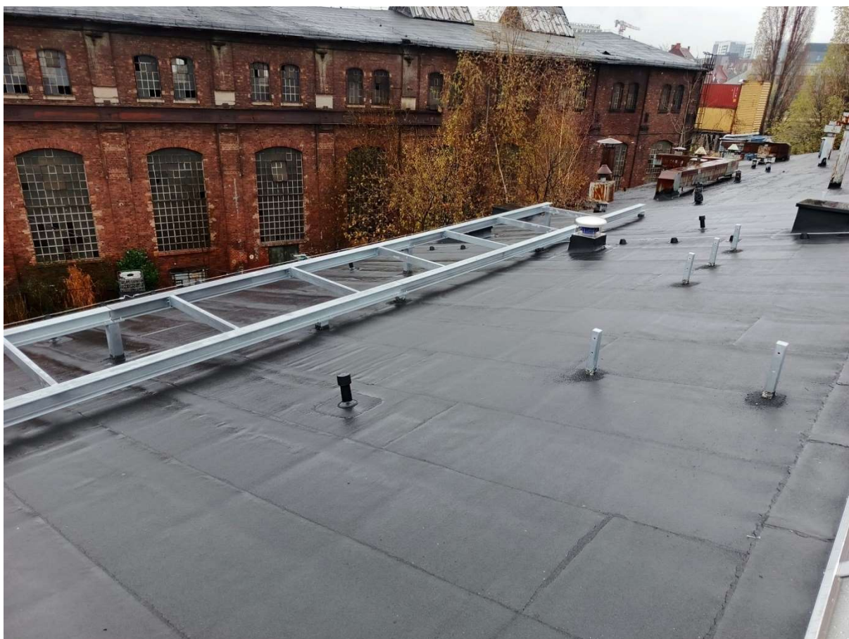
Fot. 44 Dach – część północna – budynku dawnych garaży elektrowozów/magazyn (86B), stan po pracach, fot. 2024r.
