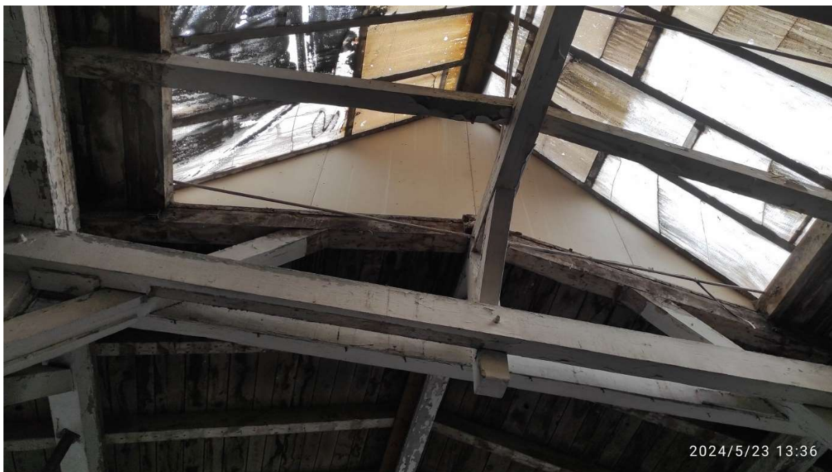
Fot. 55 Dach (konstrukcja dachu z świetlikiem) – część północna – budynku dawnych garaży elektrowozów/magazyn (86B), stan przed pracami, fot. 2024r.
