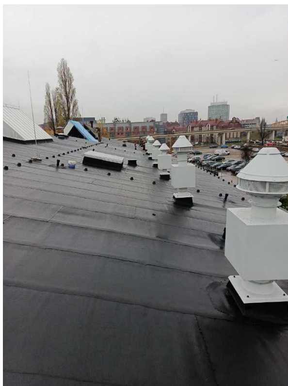
Fot. 38 Dach (zabytkowe kominki wentylacyjne) – część północna – budynku dawnych garaży elektrowozów/magazyn (86B), stan po pracach, fot. 2024r.
