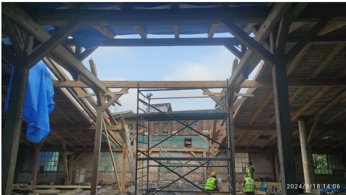
Fot. 11 Dach – część północna – budynku dawnych garaży elektrowozów/magazyn (86B) w trakcie prac – roboty ciesielskie, wymiana zdegradowanych elementów konstrukcji dachu, fot. 2024r.
