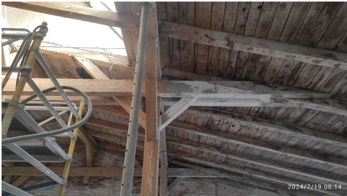
Fot. 1 Dach – część północna – budynku dawnych garaży elektrowozów/magazyn (86B) w trakcie prac – czyszczenie strumieniowo-ścierne konstrukcji drewnianej dachu, fot. 2024r.
