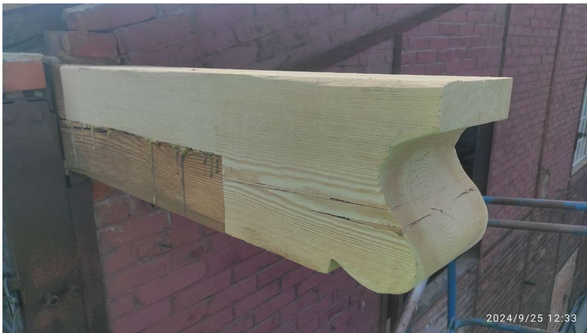
Fot. 13 Dach – część północna – budynku dawnych garaży elektrowozów/magazyn (86B) w trakcie prac – roboty ciesielskie, naprawa zdegradowanych elementów konstrukcji dachu, fot. 2024r.
