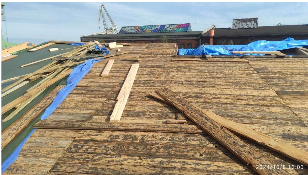
Fot. 15 Dach – część północna – budynku dawnych garaży elektrowozów/magazyn (86B) w trakcie prac – ponowny montaż odzyskanych i wyczyszczonych desek deskowania pełnego, fot. 2024r.
