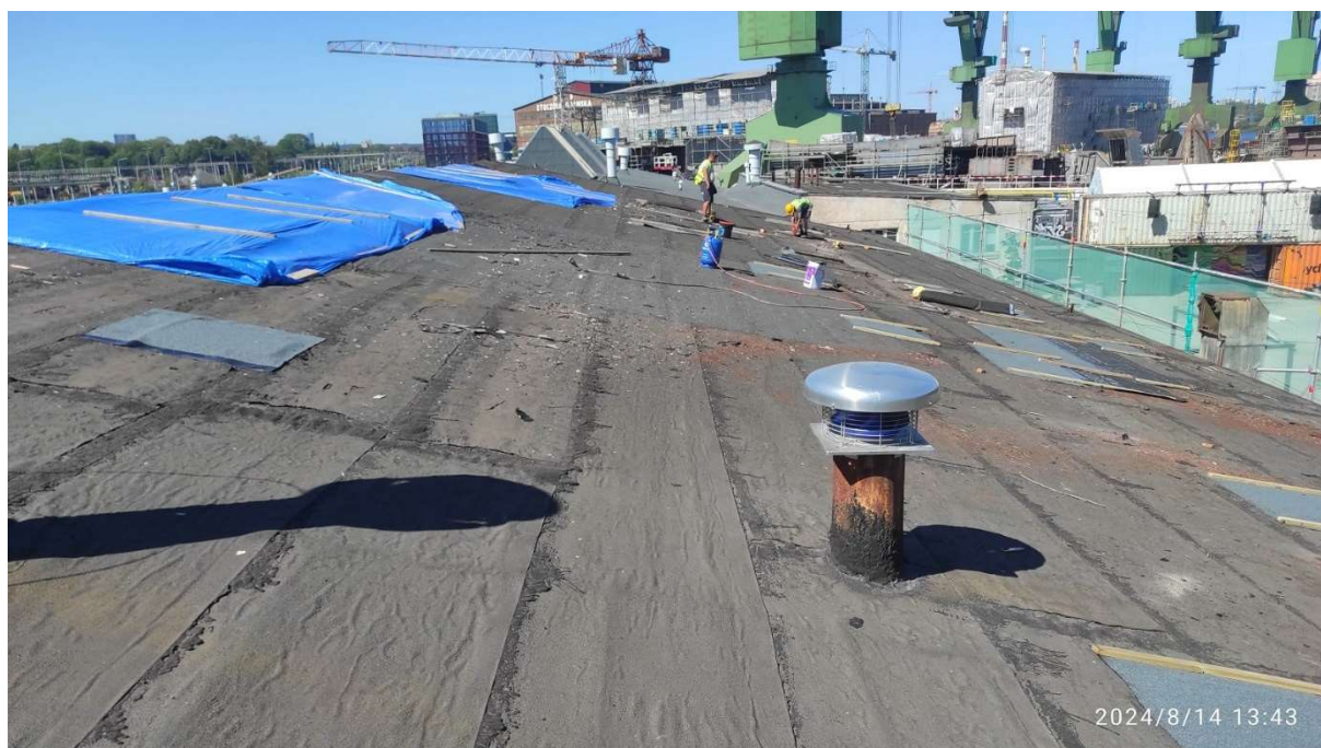
Fot. 6 Dach – część północna – budynku dawnych garaży elektrowozów/magazyn (86B) w trakcie prac – roboty rozbiórkowe świetlików i pozostałych instalacji na dachu, fot. 2024r.
