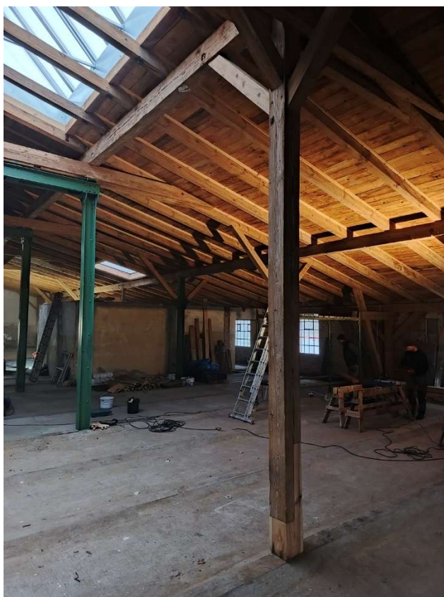
Fot. 46 Dach (konstrukcja dachu z deskowaniem pełnym) – część północna – budynku dawnych garaży elektrowozów/magazyn (86B), stan po pracach, fot. 2024r.
