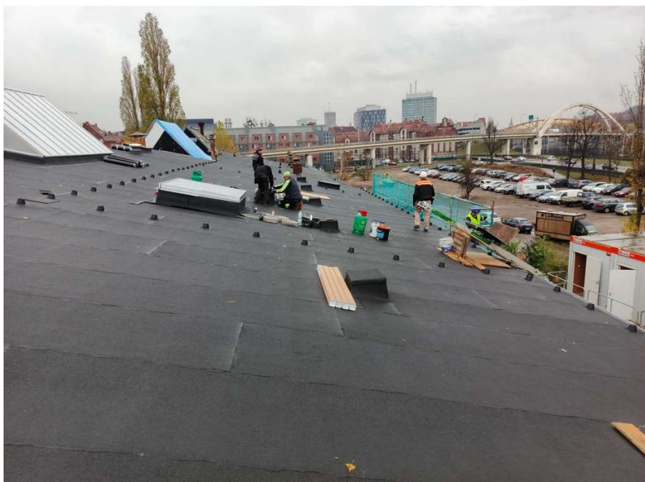
Fot. 31 Dach – część północna – budynku dawnych garaży elektrowozów/magazyn (86B) w trakcie prac – montaż instalacji odgromowej, fot. 2024r.
