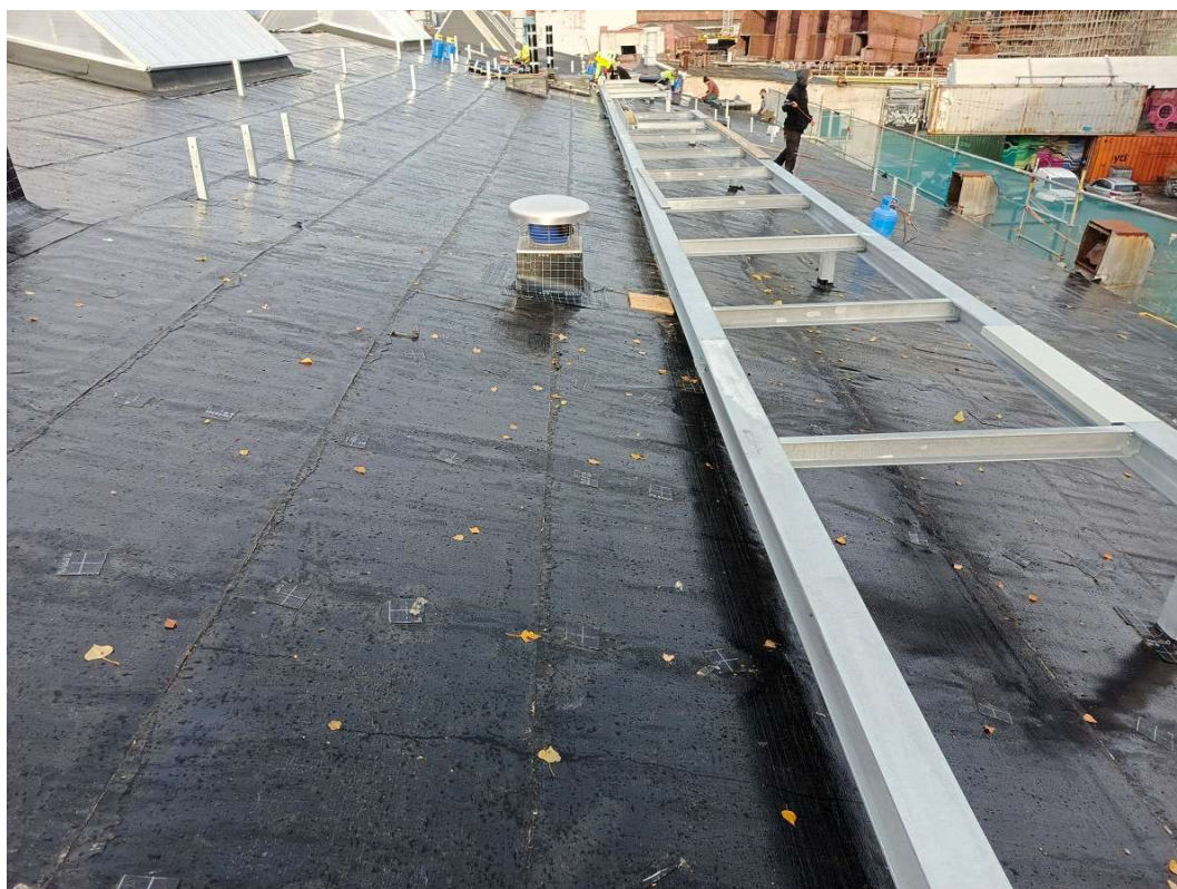
Fot. 28 Dach – część północna – budynku dawnych garaży elektrowozów/magazyn (86B) w trakcie prac – roboty dekarские, montaż papy podkładowej, fot. 2024r.
