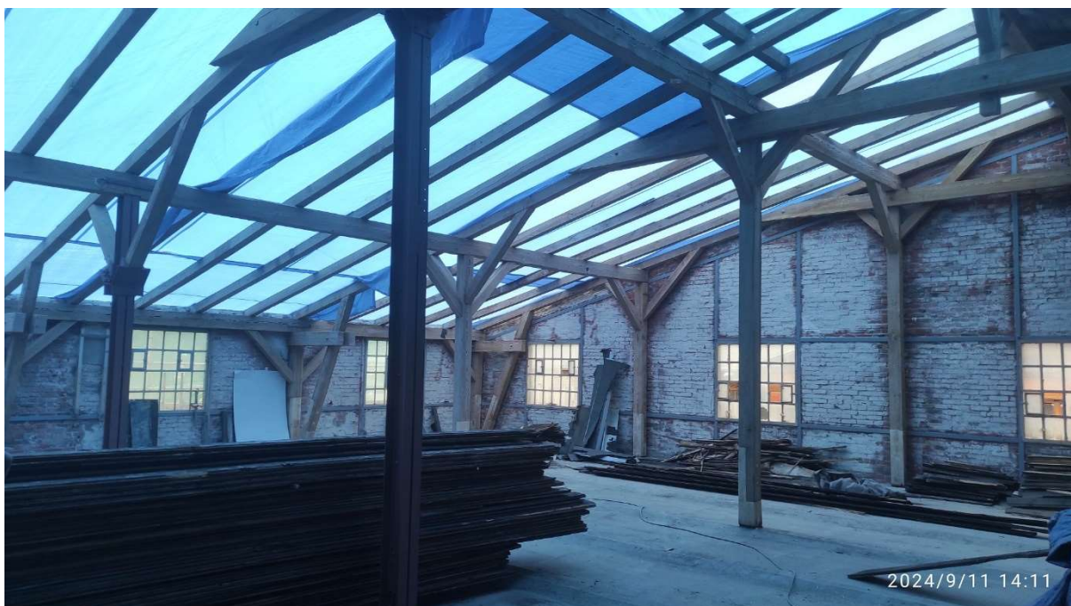
Fot. 10 Dach – część północna – budynku dawnych garaży elektrowozów/magazyn (86B) w trakcie prac – roboty rozbiórkowe deskowania pełnego, fot. 2024r.
