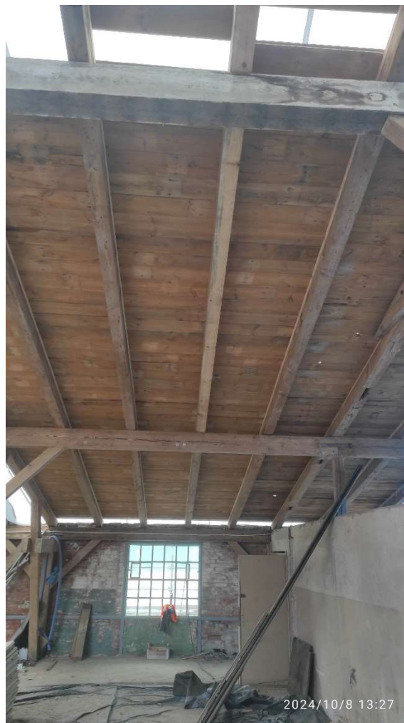
Fot. 16 Dach – część północna – budynku dawnych garaży elektrowozów/magazyn (86B) w trakcie prac – ponowny montaż odzyskanych i wyczyszczonych desek deskowania pełnego, fot. 2024r.
