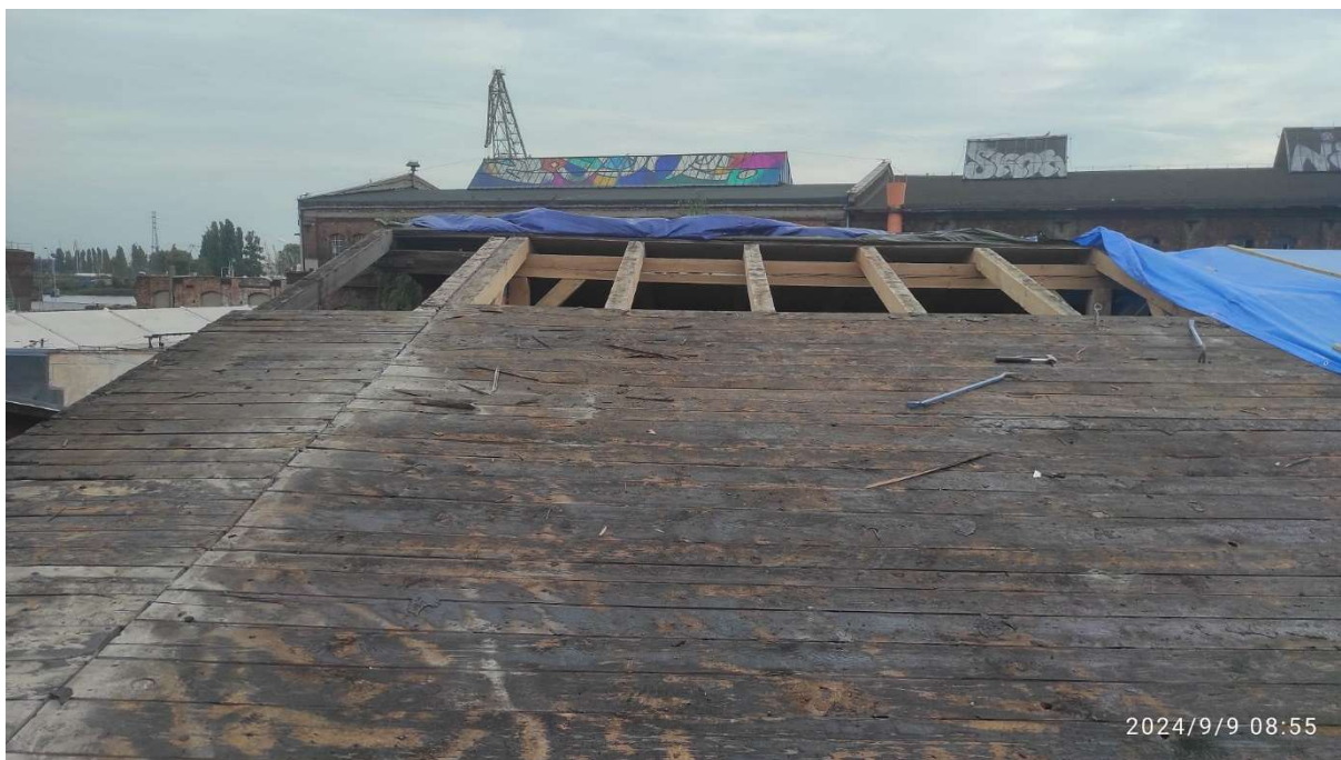
Fot. 9 Dach – część północna – budynku dawnych garaży elektrowozów/magazyn (86B) w trakcie prac – roboty rozbiórkowe deskowania pełnego, fot. 2024r.
