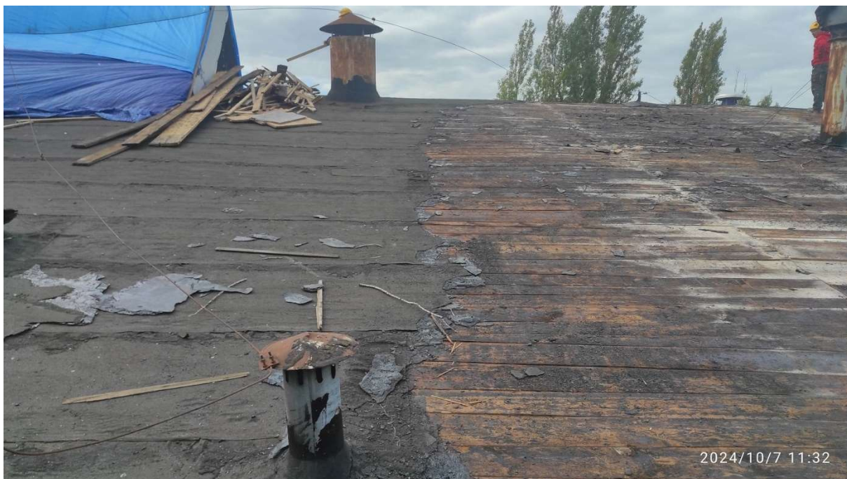
Fot. 7 Dach – część północna – budynku dawnych garaży elektrowozów/magazyn (86B) w trakcie prac – roboty rozbiórkowe pokrycia z papy, fot. 2024r.
