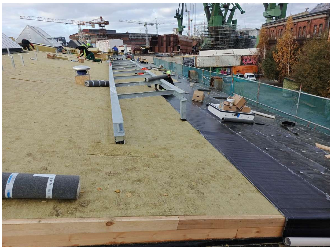
Fot. 26 Dach – część północna – budynku dawnych garaży elektrowozów/magazyn (86B) w trakcie prac – roboty dekarские, montaż wełny mineralnej i papy podkładowej, fot. 2024r.
