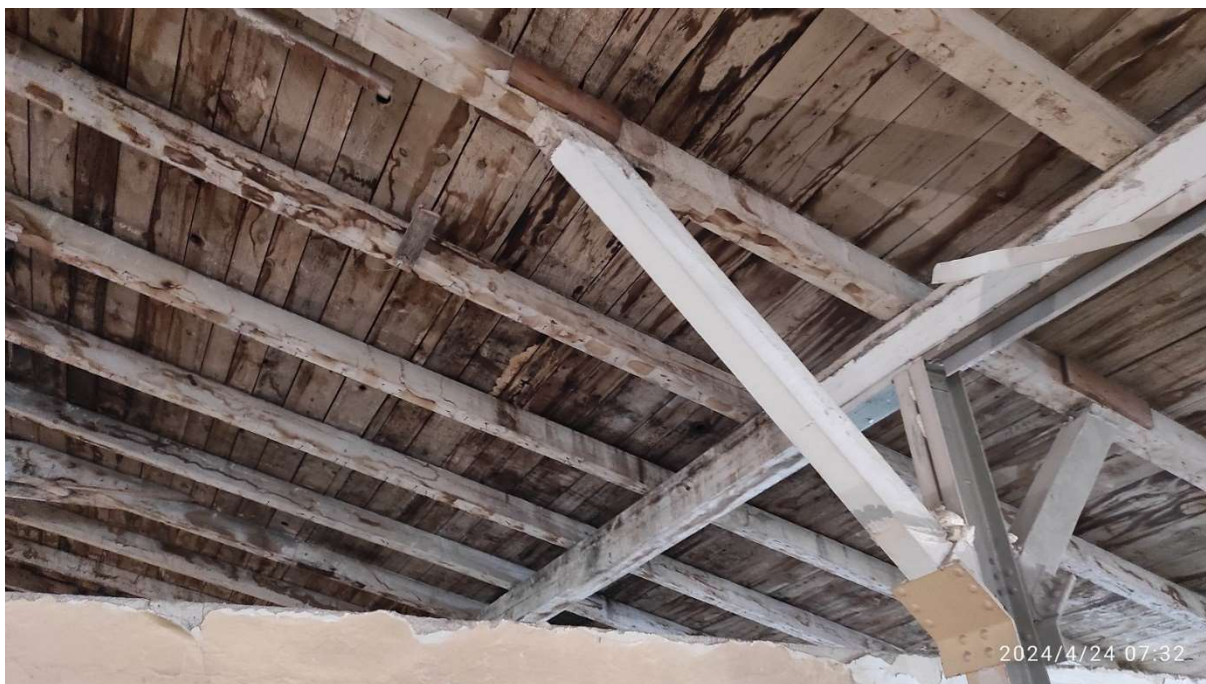
Fot. 53 Dach (konstrukcja dachu z deskowaniem pełnym) – część północna – budynku dawnych garaży elektrowozów/magazyn (86B), stan przed pracami, fot. 2024r.
