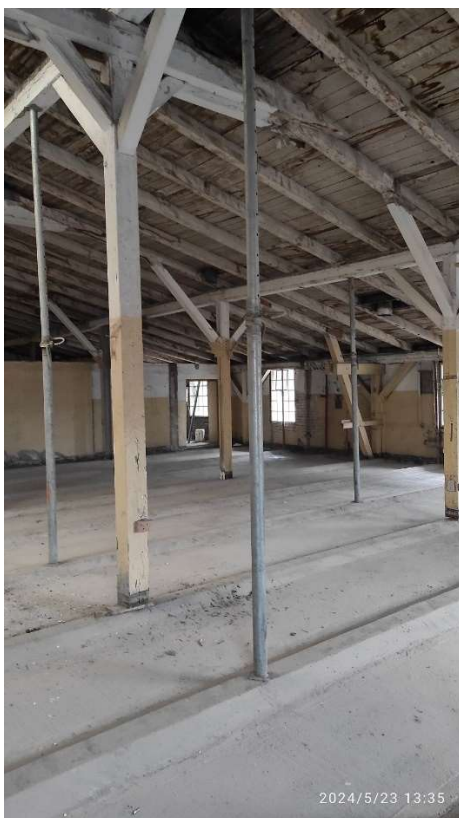
Fot. 45 Dach (konstrukcja dachu z deskowaniem pełnym) – część północna – budynku dawnych garaży elektrowozów/magazyn (86B), stan przed pracami, fot. 2024r.
