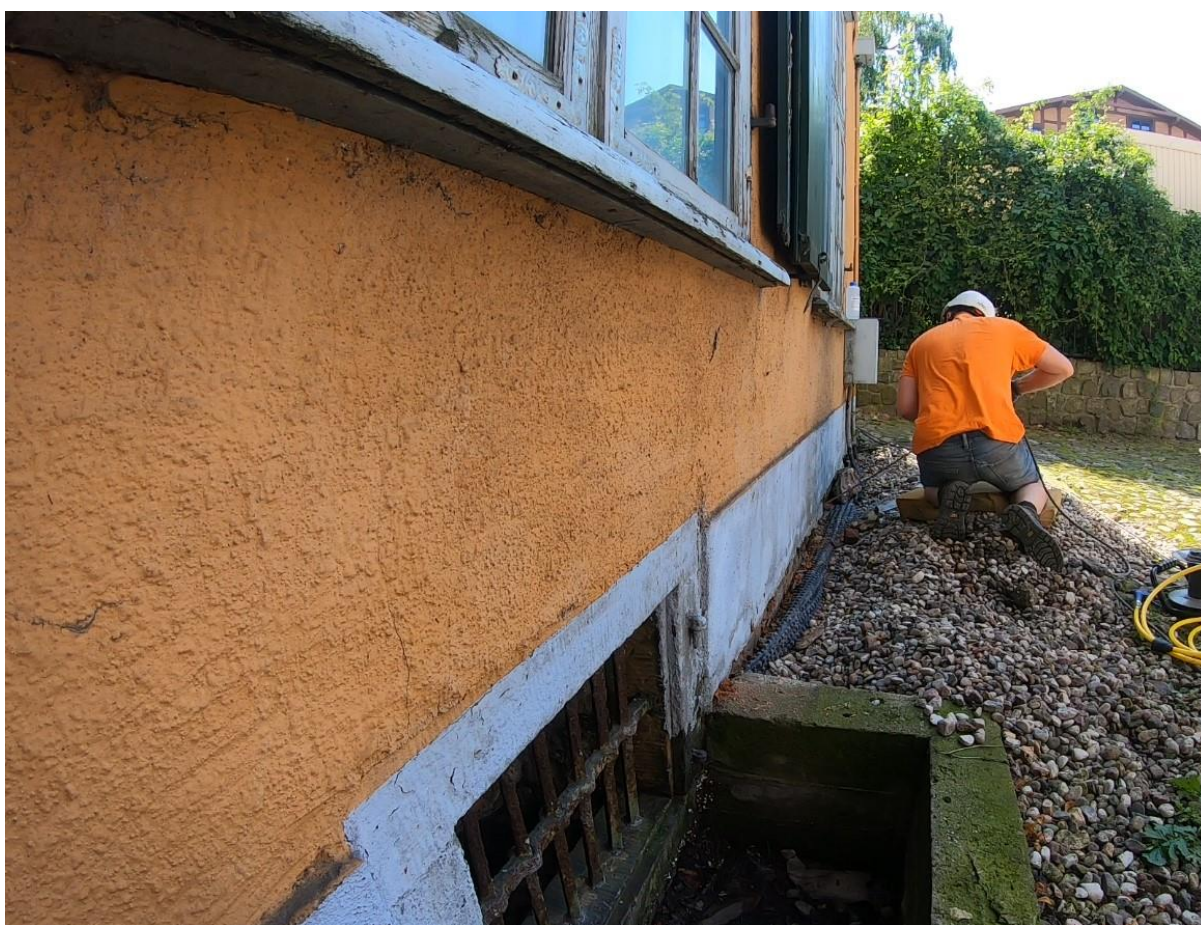
Ilustracja 26. Wykonywanie odwiertów pod iniektory
