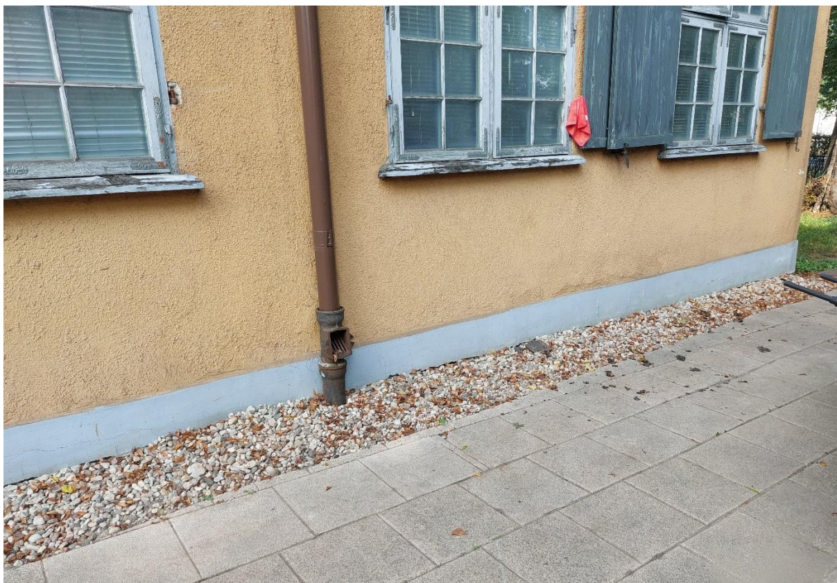
Ilustracja 54. Stan po zakończeniu prac
