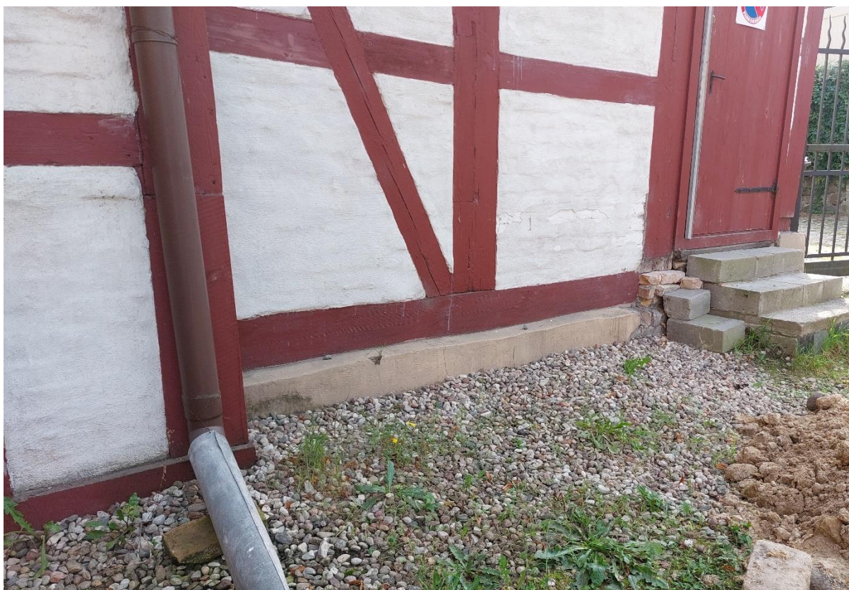
Ilustracja 45. Stan po zakończeniu prac
