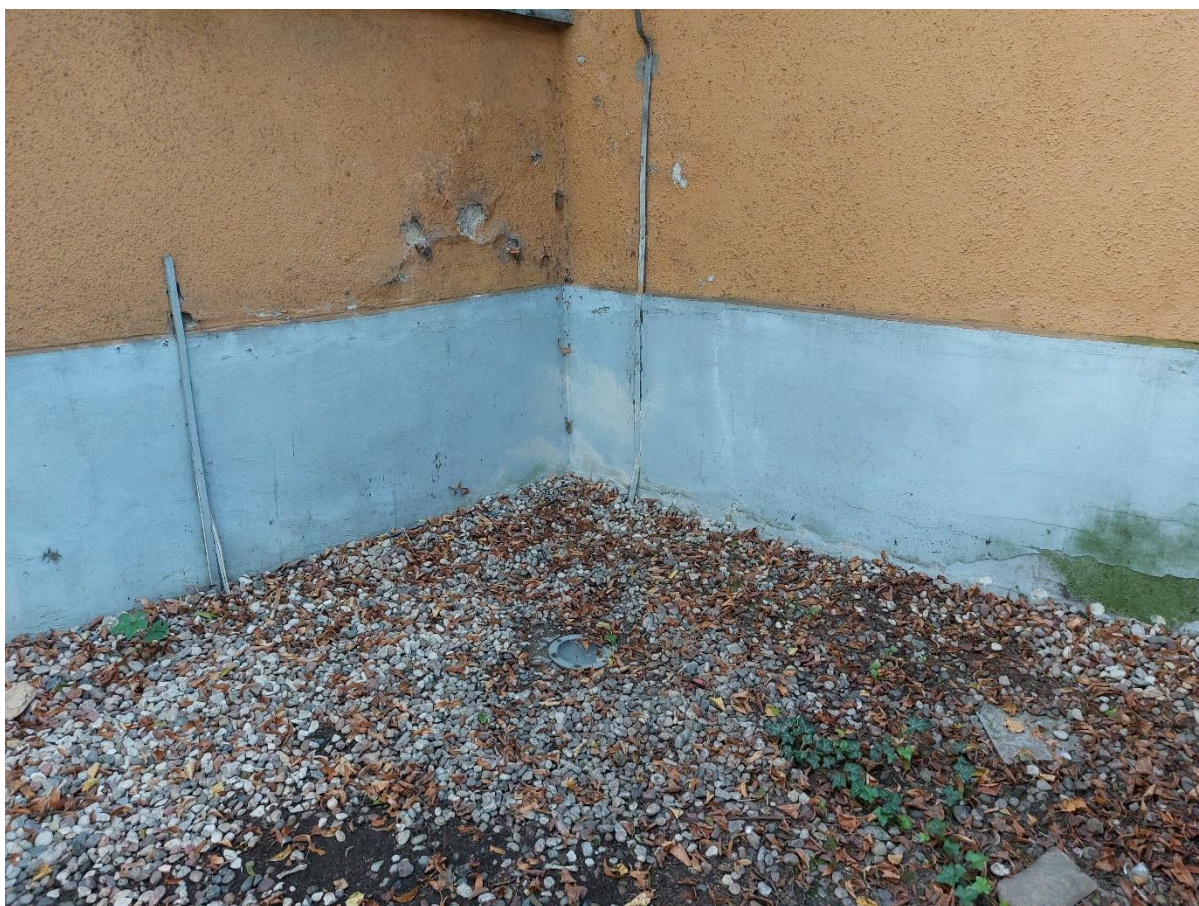
Ilustracja 57. Stan po zakończeniu prac
