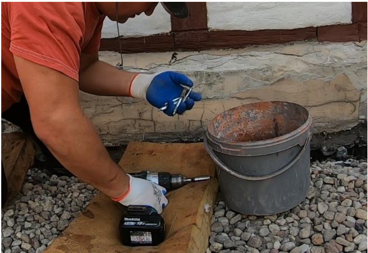
Ilustracja 34. Osadzanie iniektorów w odwiertach
