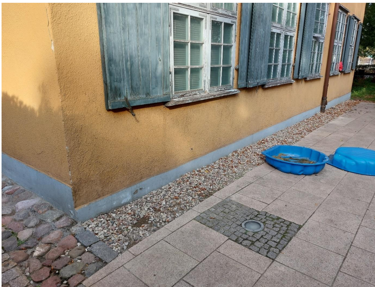
Ilustracja 53. Stan po zakończeniu prac
