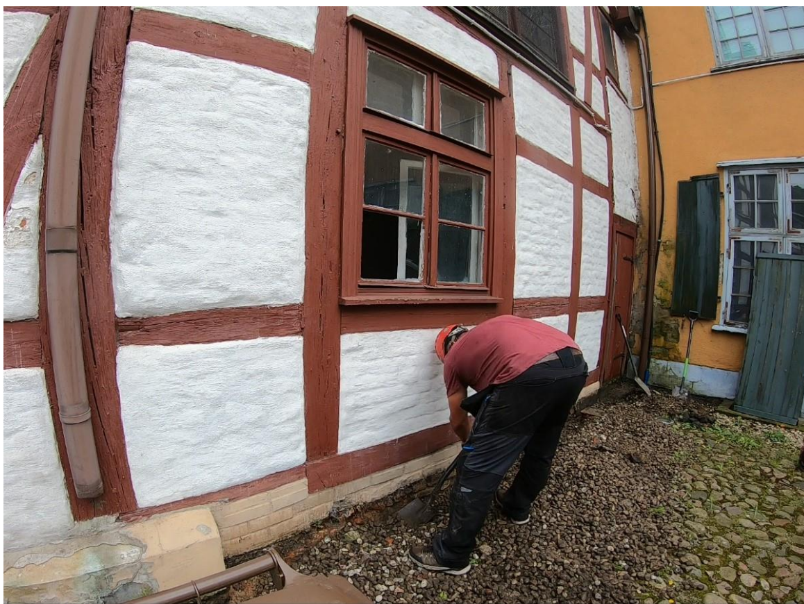
Ilustracja 23. Przygotowania do wykonania odwiertów
