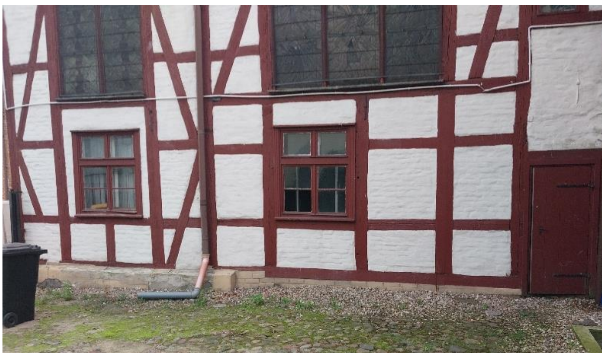
Ilustracja 46. Stan po zakończeniu prac
