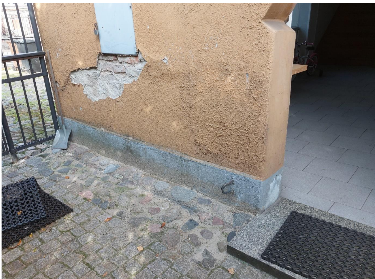
Ilustracja 51. Stan po zakończeniu prac
