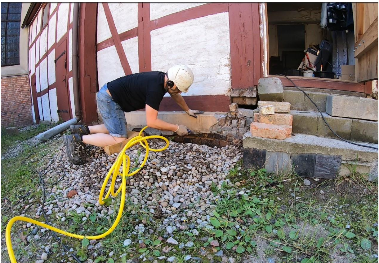
Ilustracja 30. Oczyszczanie odwiertów z materiałów luźnych (przedmuchiwanie)
