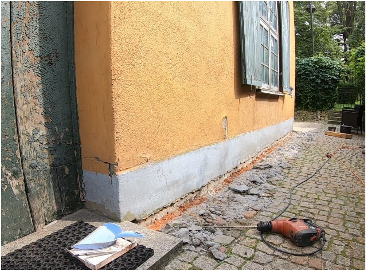
Ilustracja 29. Gotowe odwierty pod iniektory
