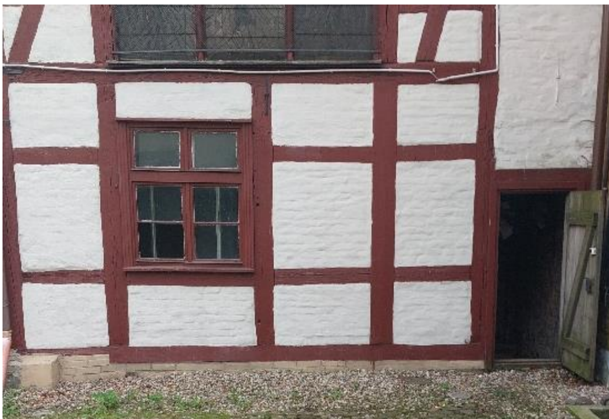
Ilustracja 47. Stan po zakończeniu prac
