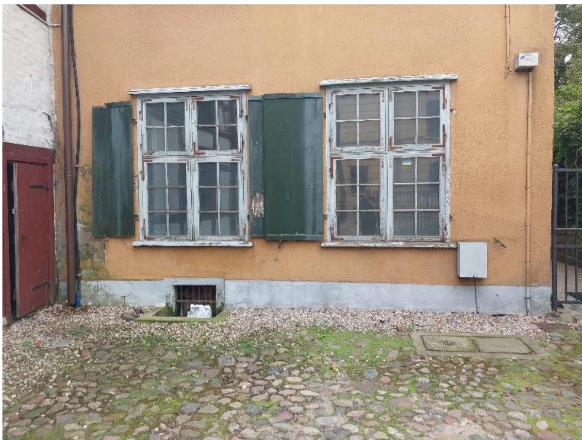
Ilustracja 49. Stan po zakończeniu prac
