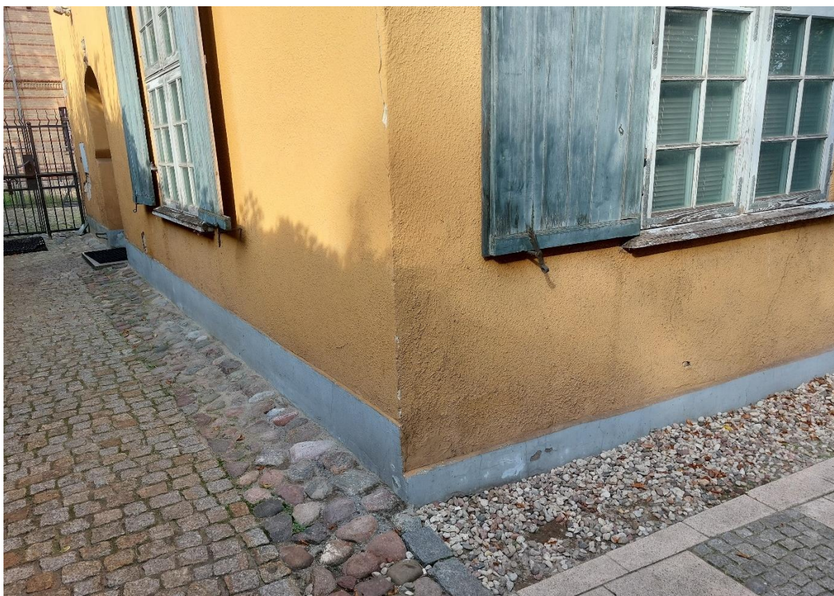
Ilustracja 50. Stan po zakończeniu prac
