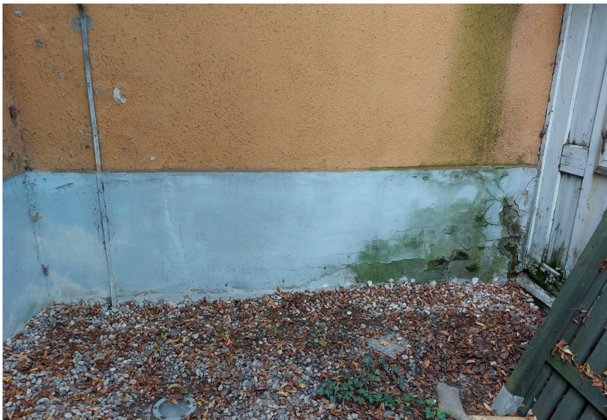
Ilustracja 58. Stan po zakończeniu prac
