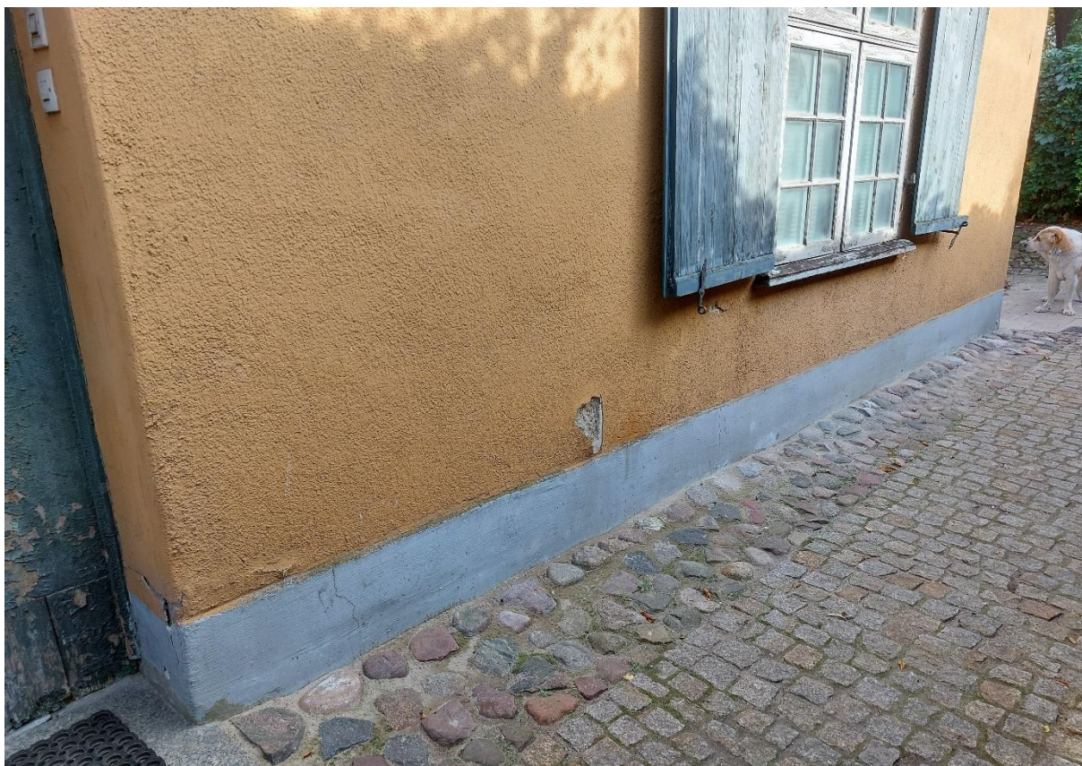
Ilustracja 52. Stan po zakończeniu prac
