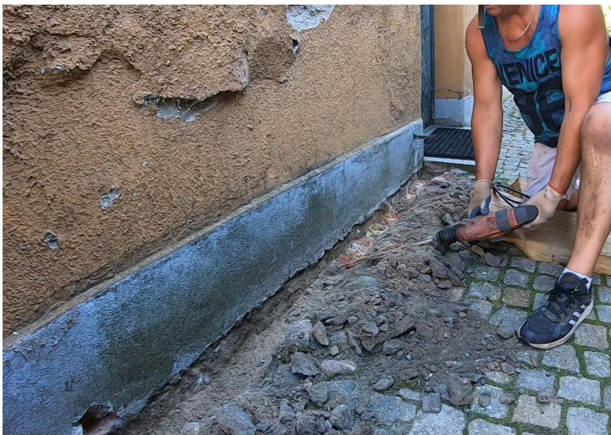
Ilustracja 27. Wykonywanie odwiertów pod iniektory
