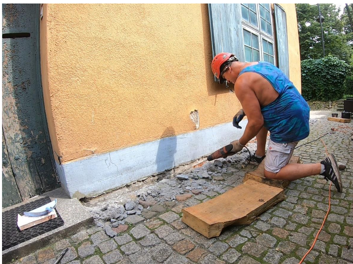
Ilustracja 28. Wykonywanie odwiertów pod iniektory
