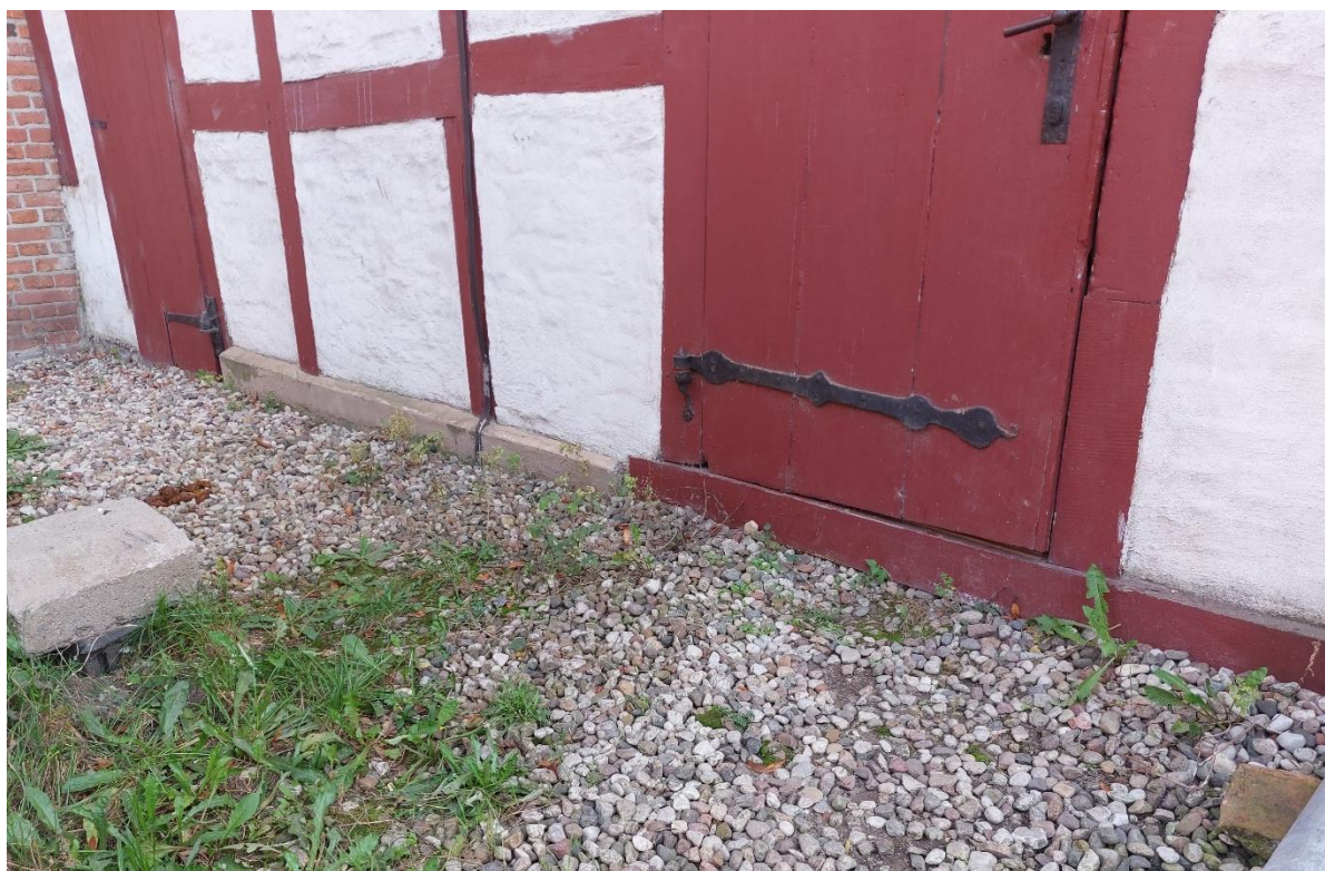
Ilustracja 43. Stan po zakończeniu prac
