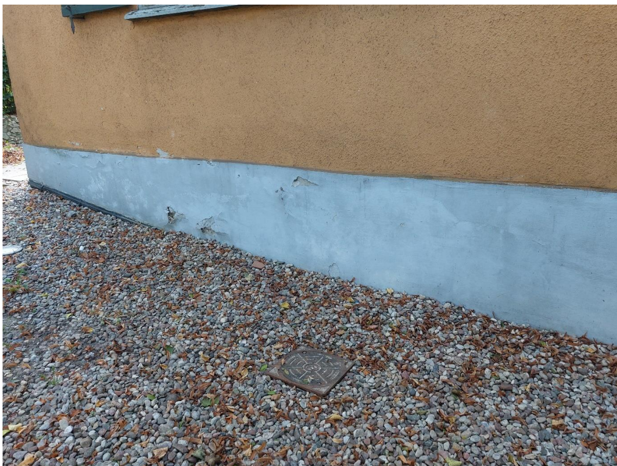
Ilustracja 55. Stan po zakończeniu prac
