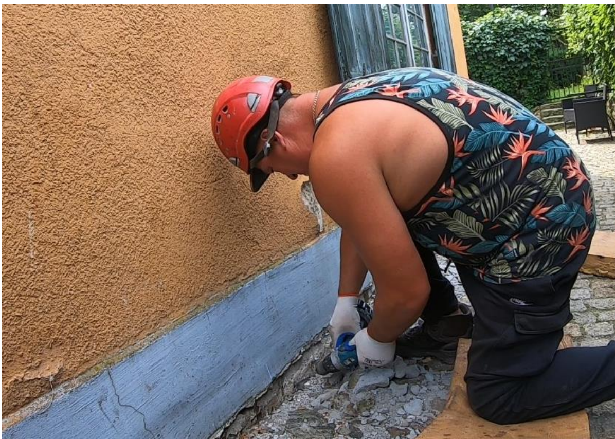
Ilustracja 32. Osadzanie iniektorów w odwiertach
