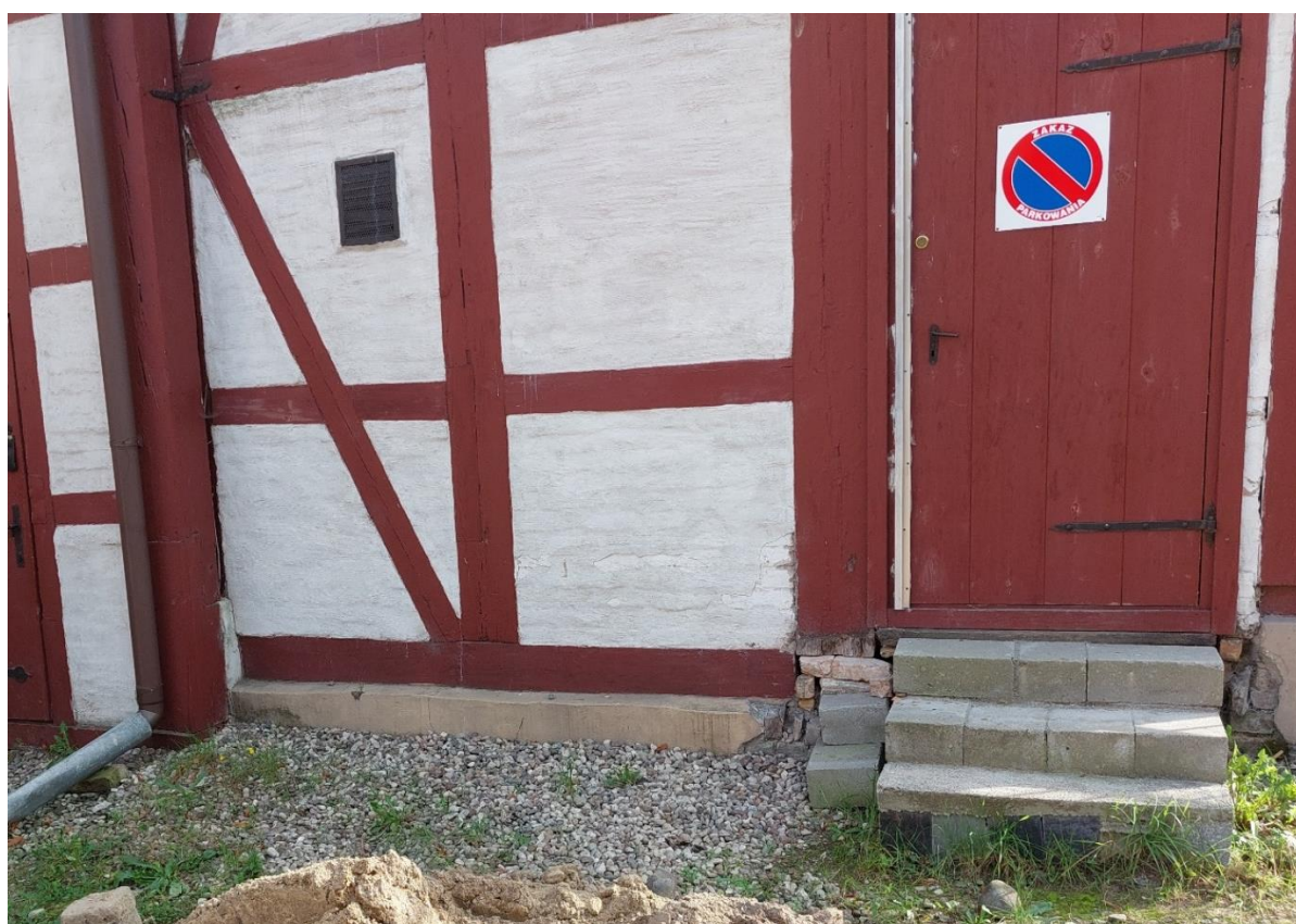
Ilustracja 44. Stan po zakończeniu prac
