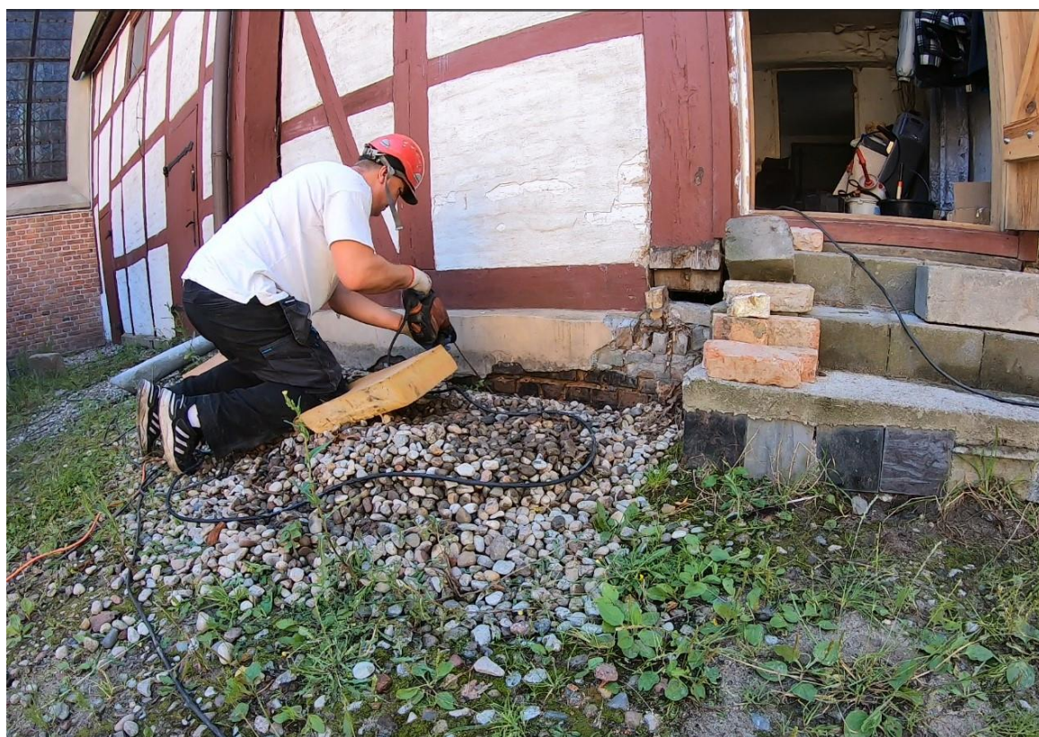
Ilustracja 24. Wykonywanie odwiertów pod iniektory
