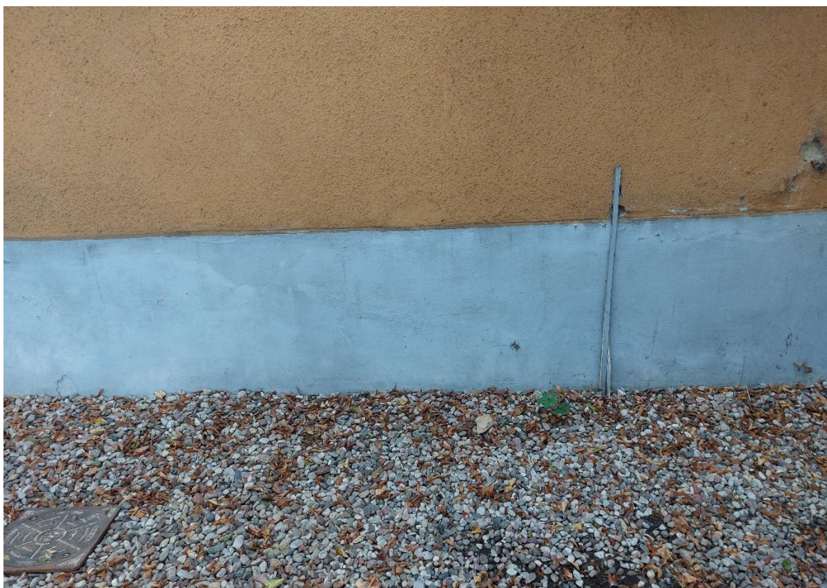
Ilustracja 56. Stan po zakończeniu prac
