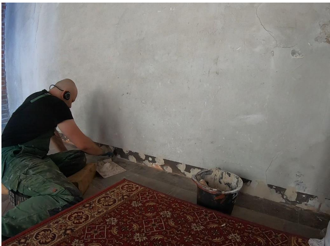
Ilustracja 53. Zabezpieczanie otworów zaprawą
