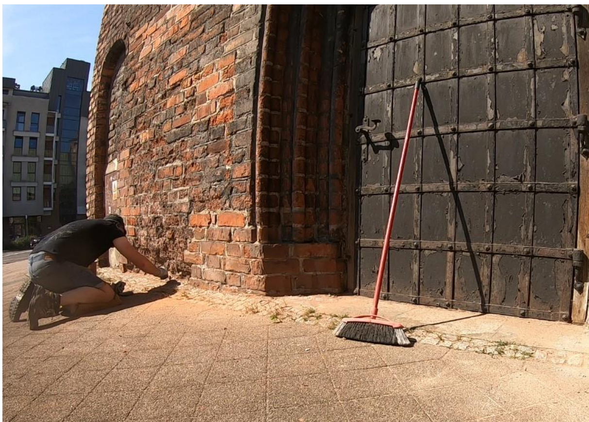
Ilustracja 56. Zabezpieczanie otworów zaprawą
