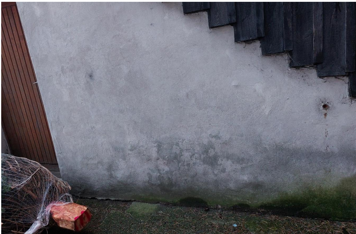
Ilustracja 24. Skutki zawilgocenia
