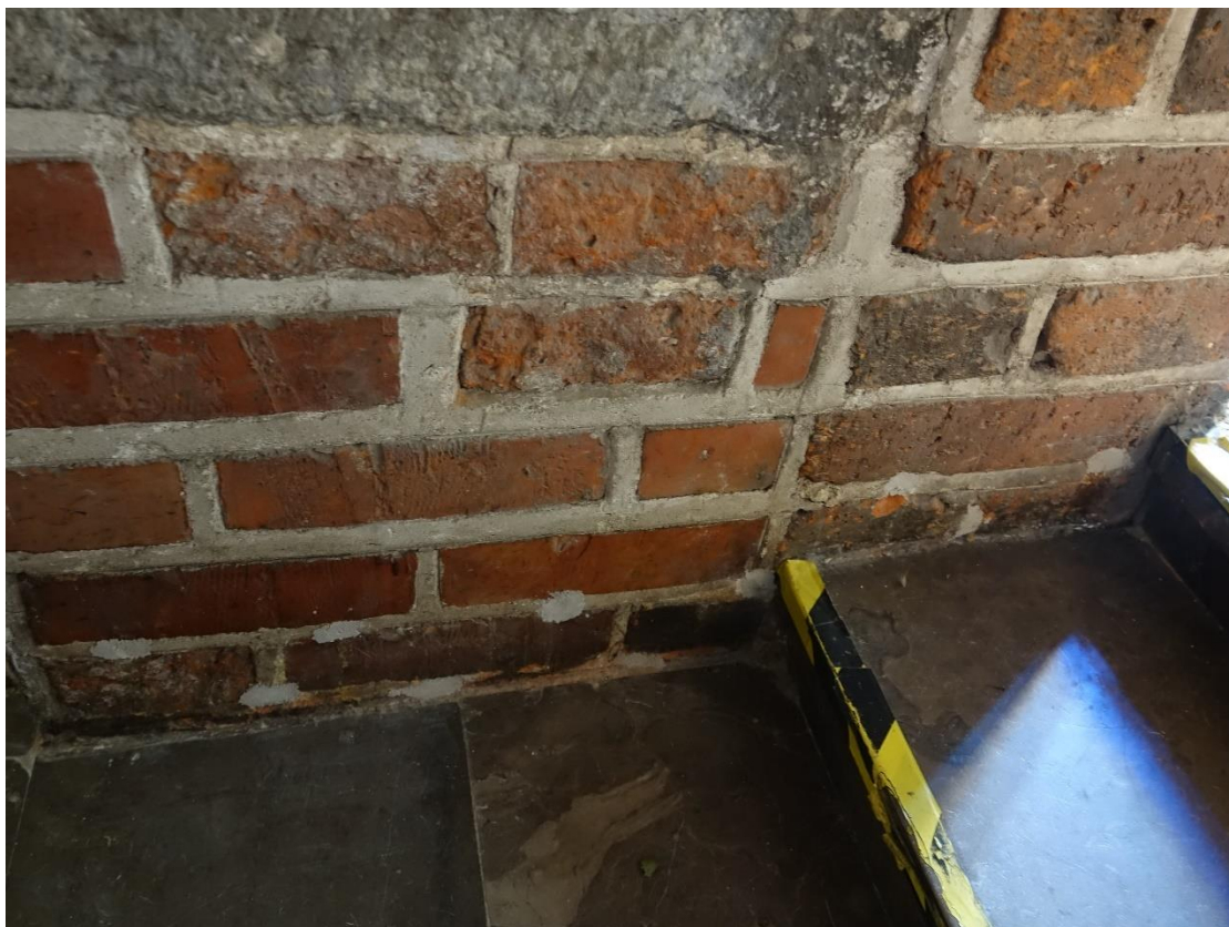
Ilustracja 97. Obiekt po zakończeniu prac (izolacja przeciwwilgociowa)
