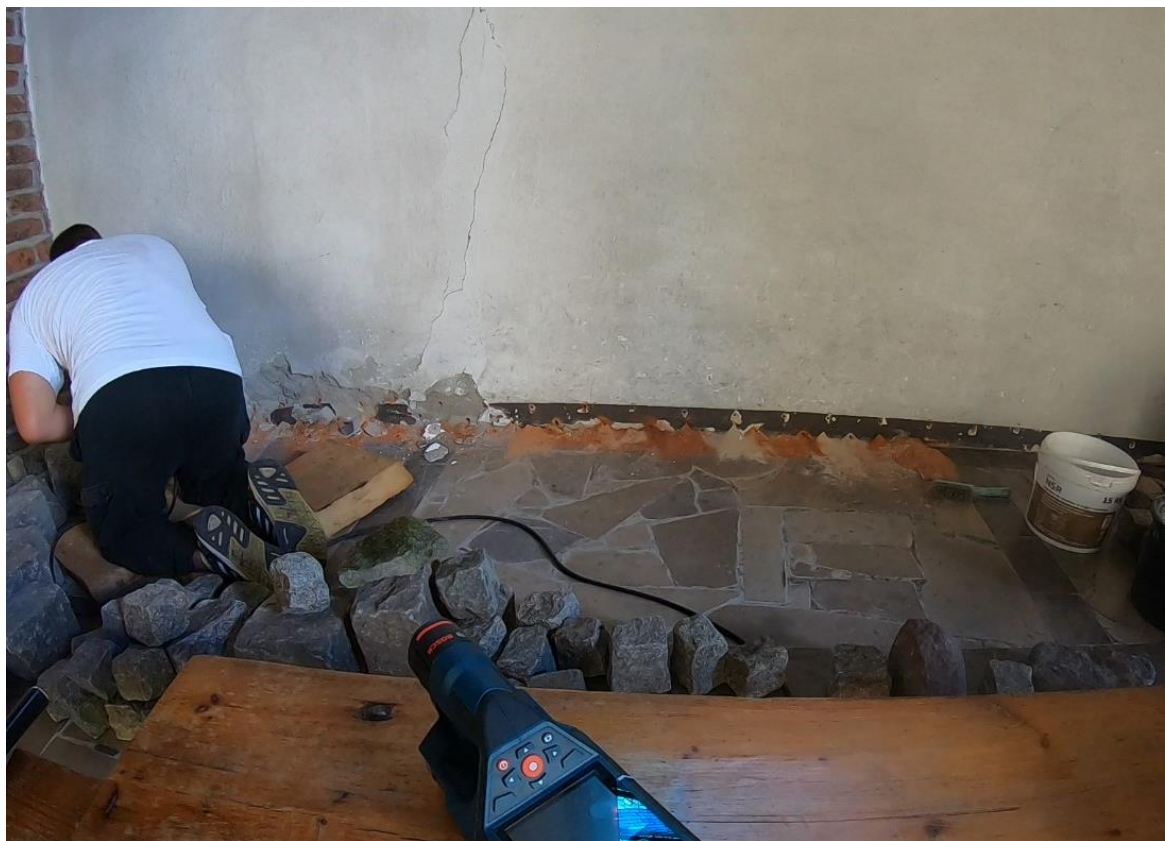
Ilustracja 36. Nawiercanie otworów pod iniektory
