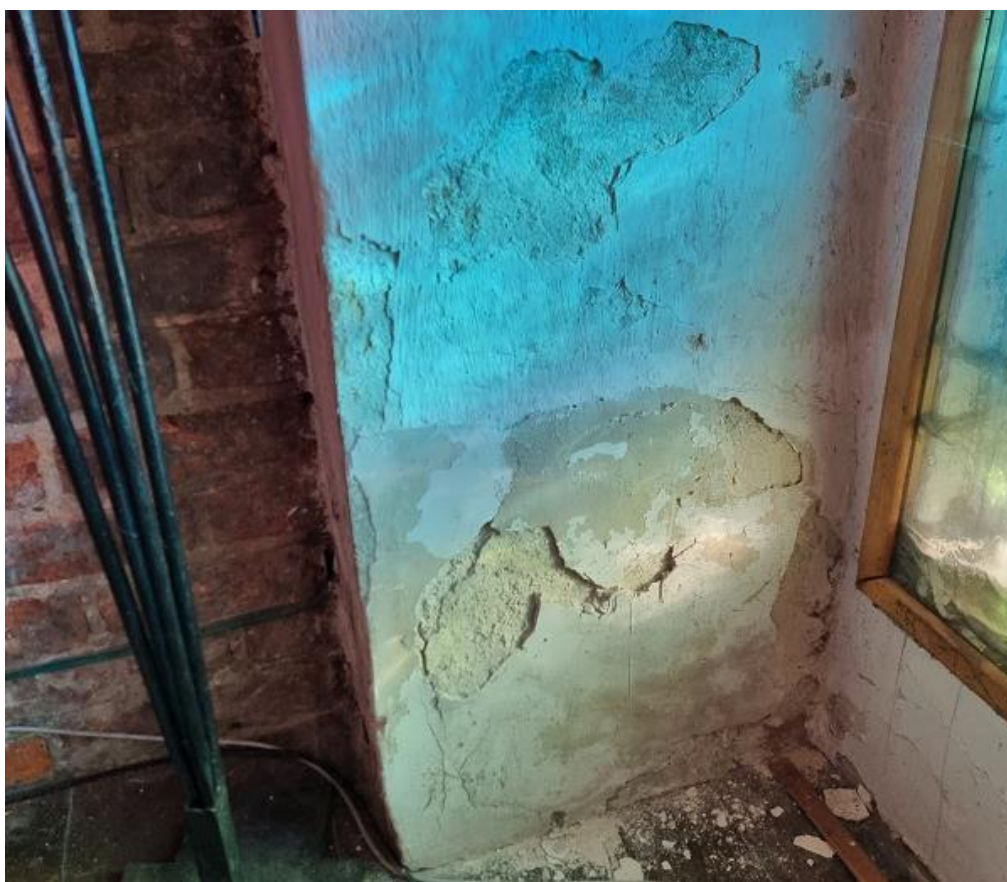
Ilustracja 18. Efekt zawilgocenia
