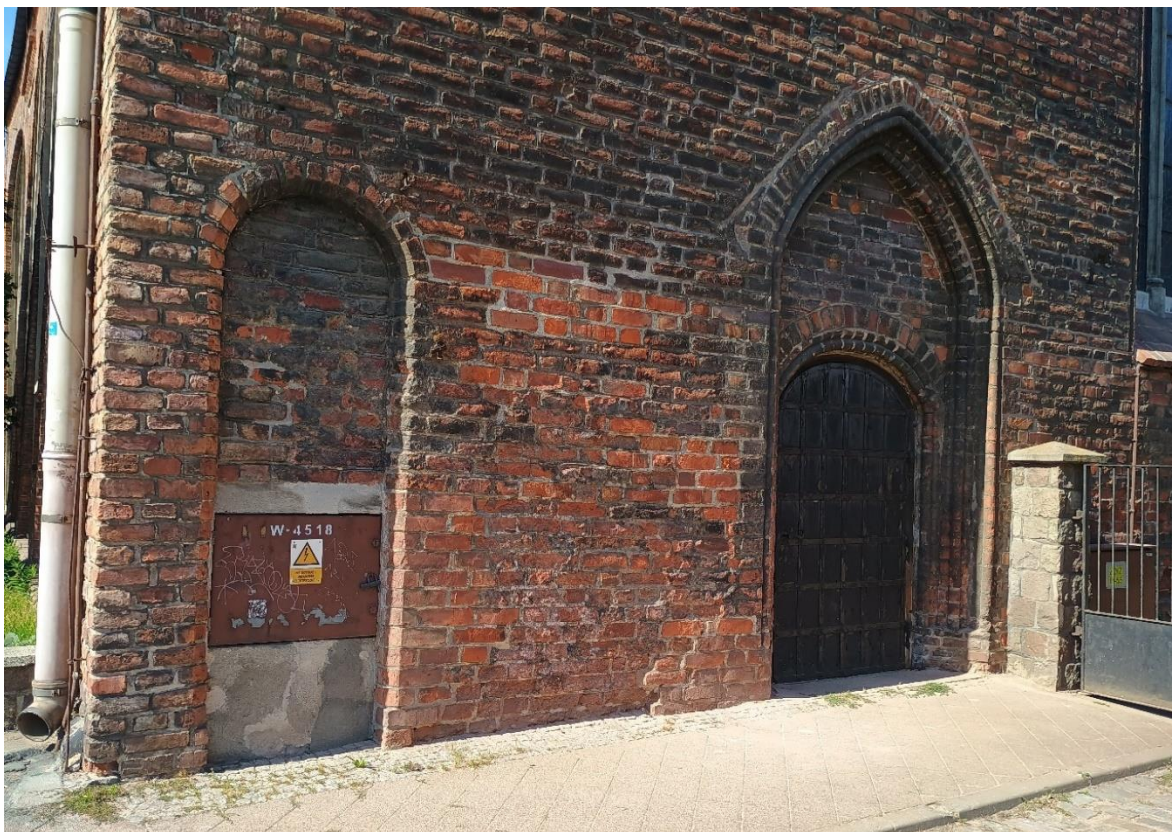
Ilustracja 91. Obiekt po zakończeniu prac (izolacja przeciwwilgociowa)
