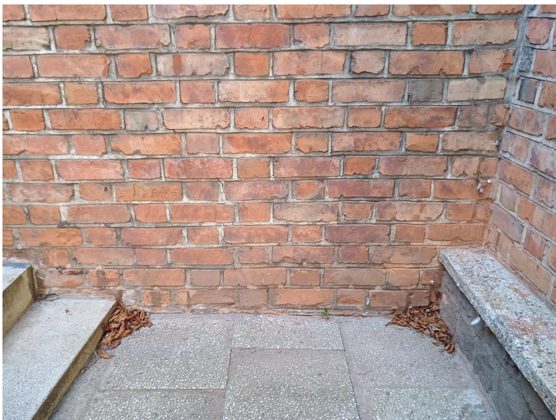
Ilustracja 79. Obiekt po zakończeniu prac (izolacja przeciwwilgociowa)
