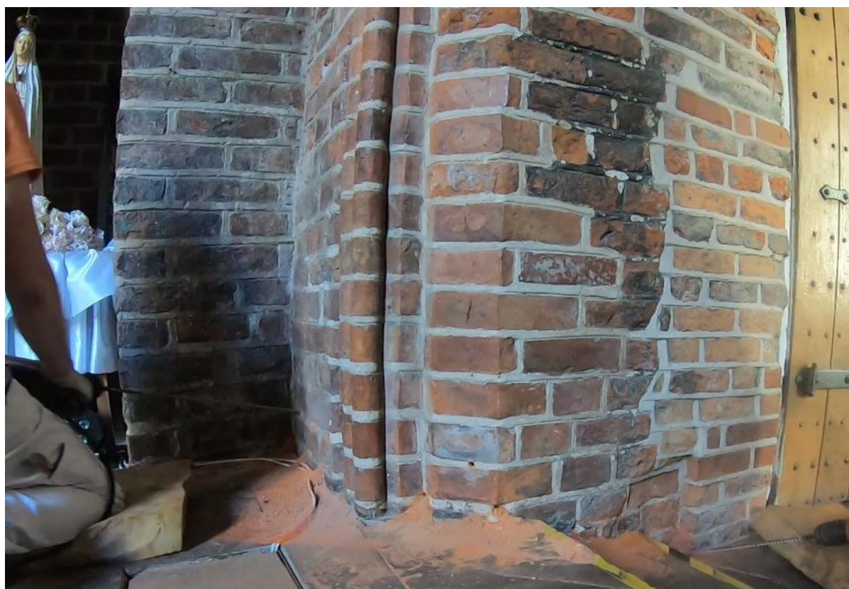
Ilustracja 32. Nawiercanie otworów pod iniektory
