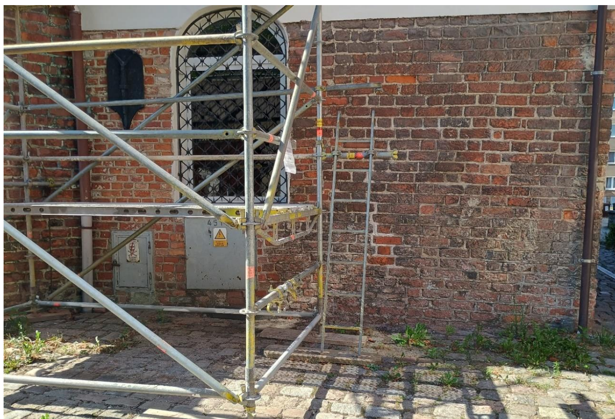
Ilustracja 88. Obiekt po zakończeniu prac (izolacja przeciwwilgociowa)
