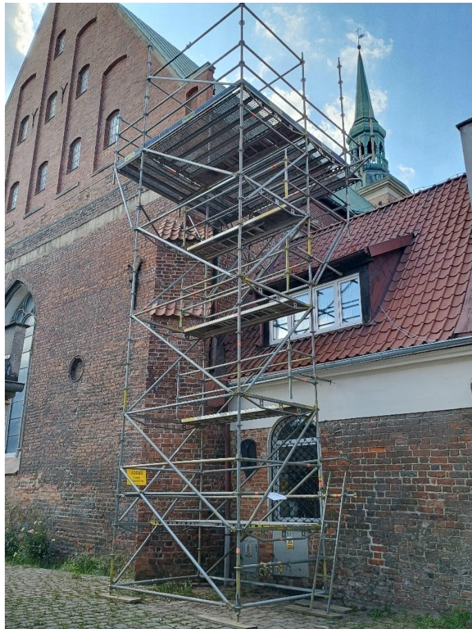
Ilustracja 57. Ustawienie rusztowań z platformą wiertniczą
