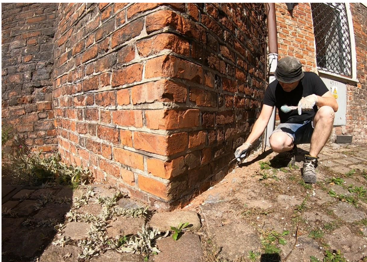
Ilustracja 55. Zabezpieczanie otworów zaprawą
