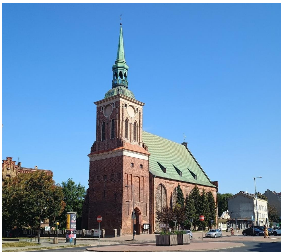
Ilustracja 73. Obiekt po zakończeniu prac
