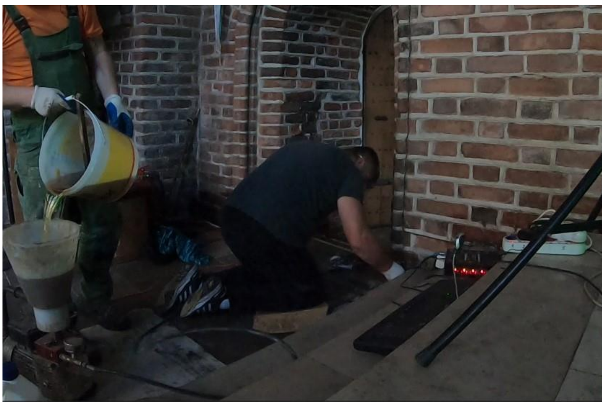
Ilustracja 42. Aplikacja środka iniekcyjnego
