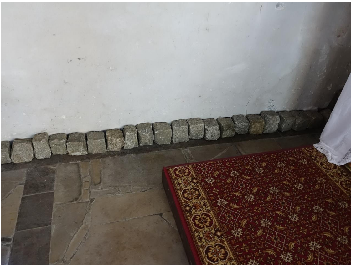
Ilustracja 95. Obiekt po zakończeniu prac (izolacja przeciwwilgociowa)
