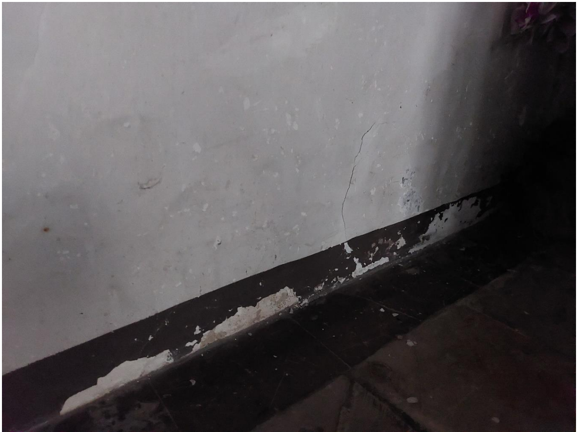
Ilustracja 23. Skutki zawilgocenia: plamy wilgoci i odspajający się tynk
