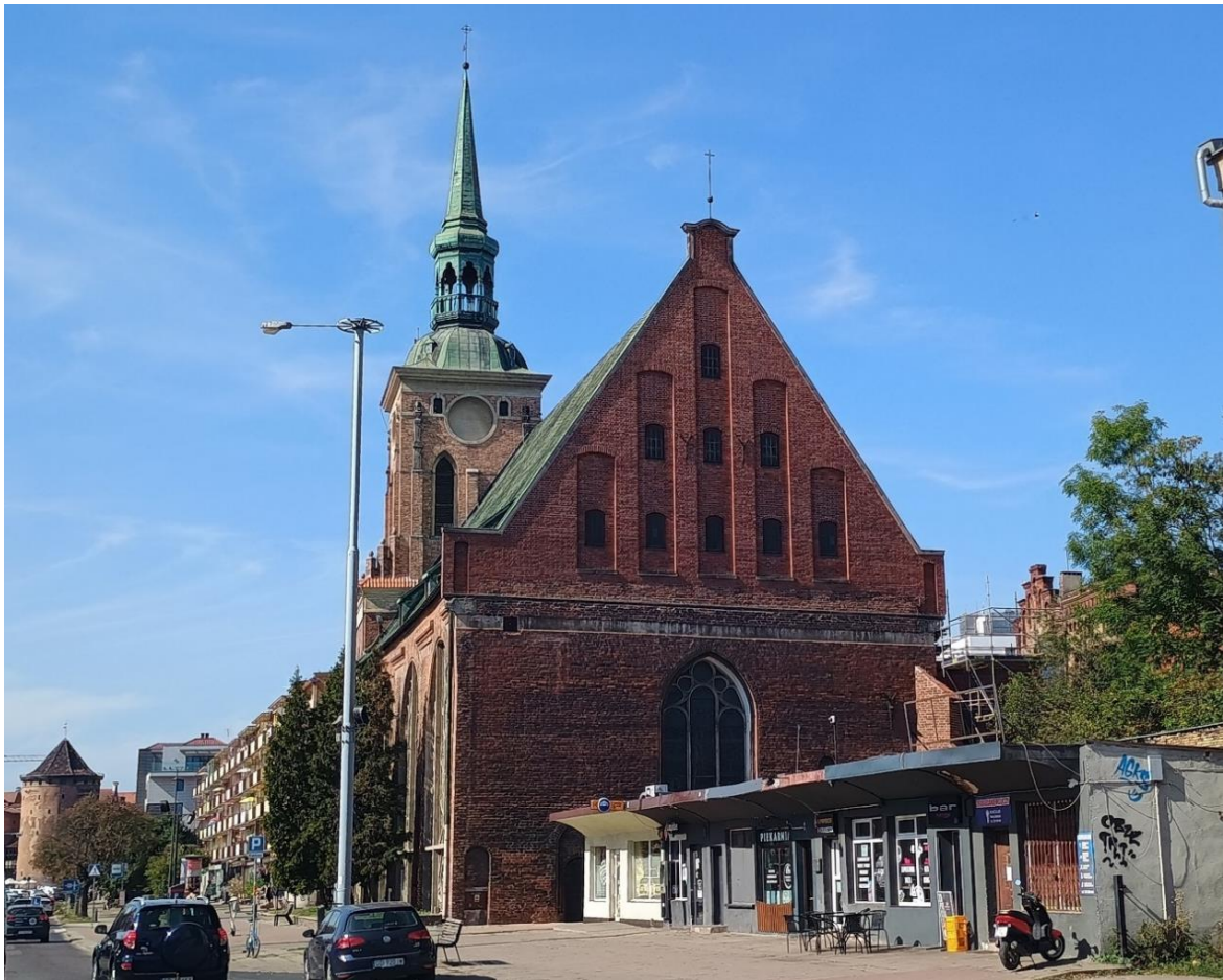
Ilustracja 75. Obiekt po zakończeniu prac
