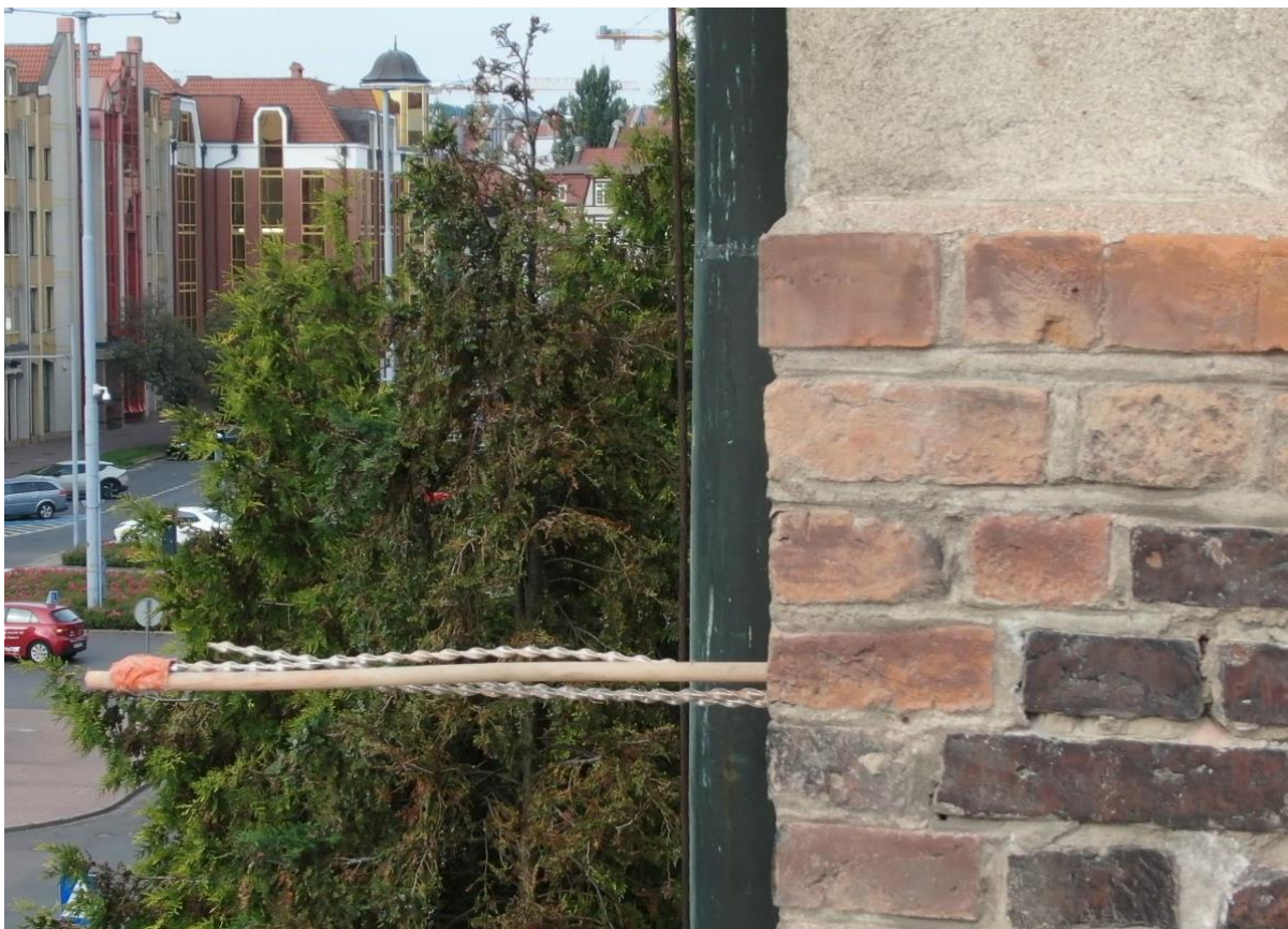
Ilustracja 69. Przejście wiązki prętów przez całą długość muru
