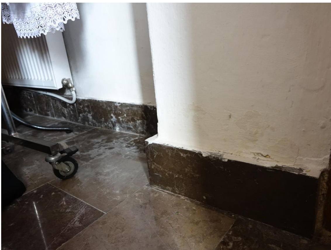
Ilustracja 94. Obiekt po zakończeniu prac (izolacja przeciwwilgociowa)
