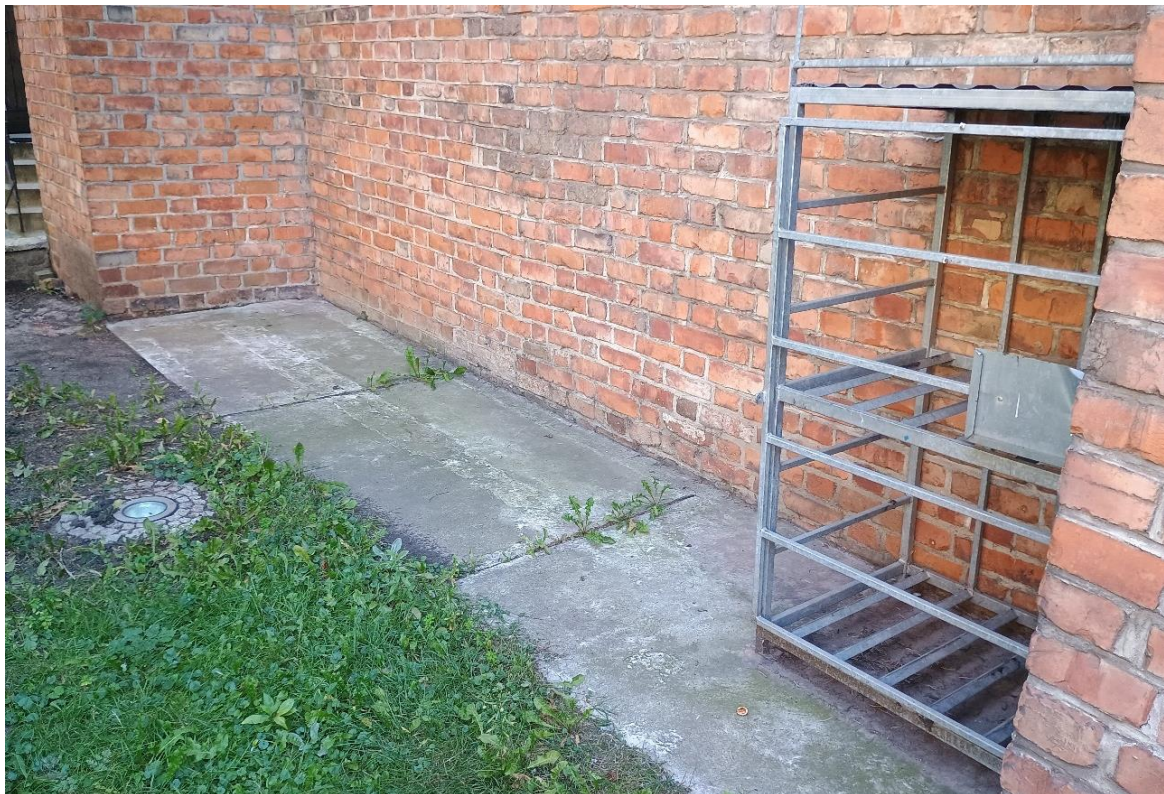
Ilustracja 76. Obiekt po zakończeniu prac (izolacja przeciwwilgociowa)
