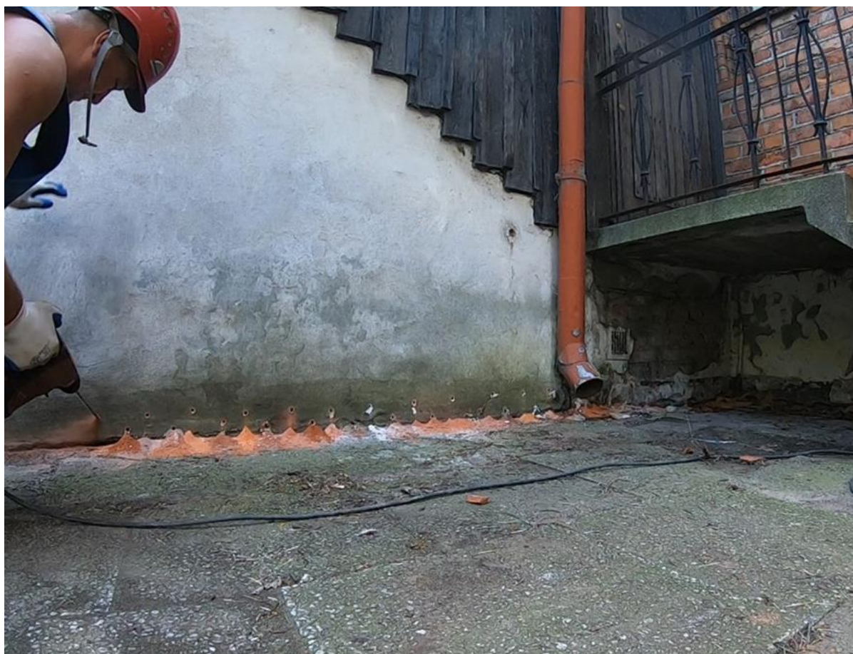
Ilustracja 27. Nawiercanie otworów pod iniektory
