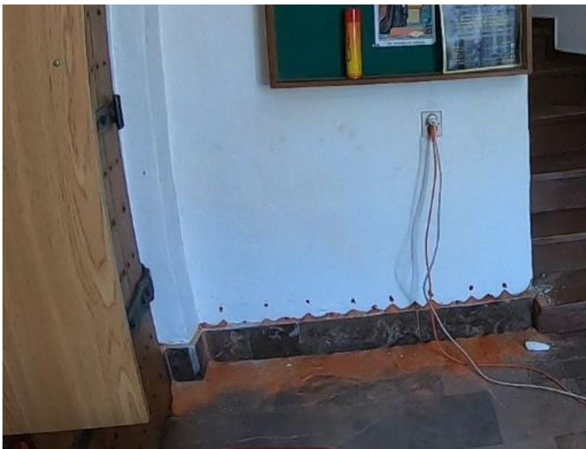
Ilustracja 33. Otwory pod iniektory
