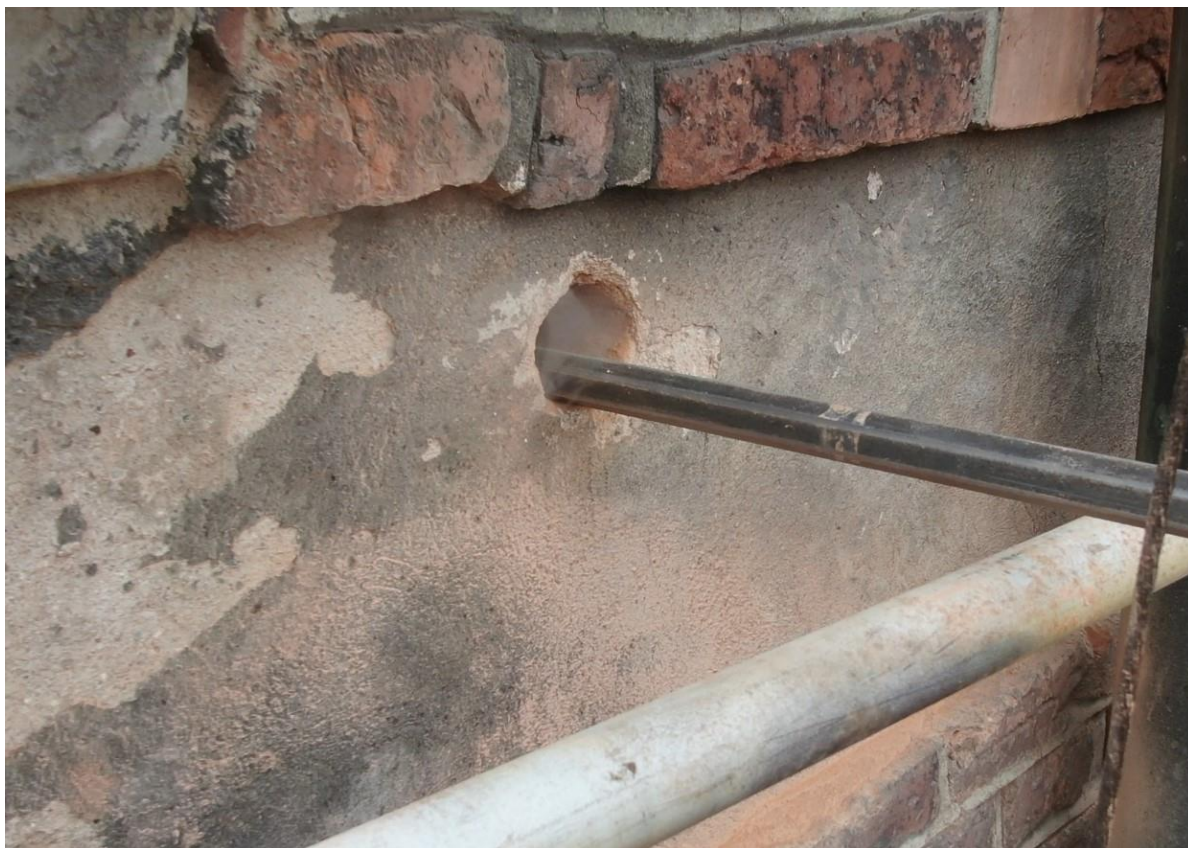
Ilustracja 61. Wykonywanie odwiertu w strefie rdzeniowej muru
