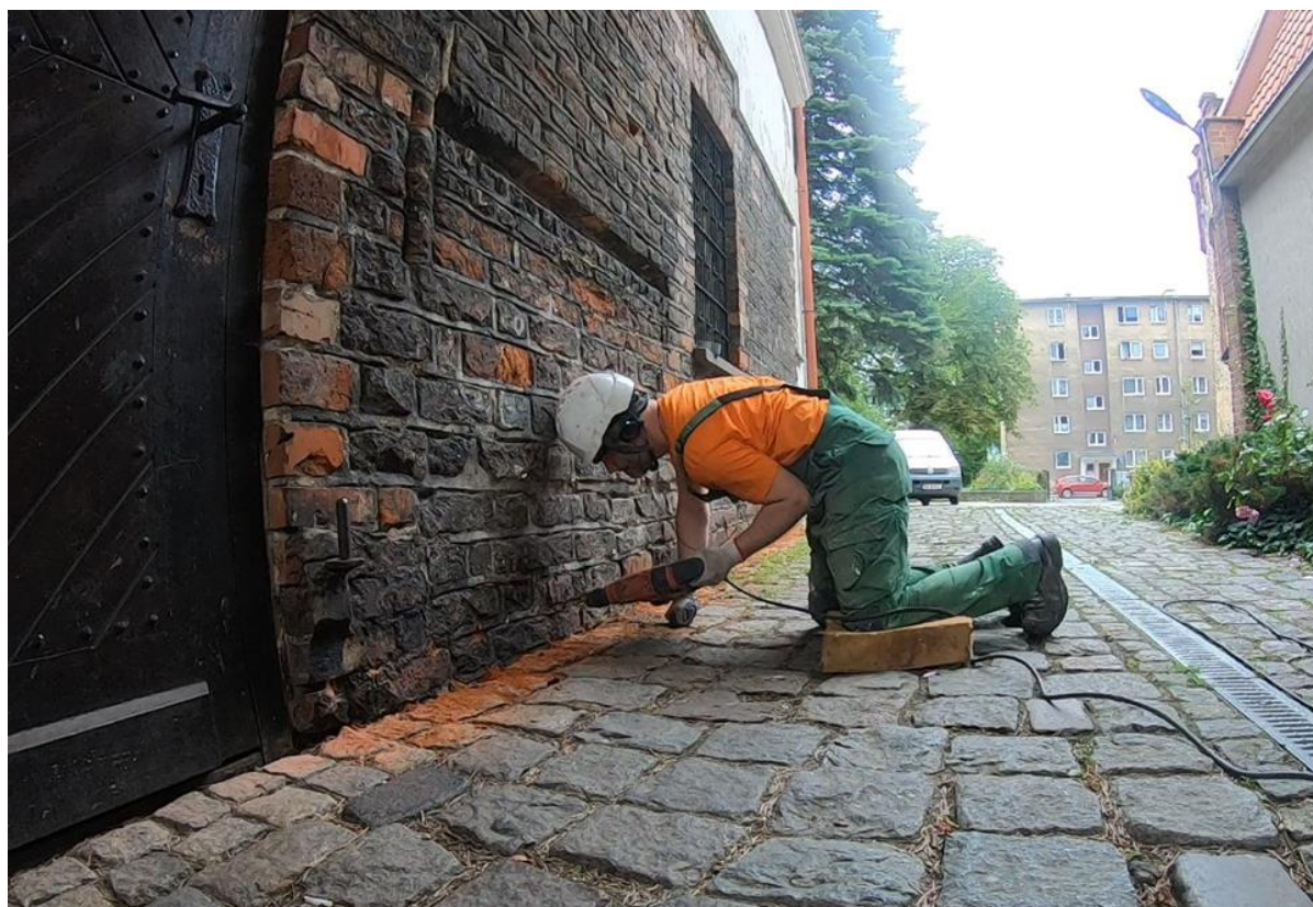
Ilustracja 28. Nawiercanie otworów pod iniektory
