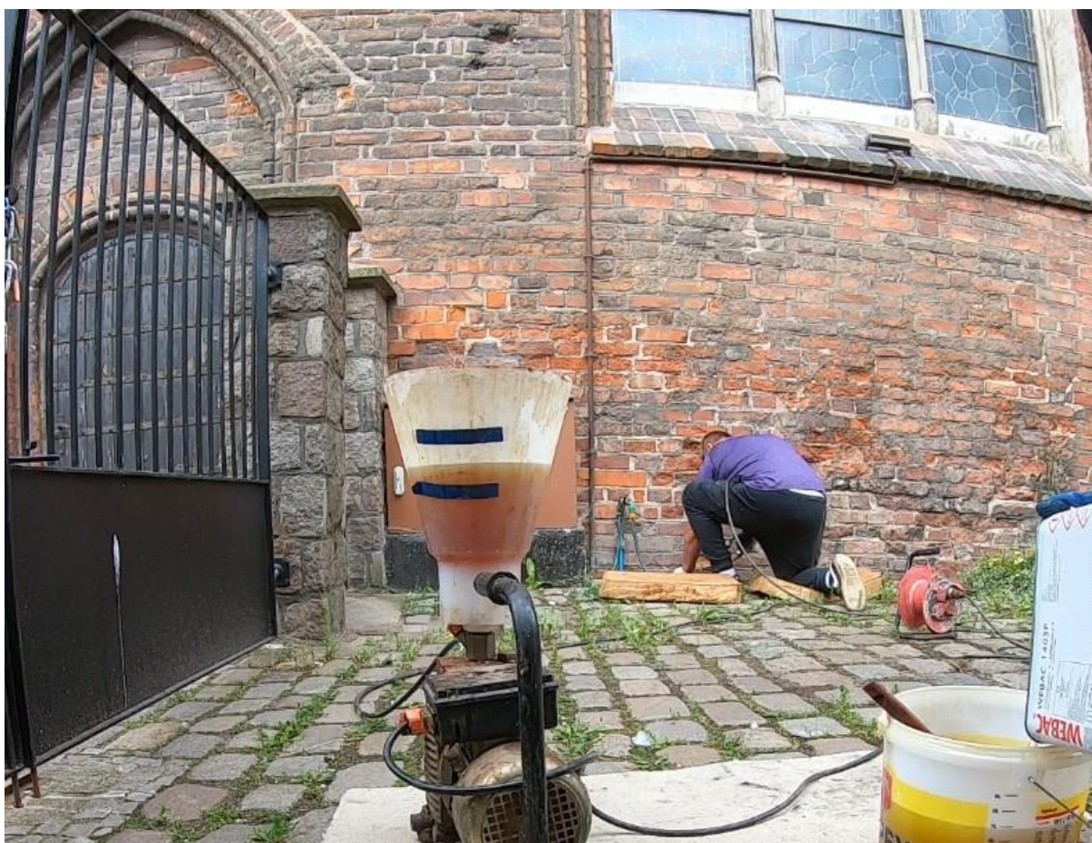
Ilustracja 50. Aplikacja środka iniekcyjnego
