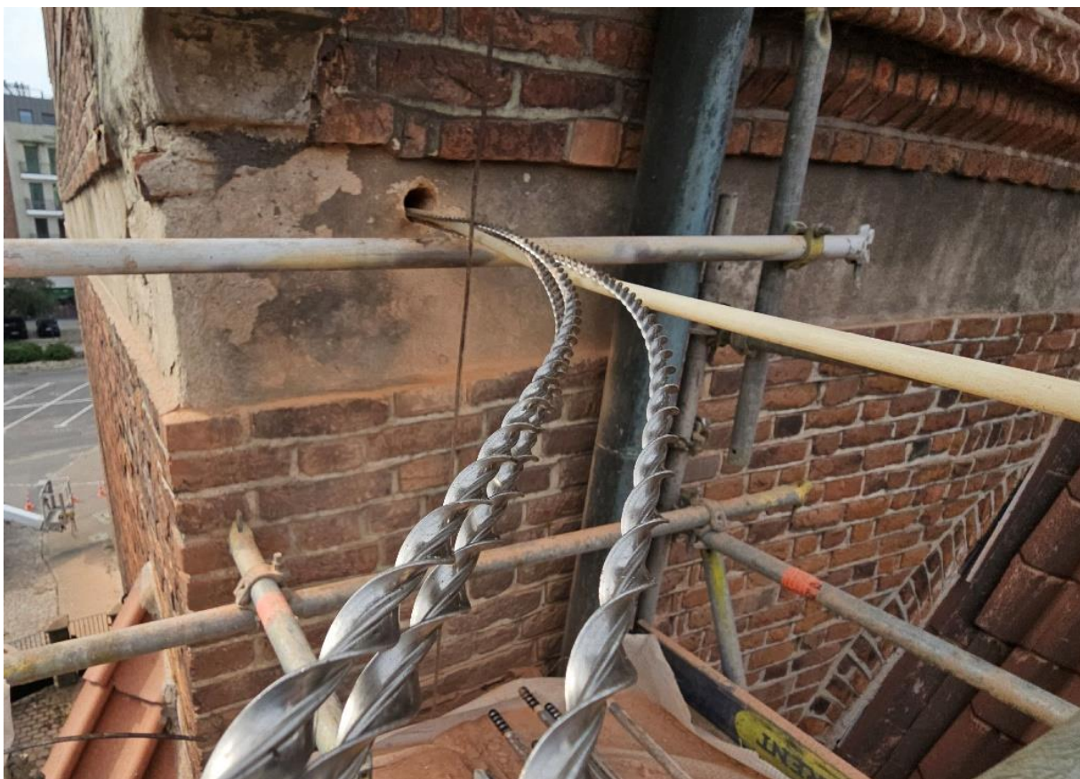
Ilustracja 66. Wprowadzanie wiązki trzech prętów spiralnych
