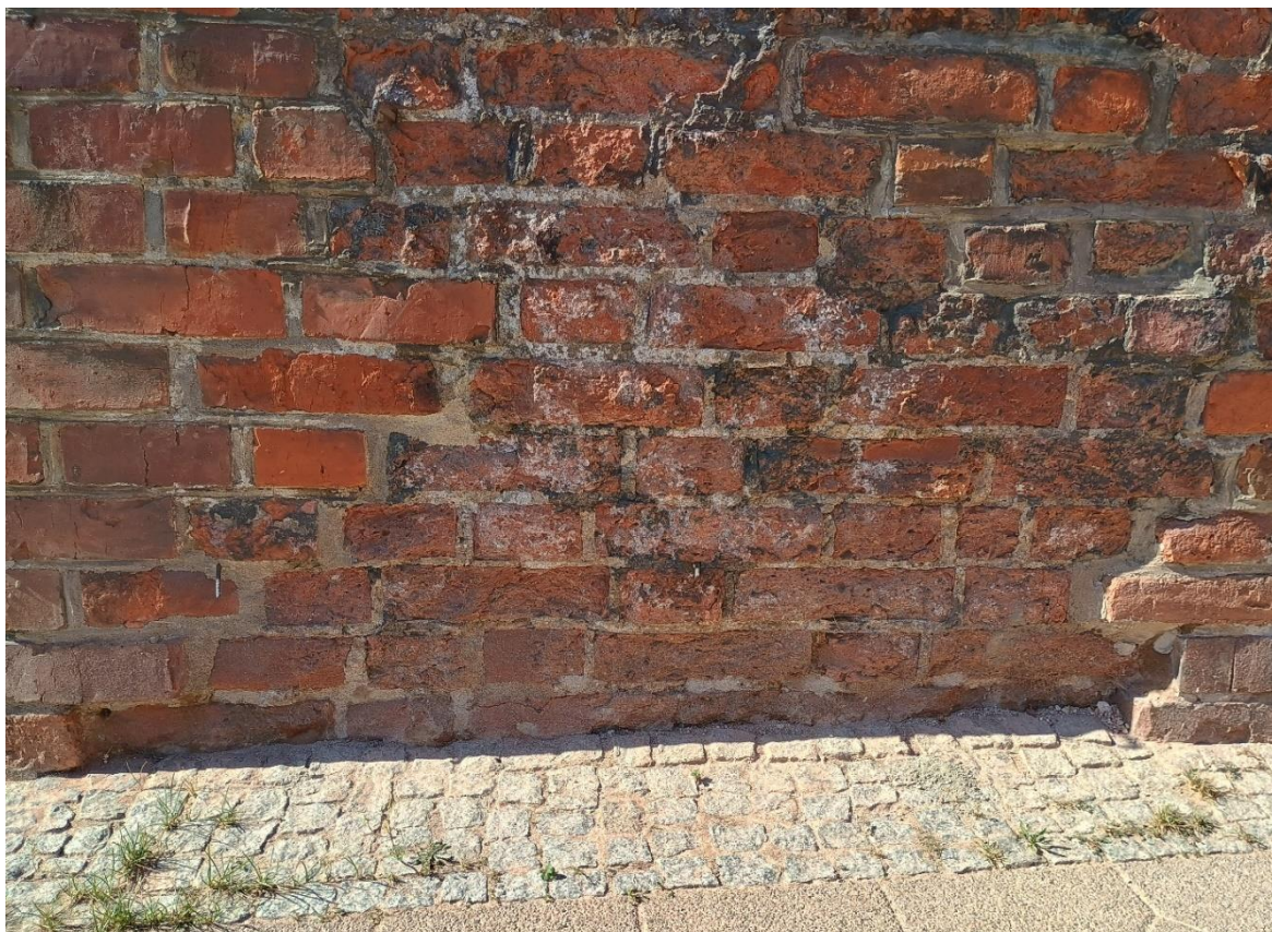
Ilustracja 92. Obiekt po zakończeniu prac (izolacja przeciwwilgociowa)
