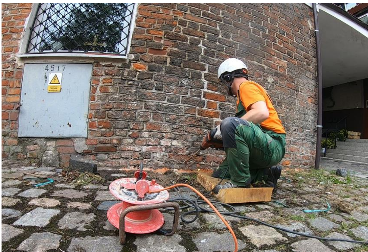
Ilustracja 30. Nawiercanie otworów pod iniektory
