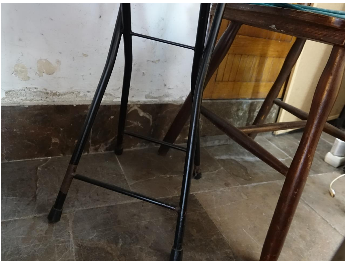
Ilustracja 96. Obiekt po zakończeniu prac (izolacja przeciwwilgociowa)
