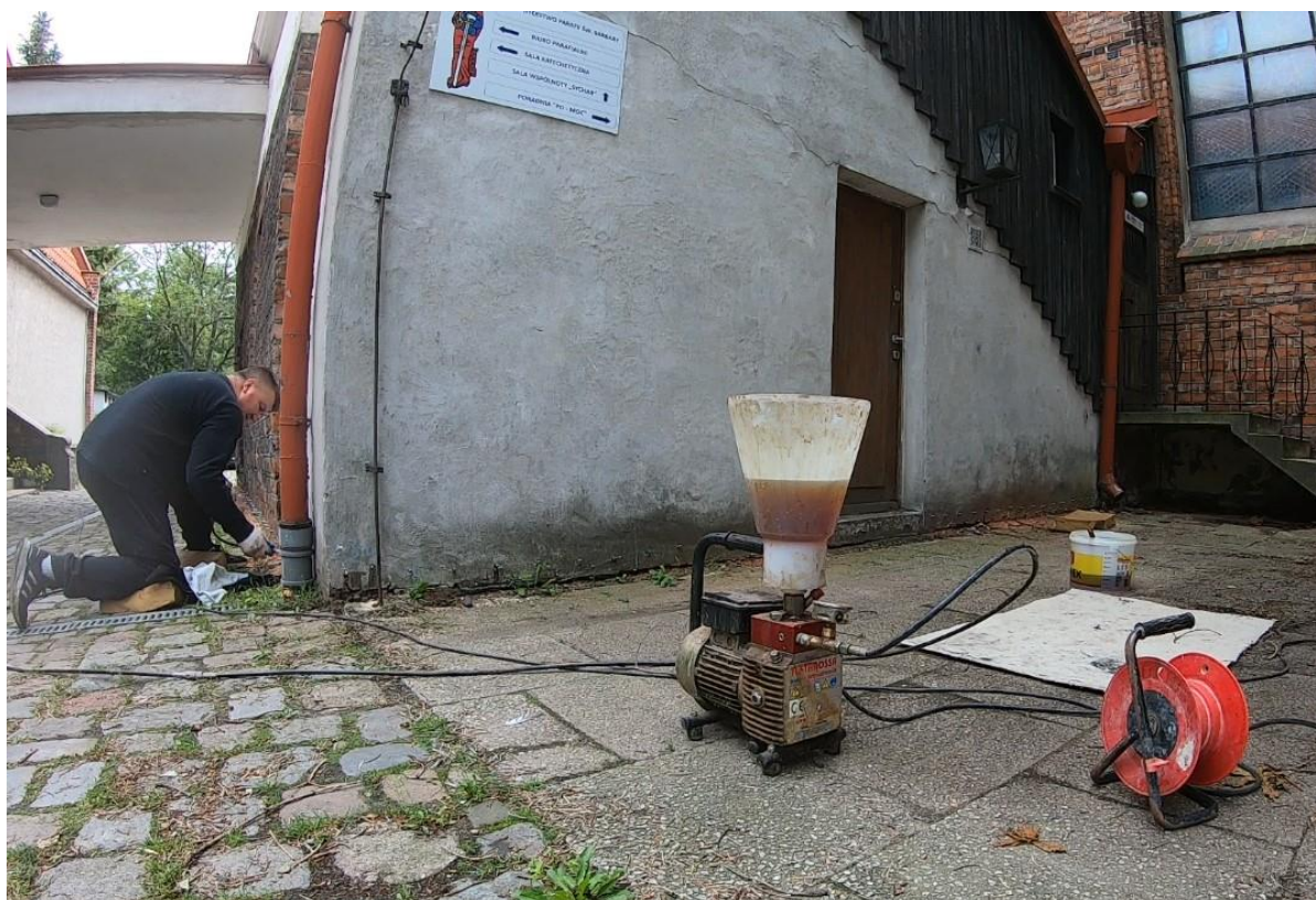
Ilustracja 48. Aplikacja środka iniekcyjnego
