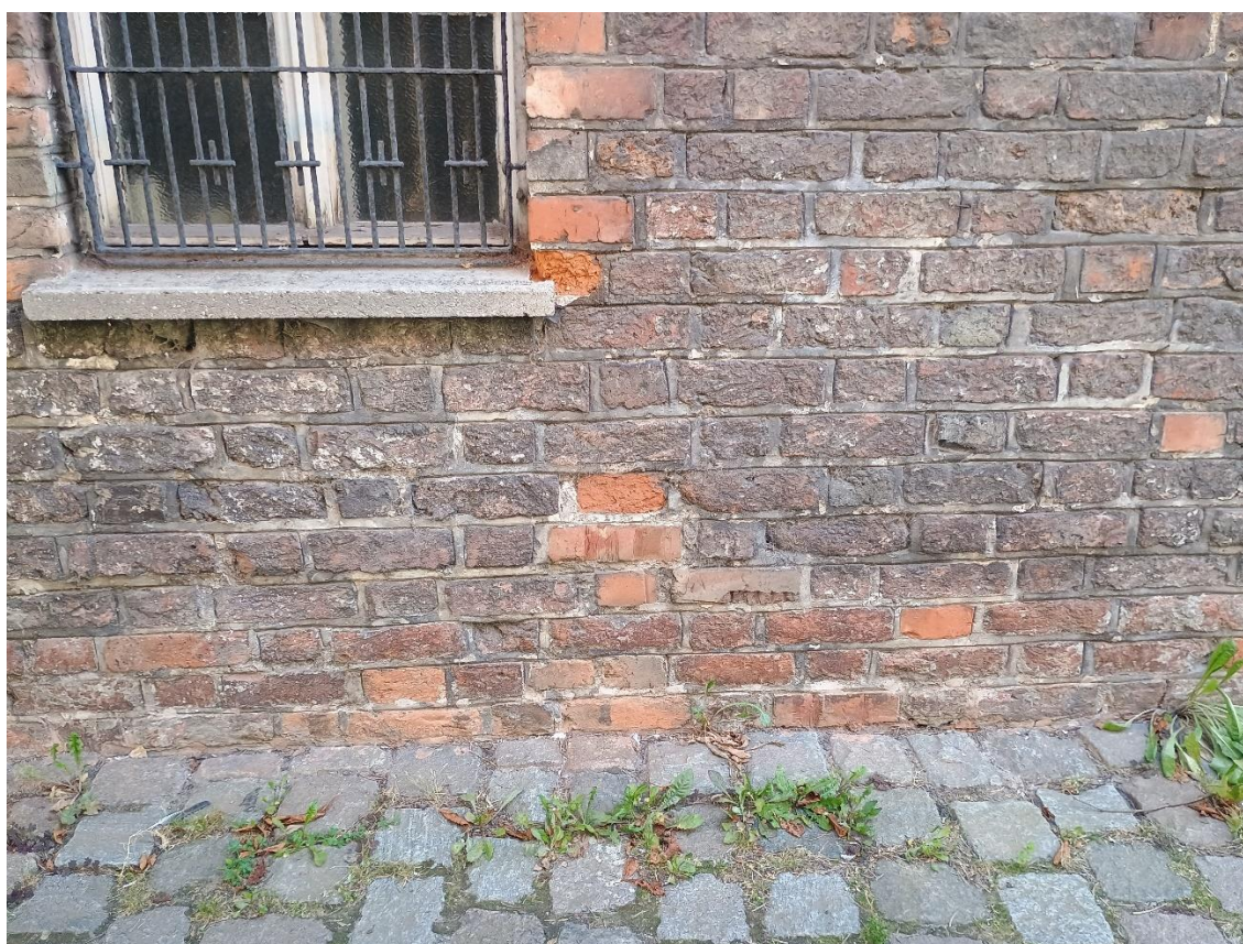
Ilustracja 86. Obiekt po zakończeniu prac (izolacja przeciwwilgociowa)
