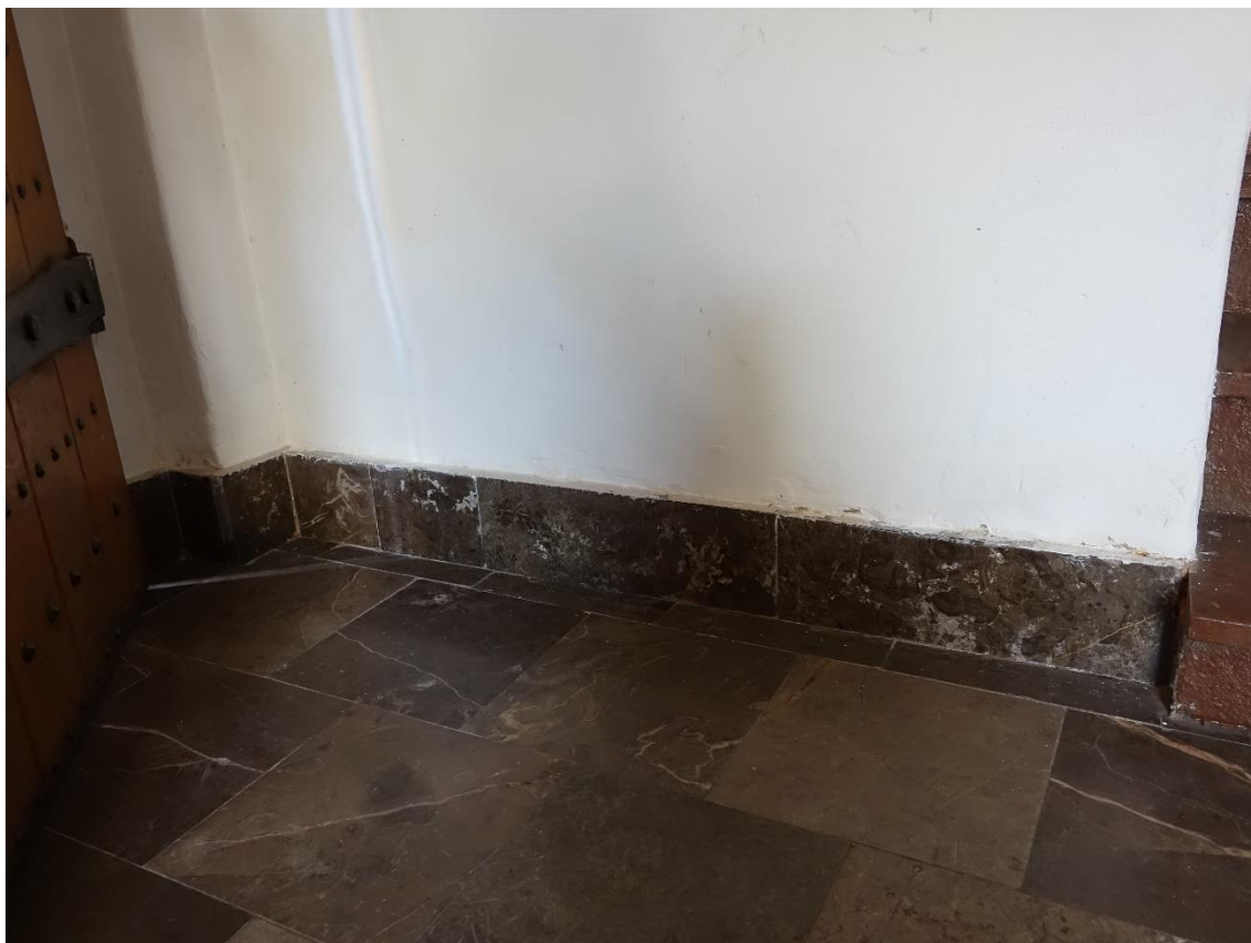
Ilustracja 93. Obiekt po zakończeniu prac (izolacja przeciwwilgociowa)
