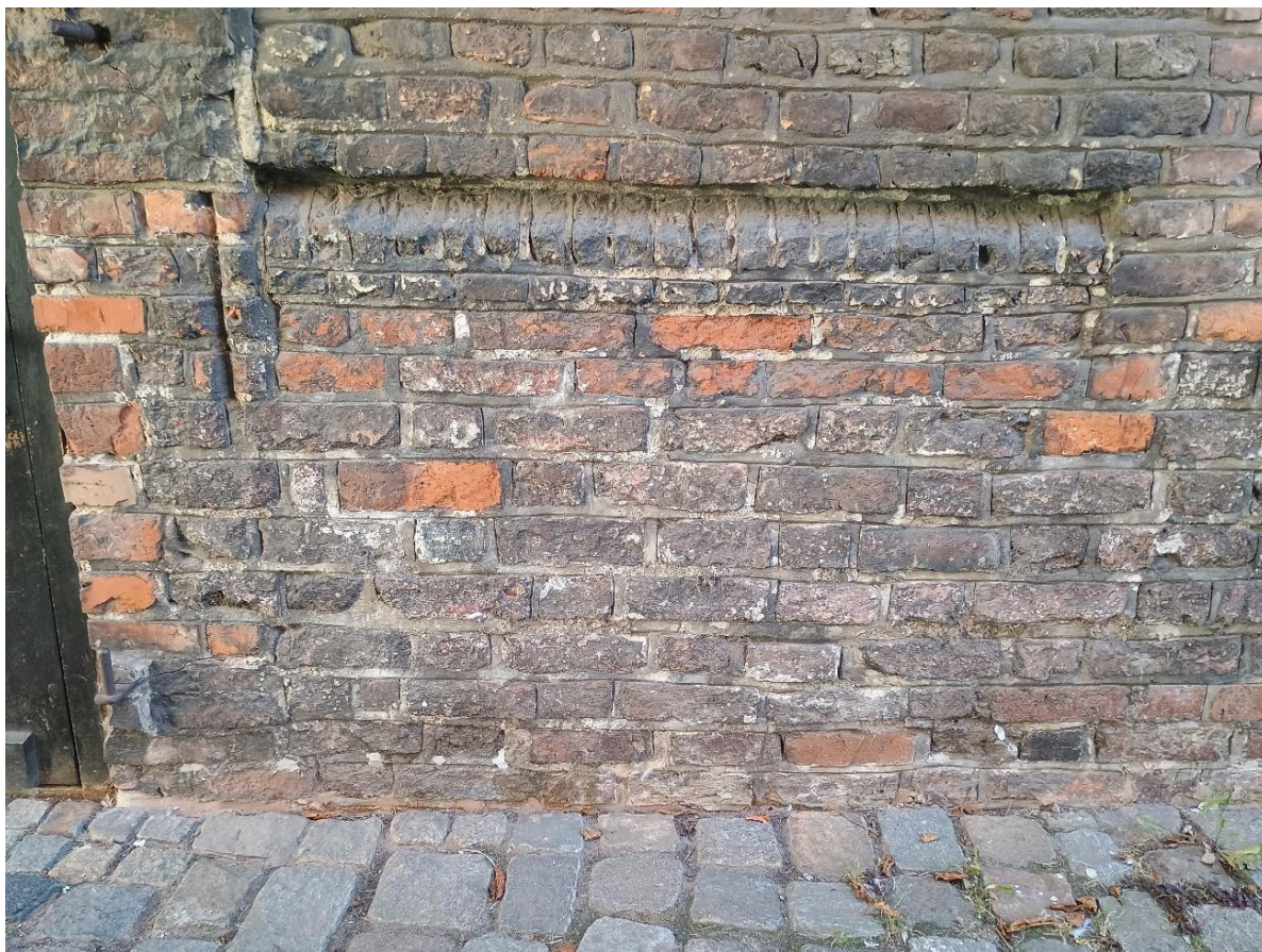
Ilustracja 87. Obiekt po zakończeniu prac (izolacja przeciwwilgociowa)
