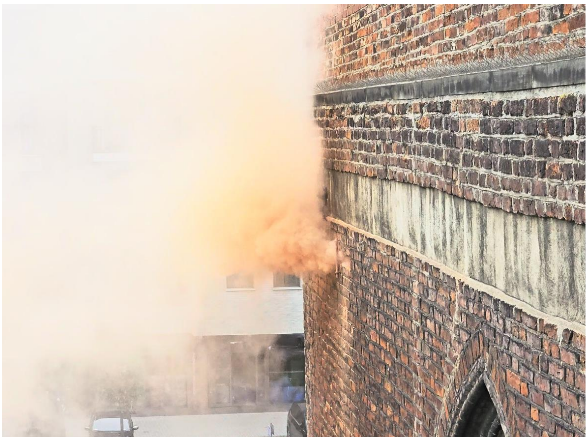
Ilustracja 64. Oczyszczanie otworu z materiałów luźnych
