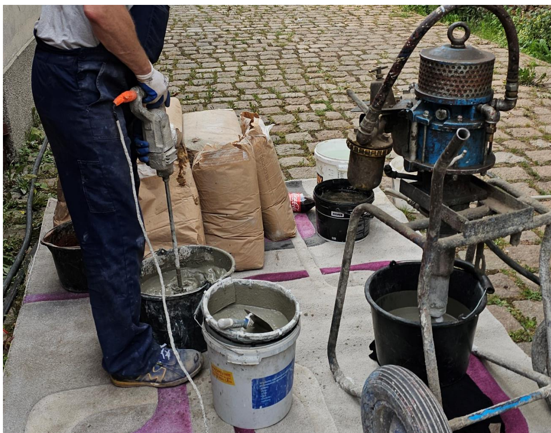
Ilustracja 70. Przygotowanie zaprawy mineralnej
