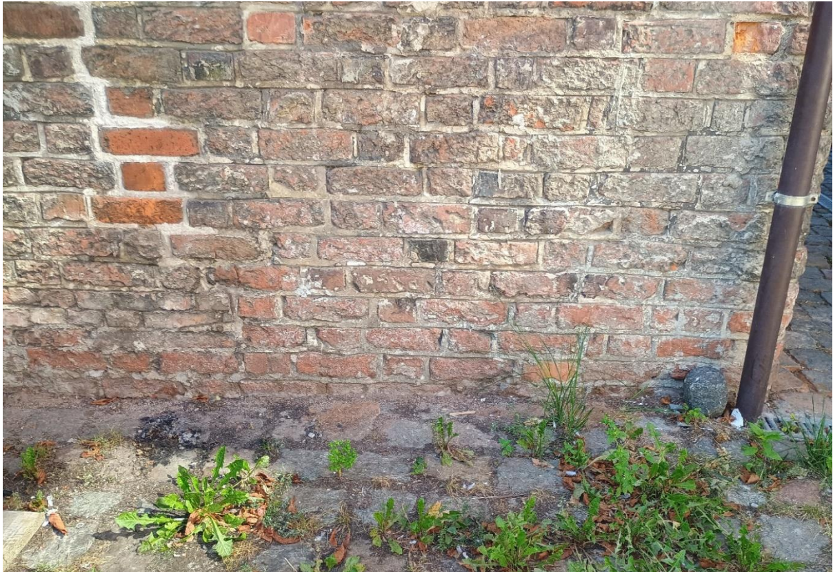
Ilustracja 89. Obiekt po zakończeniu prac (izolacja przeciwwilgociowa)
