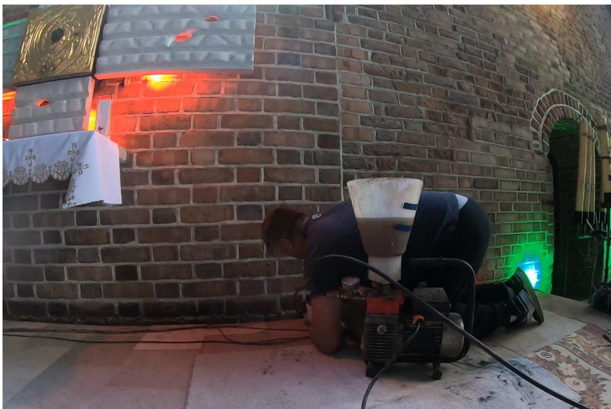
Ilustracja 41. Aplikacja środka iniekcyjnego
