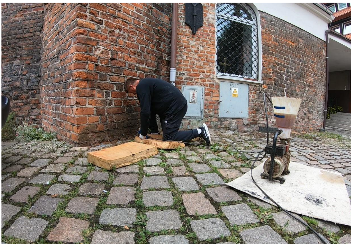
Ilustracja 49. Aplikacja środka iniekcyjnego
