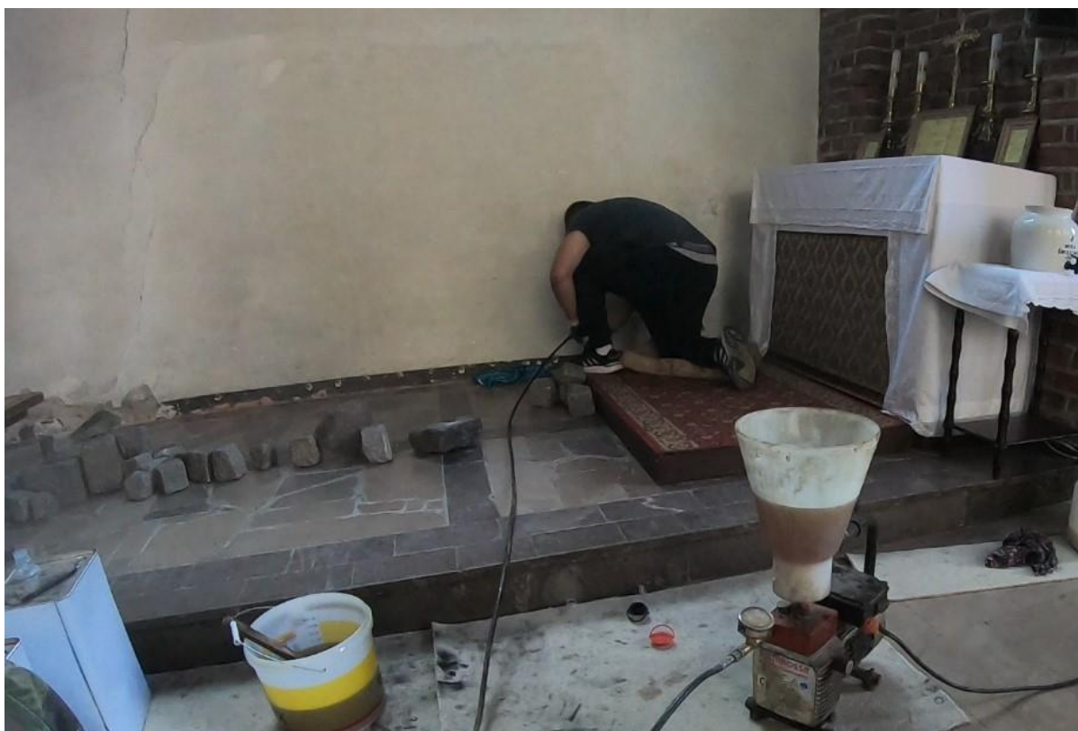
Ilustracja 43. Aplikacja środka iniekcyjnego
