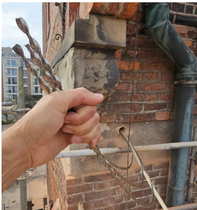
Ilustracja 67. Wprowadzanie wiązki trzech prętów spiralnych
