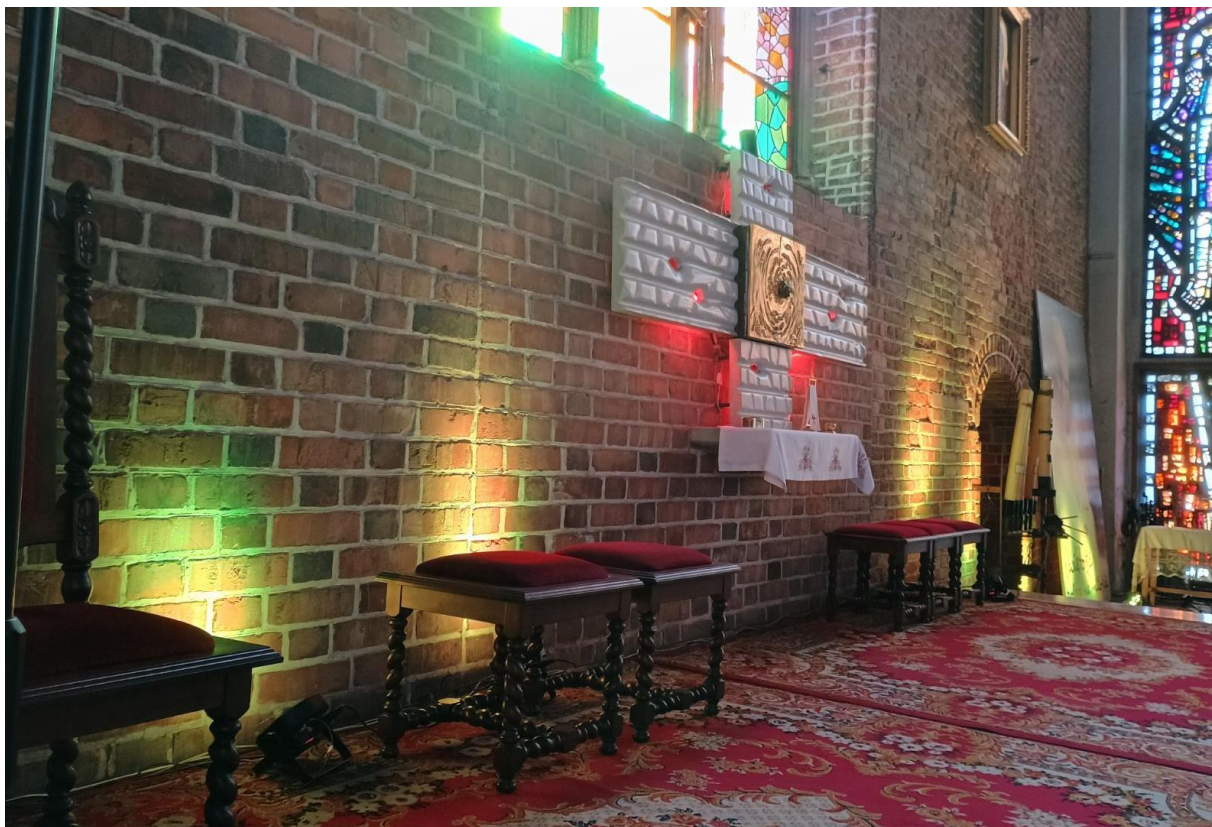
Ilustracja 99. Obiekt po zakończeniu prac (izolacja przeciwwilgociowa)
