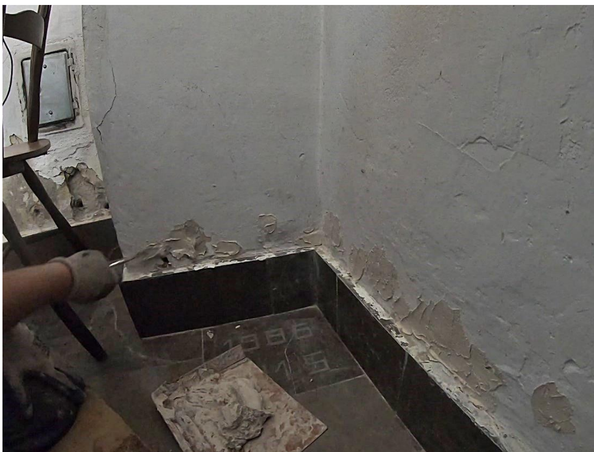
Ilustracja 52. Zabezpieczanie otworów zaprawą
