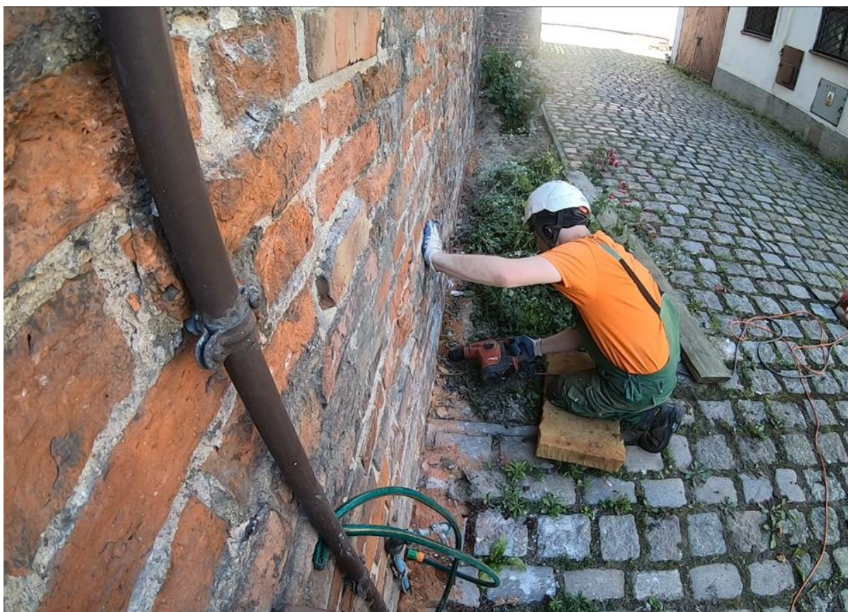
Ilustracja 31. Nawiercanie otworów pod iniektory
