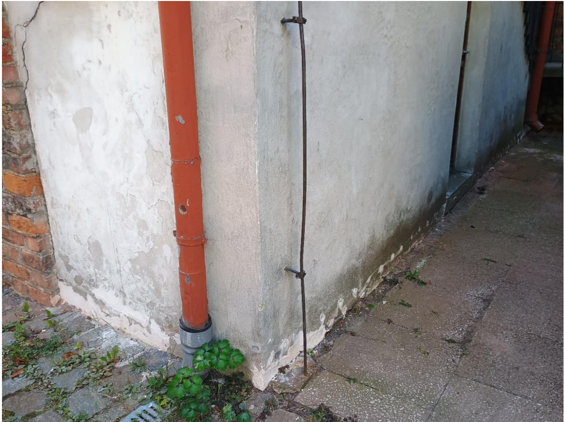
Ilustracja 83. Obiekt po zakończeniu prac (izolacja przeciwwilgociowa)
