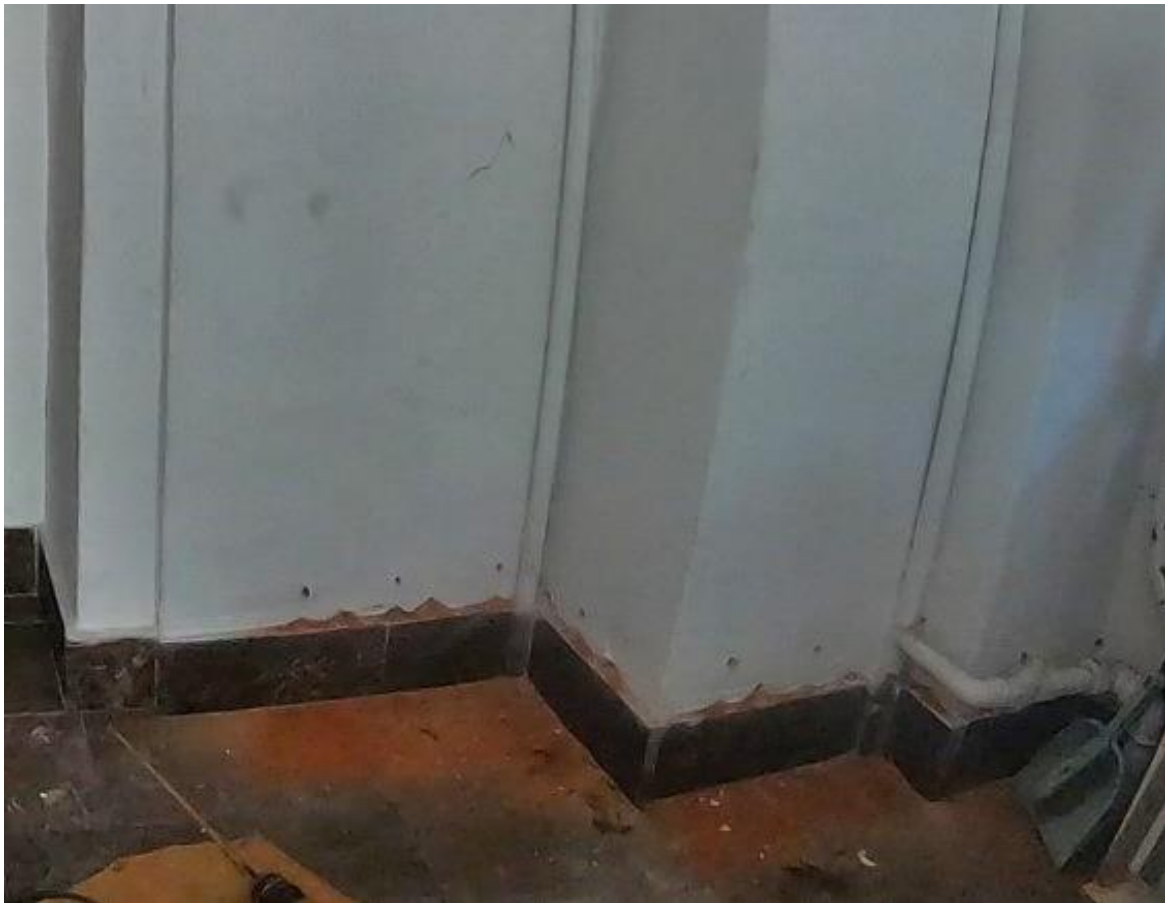
Ilustracja 35. Otwory pod iniektory
