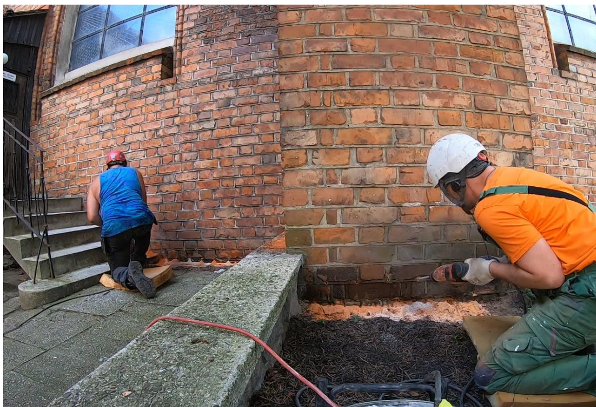
Ilustracja 26. Nawiercanie otworów pod iniektory
