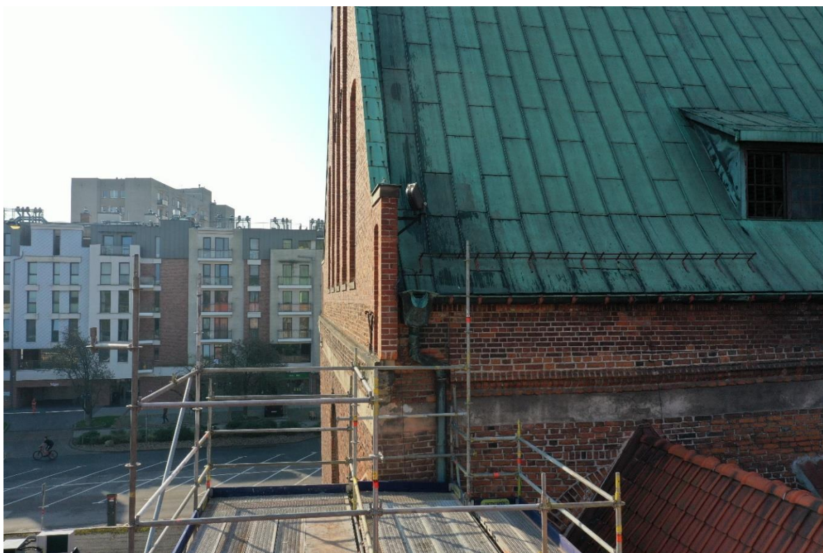
Ilustracja 103. Obiekt po zakończeniu prac (wzmocnienie rdzeniowe)
