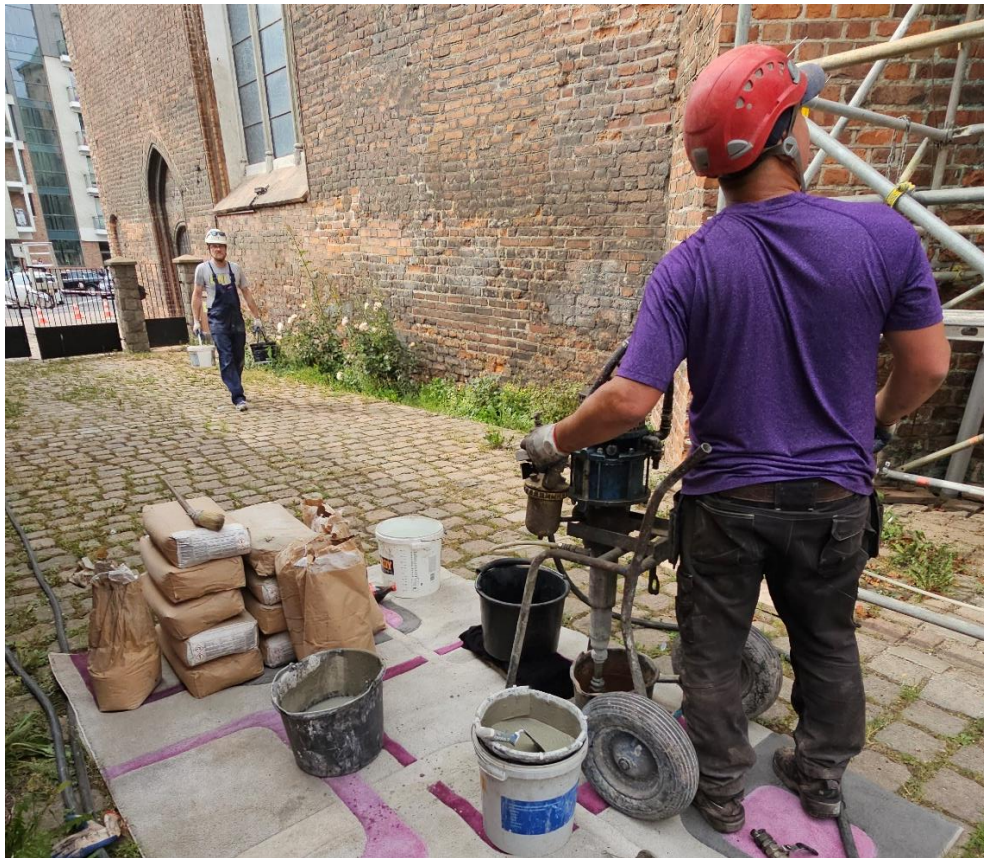
Ilustracja 71. Ciśnieniowa iniekcja zaprawy mineralnej
