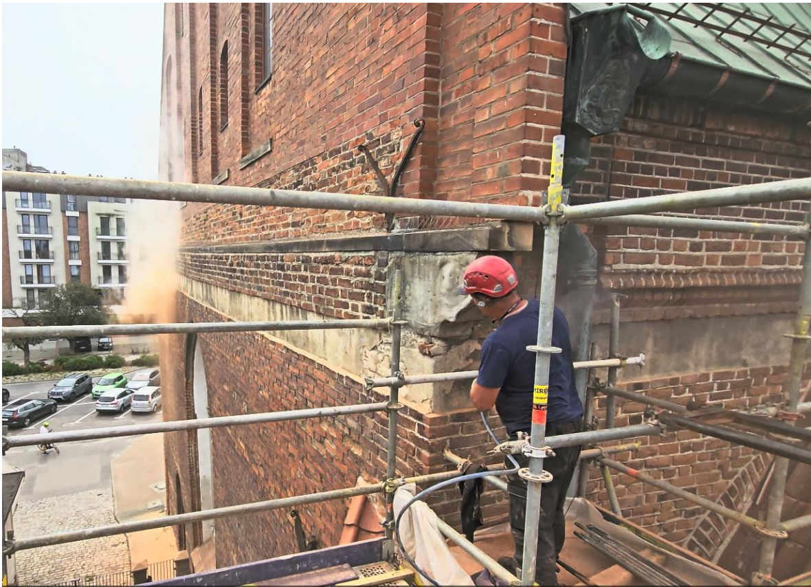
Ilustracja 63. Oczyszczanie otworu z materiałów luźnych (pył ceglany wydostaje się przez otwór rewizyjny)
