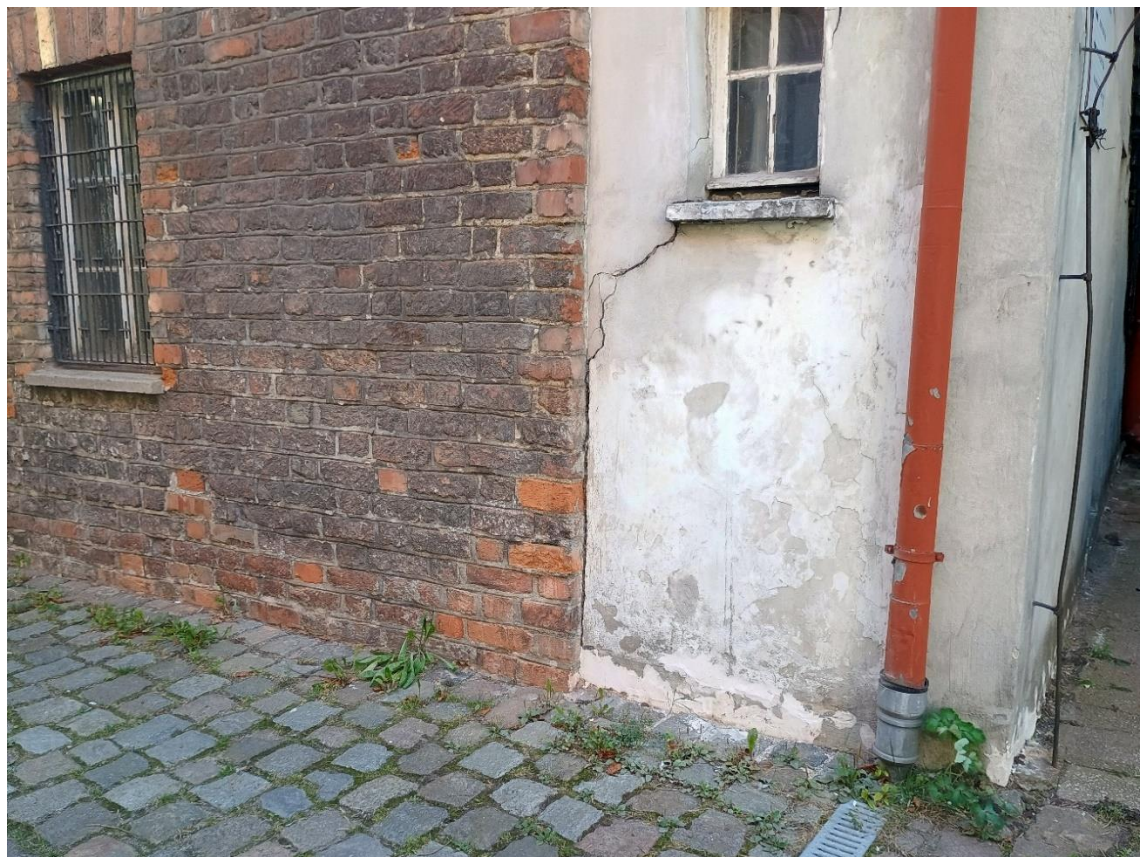
Ilustracja 84. Obiekt po zakończeniu prac (izolacja przeciwwilgociowa)
