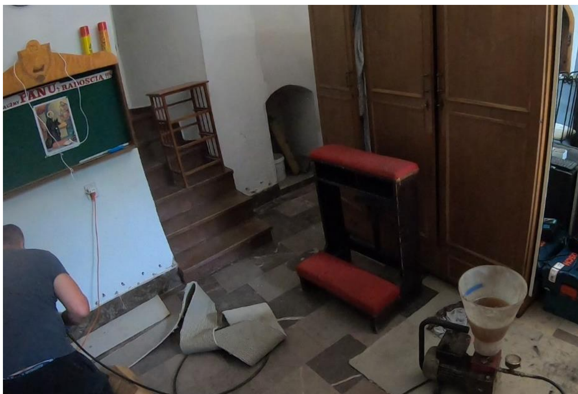
Ilustracja 44. Aplikacja środka iniekcyjnego
