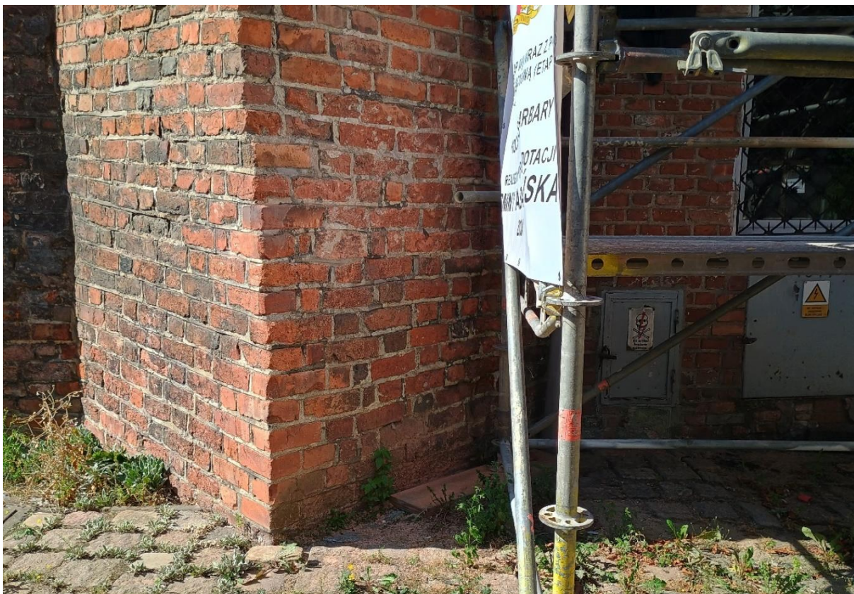
Ilustracja 90. Obiekt po zakończeniu prac (izolacja przeciwwilgociowa)
