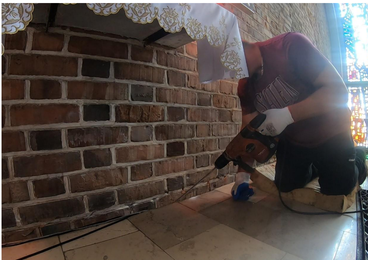
Ilustracja 38. Nawiercanie otworów pod iniektory
