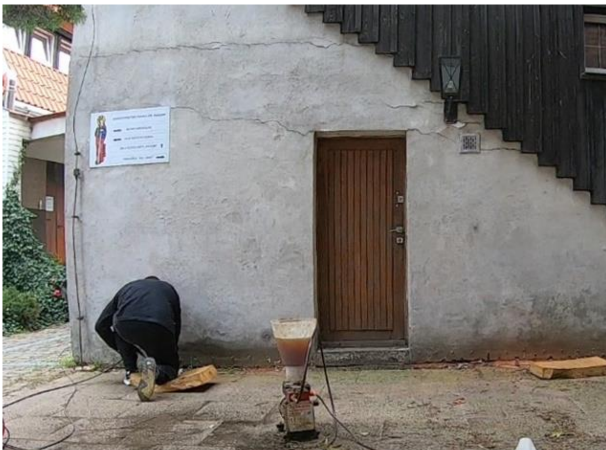
Ilustracja 47. Aplikacja środka iniekcyjnego
