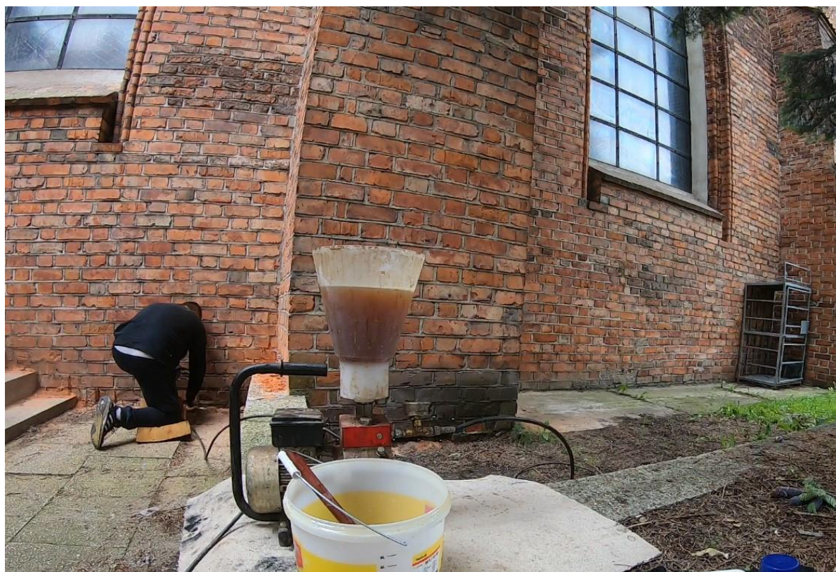
Ilustracja 46. Aplikacja środka iniekcyjnego
