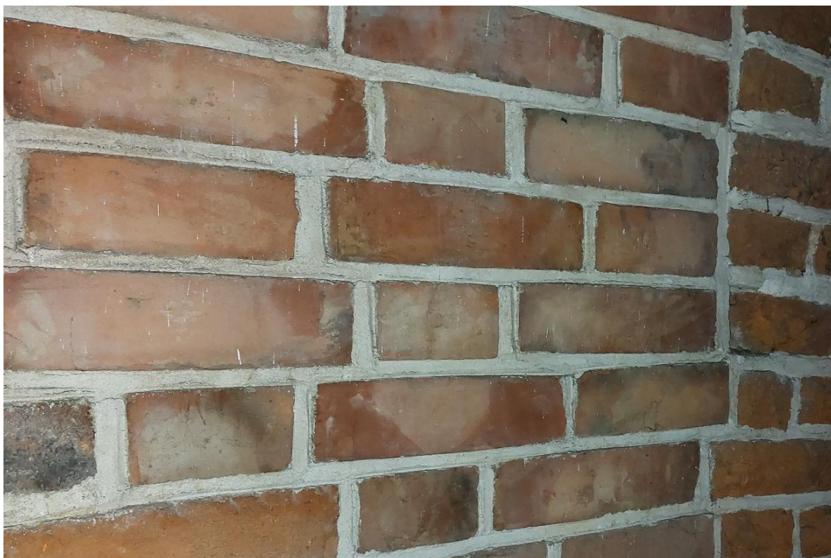
Ilustracja 22. Skutki zawilgocenia: plamy wilgoci na murach wewnątrz zabytku
