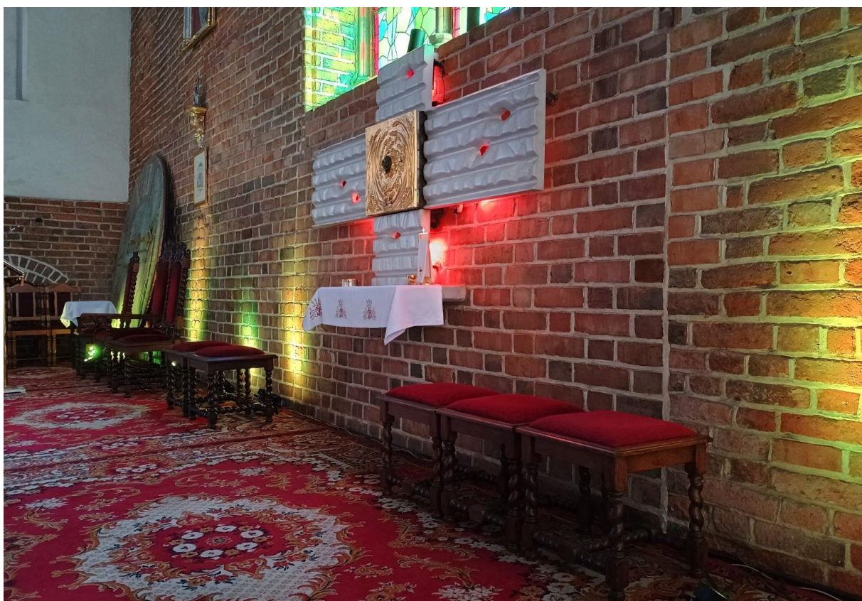
Ilustracja 100. Obiekt po zakończeniu prac (izolacja przeciwwilgociowa)
