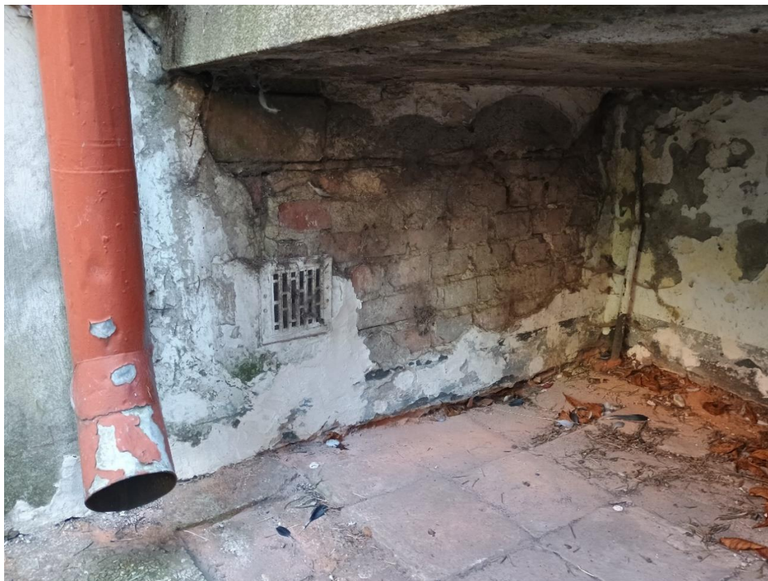
Ilustracja 81. Obiekt po zakończeniu prac (izolacja przeciwwilgociowa)
