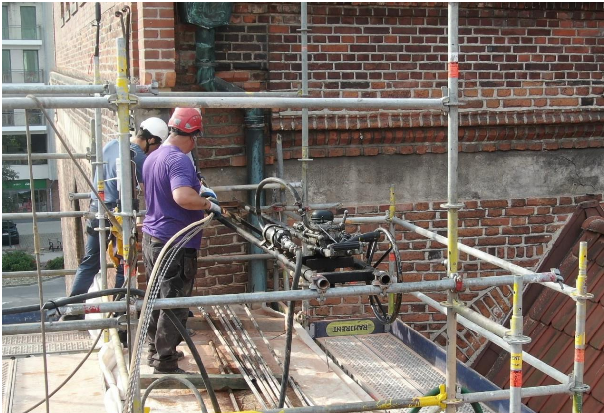
Ilustracja 65. Wprowadzanie wiązki trzech prętów spiralnych
