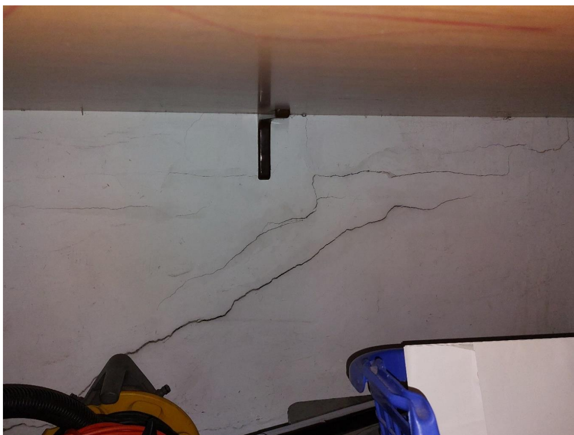
Ilustracja 16. Spękania murów
