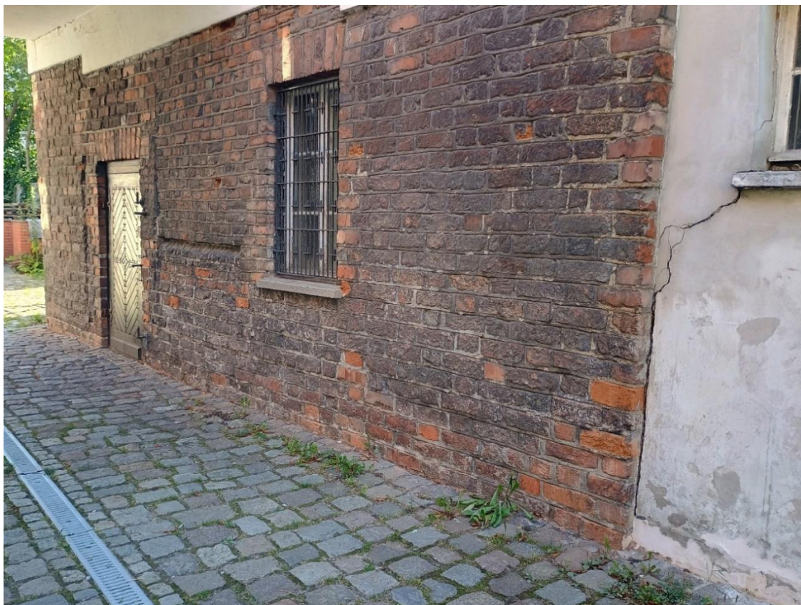
Ilustracja 85. Obiekt po zakończeniu prac (izolacja przeciwwilgociowa)
