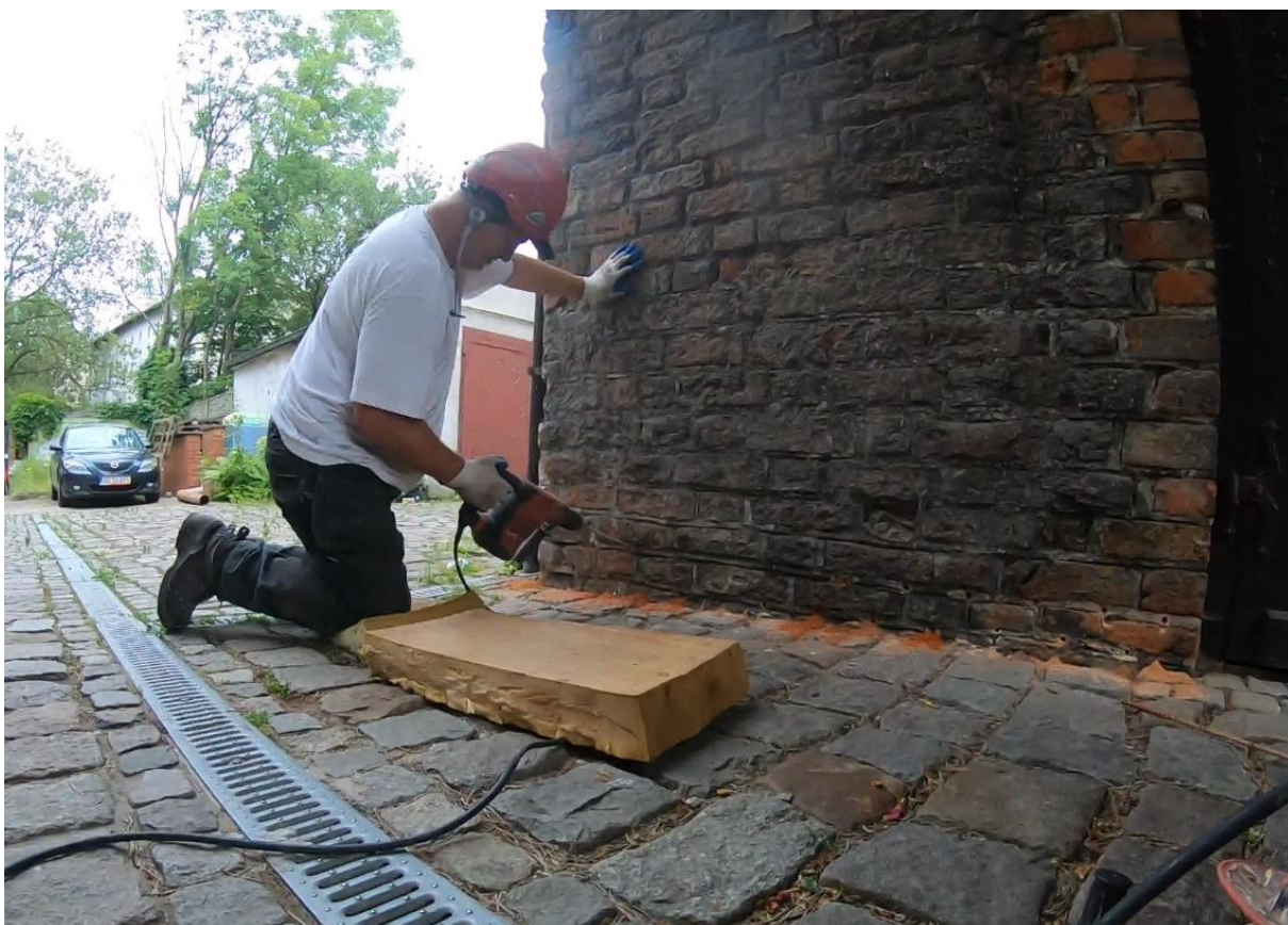
Ilustracja 29. Nawiercanie otworów pod iniektory
