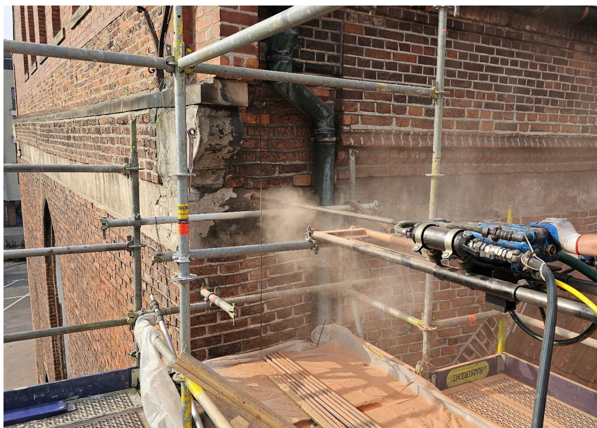
Ilustracja 60. Wykonywanie odwiertu w strefie rdzeniowej muru
