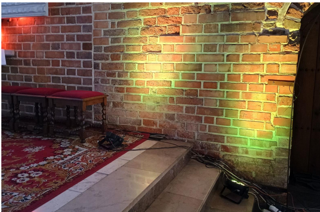
Ilustracja 101. Obiekt po zakończeniu prac (izolacja przeciwwilgociowa)
