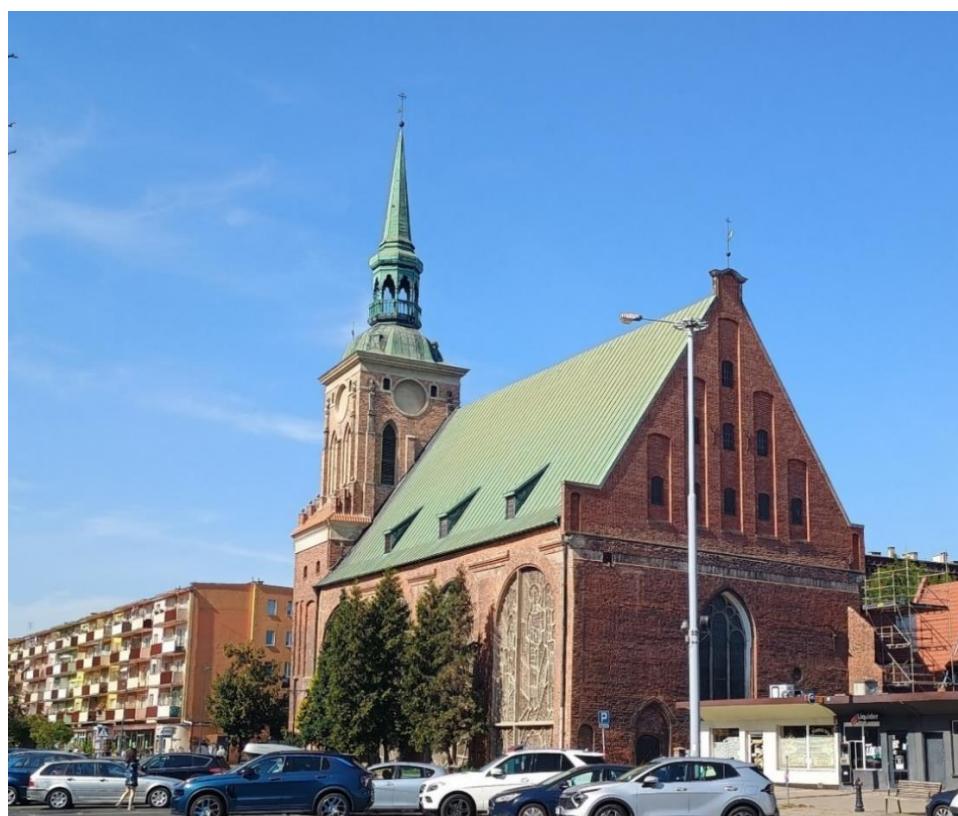
Ilustracja 74. Obiekt po zakończeniu prac
