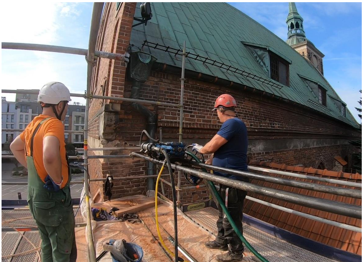
Ilustracja 58. Przygotowanie wiertnicy do pracy (widok od północy)
