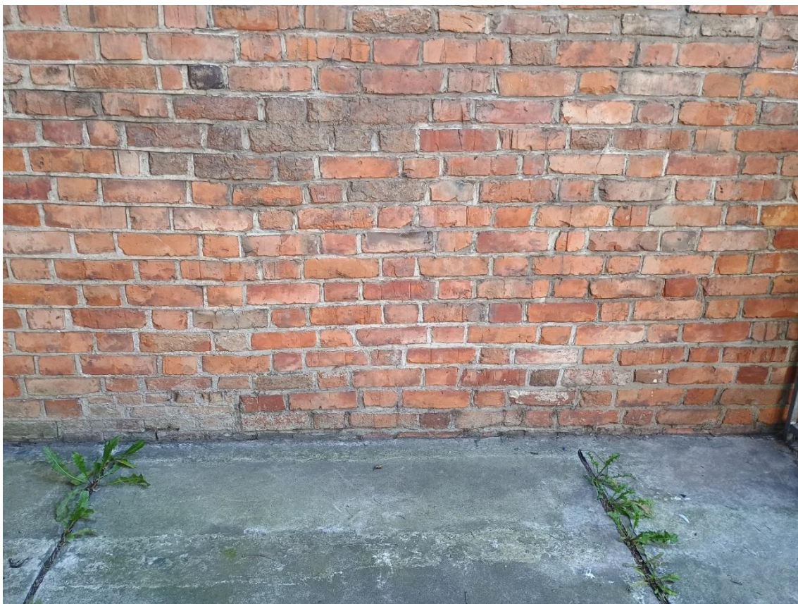
Ilustracja 77. Obiekt po zakończeniu prac (izolacja przeciwwilgociowa)
