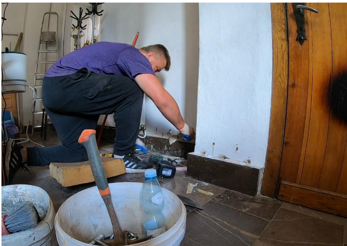
Ilustracja 51. Zabezpieczanie otworów zaprawą
