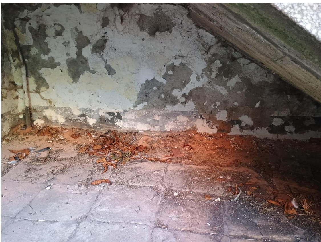
Ilustracja 80. Obiekt po zakończeniu prac (izolacja przeciwwilgociowa)
