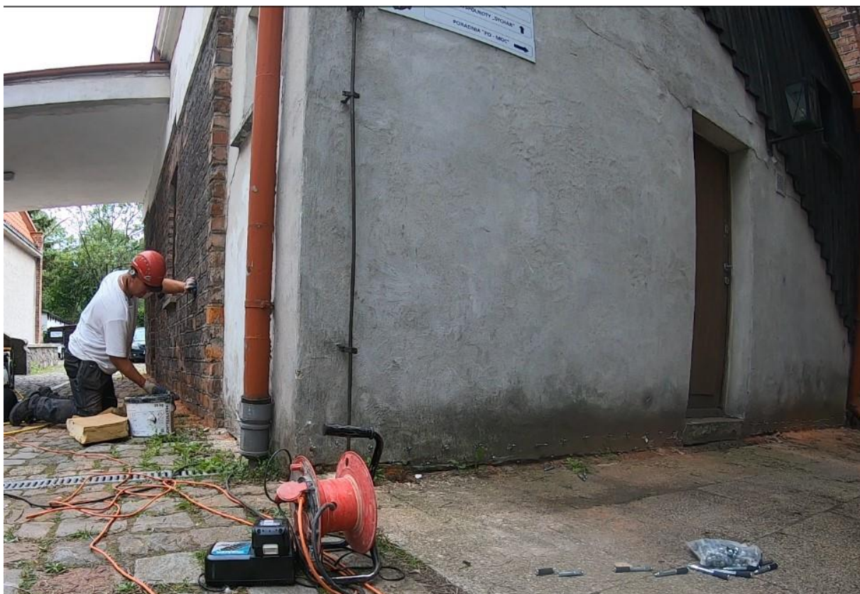
Ilustracja 40. Osadzenie iniektorów w odwiertach
