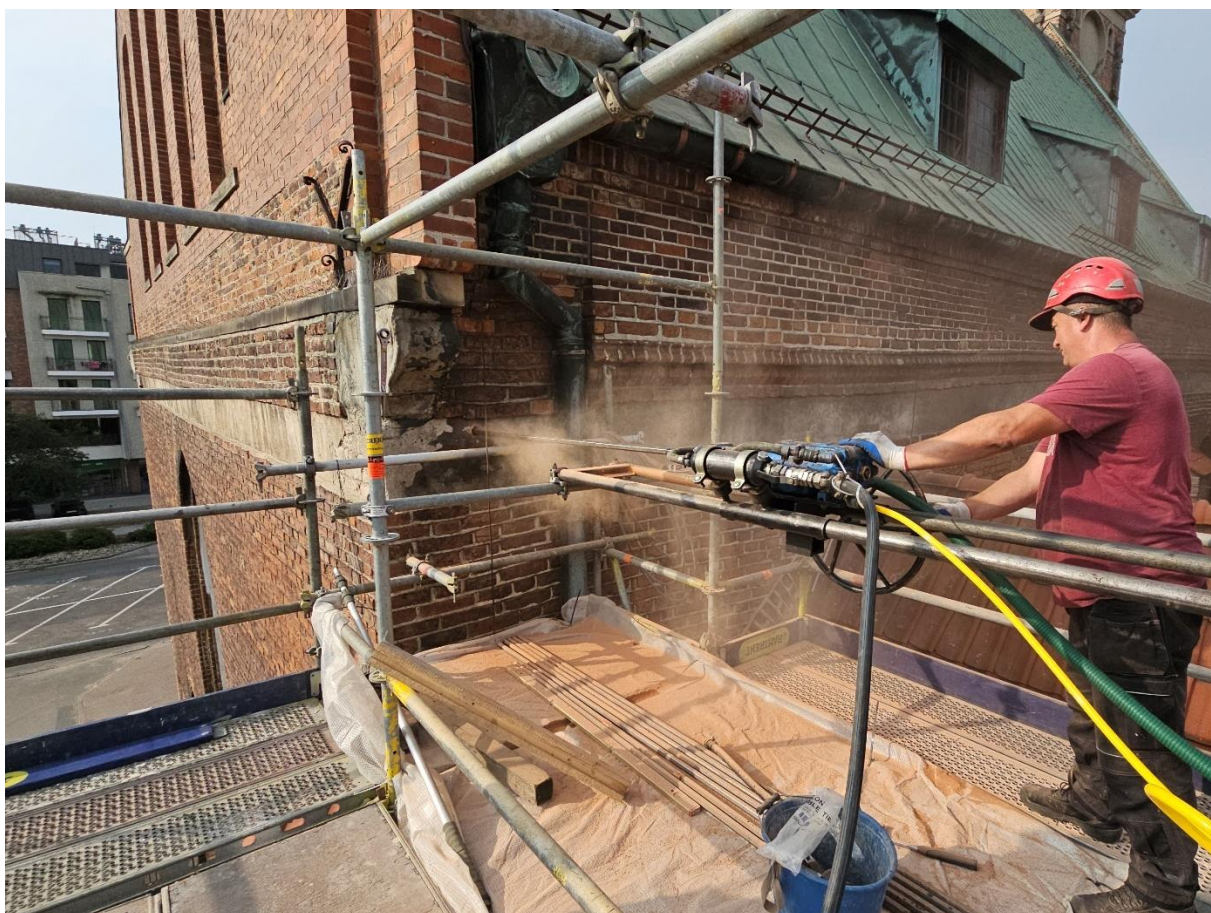
Ilustracja 59. Wykonywanie odwiertu w strefie rdzeniowej muru
