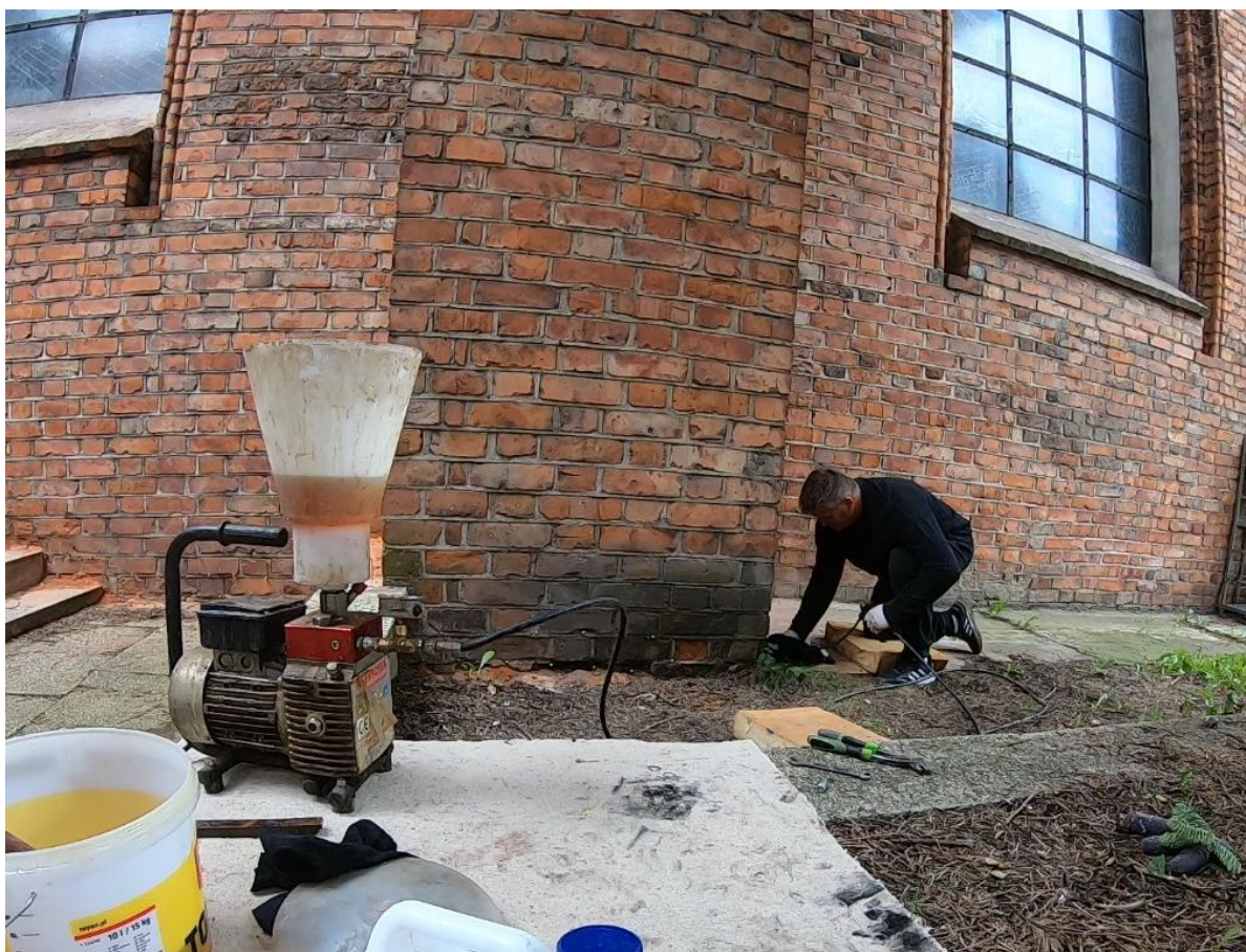
Ilustracja 45. Aplikacja środka iniekcyjnego
