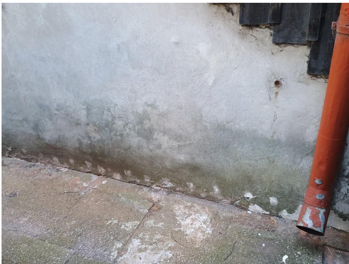
Ilustracja 82. Obiekt po zakończeniu prac (izolacja przeciwwilgociowa)
