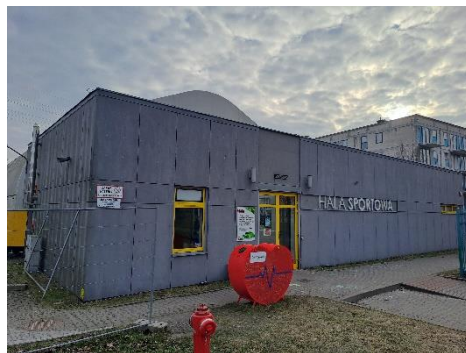
Istniejące murowane zaplecze sali
