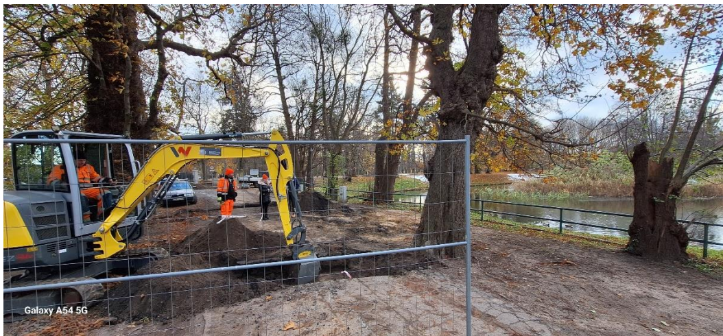
Fot. 14 Po zakończeniu badań odkrywki zasypano.
