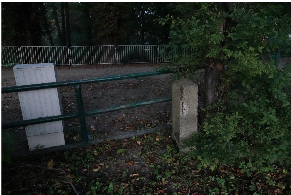
Fot. 23 Skrzynki od instalacji technicznych.
