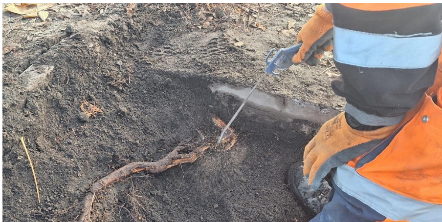
Fot. 9 Odkrywanie korzeni sprężonym powietrzem.
