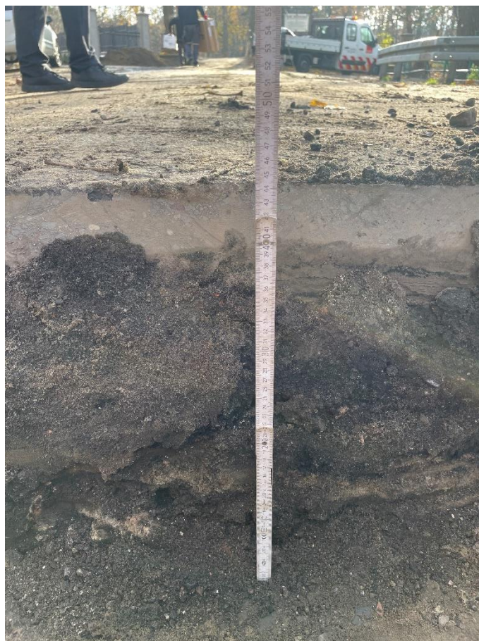
Fot. 3 Głębokość głównego wykopu - 45 cm.
