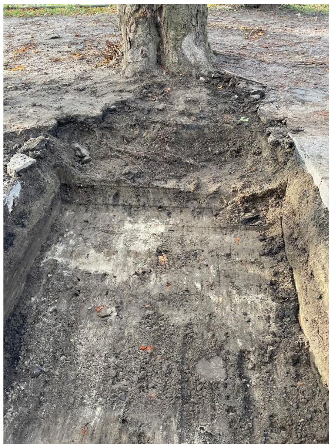
Fot. 2 W pozostałej części wykopu nie stwierdzono korzeni drzew.
