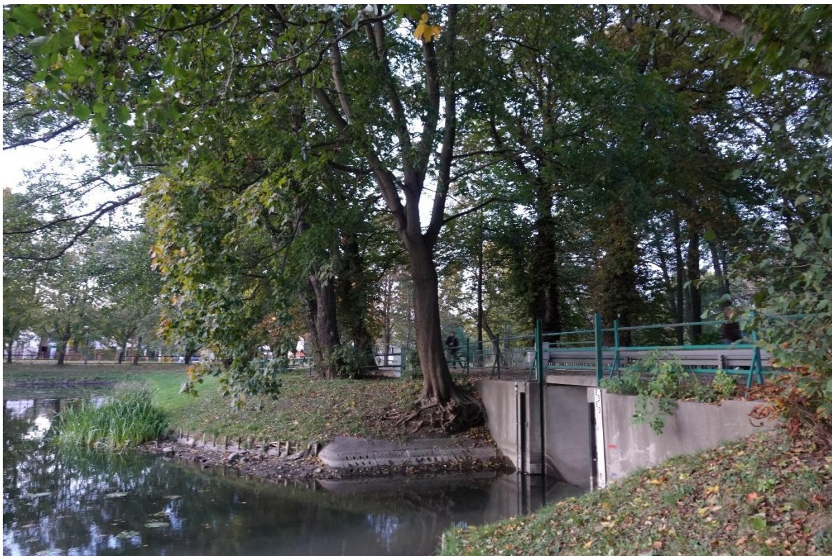
Fot. 3 Przepust skrzynkowy – ujście Potoku Oliwskiego ze zbiornika nr2.
