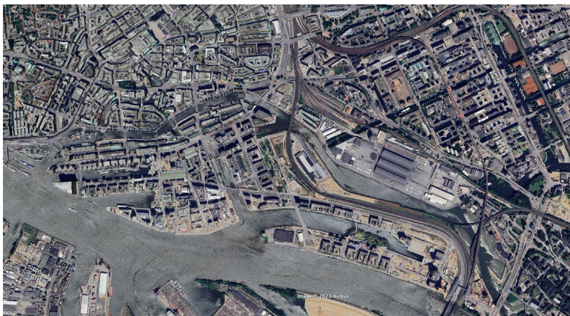
Rys. 24. Postęp budowy dzielnicy Hafencity z 2023 roku (źródło: https://www.google.com/maps )
