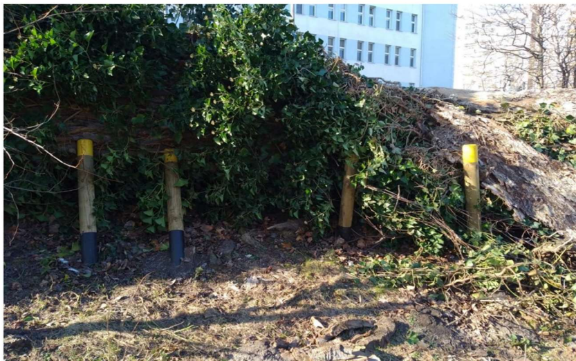
Zabezpieczenie przed osunięciem się na ścieżkę
