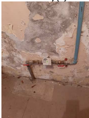
Istniejący zestaw wodomierzowy
