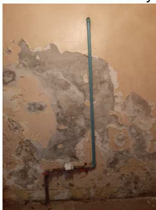
Istniejący zestaw wodomierzowy
