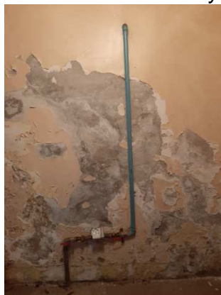
Istniejący zestaw wodomierzowy
