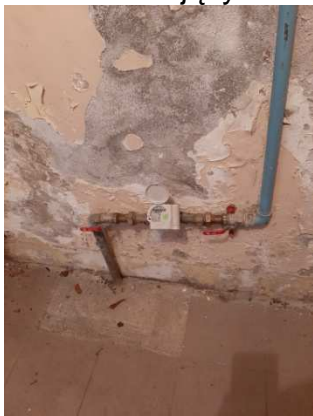
Istniejący zestaw wodomierzowy
