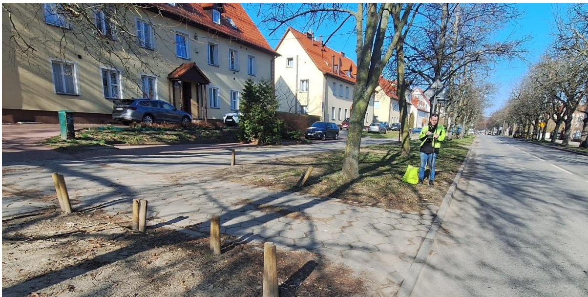
Fot. 10 Wytyczanie geodezyjne przebiegu kabla i lokalizacji komór wejściowych przecisku sterowanego.
