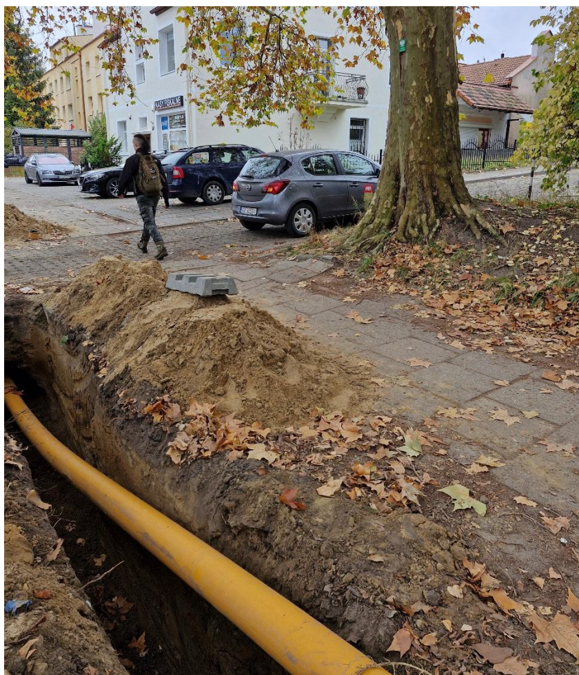
Widok wykopu pod sieć gazową w sąsiedztwie grupowego pomnika przyrody – źródło: Gdański Zarząd Dróg i Zieleni (08.11.2024)
