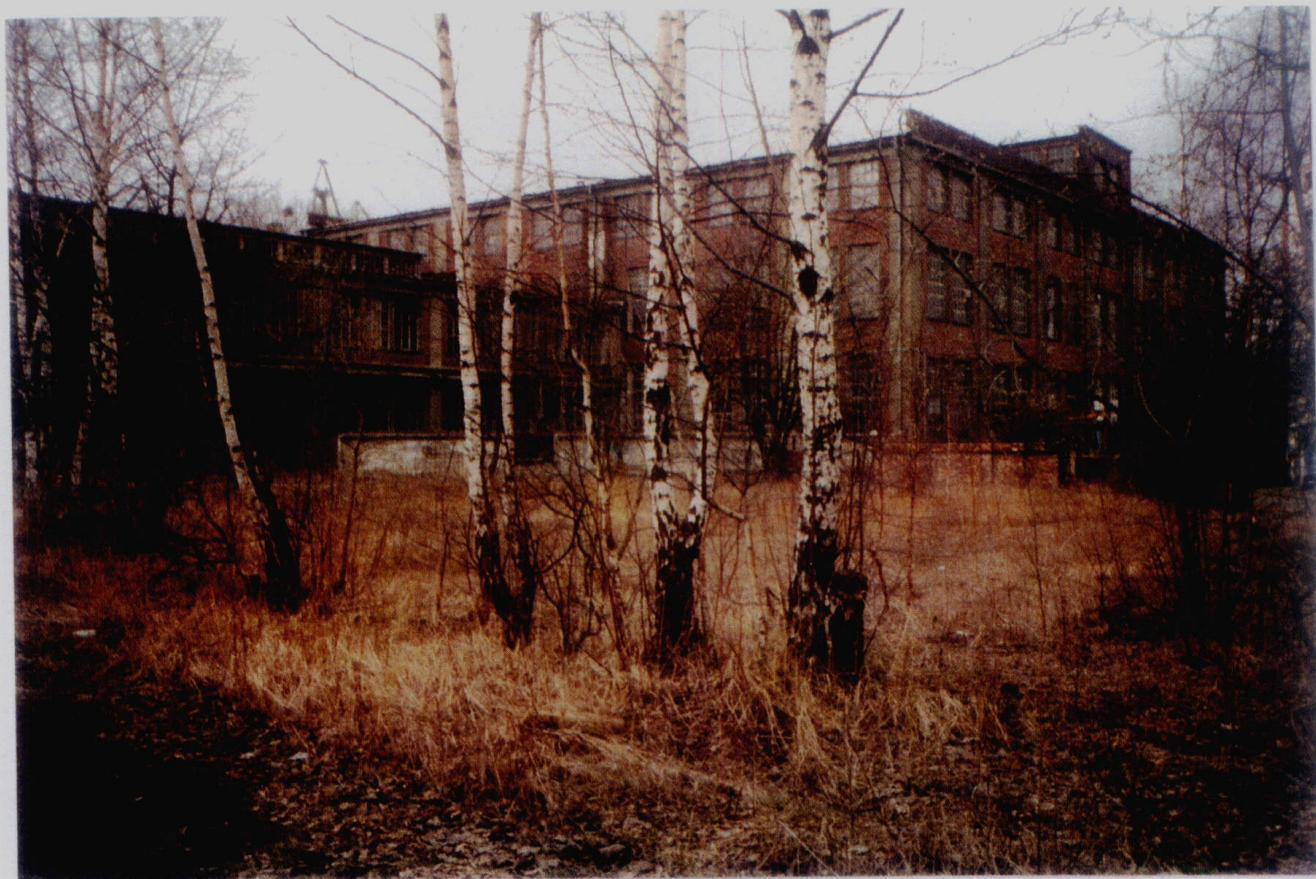
Fot. 5 – Dawny skwer obok nieczynnego obiektu
