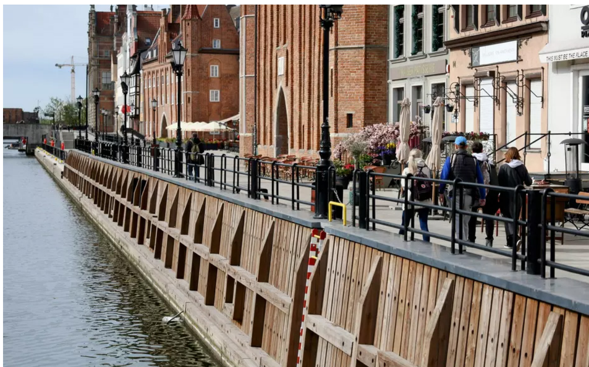
Fig. 15. Długie Pobrzeże promenade after renovation, source: gdansk.pl
