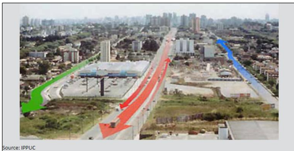
Rys. 2.45 Widok korytarza transportowego BRT w Kurytybie
