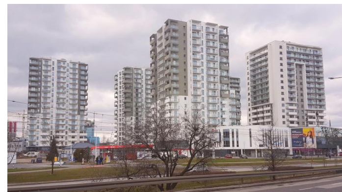
Albatros Towers, rejon ul. Kołobrzeska Gdańsk
