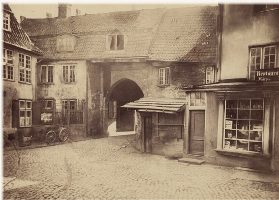
4 Przedbramie Bramy Zamkowej przed rozbiórką w 1879 r., ze zbiorów PAN Biblioteki Gdańskiej, sygn. AL/IV/8. | The Foregate of the Castle Gate before its demolition in 1879, from the collection of the Gdańsk Library of the Polish Academy of Sciences, ref. no. AL/IV/8.
