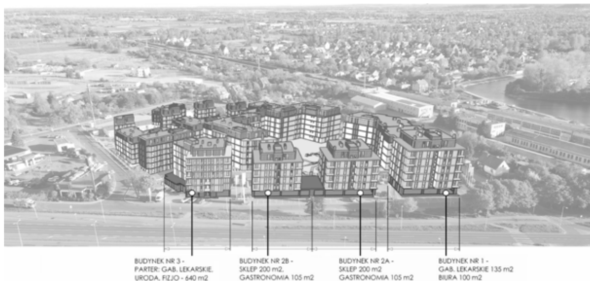
Ryc. 16. Lokalizacja usług w pierzei ul. Elbląskiej (mat. inwestora)
