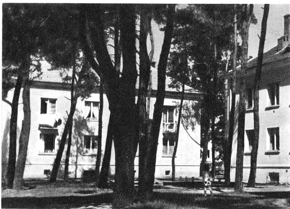
371. Osiedle w Górkach Zachodnich. Budynki typowe. Projekt urbanistyczny I. Heilmanowej. Stan w 1957 r.
