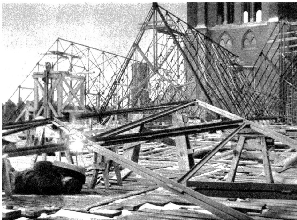
355. Odbudowa dachów na kościele NP Marii. Projekt konstrukcji dachowej — T. Jarosz. Stan w 1948 r.
