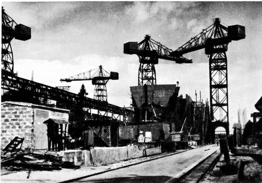
338. Budowa statku na pochylni Stoczni Gdańskiej
