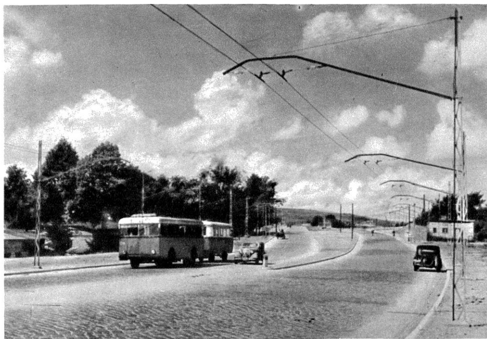
335. Rozbudowana Droga Państwowa nr 1 między Sopotem i Gdynią
