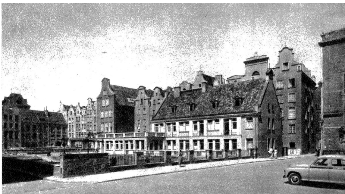
342. Wnętrze pierwszego odbudowanego bloku na Głównym Mieście między ulicami: Ogarną Garbary, Długą i Pocztową. Na pierwszym planie żłobek. Stan w 1958 r.
