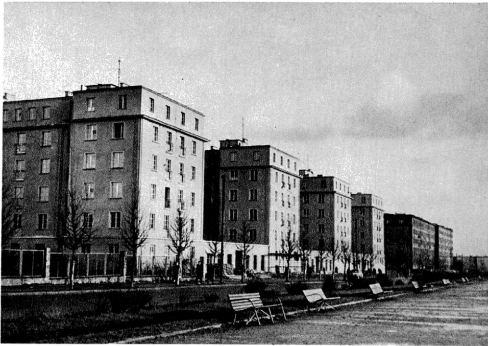
378. Budynki mieszkalne przy ul. Czołgistów w Gdyni. Stan w 1957 r.
