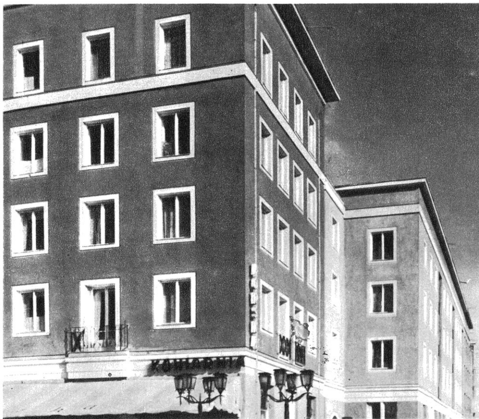
367. GDM — fragment budynku mieszkalno-usługowego. Proj. R. Semka. Stan w 1957 r.
