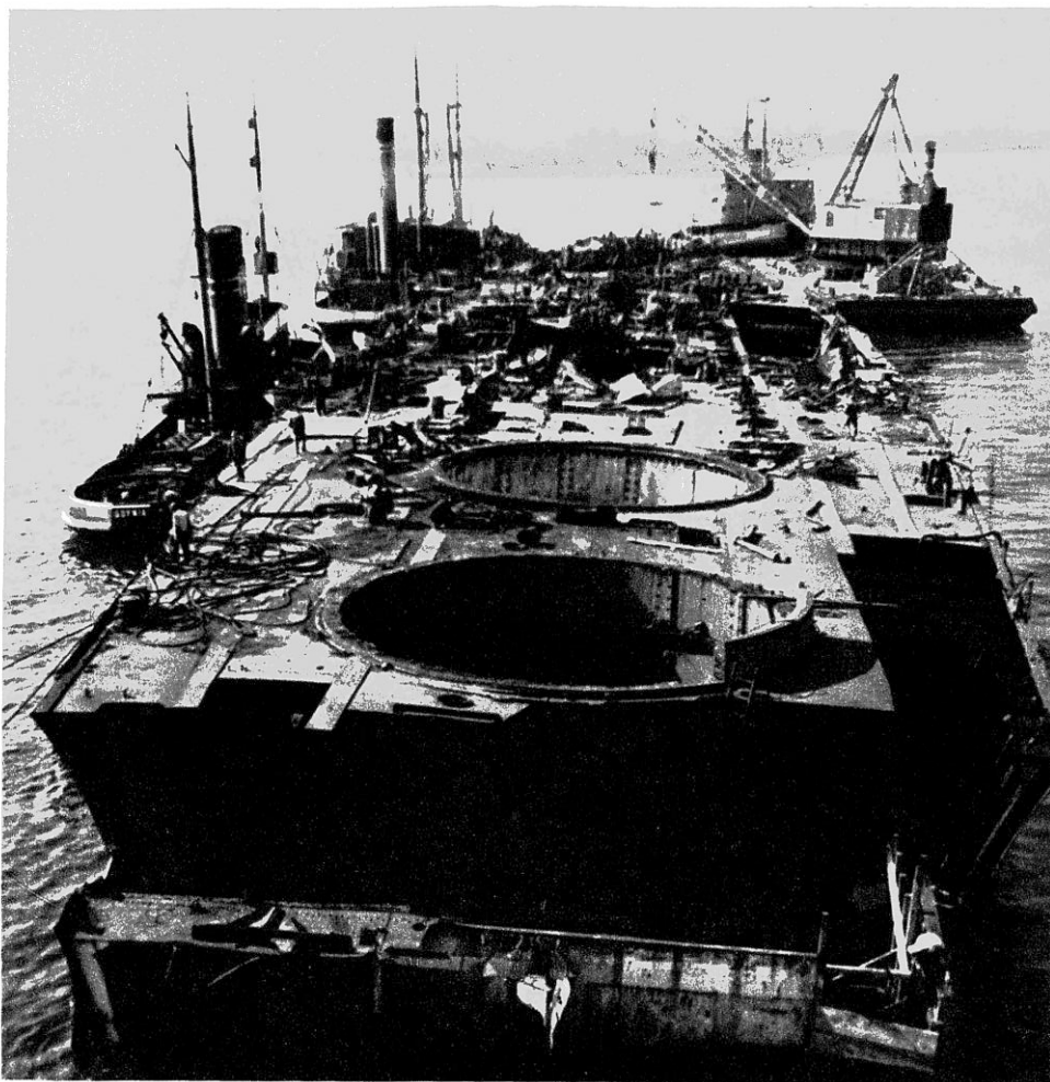
330. Cięcie na złom wraka okrętu liniowego „Gneisenau“, który blokował wejście do portu w Gdyni
