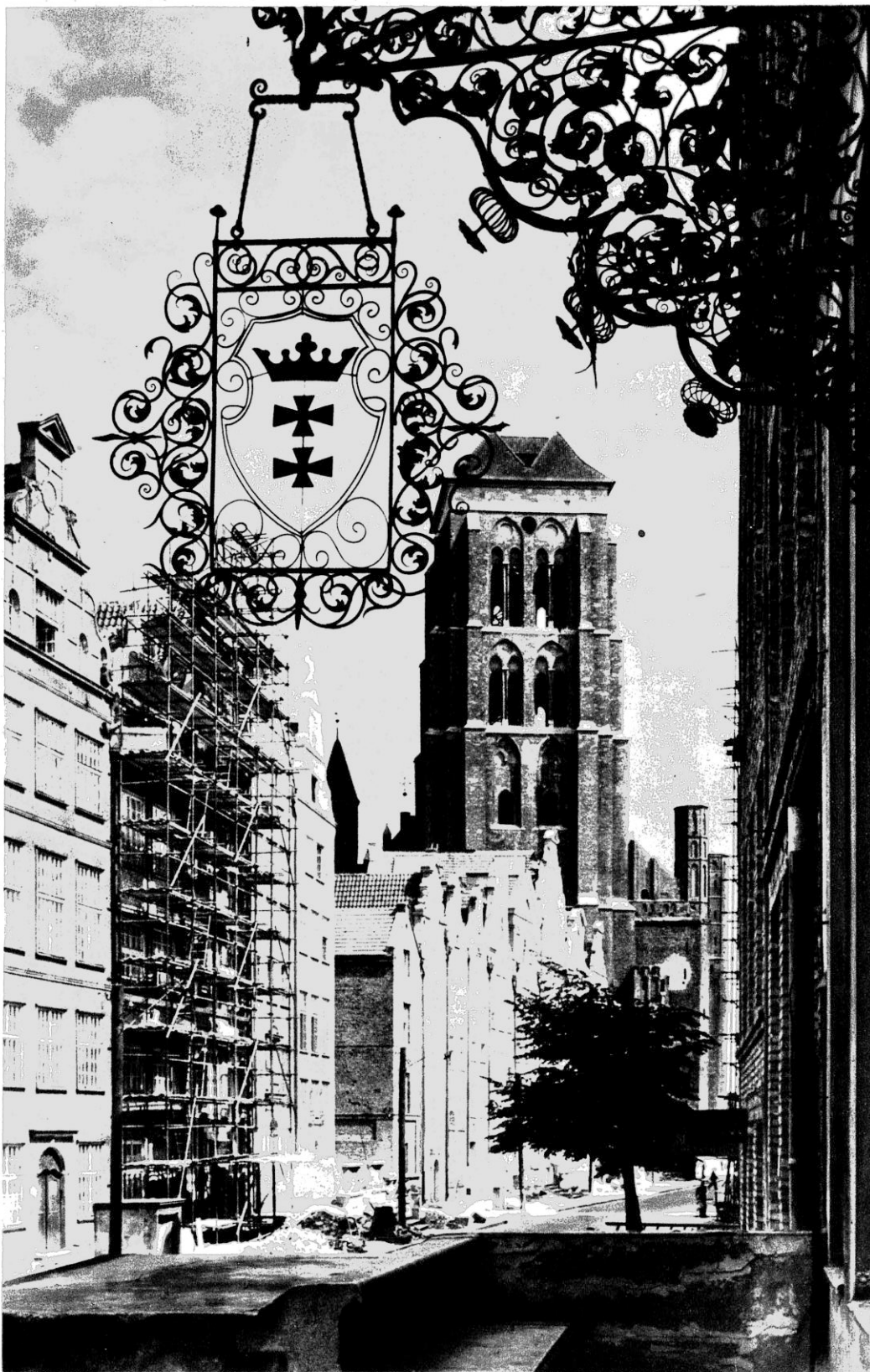
351. Odbudowana ul. Piwna. Stan w 1958 r.
