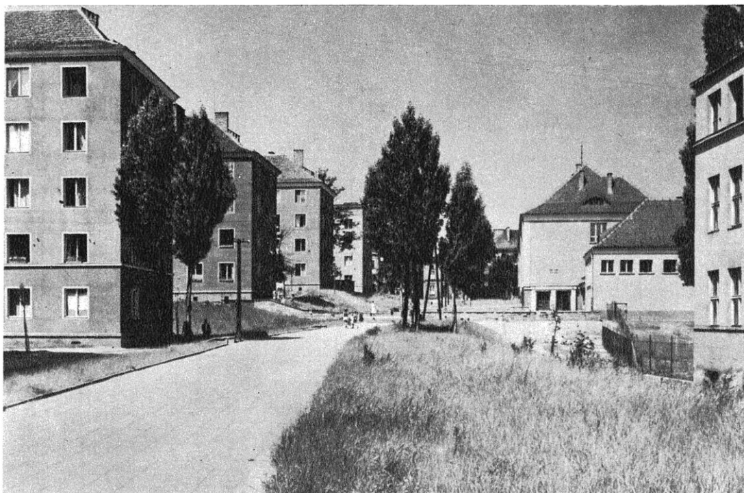
366. Wnętrze bloku przedstawionego na rys. 365. Po prawej — szkoła podstawowa. Stan w 1958 r.
