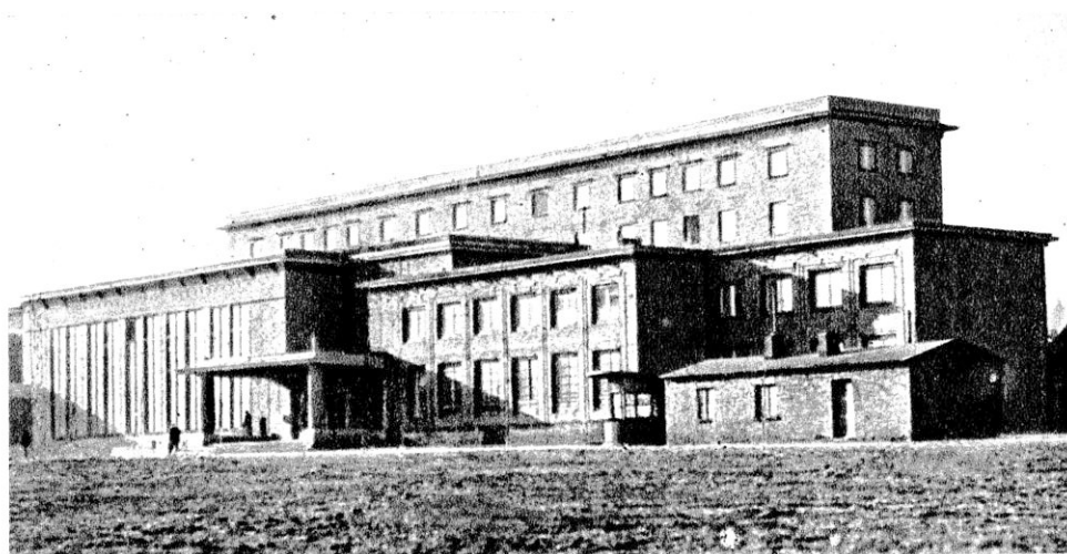
386. Nowy dworzec kolejowy w Gdyni. Proj. W. Tomaszewski. Stan w 1959 r.
