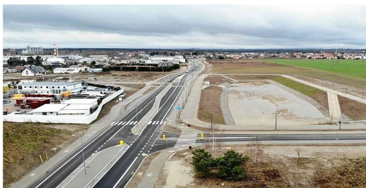
Budowa zbiornika Osowa II
