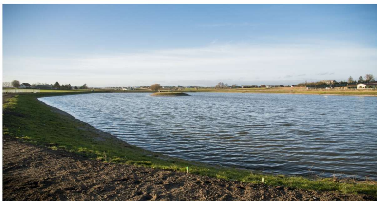
Budowa zbiornika Strzelniczka II
