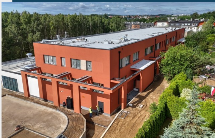
Fot.: Dyrekcja Rozbudowy Miasta Gdańska
