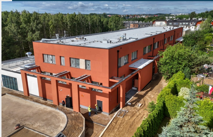
Fot.: Dyrekcja Rozbudowy Miasta Gdańska
