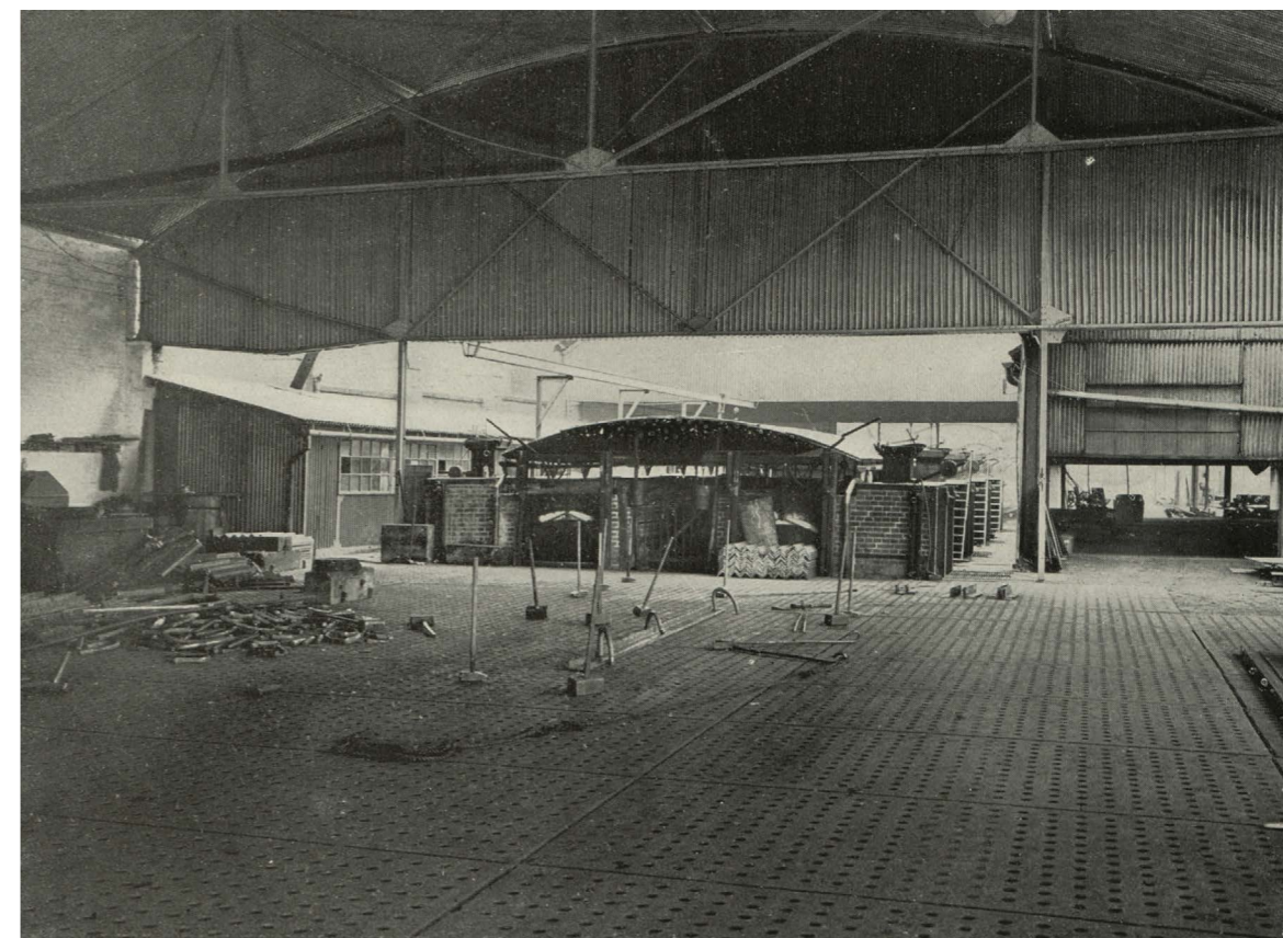
II. 135. Piec do rozgrzewania kształtowników na wręgi (w głębi) oraz hala ich formowania – wręgownia – niem. Richtplatten Halle (na pierwszym planie), z charakterystyczną podłogą zestawioną z masywnych otworowych płyt, służących do mocowania kształtowników w czasie ich kowalskiego formowania. Obiekty te należały do stoczni Vulcan w Szczecinie. W środku widoczny przytwierdzony do podłogi masywny kształtownik stalowy oraz wielkie młoty kowalskie. Zapewne podobnie wyglądała wręgownia i piec Stoczni Cesarskiej w Gdańsku. Były to obiekty połączone, zlokalizowane w podobnym układzie jak na powyższej fotografii. Zapewne niemieckie określenie Richtplatte – „równica”, płyta kowalska, obejmuje nie tylko płyty-stoły kowalskie (przykład na il. 91), ale także charakterystyczną podłogę wręgowni w postaci otworowych płyt, fot NN, ok. 1901, domena publiczna
