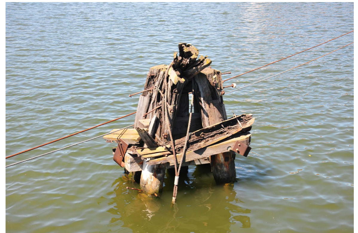
II. 78. Stara stoczniowa dalba cumownicza. Służyła do cumowania statków, stanowiła osłonę brzegów kanałów lub przejść wodnych. Obiekty tego rodzaju, charakterystyczne dla stoczni, pojawiały się często na starych fotografiach, fot. A. Trzeciak, 2017, zbiory autora
