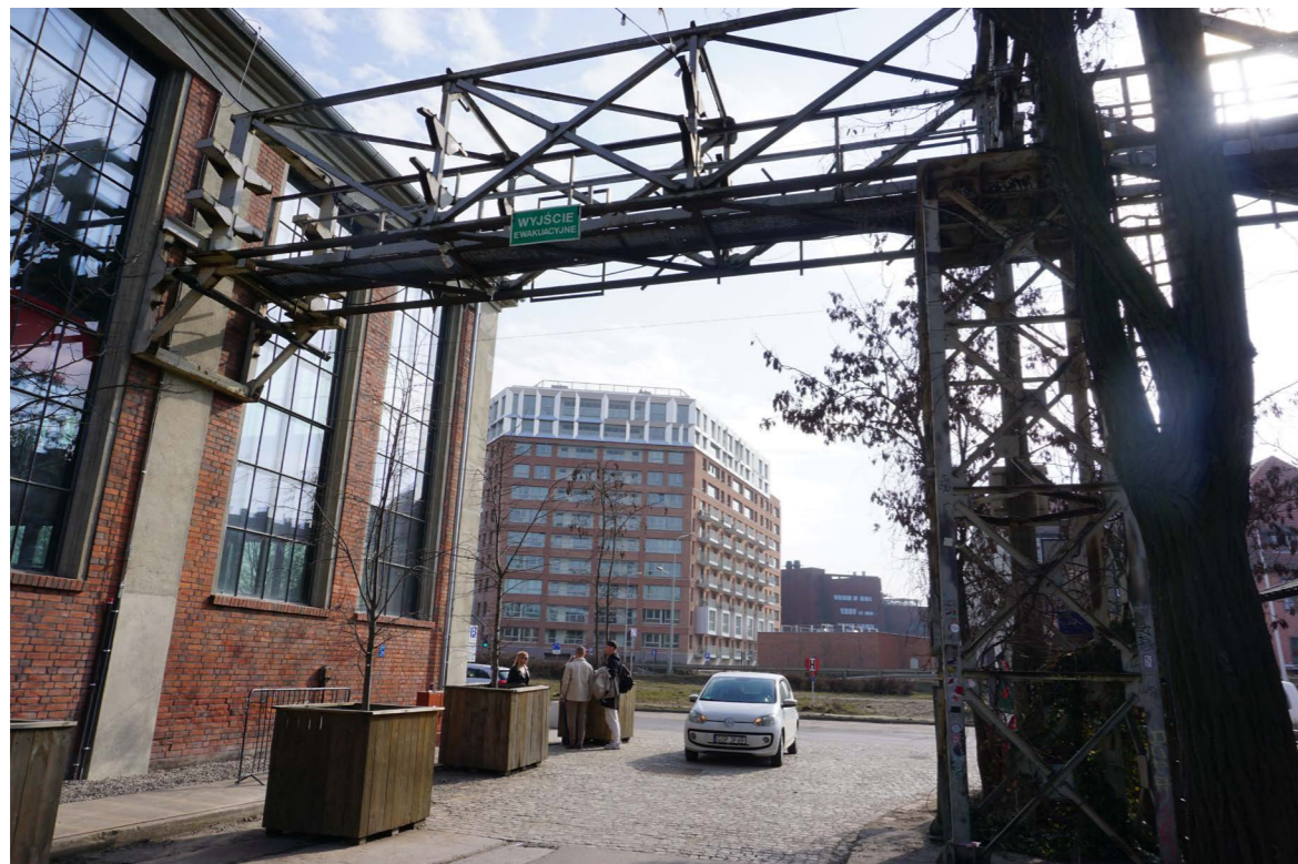
II. 255. Kratownica estakady rurociągów zachowana u wylotu ul. Elektryków, fot. W. Chmielewski, zbiory BAM
