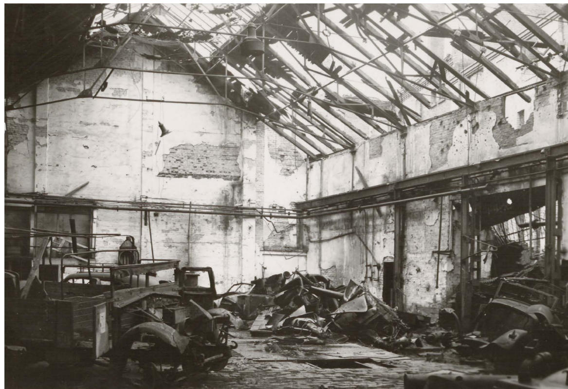
II. 215. Zniszczona hala nieistniejącej dziś stoczniowej odlewni. Zdjęcie dobrze obrazuje skalę zniszczeń stoczniowych obiektów przemysłowych. Zarówno na początku XX w., w okresie międzywojennym jak i po 1945 r. odlewnia była jednym z najważniejszych warsztatów w stoczni, fot. NN, 1945, zbiory APG
