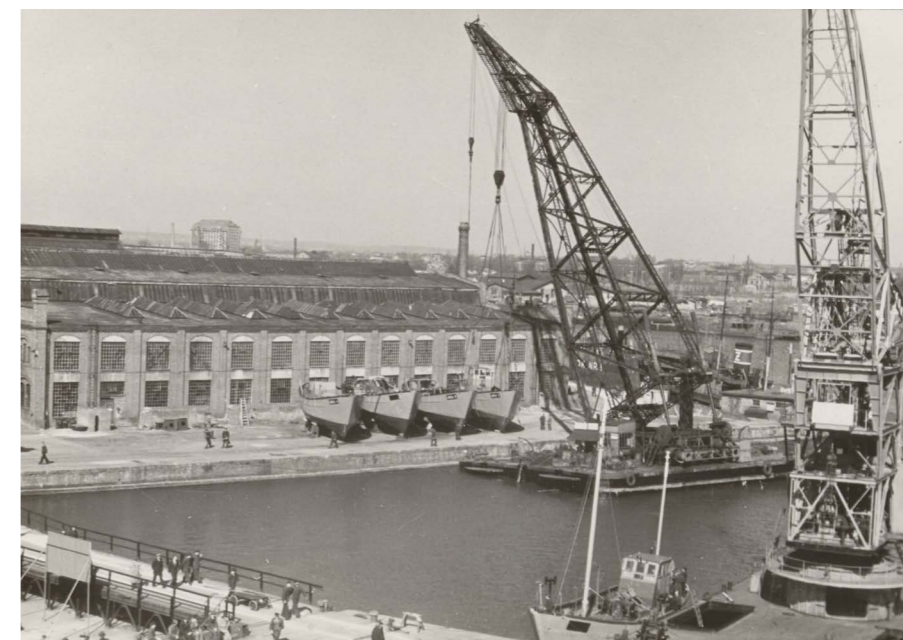
II. 219. Basen Dokowy Stoczni nr 1 (dawniej Stoczni Cesarskiej) podczas przygotowań do wodowania stalowych kutrów rybackich – pierwszej serii jednostek pływających zbudowanych w stoczni i pierwszych jednostek rybackich powstałych w zakładzie. Pionierska była technologia budowy tych kutrów i ich stalowa konstrukcja. Jednostki te zapoczątkowały długą tradycję budowy w Stoczni Gdańskiej coraz nowocześniejszych rybackich jednostek połowowych i przetwórczych. Stały się one jedną ze specjalizacji zakładu i źródłem sukcesów produkcyjnych, handlowych i wizerunkowych Stoczni Gdańskiej. Symbolicznym jest, że wcześniej, od r. 1908, było to miejsce wodowania niemieckich jednostek wojennych – U-Bootów, fot. NN, 1947, zbiory APG
