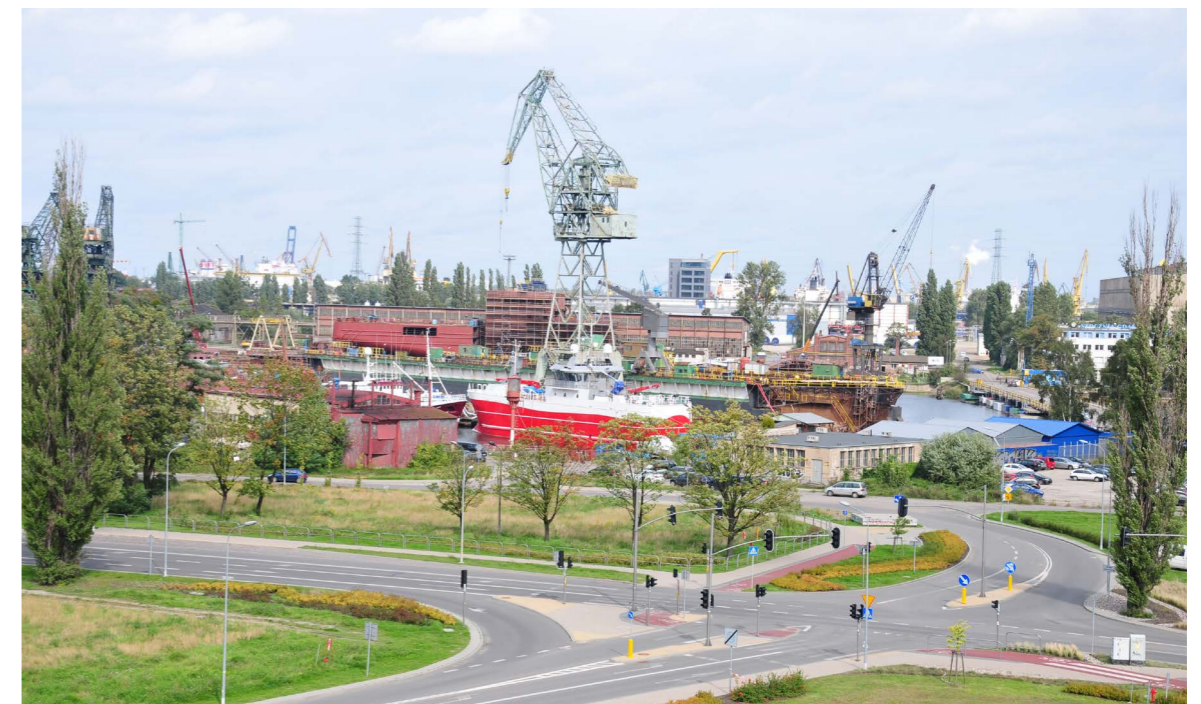
II. 11. Skrzyżowanie obecnych ulic miejskich – ks. J. Popiełuszki oraz Nowomiejskiej biegnących przez teren Stoczni Gdańskiej. W głębi widoczny kadłub statku (biało-czerwony) zacumowany przy nabrzeżu stoczniowym oraz oryginalny dźwиг znajdujący się na pirsie wyposażeniowym, fot. A. Trzeciak, 2020, zbiory autora
