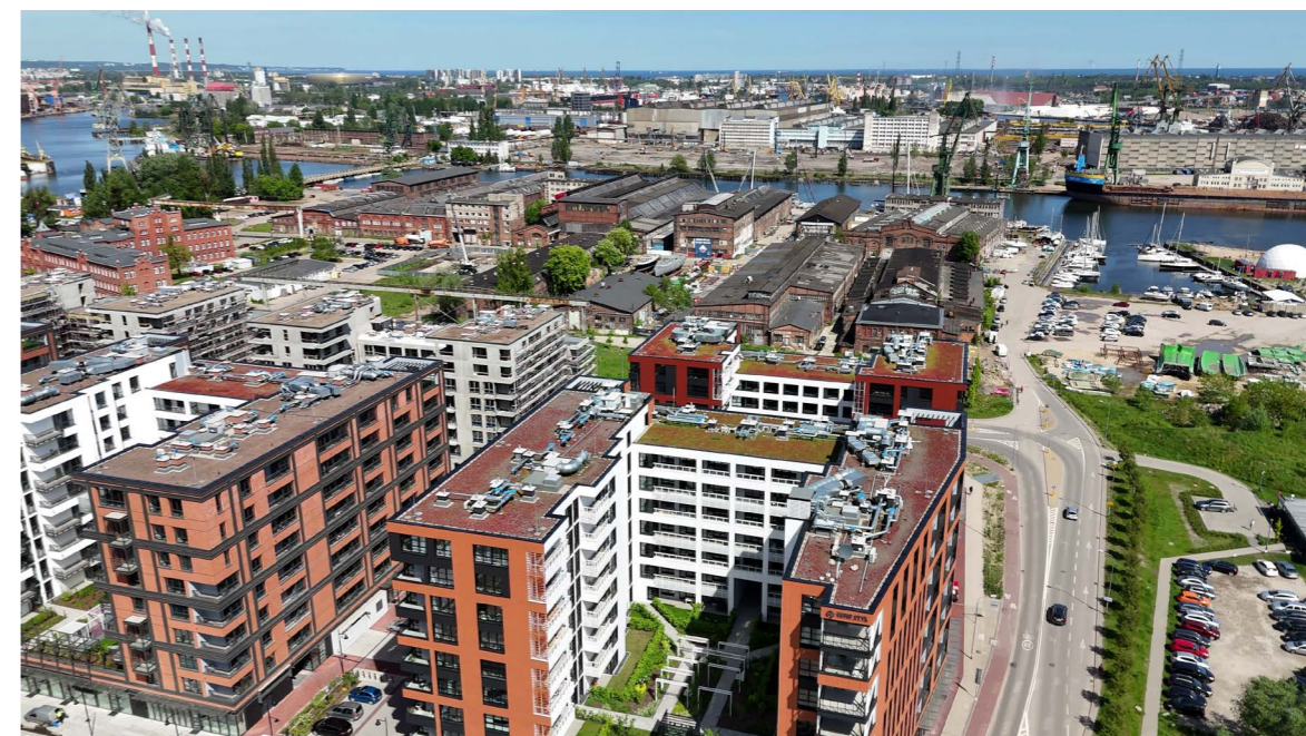
II. 107. Dawna Stocznia Cesarska - na I planie powstająca zabudowa mieszkalno-usługowa, za nią zespół historycznych hal produkcyjnych i historyczny Basen Dokowy - obecnie przystań jachtowa, fot. J. Zulewski 2024, zbiory BAM
