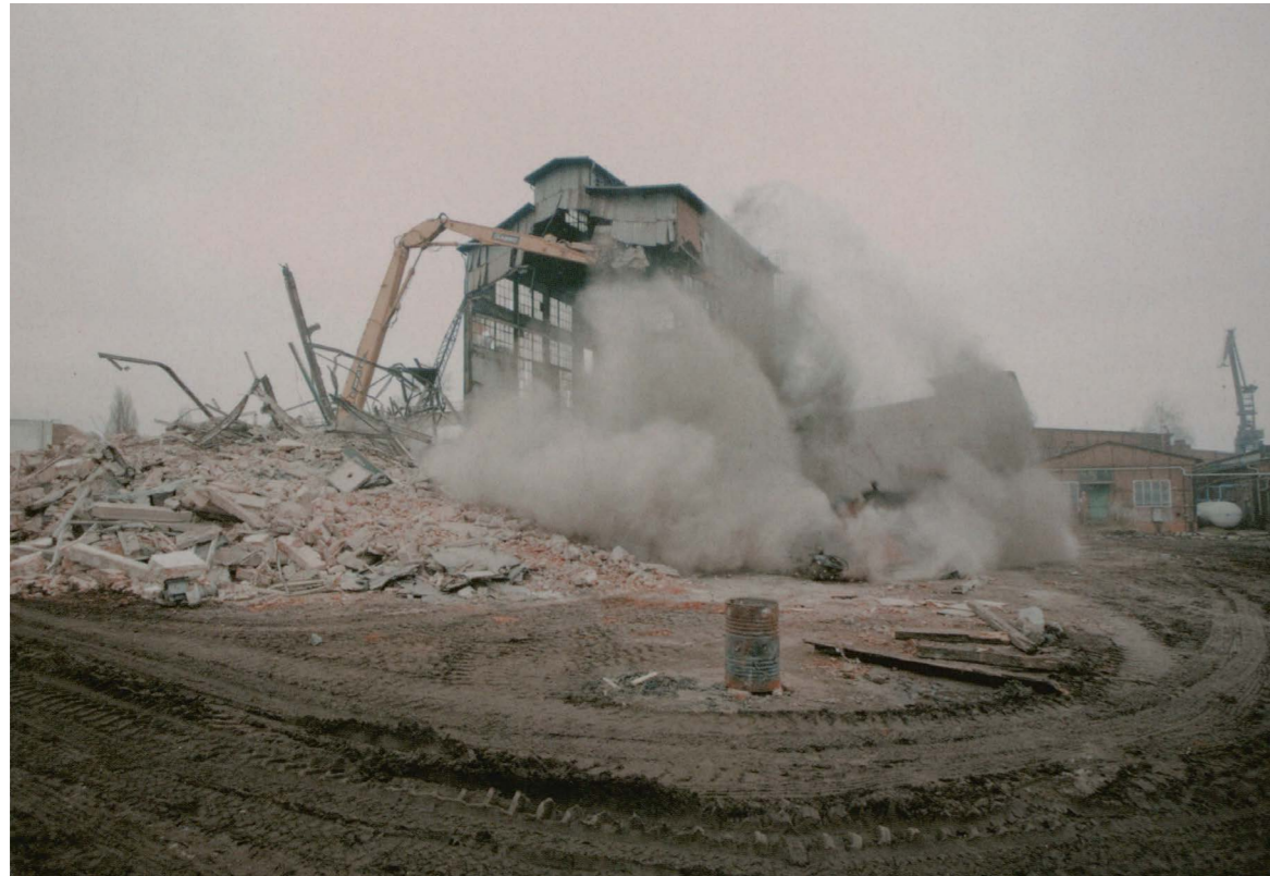
II. 55. Rozbiórka stoczniowej kotłowni, fot. M. Szlaga, z cyklu pt. Paskudne Pocztówki , 2012, zbiory autora
