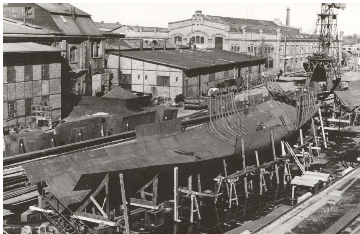
II. 144. Fragmenty zabudowy zespołu dawnej Stoczni Cesarskiej i Stoczni Gdańskiej w okolicy Basenu Dokowego. Po lewej hala kuźni okrętowej Schiffbau-Schmiede (Schmiede) – jej starsza część z arkadowym oknem oraz młodsze dobudówki wzniesione w konstrukcji szkieletowej. W głębi, po prawej, warsztat ślusarski i magazyn z ok. 1876–1882 – Schlosser-Werkstatt, Ressort Magazin. Po wojnie ślusarnia, fot. NN, ok. 1947, fragment, zbiory APG
