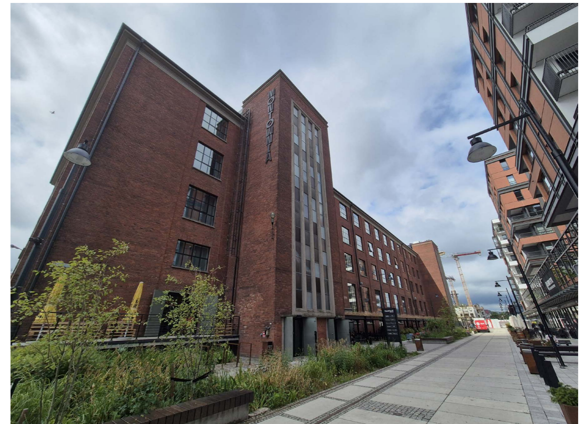
II. 59. Budynek 89A - dawny magazyn główny obszaru A - po renowacji i adaptacji na lokale mieszkalne, sale konferencyjne i zespół lokali gastronomicznych - food hall "Montownia". Realizacja otrzymała w 2024 r. tytuły: Zabytek Zadbane - w konkursie MKiDN oraz Najlepsza Gdańska Realizacja Architektoniczna 2022-2023 - w konkursie miasta Gdańska. Ilustracja z publikacji pokonkursowej Biura Architekta Miasta, fot. M. Wantoch-Rekowski, zbiory BAM,
