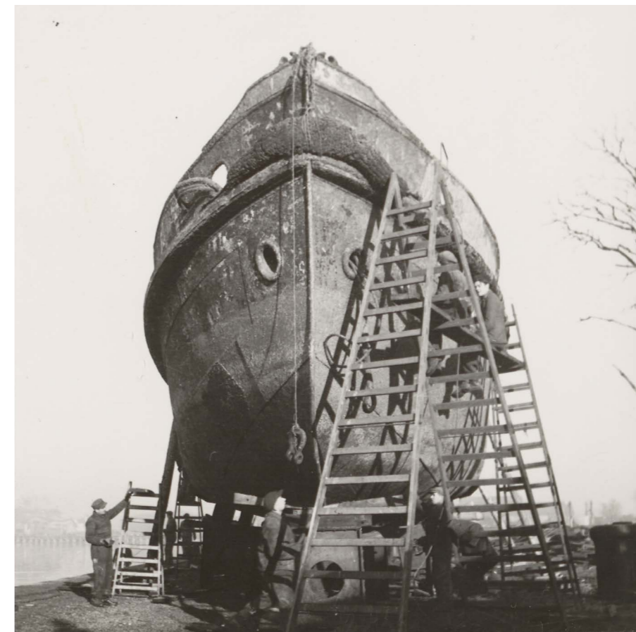
II. 217. Pierwsze prace remontowe przy jednostkach pływających podejmowane w stocznich gdańskich. Remont dokonuje się na nabrzeżu, co zapewne spowodowane było brakiem doków pływających w pierwszym powojennym okresie działania stoczni, fot. NN, ok. 1945, zbiory APG
