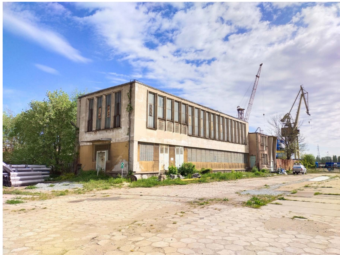
II. 239. Zachowane powojenne budynki stoczniowe (przełom lat 50.-60. XX w.): główna rozdzielnia elektryczna B5, fot. A. Trzeciak, 2022, zbiory autora
