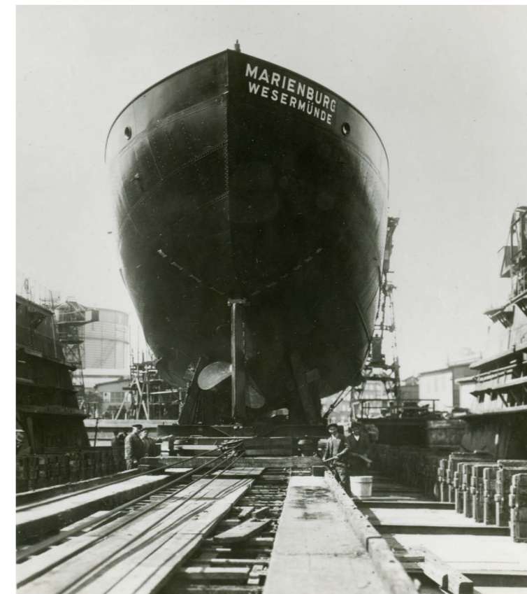
II. 195. Pracownicy międzywojennej Stoczni Gdańskiej przy budowie statku Marienburg. Na zdjęciu (fragment) przeciąganie jednostki z pochylni płaskiej (slipu) do doku pływającego zacumowanego w Basenie Dokowym, fot. NN, lata 30.XX w. (?), zbiory NMM
