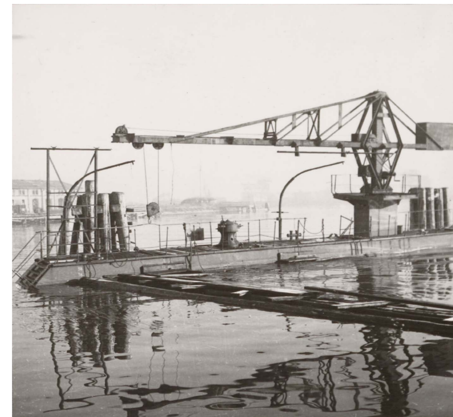
II. 221. Zatopiony niemiecki dok pływający. Wydobycie i remont doków był jednym z pierwszych zadań polskich załóg stoczniowych. Posiadanie sprawnych doków pływających umożliwiało podejmowanie zleceń w zakresie remontów statków, fot. NN, 1945, zbiory APG
