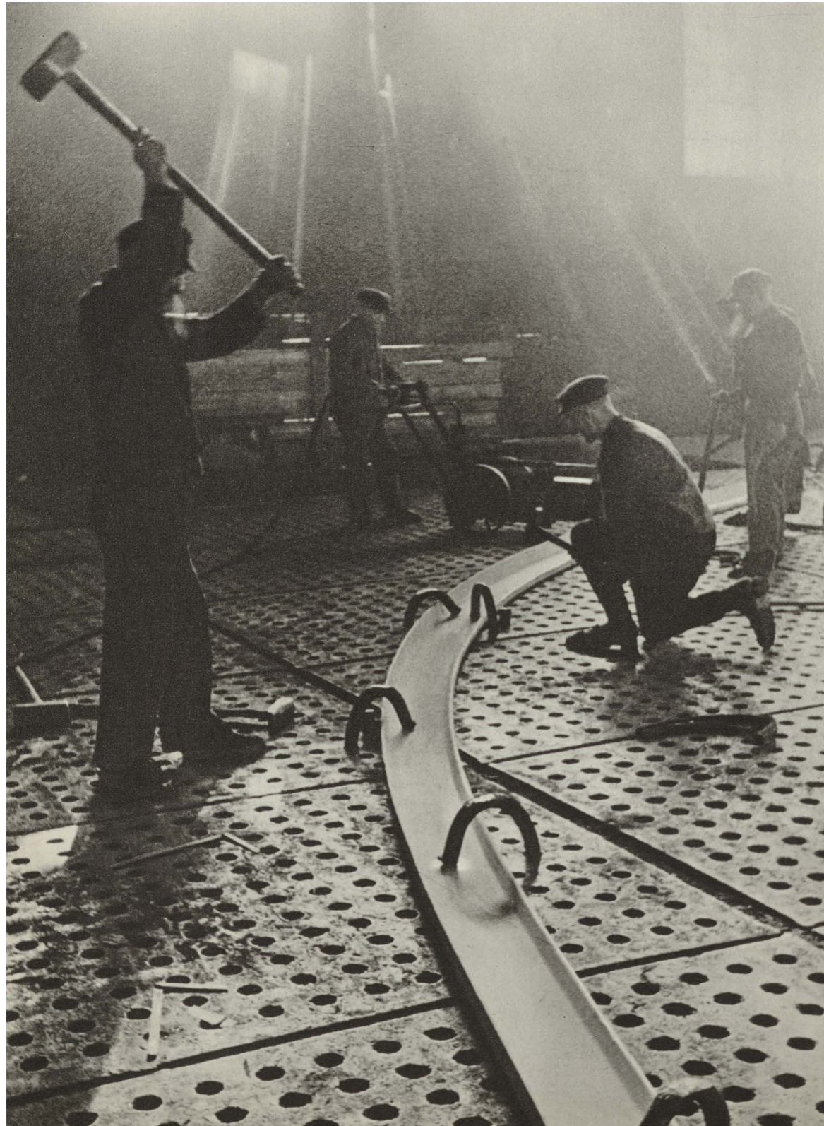
II. 167. Ręczne formowanie wręg w traserni Stoczni Schichaua. Widoczna charakterystyczna posadzka wręgowni złożona z masywnych płyt otworowych, fot. NN, przed 1937, zbiory BE
