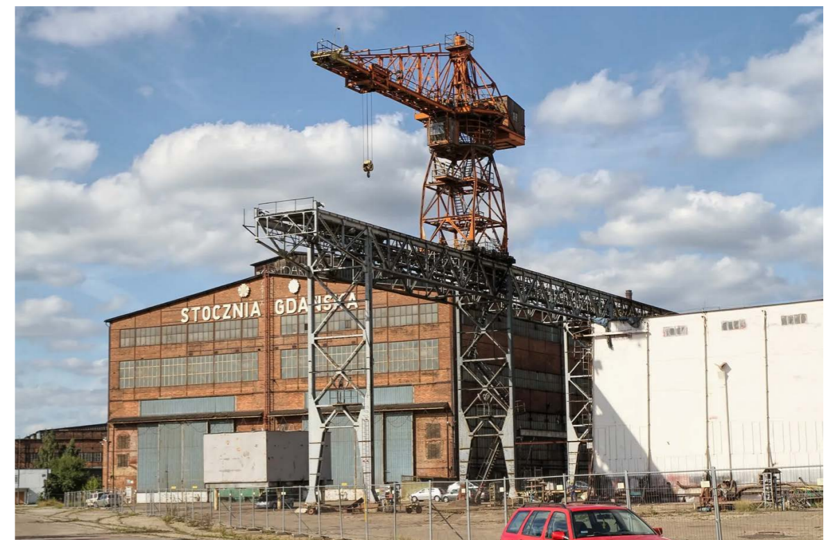
II. 173. Żuraw M15 przy hali traserni (3B) - ostatni zachowany żuraw przypochylniowy dawnej Stoczni Schichaua, pozostałe zostały zastąpione przez dźwigi Kone w latach 70. XX w. fot. J. Zulewski, 2010, zbiory BAM
