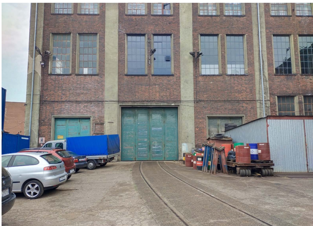
II. 176. Fragment elewacji budynku magazynowego 90B oraz torowisko umożliwiające wjazd wagonów towarowych do wnętrza gmachu w celu ich rozładunku, fot. A. Trzeciak, 2021, zbiory autora, fot. A. Trzeciak, 2021, zbiory autora
