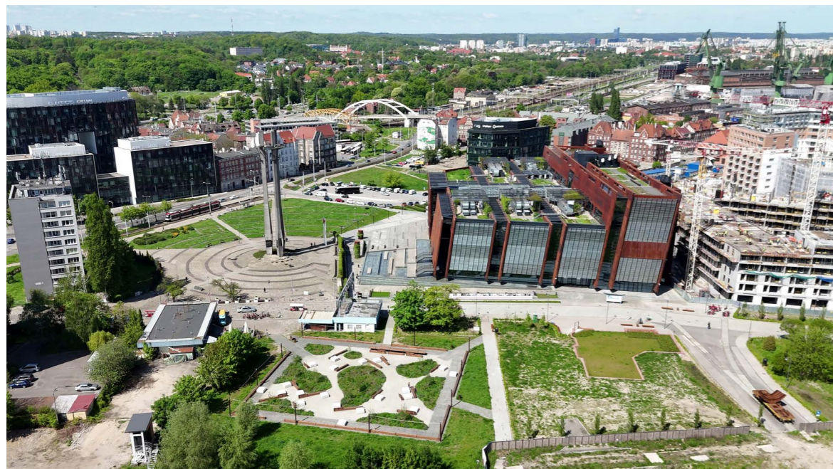
II. 64. Plac Solidarności wraz z Pomnikiem Poległych Stoczniovców i gmachem ECS. Widoczna również Brama nr 2 i biuro przepustek oraz obrysy nieistniejących budowli: stołówki i przychodni, fot. J. Zulewski, 2024, zbiory BAM
