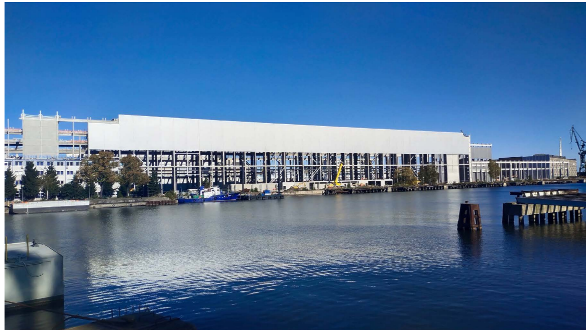
II. 10. Budowa hali montażu wież wiatrowych na wyspie Ostrów, jednej z największych inwestycji na obszarze dawnej Stoczni Gdańskiej po roku 1989, fot. A. Trzeciak, 2024, zbiory autora
