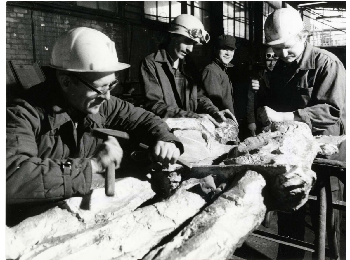
II. 248. Praca przy odlewach płaskorzeźb Pomnika Poległych Stoczniowców 1970 w stoczniowej odlewni, fot. J. Ukłejewski, 1980, archiwum ECS
