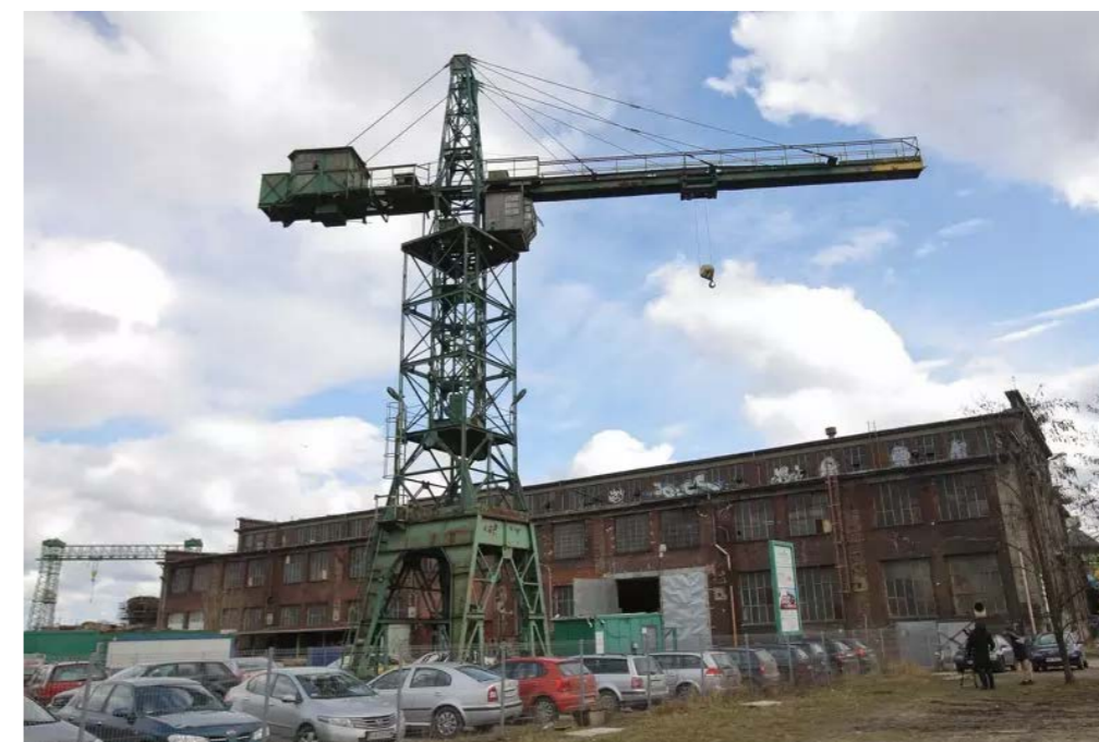
II. 175. Żuraw przy ul. Narzędziowców, na terenie dawnego składu rur zakupiony przez Miasto Gdańsk w 2013 roku, fot. G. Mehring, źródło: gdansk.pl
