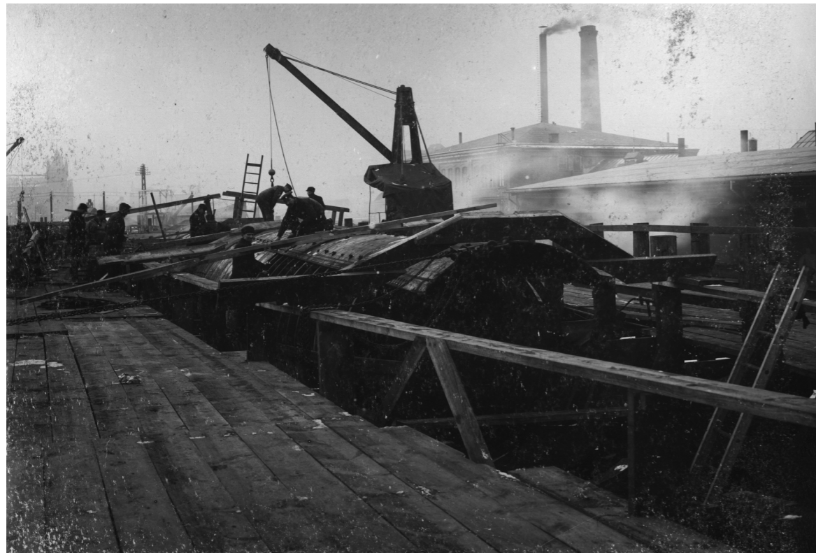
II. 123. Pracownicy Stoczni Cesarskiej podczas budowy jednego z wczesnych typów okrętów podwodnych (U-Bootów). Na zdjęciu poszywanie kadłuba – okładanie wręg okrętowych arkuszami blachy i ich łączenie za pomocą śrub i nitów. Jednostka stoi na jednym ze stoczniowych slipów (pochylni, tzw. płaskiej) przy Basenie Dokowym, w tle budynek kuźni okrętowej (niższy) – jej hala boczna, oraz gmach tzw. „centrali głównej” (wyższy), fot. NN, 1913, zbiory NMM
