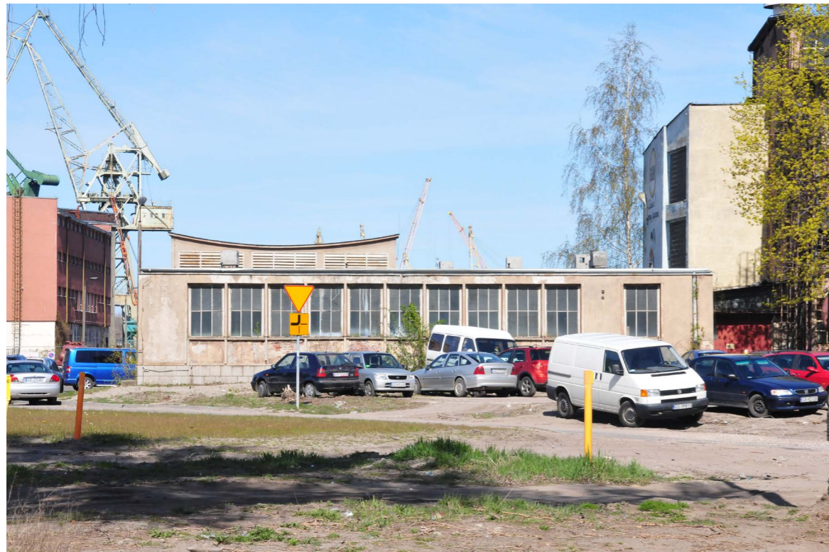
II. 238. Zachowane powojenne budynki stoczniowe (przełom lat 50.-60. XX w.): transformatorownia A9, fot. A. Trzeciak, 2015, zbiory autora
