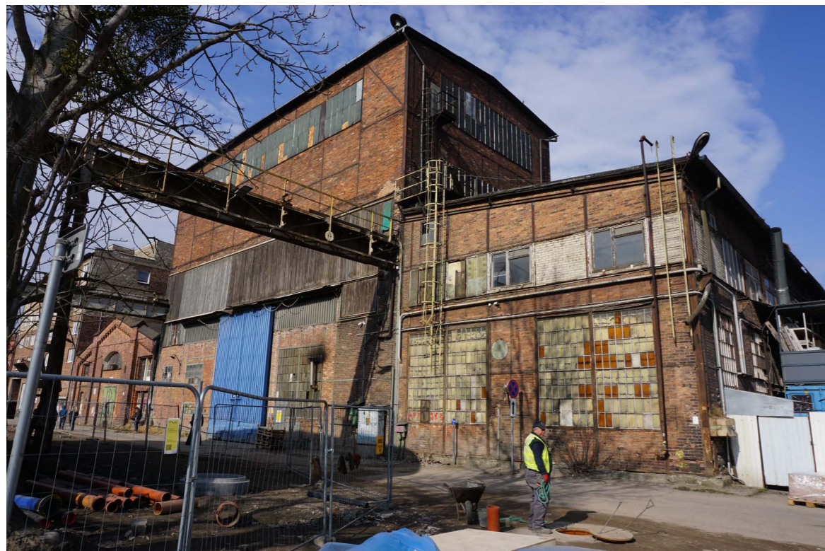
II. 194. Hala 34A - kotłarnia (1923) - jedyny zachowany obiekt kubaturowy z okresu funkcjonowania międzywojennej Stoczni Gdańskiej, fot. W. Chmielewski, 2026, zbiory BAM
