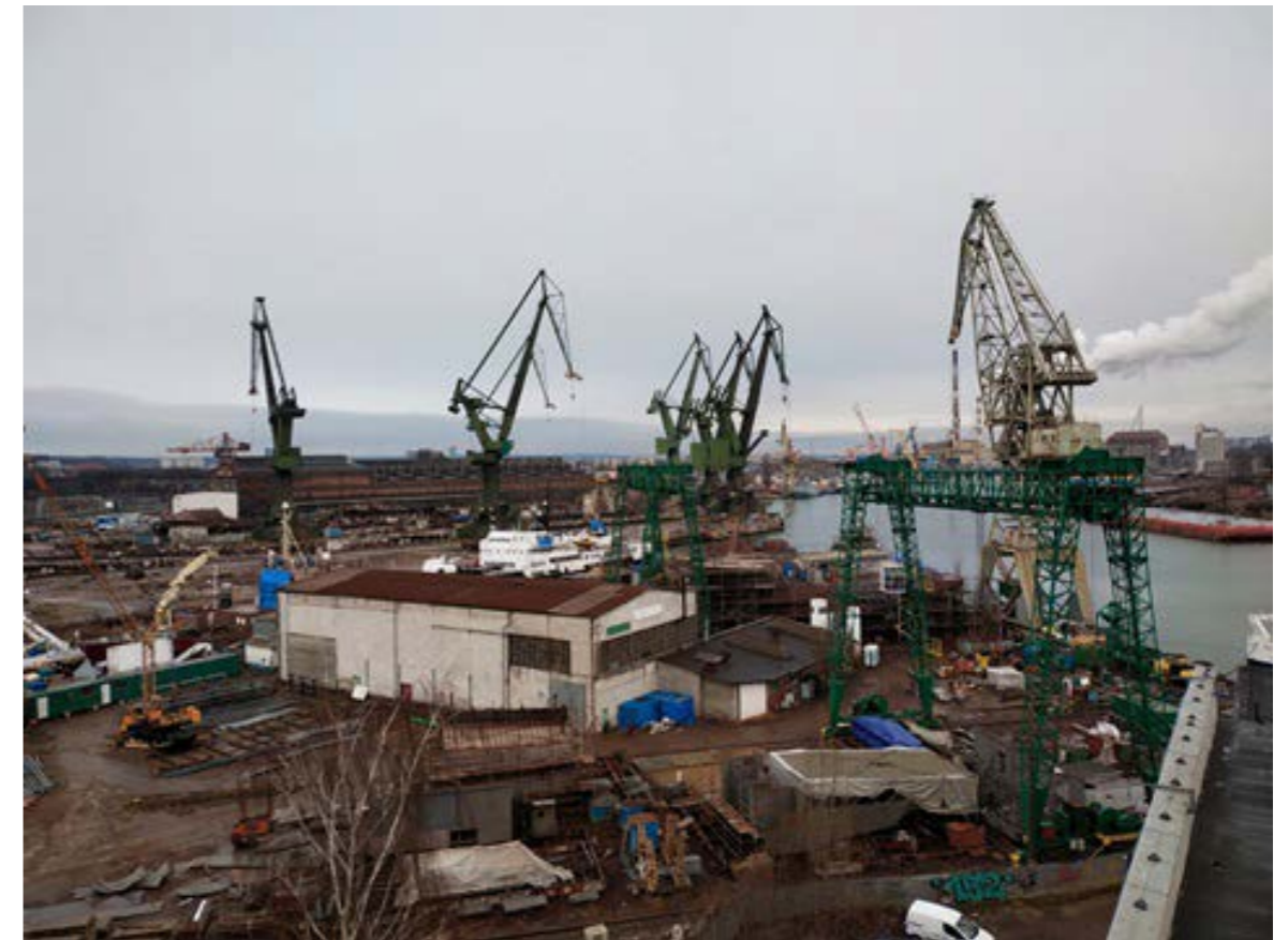
II. 159. Widok na halę 25B, ostatni zachowany budynek stoczniowy w tym rejonie, pochodzący z lat 20. XX w., fot. A. Trzeciak, 2023, zbiory autora
