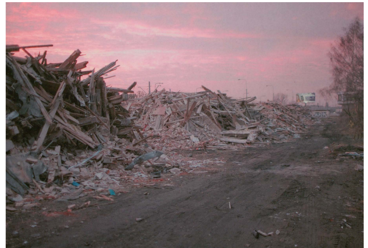
II. 53. Rozbiórka stoczniowej kotłowni, fot. M. Szłaga, z cyklu pt. Paskudne Pocztówki , 2012, zbiory autora
