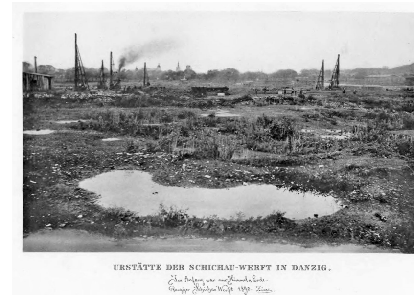
II. 38. Wygląd terenów przyszłej Stoczni Schichaua w Gdańsku po rozpoczęciu prac budowlanych. Widać jak nierówny i podmokły był to teren. W tle parowe kafary przy pomocy których dokonywano palowania gruntu w celu jego zagęszczenia i wzmocnienia przed realizacją zabudowy przemysłowej, fot. Carl Ziese, 1890, domena publiczna
