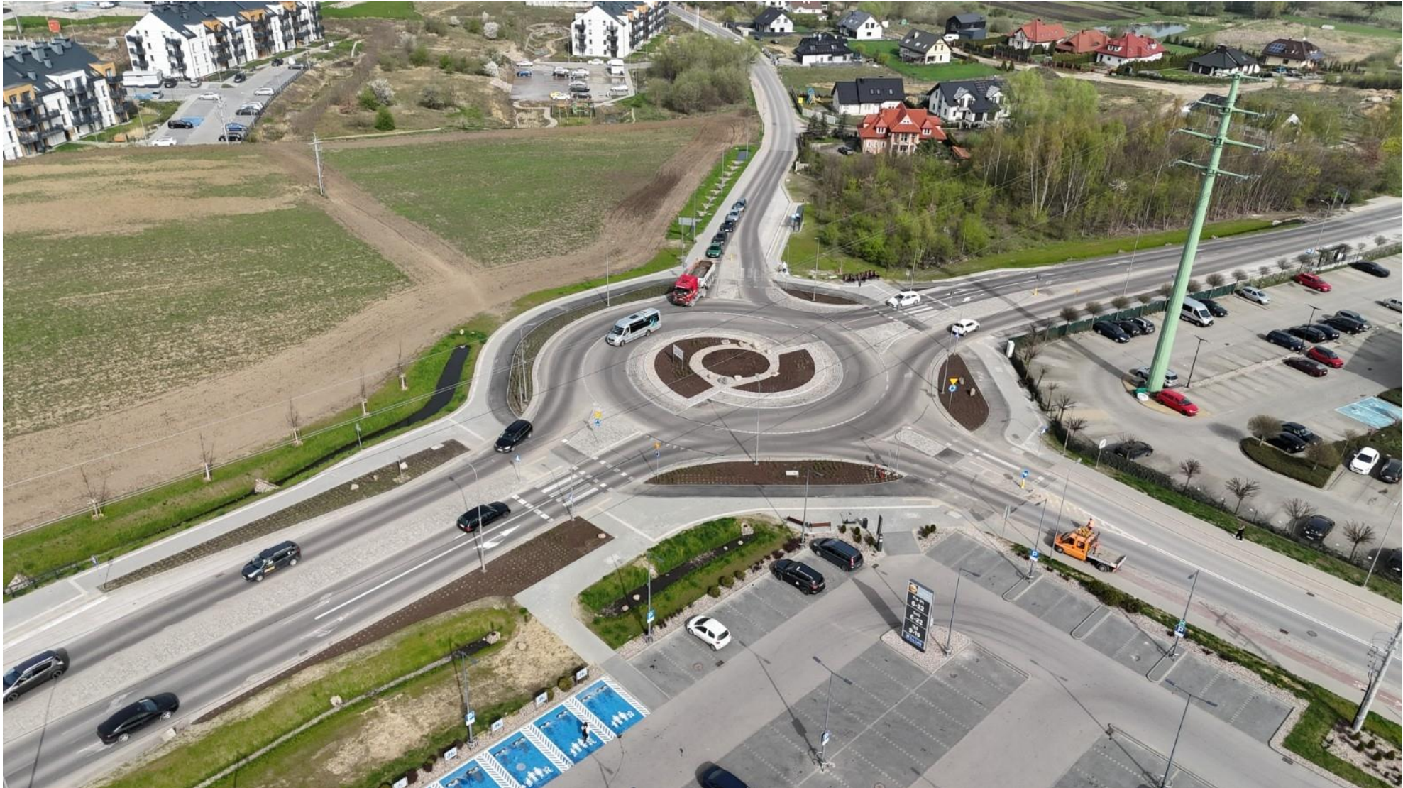
Zdjęcie obiektu (fot. DRMG):
