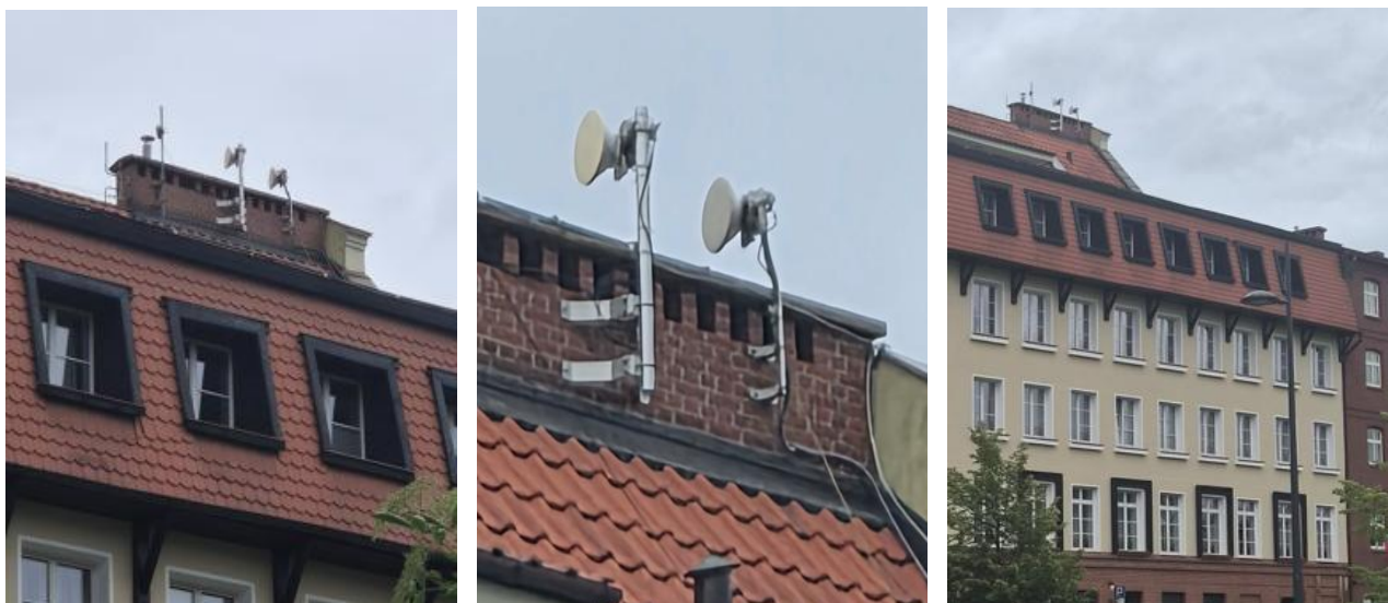
Widok obiektu wraz z zainstalowanym zespołem antenowym
