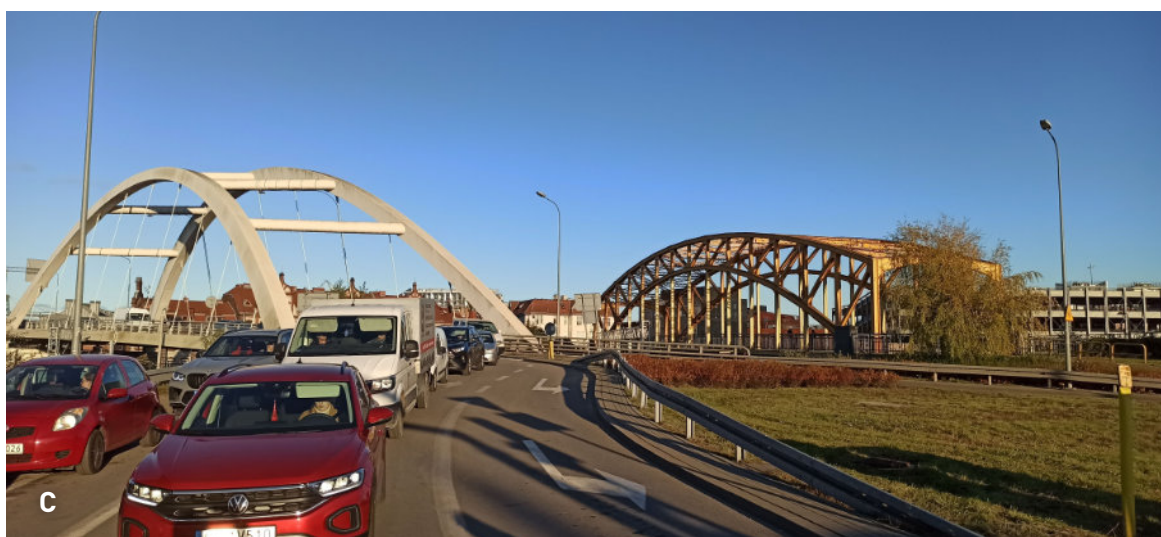
Ryc. 27 A-C. Główny wjazd samochodowy na Młode Miasto od strony Al. Zwycięstwa i ronda Ofiar Katynia wiaduktem nad magistralą kolejową i ul. Jana z Kolna, dalej estakadą i nasypem najazdowym aż do ul. Nowomiejskiej; dostępny obecnie wyłącznie dla ruchu kołowego; na zdjęciach A, B i C widoczny brak chodników; na zdj. C widoczne przesunięcie jezdni w osi planowanego drugiego zduplikowanego wiaduktu i estakady. (źródło: Piotr Smolnicki, jesień 2025)
