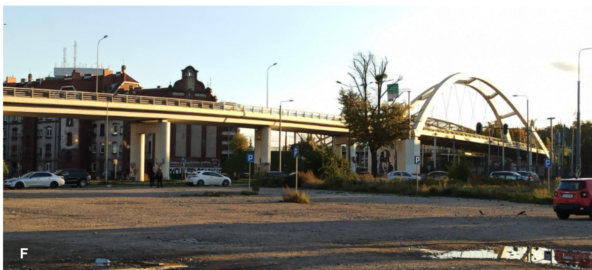
Ryc. 27 E-F. Główny wjazd samochodowy na Młode Miasto od strony Al. Zwycięstwa i ronda Ofiar Katynia wiaduktem nad magistralą kolejową i ul. Jana z Kolna, dalej estakadą i nasypem najazdowym aż do ul. Nowomiejskiej; dostępny obecnie wyłącznie dla ruchu kołowego; na zdj. E widoczny nasyp i przyczółek estakady blokujący oś ul. S. Jaracza i Rurarzy. (źródło: Piotr Smolnicki, jesień 2025)
