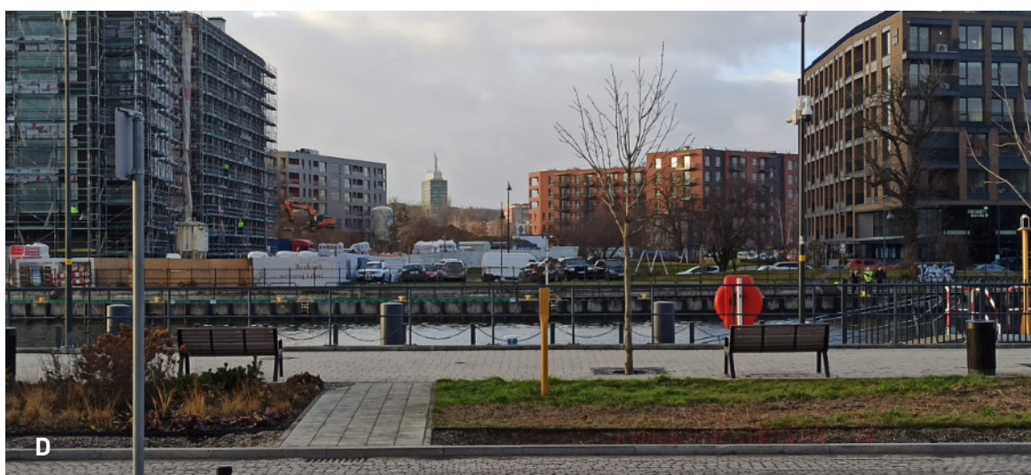
Ryc. 38 A-D. Rejon przyszłych wykopów zjazdu do tunelu ul. ks. J. Popiełuszki: A, B – skwer Gdańskich Wolontariuszy po zachodniej stronie rzeki, na Młodym Mieście, C – widok z Młodego Miasta w kierunku wschodnim na rezerwę terenową pod zjazd do tunelu na Polskim Haku, D – widok z Polskiego Haka w kierunku zachodnim na rezerwę terenową pod zjazd do tunelu i skwer Gdańskich Wolontariuszy. (źródło: Piotr Smolnicki, jesień 2025)
