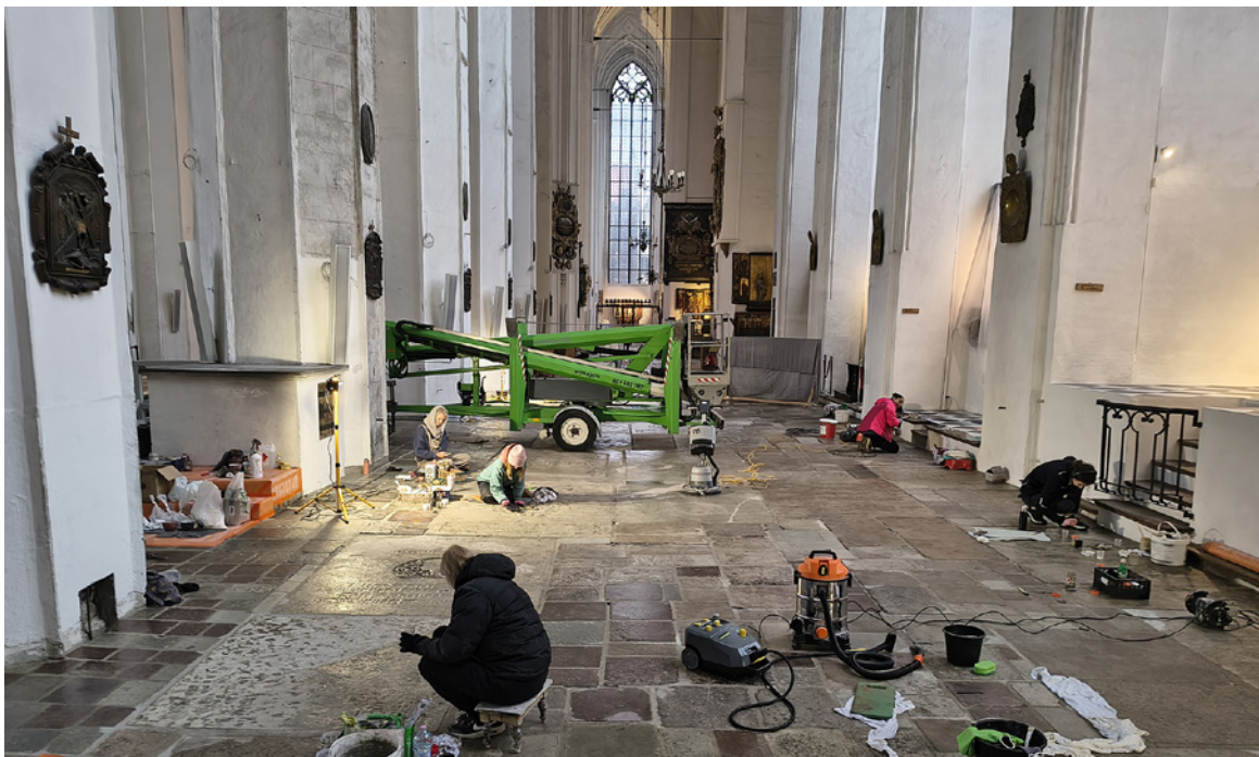
Prace renowacyjne przy posadzce w kościele Mariackim (2025).
