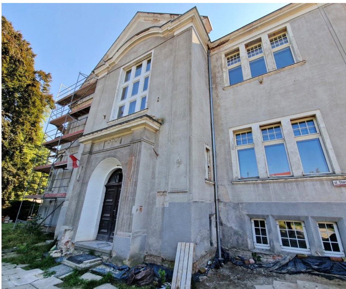
Remont zabytkowej willi przy ul. Małachowskiego w zakresie wnętrz, elewacji, stolarki i ogrodenia.
