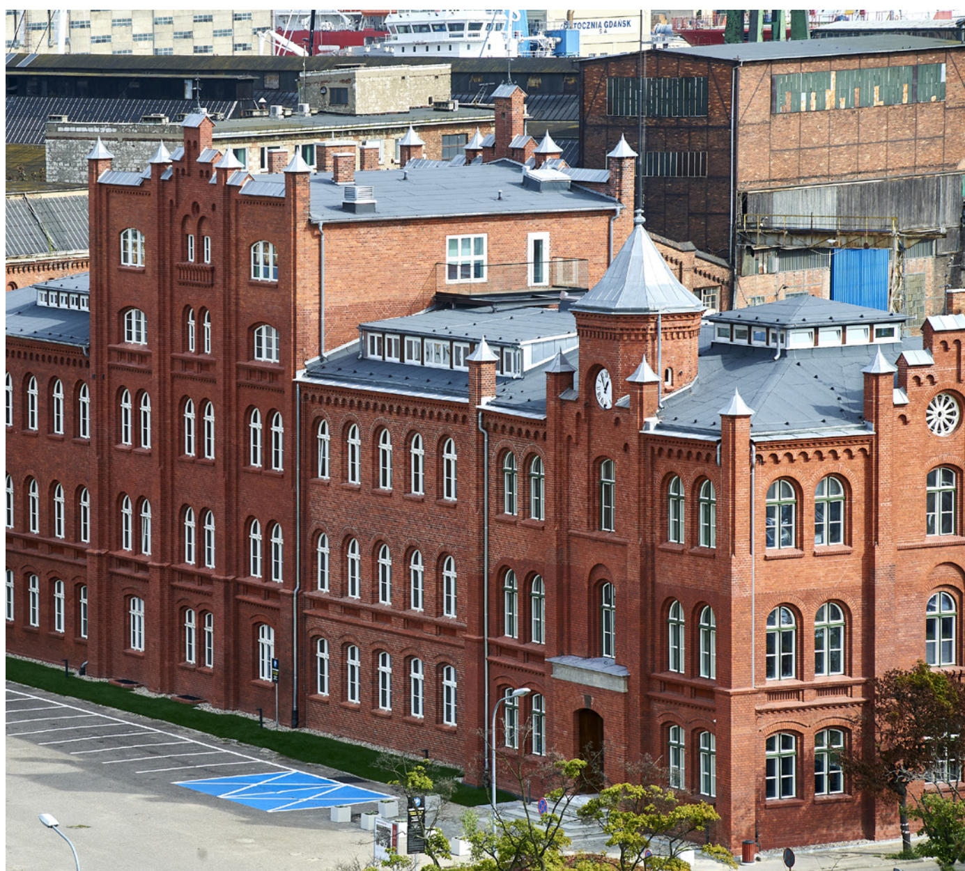
Budynek Dyrekcji Stoczni, w tle hale Stoczni Cesarskiej.
