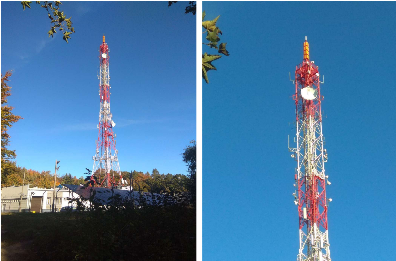
Widok obiektu wraz z zainstalowanym zespołem antenowym
