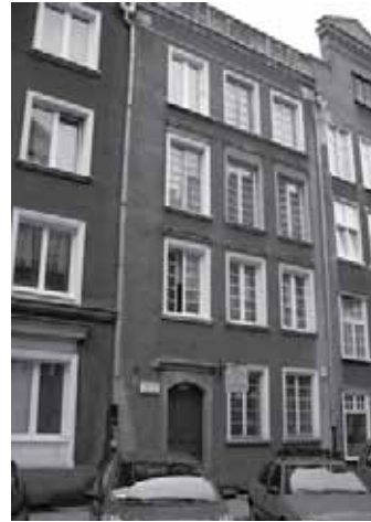
Dom przy ul. Ogarnej 78/79
