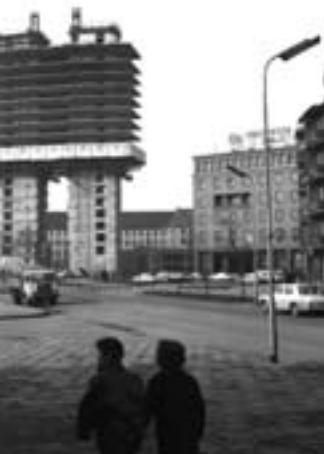
Widok na zbieg ulic Rajskiej i Wały Piastowskie. Po prawej budynek Biura Projektów Budownictwa Morskiego Projmors, w którym dziś urzędują władze NSZZ „Solidarność”, po lewej budowa wieżowca „Zieleniak”, jednego z najbardziej charakterystycznych obiektów w centrum Gdańska. Zdjęcie z marca 1968 r.
