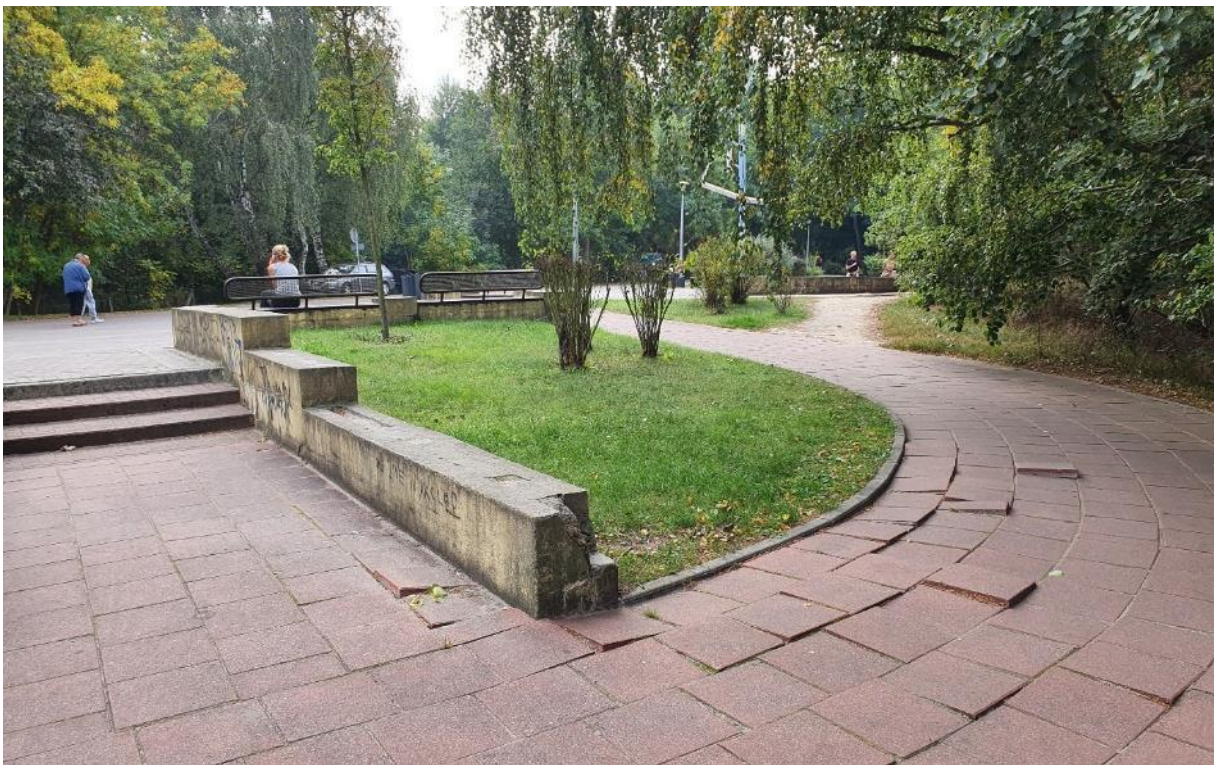
Zdjęcie 21 - 2020.09.25 – zniszczona nawierzchnia, murki i przedepty w dolnej części końcowego odcinka Promenady
