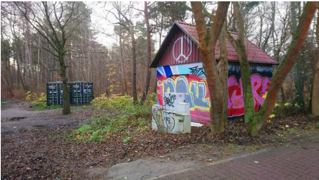
Zdjęcie 13 - 2021.11.23 - widok na stację transformatorową i szafki elektroenergetyczne przy Promenadzie
