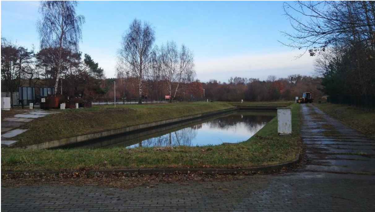
Zdjęcie 6 - 2021.11.23 - widok na zbiornik retencyjny od strony parkingu
